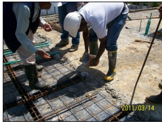
Aplicación de SIKADUR; producto de SIKA para fijar concreto fresco a concreto endurecido en la zona donde se realizó un "corte".
