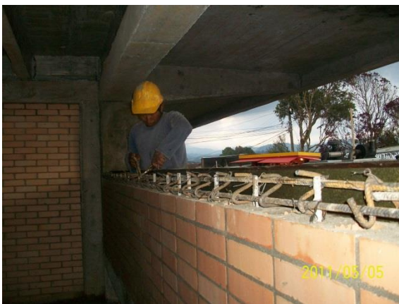
Amarre de refuerzo viga de remate mampostería sobre banca
