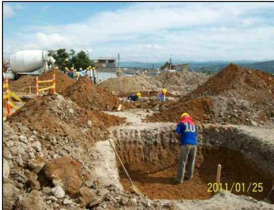
Perfilación de las paredes y nivelación del fondo de la excavación
