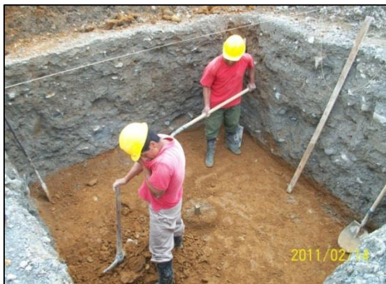
Perfilación de las paredes y nivelación del fondo de la excavación
