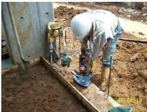
Anclajes para mampostería estructural
