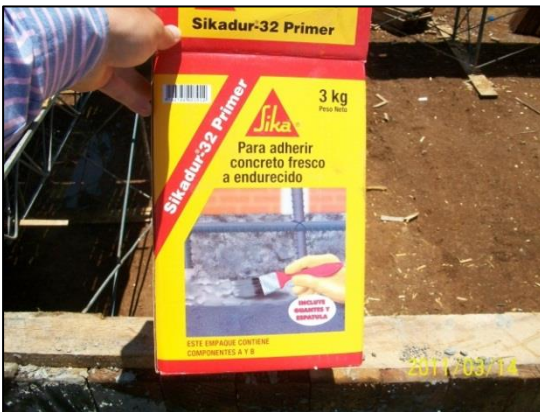
Aplicación de SIKADUR; producto de SIKA para fijar concreto fresco a concreto endurecido en la zona donde se realizó un "corte".
