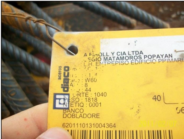
Detalle ficha DIACO. Recibo de acero figurado
