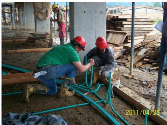
Protección de tubería empleando malla electrosoldada
