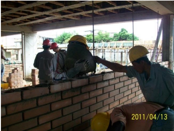
Relleno de las celdas con GROUTING (Concreto fluido)
