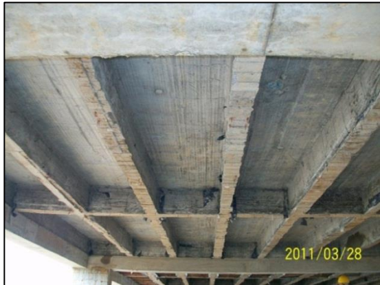
Losa aligerada de entrepiso terminada.
