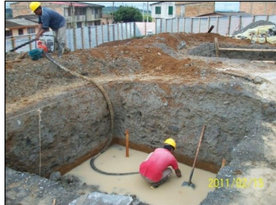
Comprobación de niveles de excavación con el apoyo de la comisión topográfica
