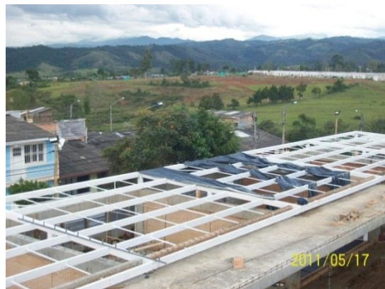
Estructura metálica de cubierta terminada bloque pre-escolar.
