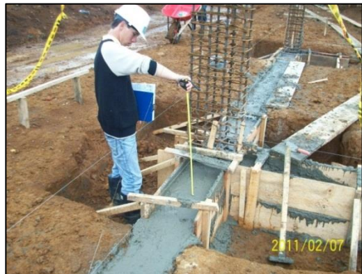
Chequeo de niveles con los hilos de referencia
