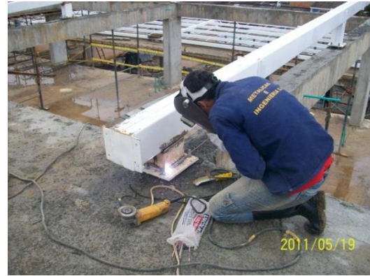
Platina asegurada; pernada y soldada
