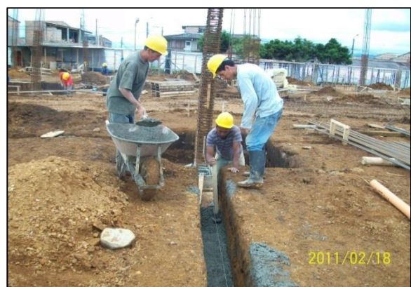
Fundición de solado de limpieza para vigas de amarre bloque primaria
