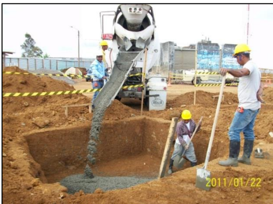
Vaciado del concreto para solado de limpieza de las Zapatas.
