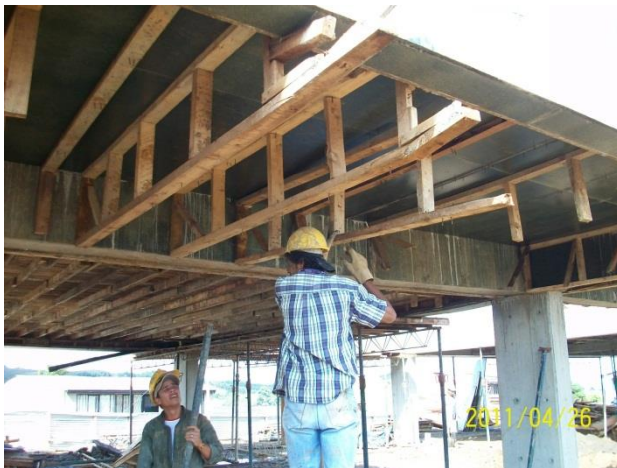
Desencofrado de la losa
