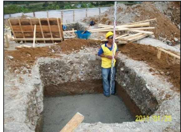
Chequeo de niveles con apoyo de la comisión topográfica
