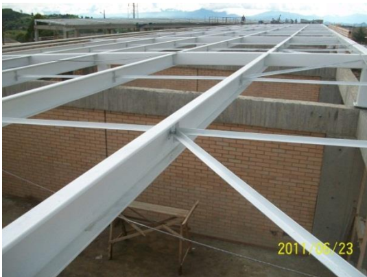
Retoque de pintura. Acabado final
