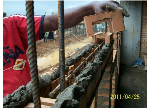
Refuerzo vertical y horizontal en marcos de ventanas (Viga-bloque)
