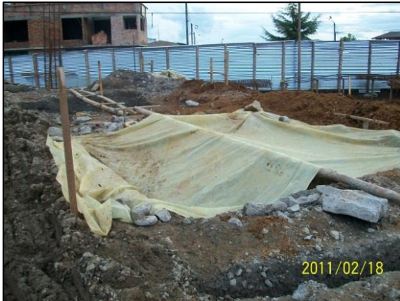
Protección de zonas excavadas o recién vaciadas con polietileno
