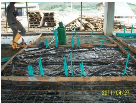
Pases ubicados en vigas de cimentación
