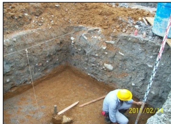
Comprobación de niveles de excavación con el apoyo de la comisión topográfica
