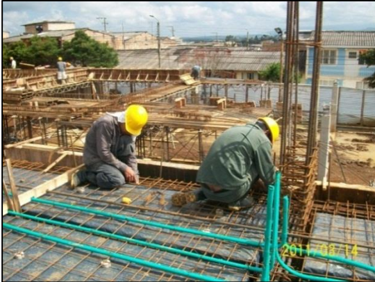
Aplicación de SIKADUR; producto de SIKA para fijar concreto fresco a concreto endurecido en la zona donde se realizó un "corte".
