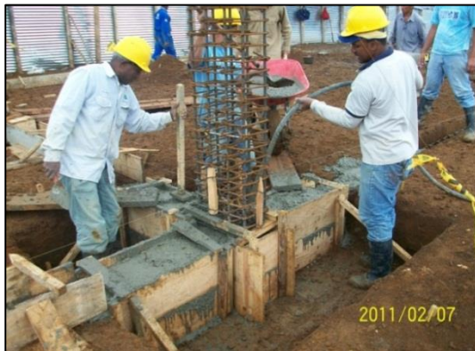
Vibrado de concreto cerca de los nudos
