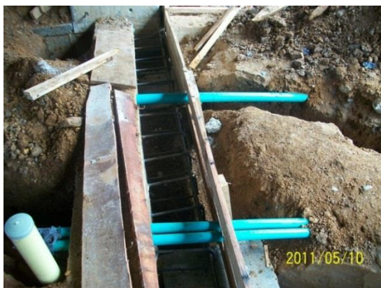
Pases ubicados en vigas de cimentación
