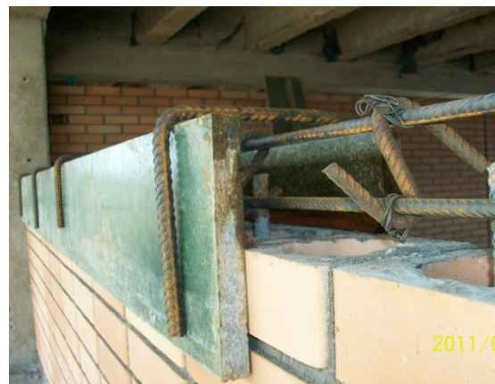
Encofrado; previo proceso a la fundición
