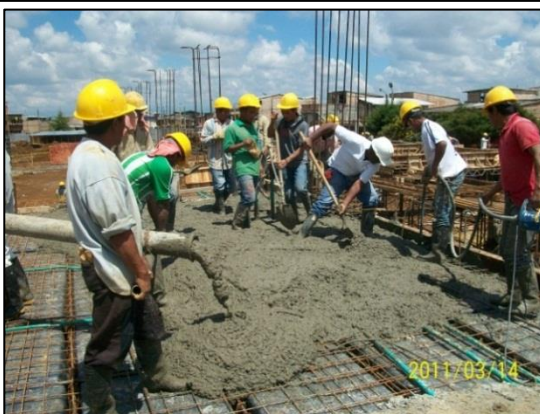
Fundición de losa aligerada de entrepiso. Control de proceso de vibrado.
