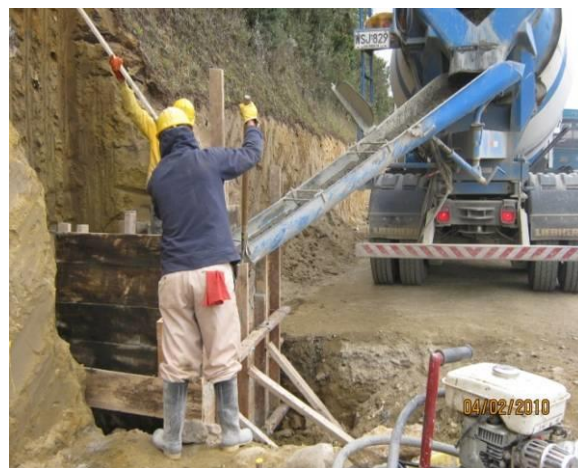
VISTA DE LA INSTALACIÓN DE TUBERÍA DE 900 mm Y FUNDICIÓN DE CABEZALES – SE TIENE CONSTRUIDAS UN TOTAL DE 28 ALCANTARILLAS DE 36"
