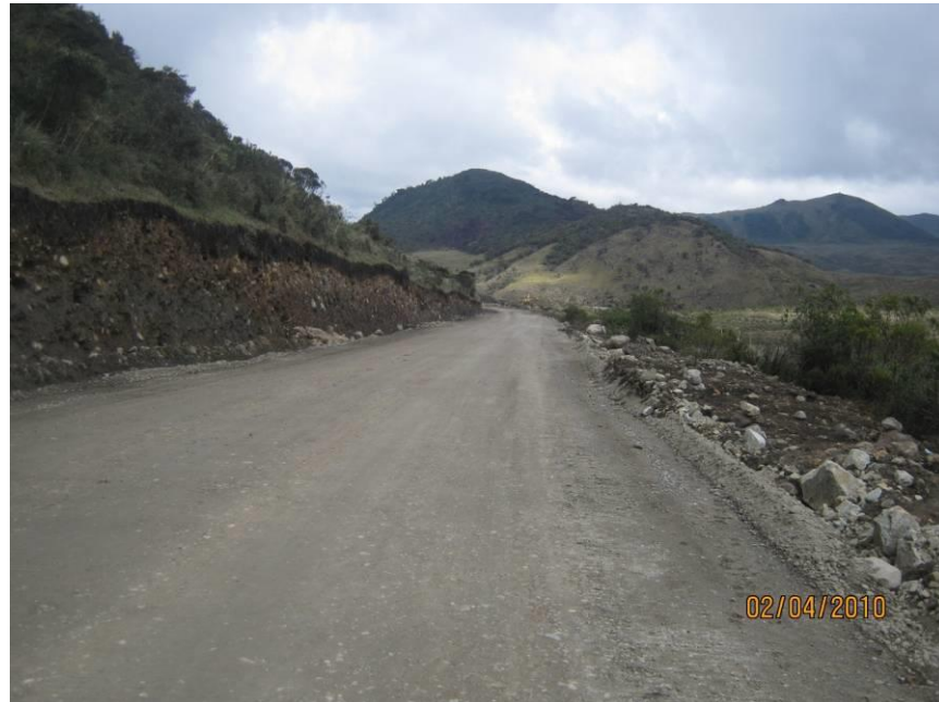
VISTA DE LA SUBRASANTE COMPACTADA
