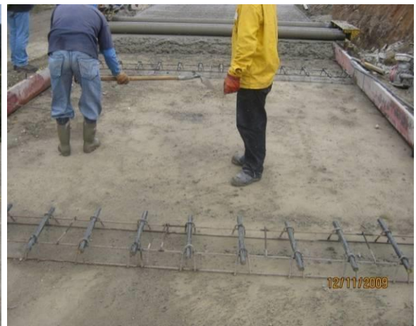
VISTA DEL TERMINADO DE LA SUBBASE Y COLOCACIÓN DE DOVELAS PARA LAS LOSAS
