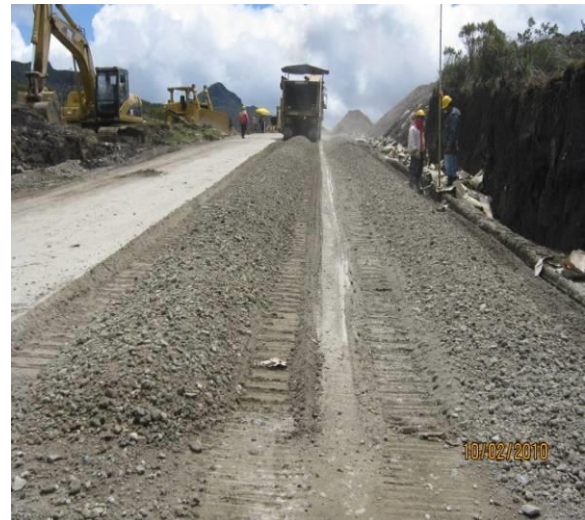
VISTA DE LA SUBBASE EN PROCESO DE ESTABILIZACIÓN
