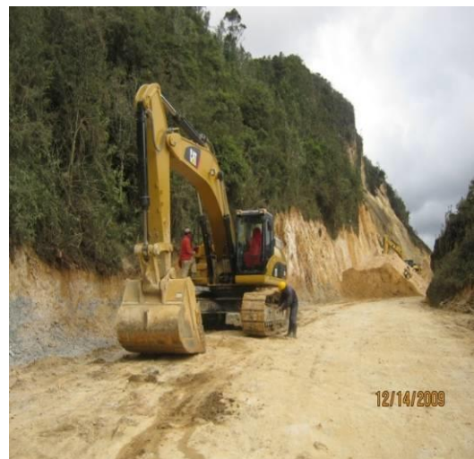
SE AVANZA EN LOS CORTES PARA EL MEJORAMIENTO DEL ALINEAMIENTO GEOMÉTRICO
