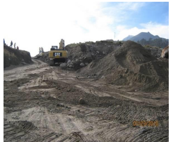
SE AVANZA EN LOS CORTES PARA AMPLIACIÓN DE LA BANCA – PR50+010
