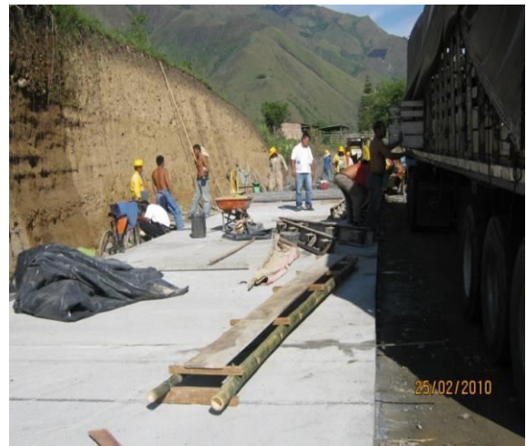
SE APRECIA EL PROCESO CONSTRUCTIVO DEL PAVIMENTO RÍGIDO – SE ESTA PREPARANDO EL CONCRETO IN SITU
