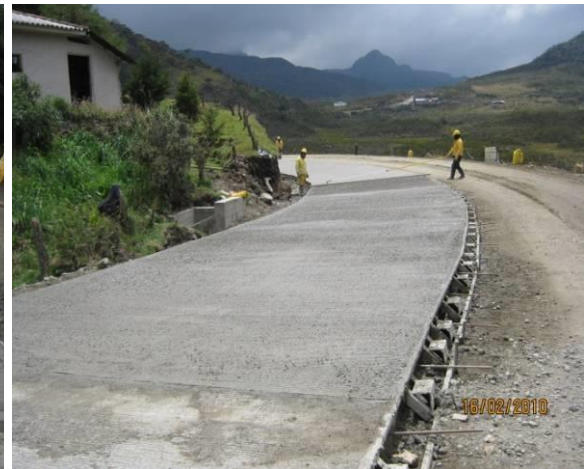
VISTA DEL VACIADO DEL CONCRETO PREMEZCLADO Y TERMINADO DE LAS LOSAS K48+800
