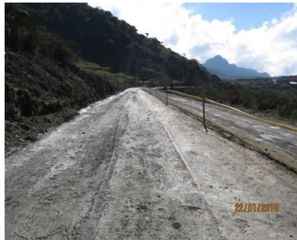
VISTA DEL TERMINADO DE LA SUBBASE Y TERMINADO DE LA BASE ESTABILIZADA
