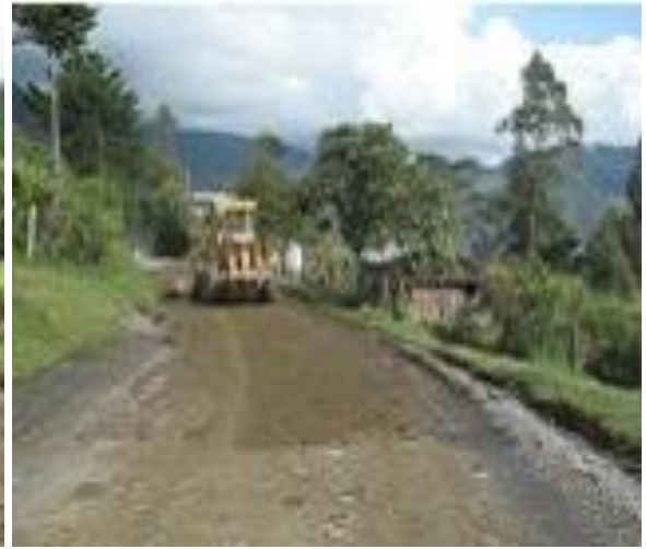
RIEGO Y EXTENSIÓN DE MATERIAL ADICIONADO PARA MANTENIMIENTO
