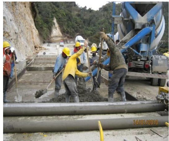
FORMALETA PARA LA FUNDICIÓN DE LOSAS – VACIADO DEL CONCRETO PREMEZCLADO
