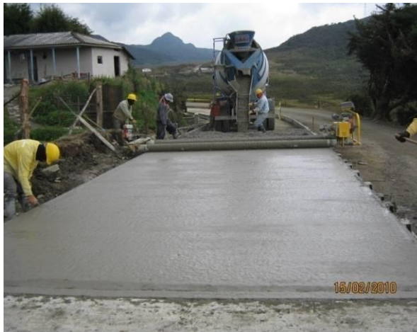
VISTA DEL VACIADO DEL CONCRETO PREMEZCLADO Y TERMINADO DE LAS LOSAS K48+800
