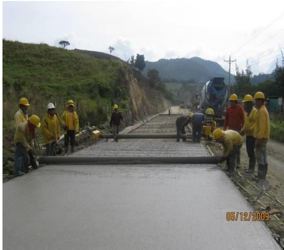
VACIADO DEL CONCRETO
