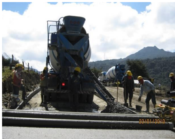
VISTA DEL VACIADO DE LAS LOSAS – EL MODULO DE ROTURA ES DE 4.2 MPA
