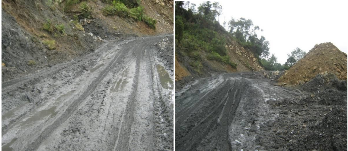
SE PUEDE OBSERVAR EL ESTADO DE LA VÍA
