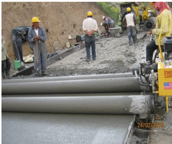
SE APRECIA EL PROCESO CONSTRUCTIVO DEL PAVIMENTO RÍGIDO – SE ESTA PREPARANDO EL CONCRETO IN SITU
