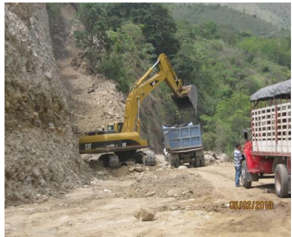
CONTINUACIÓN DE LOS CORTES PARA AMPLIACIÓN DE LA BANCA PR68+700
