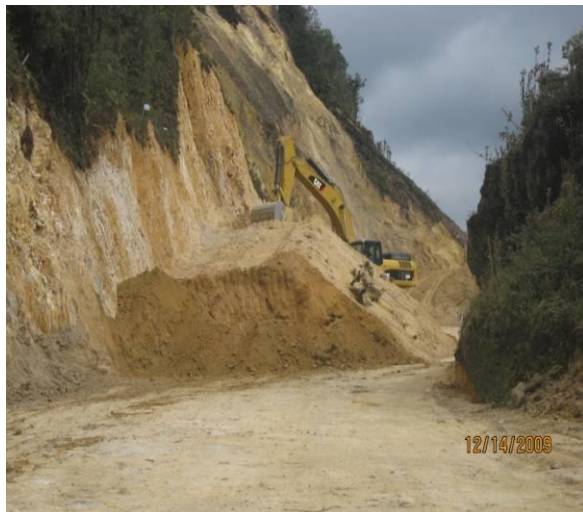
SE AVANZA EN LOS CORTES PARA EL MEJORAMIENTO DEL ALINEAMIENTO GEOMÉTRICO
