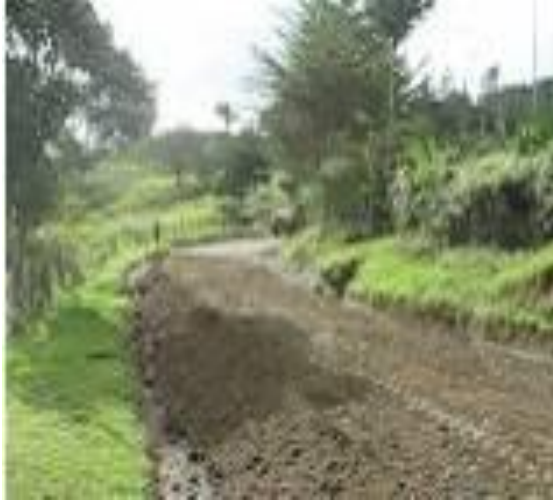
RIEGO Y EXTENSIÓN DE MATERIAL ADICIONADO PARA MANTENIMIENTO
