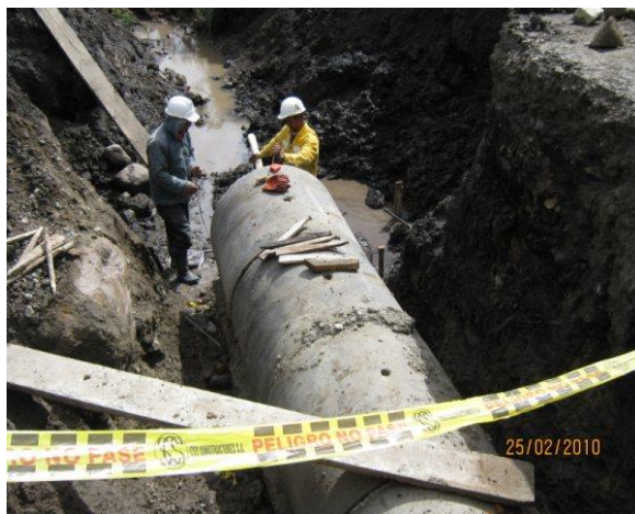
VISTA DE LA INSTALACIÓN DE TUBERÍA DE 900 mm Y FUNDICIÓN DE CABEZALES – SE TIENE CONSTRUIDAS UN TOTAL DE 28 ALCANTARILLAS DE 36"
