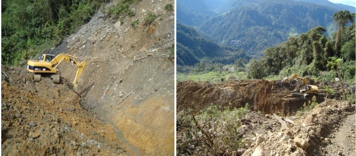
PROCESO DE EXCAVACIÓN PARA CONSTRUCCIÓN DE LAS CANALES RECOLECTORAS DE AGUA SUPERFICIAL
