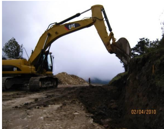
VISTA DE LOS CORTES PARA LA AMPLIACIÓN DE LA BANCA – PR 50+800
