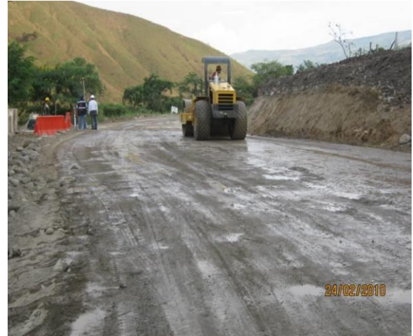
COMPACTACIÓN DE LA CAPA DE SUBBASE GRANULAR
