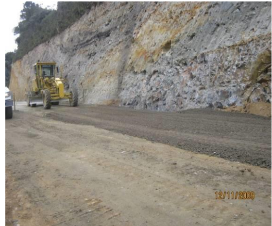
MEJORAMIENTO Y EXTENSIÓN DEL MATERIAL DE SUBBASE ESTABILIZADO CON CEMENTO
