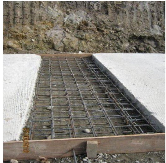
REPARACIONES A LAS LOSAS FISURADAS
