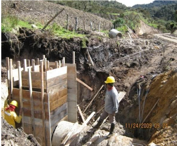
INSTALACIÓN DE TUBERÍA DE 36" – 900mm . CONSTRUCCIÓN DE ESTRUCTURAS CABEZALES
