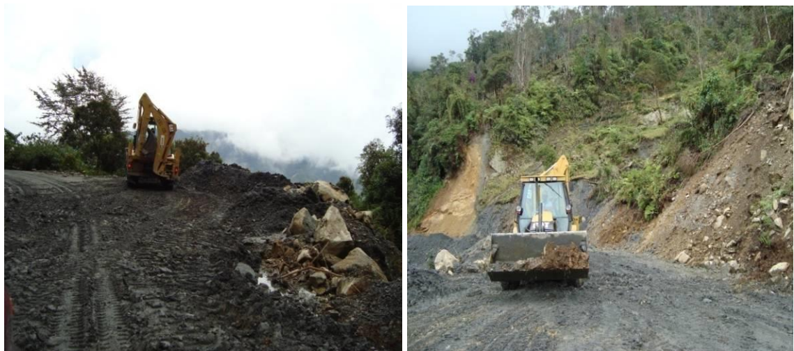
SE PUEDE OBSERVAR LA MAQUINARIA HACIENDO TRABAJOS EN LA VÍA
