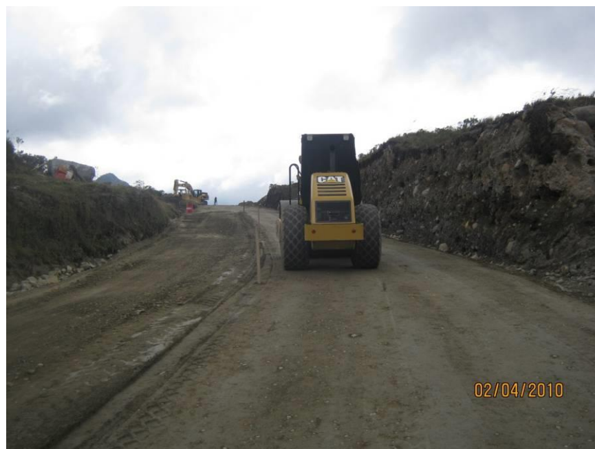
VISTA DE LAS EXPLANACIONES REALIZADAS – PROCESO DE COMPACTACIÓN DE LA SUBRASANTE
