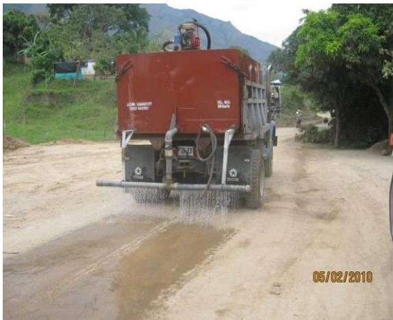
IRRIGACIÓN DE LA VÍA PARA EVITAR LA EXCESIVA PRESENCIA DE POLVO
