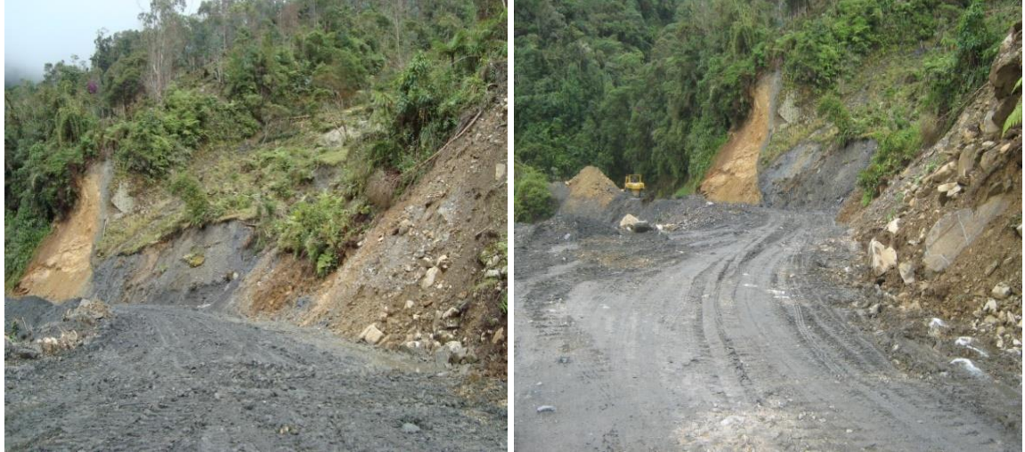
ESTADO DE LA VÍA DESPUÉS DE LOS TRABAJOS
