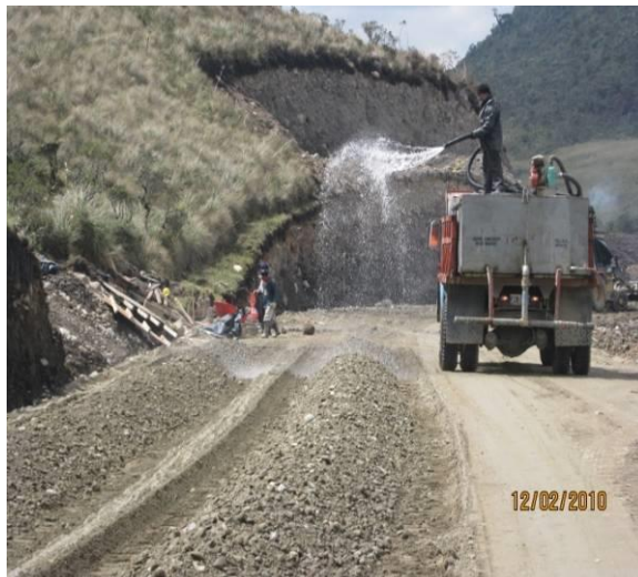
VISTA DE LA SUBBASE EN PROCESO DE ESTABILIZACIÓN
