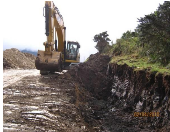
VISTA DE LOS CORTES PARA LA AMPLIACIÓN DE LA BANCA – PR 50+800
