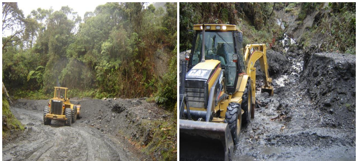
MAQUINARIA TRABAJANDO EN EL SITIO CRITICO
