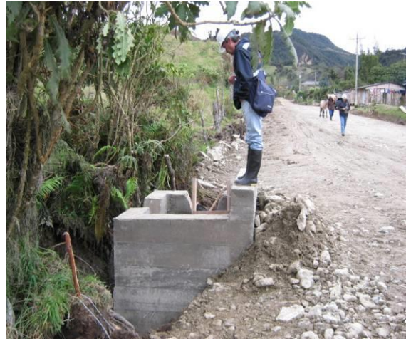
INSTALACIÓN DE TUBERÍA DE 36" – 900mm . CONSTRUCCIÓN DE ESTRUCTURAS CABEZALES
