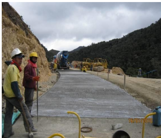
VISTA DEL VACIADO DE LAS LOSAS – EL MODULO DE ROTURA ES DE 4.2 MPA
