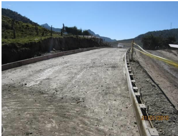
FORMALETA PARA LA FUNDICIÓN DE LOSAS – VACIADO DEL CONCRETO PREMEZCLADO
