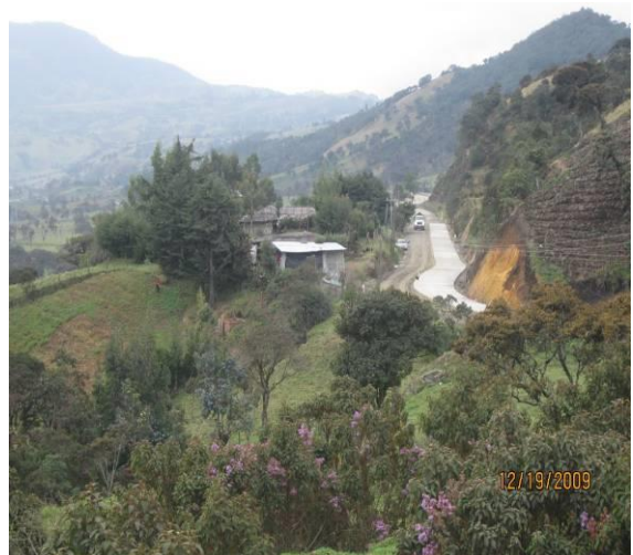
VISTA DE LA VIA – CARRIL IZQUIERDO FUNDIDO
