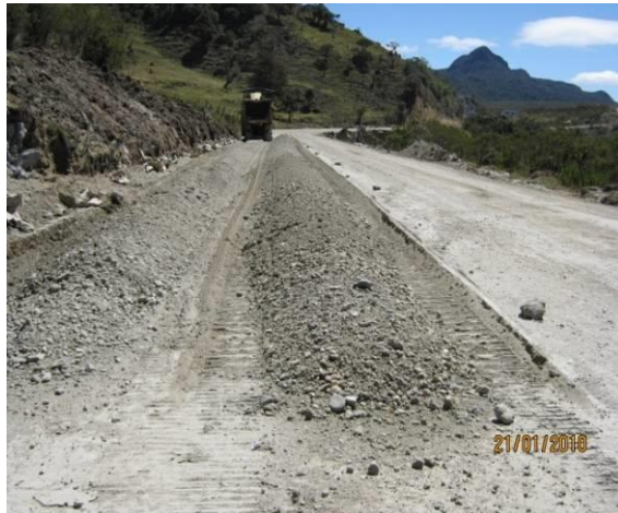
VISTA DEL TERMINADO DE LA SUBBASE Y TERMINADO DE LA BASE ESTABILIZADA
