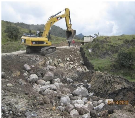
SE AVANZA EN LOS CORTES PARA AMPLIACIÓN DE LA BANCA – PR50+010
