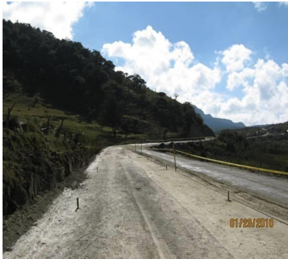
VISTA DE LA CAPA SUBBASE ESTABILIZADA TERMINADA – EN PROCESO DE CURADO PR 49+200
