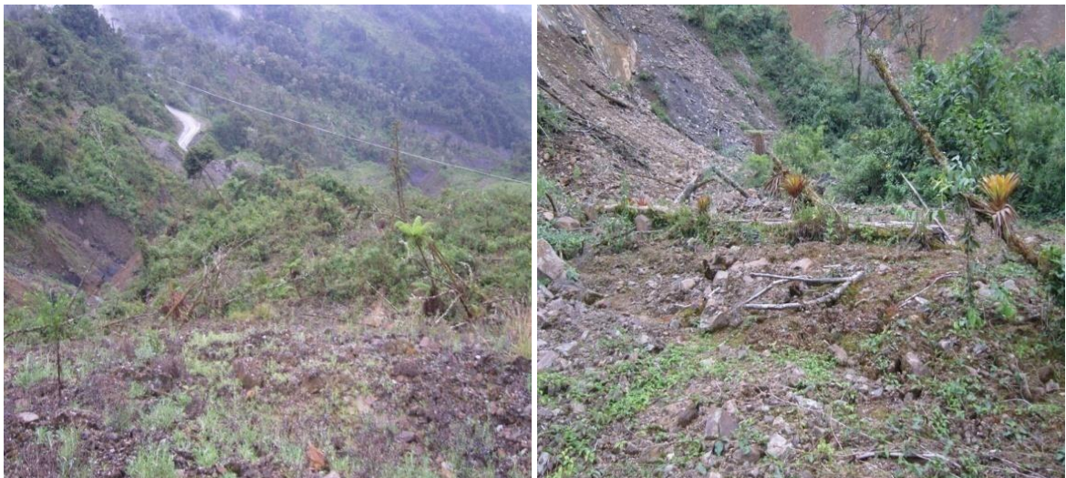
ESTADO INICIAL DEL TERRENO EN EL TALUD SUPERIOR DEL SITIO CRITICO
