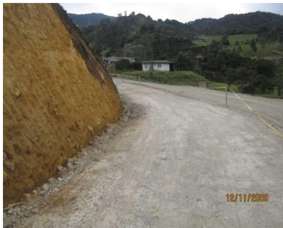
VISTA DEL TERMINADO DE LA SUBBASE Y COLOCACIÓN DE DOVELAS PARA LAS LOSAS
