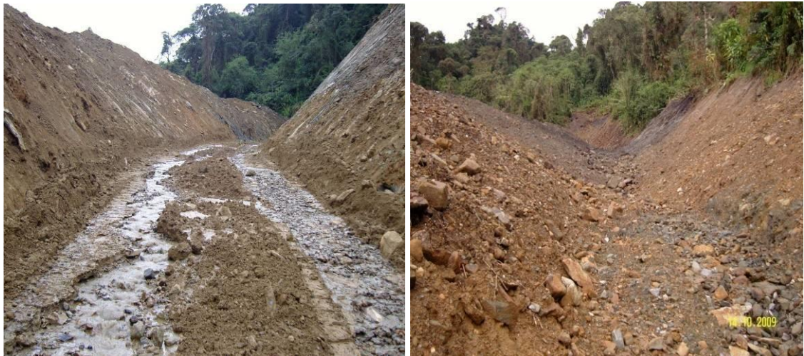
TERMINACIÓN CONSTRUCCIÓN DE CANALES
