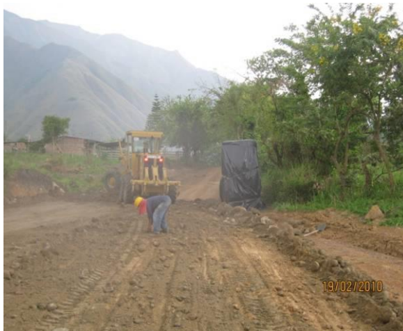
CEREO DEL MATERIAL DE SUBBASE
