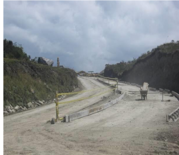
VISTA DE LA CAPA SUBBASE ESTABILIZADA TERMINADA – EN PROCESO DE CURADO PR 49+200
