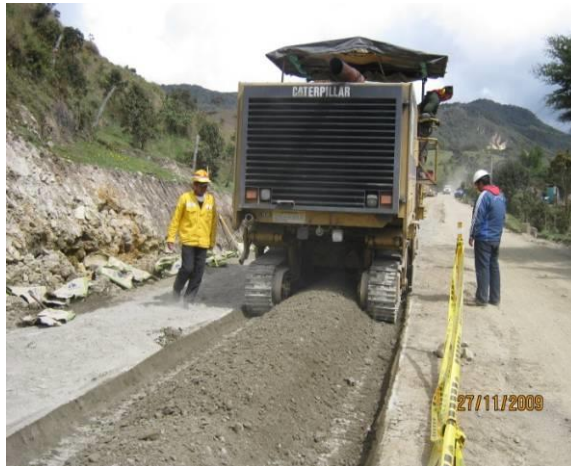
MEJORAMIENTO Y EXTENSIÓN DEL MATERIAL DE SUBBASE ESTABILIZADO CON CEMENTO
