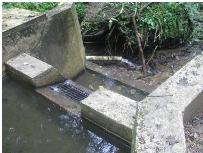
Figura 23. Sistema de Captación en la Bocatoma
