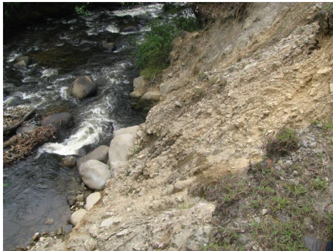
Figura 49. Deslizamiento de Tierra
