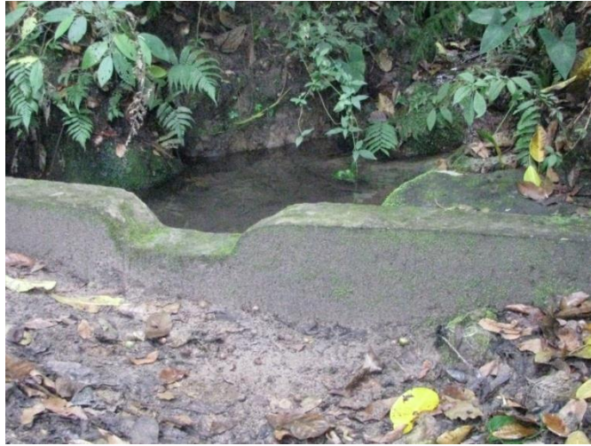
Figura 7. Bocatoma Fuente alterna del tanque de almacenamiento vereda Las Huacas.
