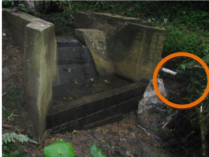
Figura 24. Falta sistema de limpieza de la bocatoma
