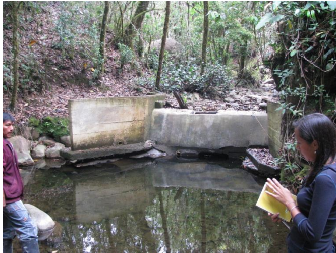
Figura 32. Bocatoma Vereda Altamira
