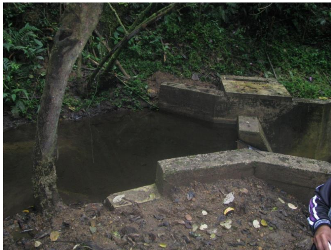
Figura 22. Bocatoma Vereda San Isidro
