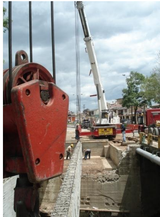
IMAGEN 34. IZAJE FINAL DE LA VIGA
