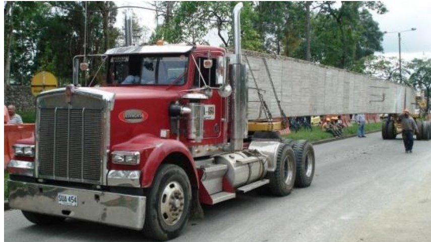
IMAGEN 31. TRANSPORTE DE LA VIGA AL SITIO DE IZAJE FINAL
