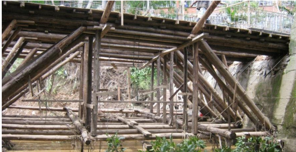
IMAGEN 8. OBRA FALSA DEL PUENTE
