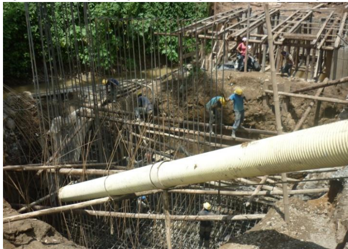
IMAGEN 1. ELABORACION DEL REFUERZO DEL ESTRIBO
