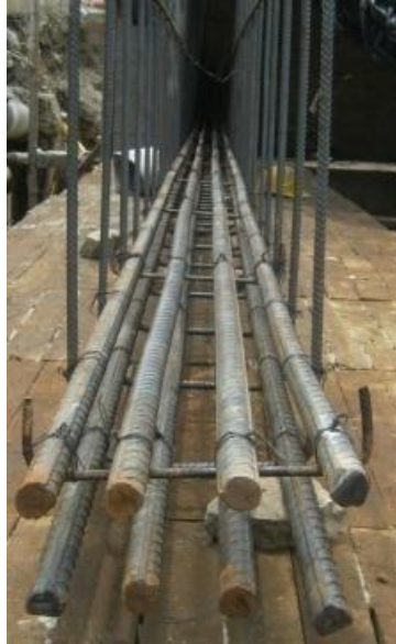
IMAGEN 10. VARILLAS DEL REFUERZO PRINCIPAL
