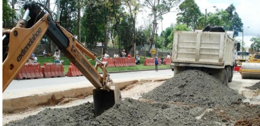
IMAGEN 32. MEJORAMIENTO DE SUELO
