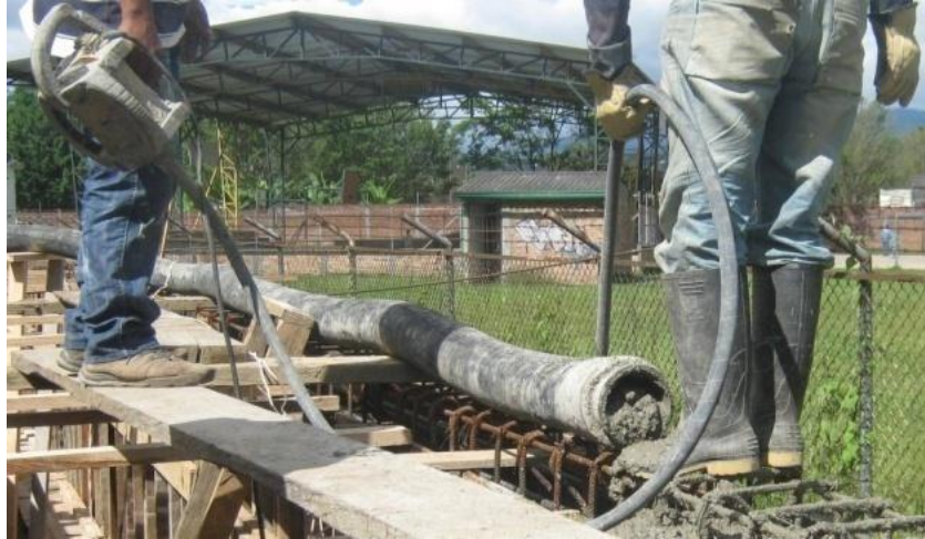
IMAGEN 18. VIBRADO DEL CONCRETO EN LA FUNDICION DE VIGAS
