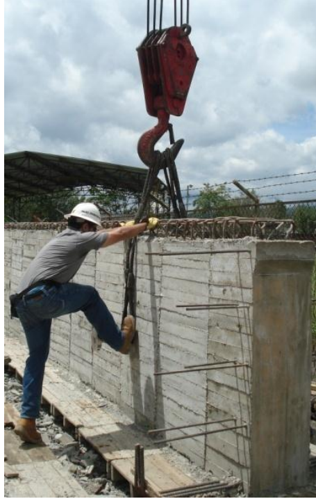
IMAGEN 26. AMARRE DE LA VIGA
