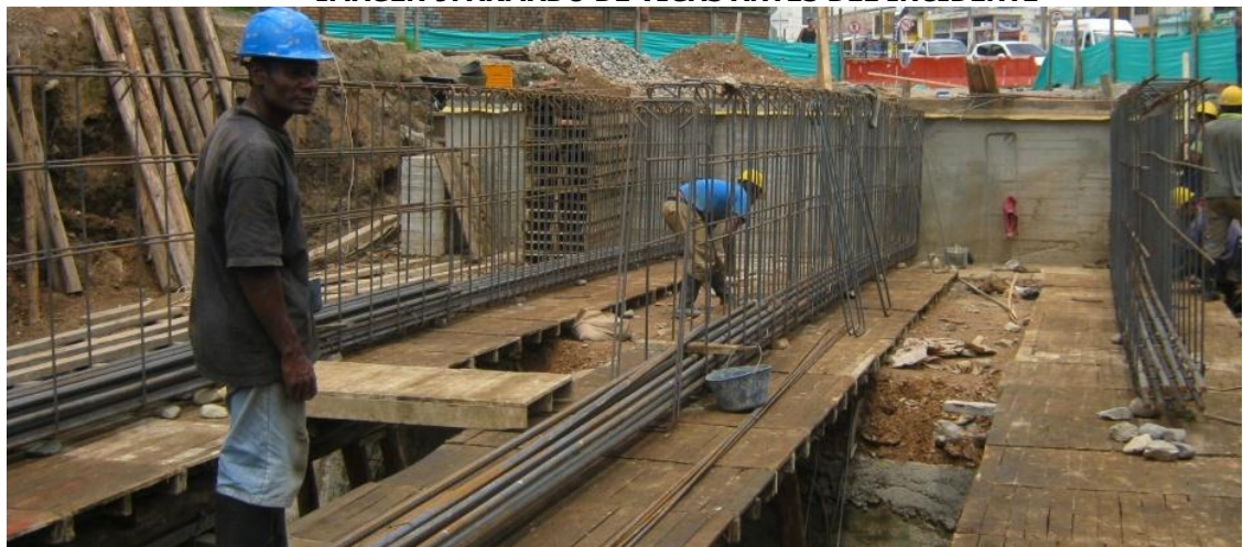
IMAGEN 9. ARMADO DE VIGAS ANTES DEL INCIDENTE
