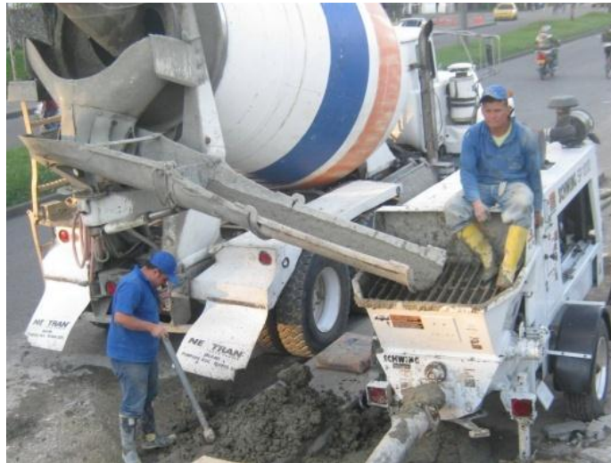
IMAGEN 19. BOMBEO DEL CONCRETO PARA LAS VIGAS
