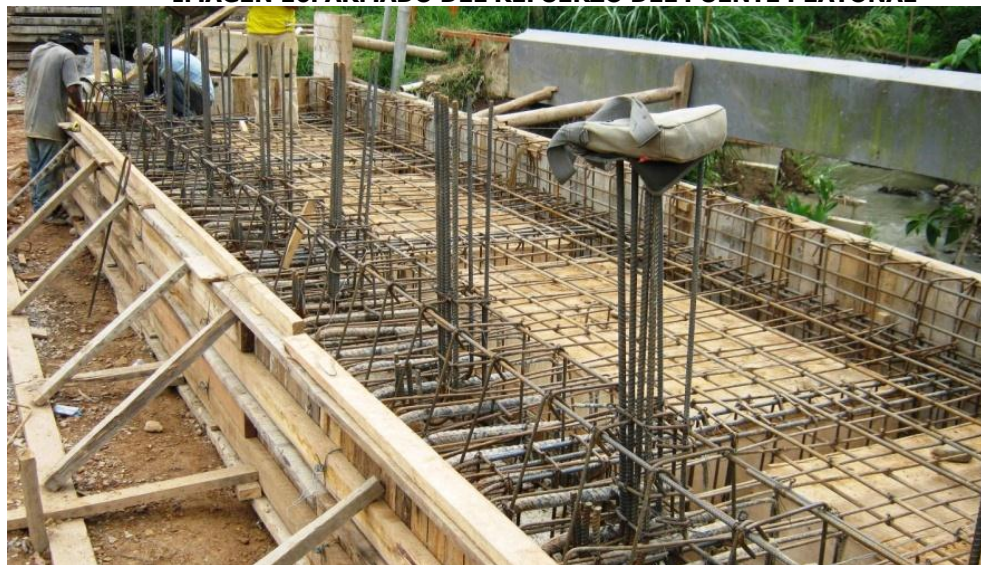
IMAGEN 16. ARMADO DEL REFUERZO DEL PUENTE PEATONAL
