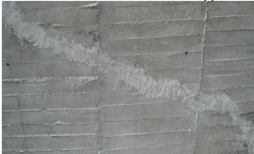
IMAGEN 25. SUBSANE DE LA VIGA (2)
