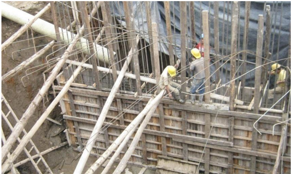
IMAGEN 2. ARMADO DE FORMALETA DEL ESTRIBO
