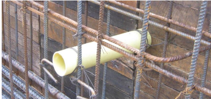
IMAGEN 17. TUBO PVC PARA EL PASADOR DE LAS VIGAS
