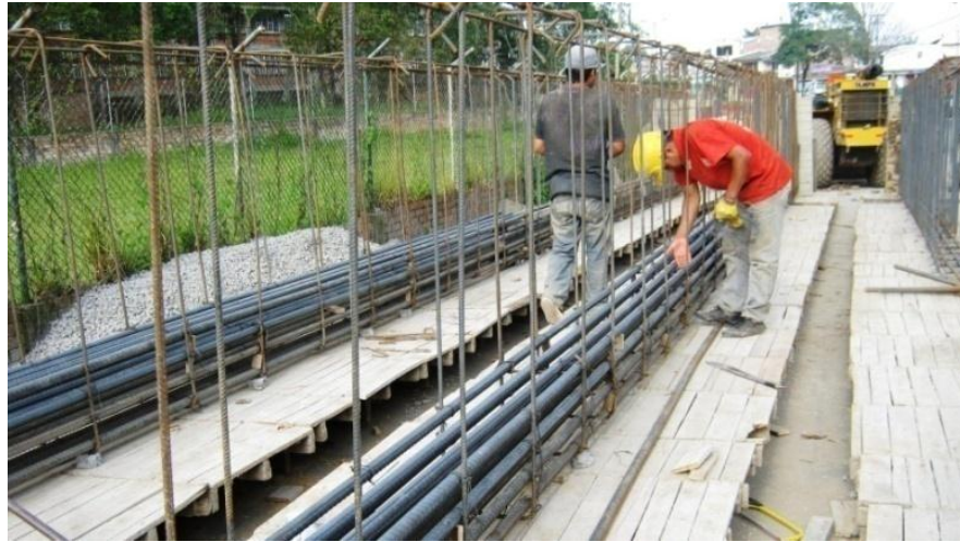
IMAGEN 15. ARMADO DEL REFUERZO DE LAS VIGAS CON EL NUEVO DISEÑO
