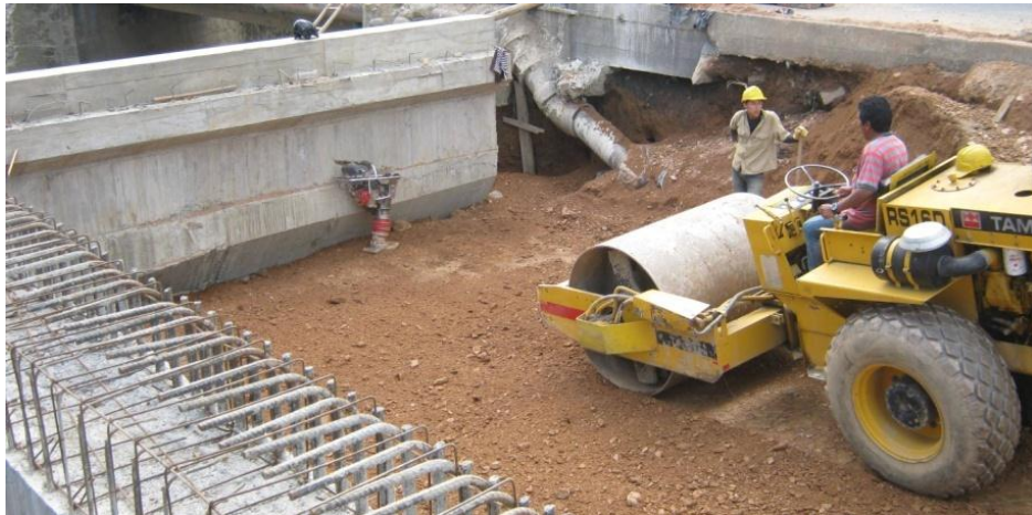
IMAGEN 6. COMPACTACION CON EL VIBROCOMPACTADOR
