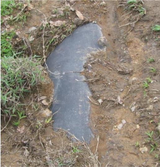
**Figura 31.** Tubería expuesta a daños.
