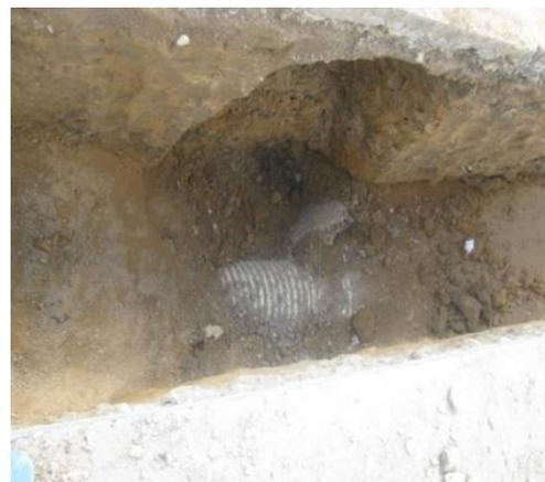
**Figura 8.** Relleno tipo II mecánico
