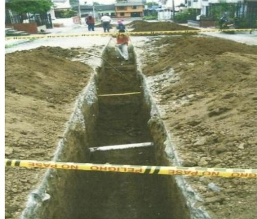
**Figura 2.** Excavación en material común
