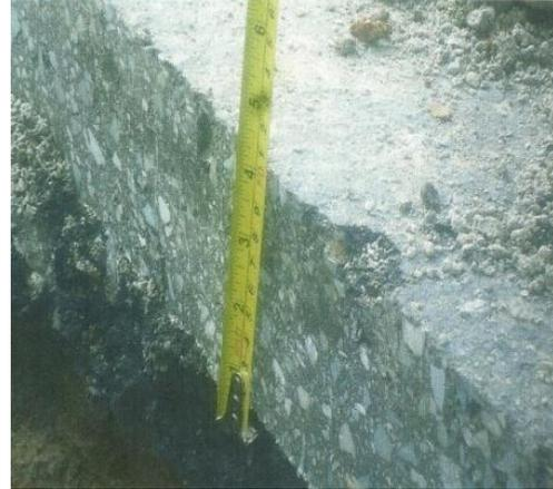
**Figura 14.** Espesor carpeta asfáltica
