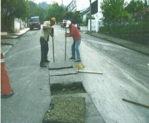
**Figura 1.** Demolición de pavimento asfáltico
