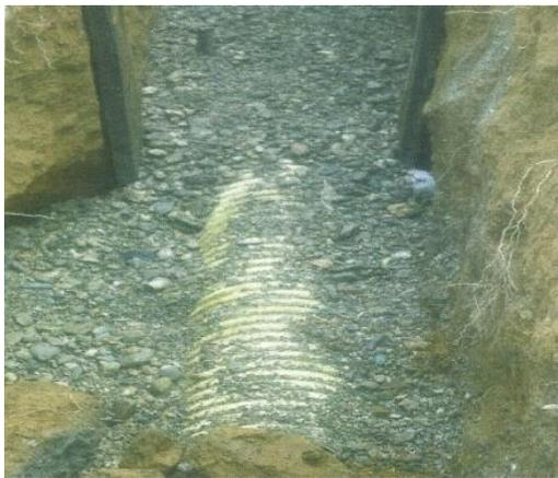
**Figura 7.** Colocación de material granular para cimentación
