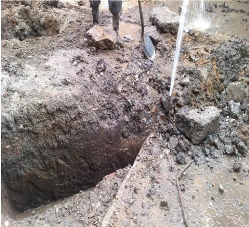
**Figura 15.** Tubería de acueducto rota por la retroexcavadora
