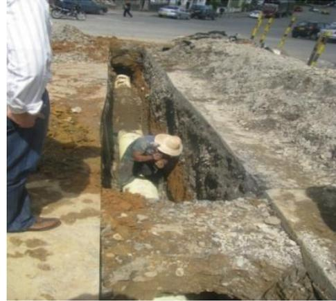
**Figura 6.** Colocación de tubería nueva
