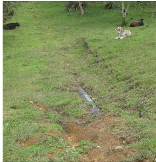
**Figura 32.** Tubería expuesta en presencia de animales.
