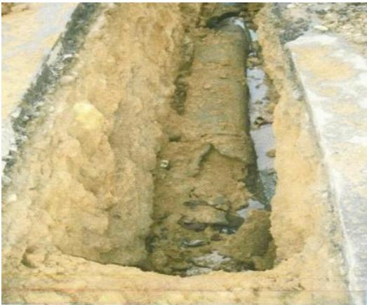
**Figura 3.** Tubería existente en asbesto cemento
