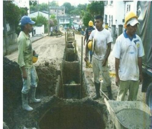
**Figura 10.** Construcción cámara de concreto
