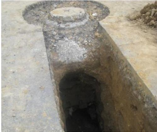
**Figura 9.** Demolición cámara de inspección en ladrillo
