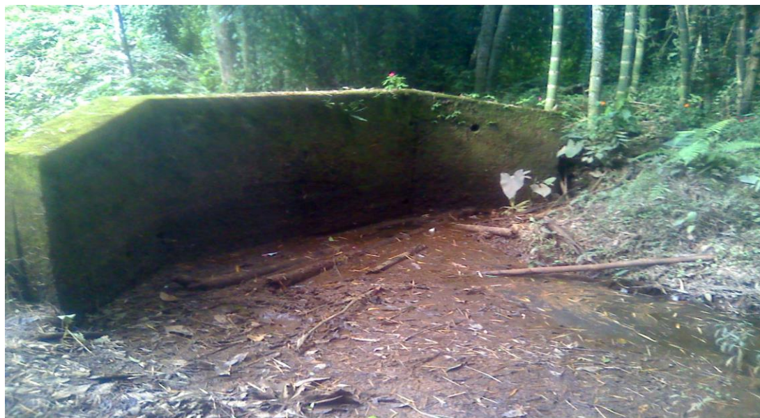
Taponamiento del tubo de la alcantarilla
