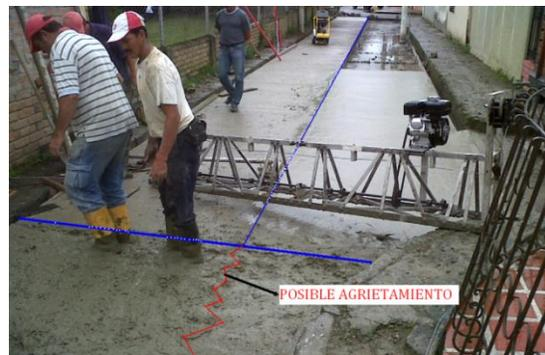
*Foto 35. Refuerzo de Losa      Foto 36. Discontinuidad de la Junta Longitudinal*
