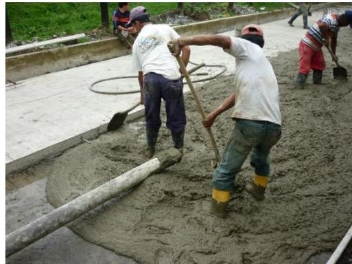
*Foto 14 y Foto 15. Distribución Uniforme del Concreto*
