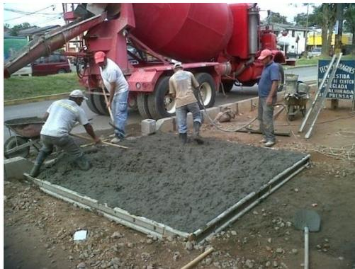
*Foto 46. Vaciado de mezcla en las losas de acceso vehicular*
