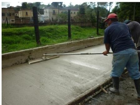
*Foto 18. Perfilado del Concreto*
