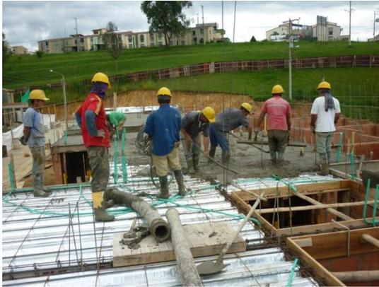
Foto 45. Losa fundida con sistema de bombeo
