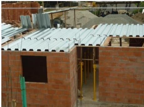
*Foto 43. Lámina steel deck*
