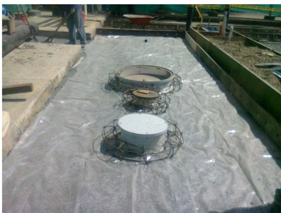
*Foto 40. Instalación del plástico sobre el triturado*
