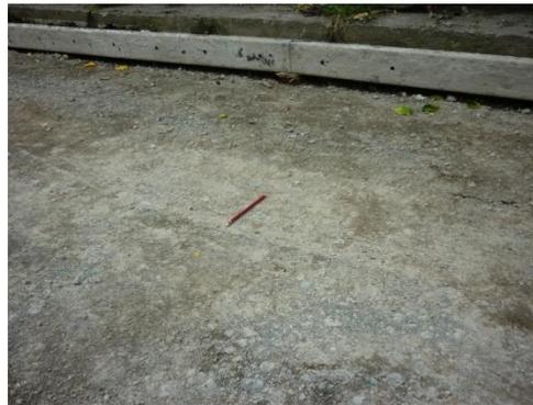
*Foto 32. Deformación de la Sub-Base*
