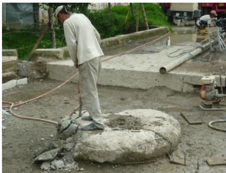
Foto 24 y Foto 25. Demolición de Caja Telefónica y Brocal
