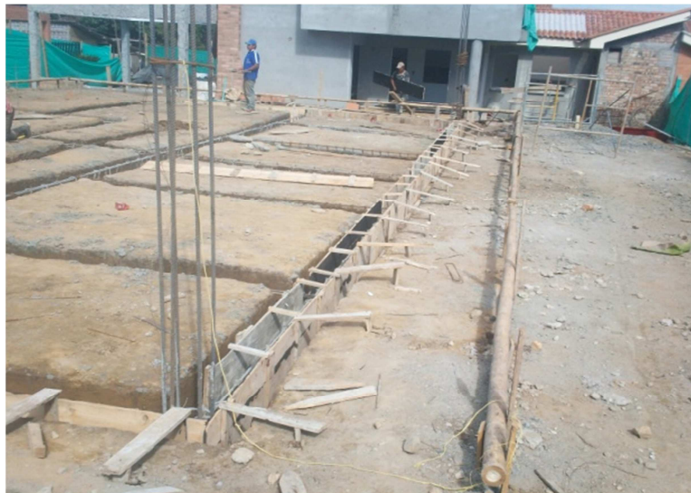
Figura 15. Cimentación con formaleta.
