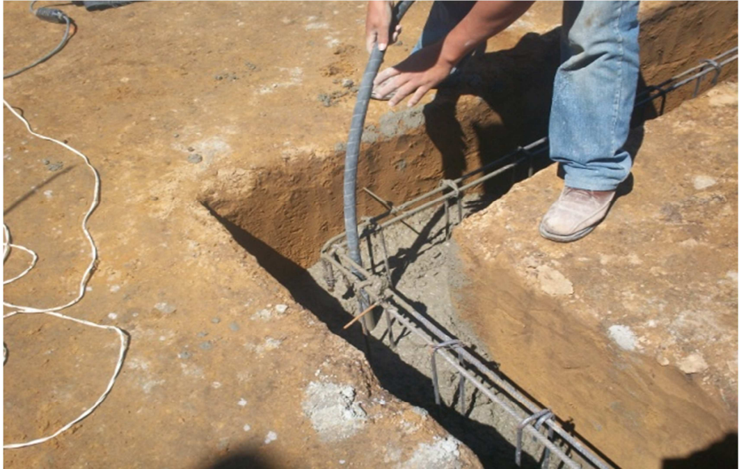
Figura 16. Operario vibrando la cimentación.
