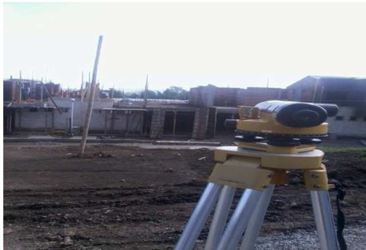
Figura 28. Nivelación de losa de entrepiso casa 35.
