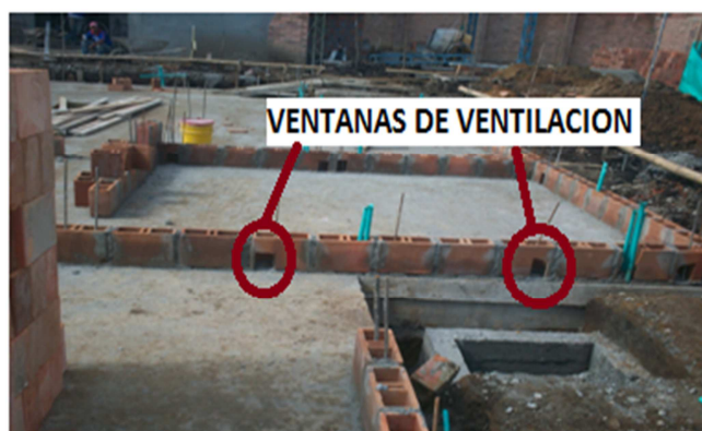
Figura 21. Pega de primera hilada de muro y ventanas de ventilación.
