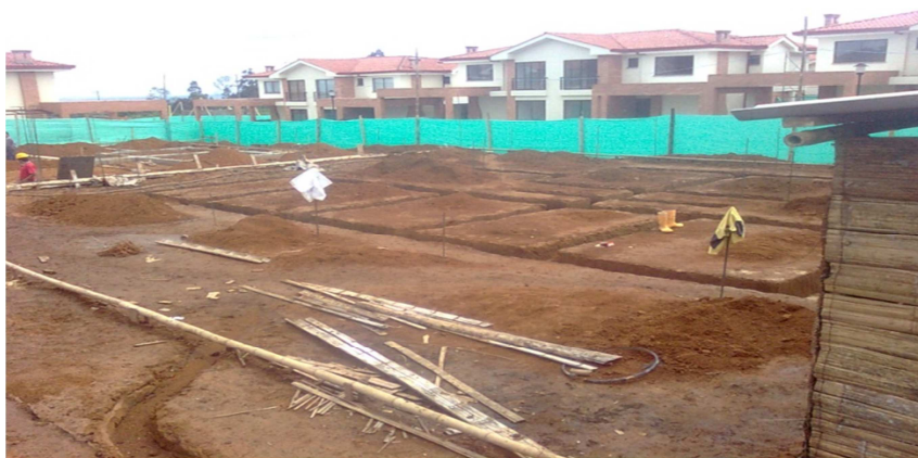
Figura 13. Excavación de un lote.
