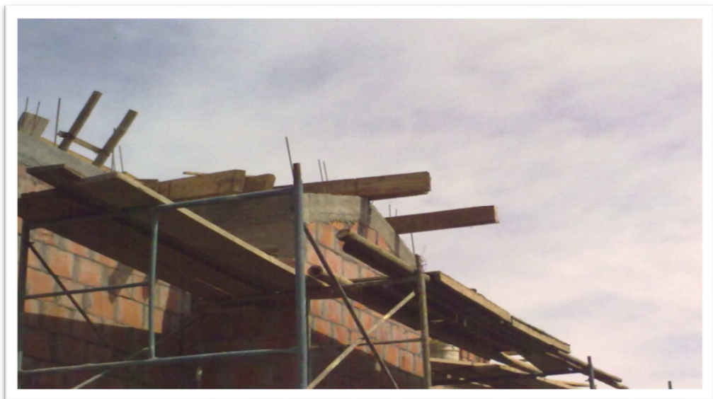
Figura 36. Viga de cubierta con sus respectivos apoyos.
