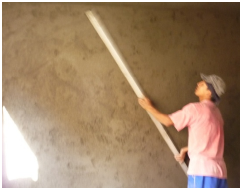
Figura5 42. Recorrido con codal de aluminio.
