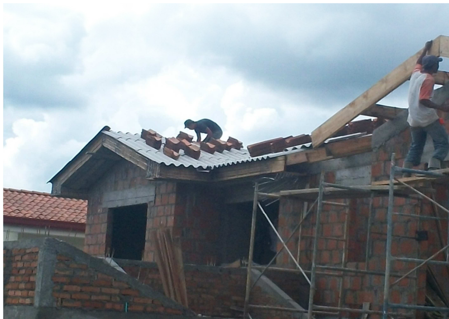
Figura 41. Cubierta en construcción.
