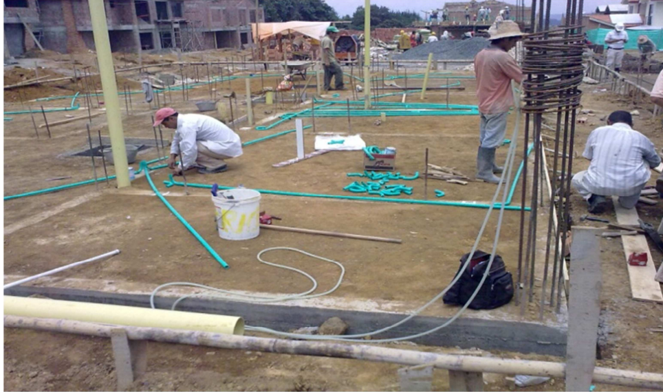
Figura 19. Instalación de la tubería de cableado
