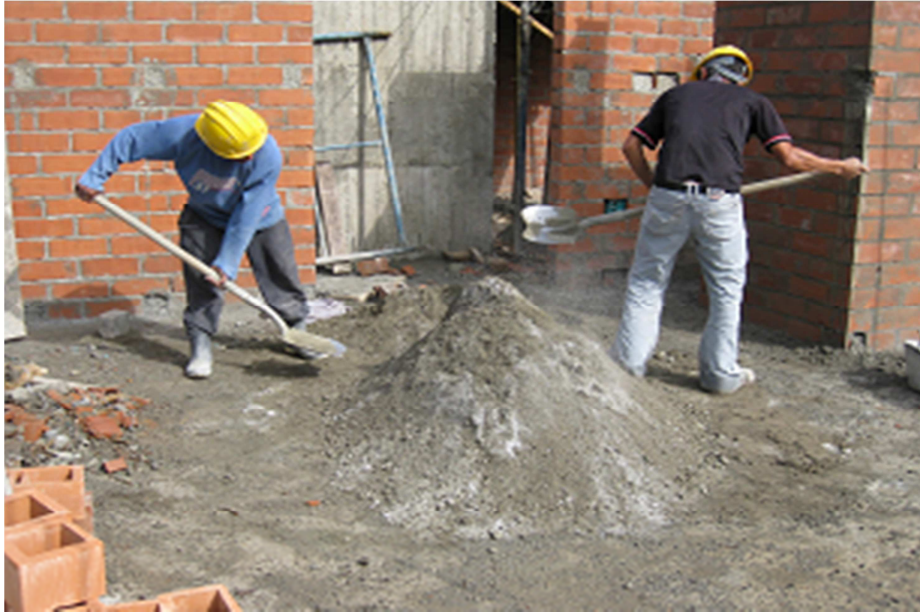
Figura 10. Preparación de mortero de pega.
