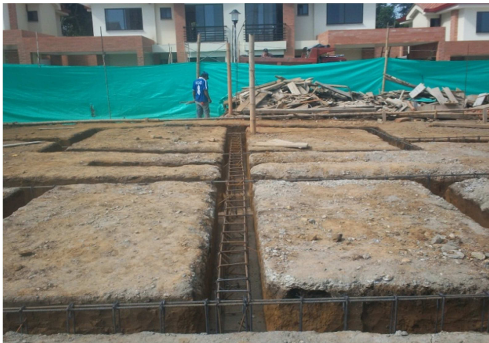
Figura 14. Acero de refuerzo para la cimentación.
