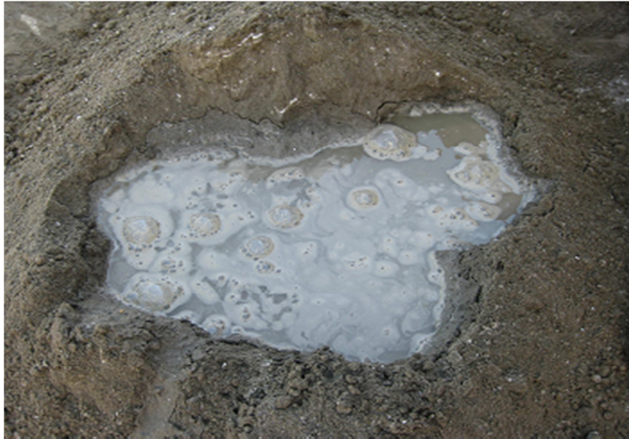
Figura 11. Preparación de mortero de pega.
