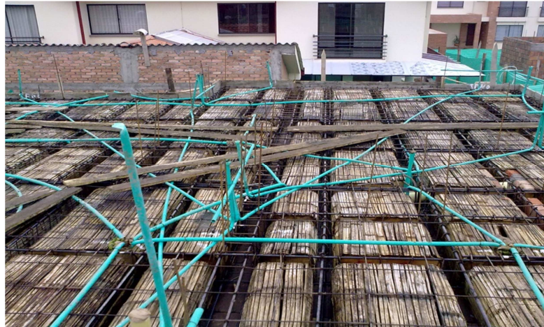
Figura 31. Tubería para cableado eléctrico y malla de acero para retracción y temperatura.
