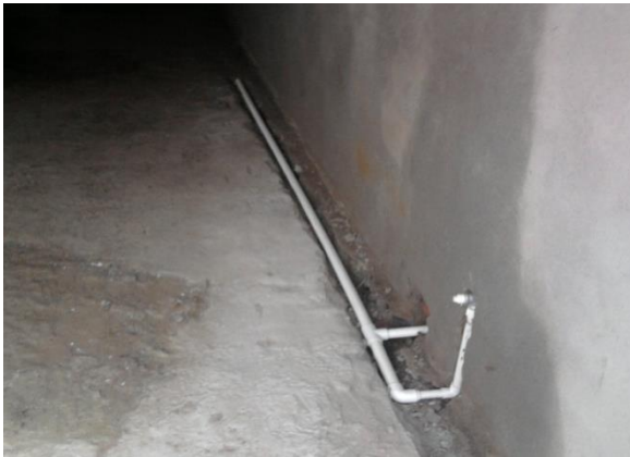
FIGURA 92 Instalación de la red de tubería en pisos
