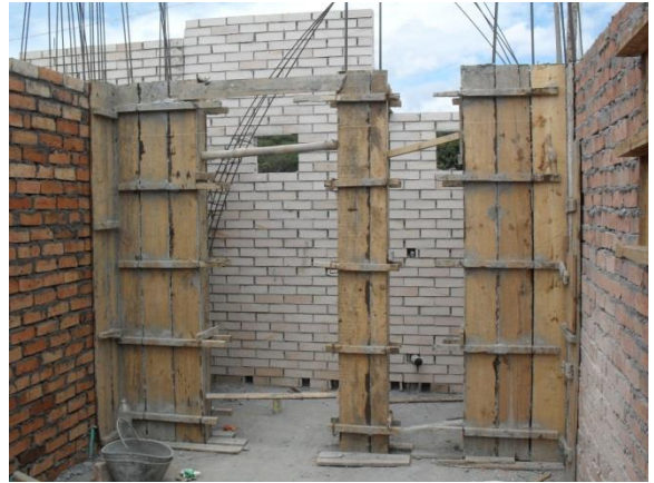
FIGURA 57 Chequeo de verticalidad a columnas y pantallas
