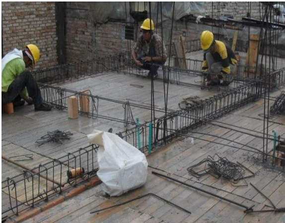
FIGURA 68 Colocación de estribos de la viga de entrepiso
