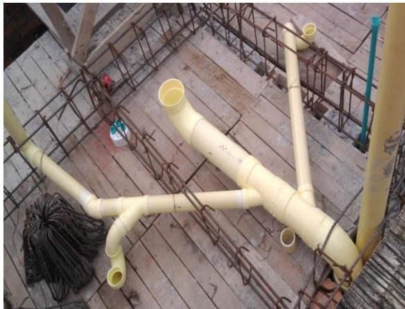
FIGURA 72 Instalación de tubería sanitaria de entrepiso baño principal
