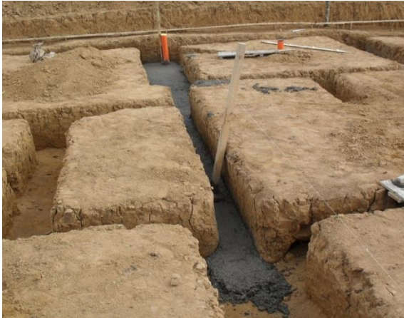
FIGURA 12 Vertido de solado de limpieza
