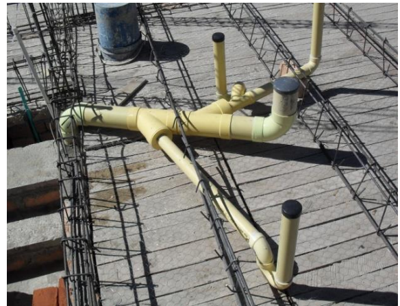
FIGURA 73 Instalación de tubería sanitaria de entrepiso baño social
