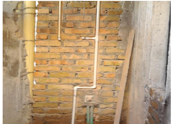
FIGURA 93 Instalación de la red de tubería en pared
