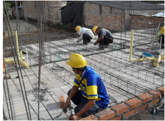
FIGURA 71 Colocación del refuerzo de los nervios de la losa aligerada
