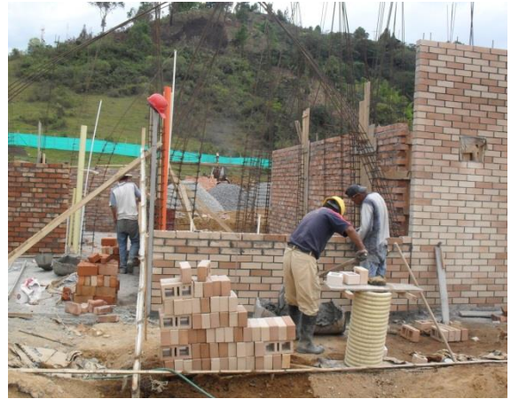
FIGURA 55 Muro en soga con ladrillo limpio
