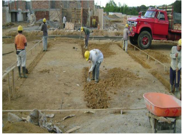
FIGURA 5 Inicio de excavaciones
