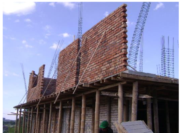
FIGURA 87 Chequeo del alineamiento y verticalidad de los muros
