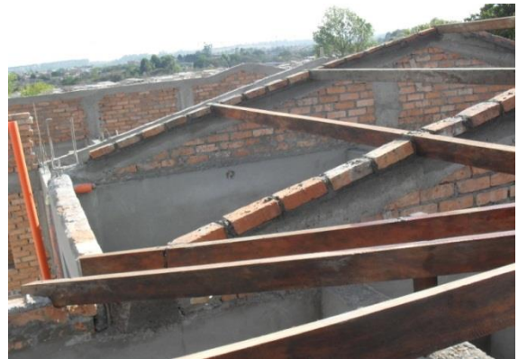
FIGURA 101 Hilada de ladrillo común para asegurar las vigas de madera
