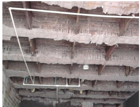
FIGURA 95 Instalación suspendida de la red de tubería hidráulica, sección garaje
