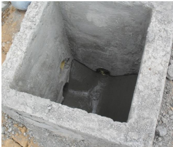
FIGURA 37 Caja de inspección con cañuela
