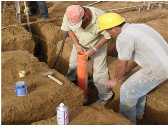
FIGURA 10 Ubicación de la tubería para agua lluvia
