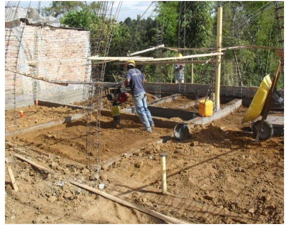
FIGURA 47 Compactación mecánica
