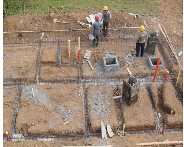
FIGURA 21 Instalación de los castillos de la viga de cimentación
