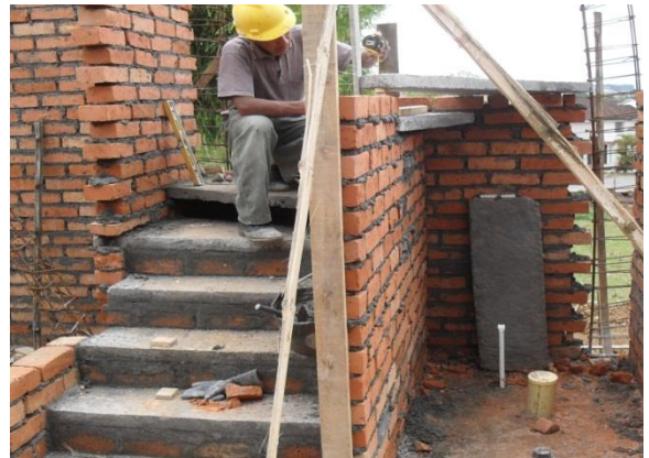
FIGURA 65 Colocación de los escalones de las gradas
