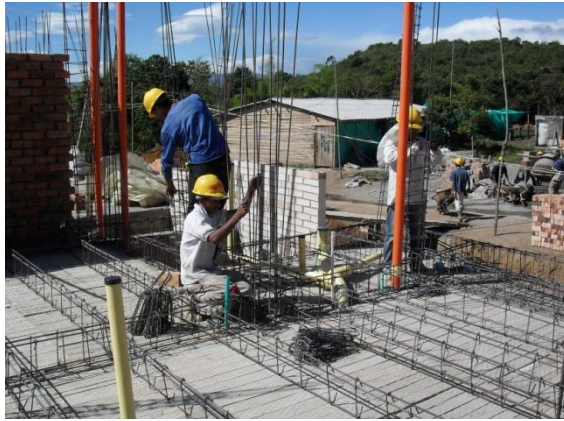
FIGURA 70 Colocación de estribos de las columnas y pantallas
