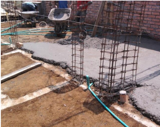
FIGURA 50 Vertido de mezcla para primario
