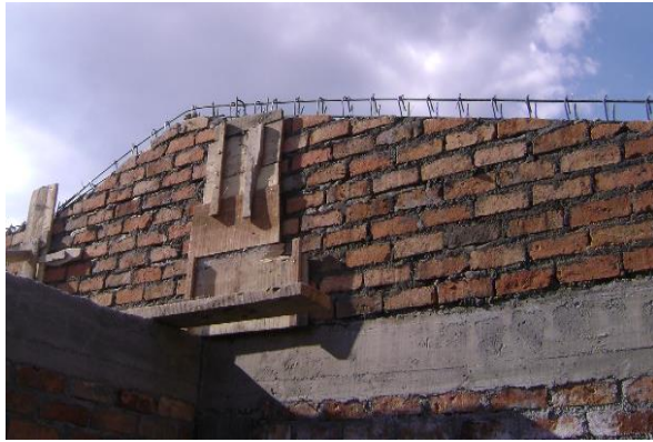
FIGURA 98 Colocación del refuerzo de cinta de confinamiento
