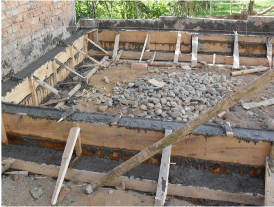
FIGURA 41 Remate o enrase de la viga de cimentación
