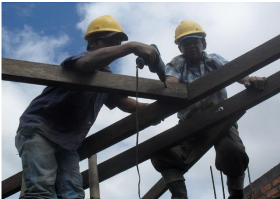
FIGURA 100 Colocación de las vigas de madera para el soporte de la cubierta
