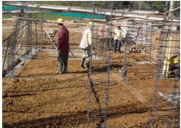
FIGURA 45 Compactación del material de manera gradual hasta el nivel de la viga
