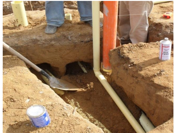
FIGURA 11 Acomodo y pendiente de la tubería sanitaria
