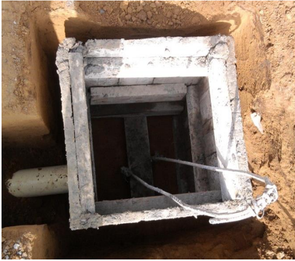
FIGURA 31 Formaleta rectangular de madera y reutilizable
