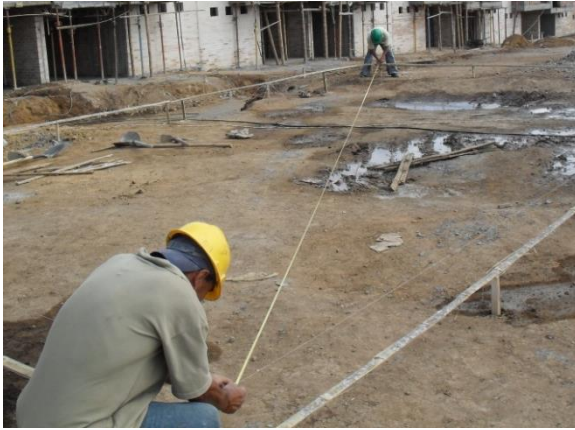
FIGURA 4 Localización y planteo de ejes
