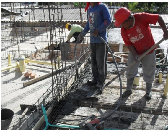
FIGURA 84 Proceso de vibrado en la fundición de la losa de entrepiso
