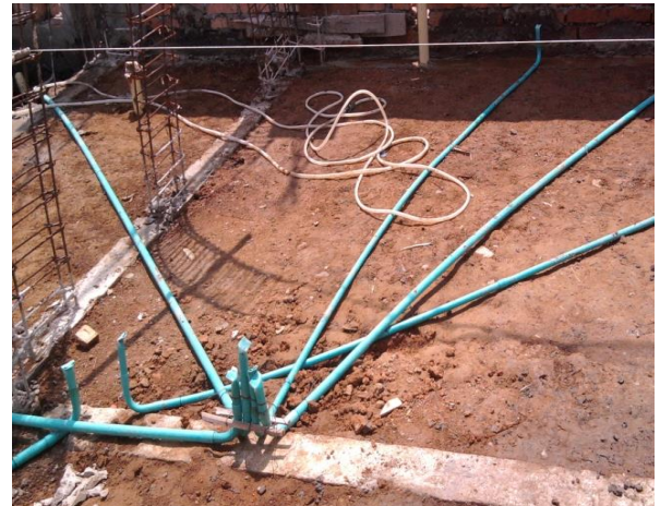
FIGURA 49 Instalación de la red de tubería eléctrica
