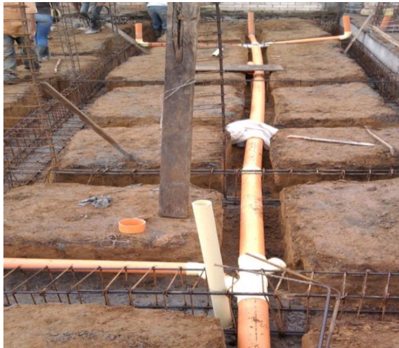
FIGURA 26 Chequeo previo de la funcionalidad de la tubería
