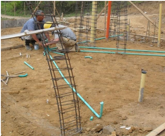
FIGURA 48 Identificación de puntos eléctricos
