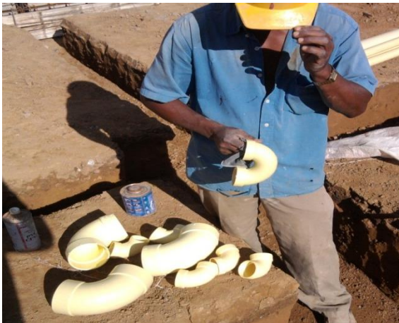
FIGURA 14 Identificación de la tubería sanitaria
