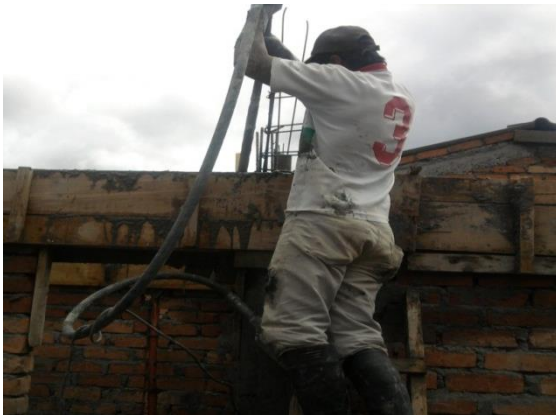
FIGURA 88 Proceso de vibrado en la fundición de la viga de amarre
