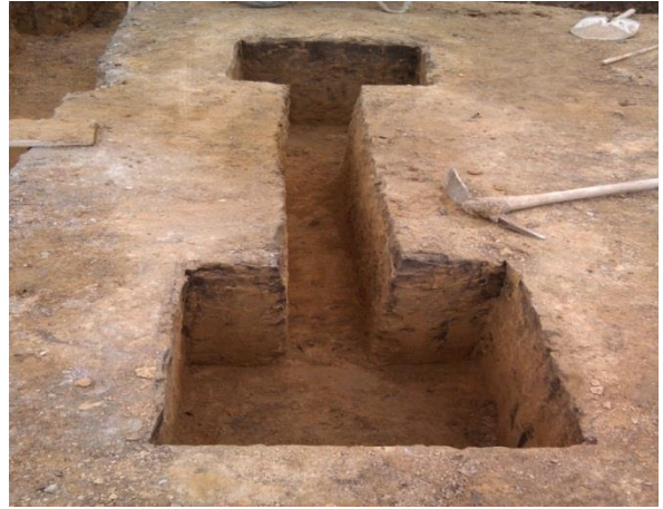
FIGURA 8 Zanjas de intercomunicación entre cajas de inspección
