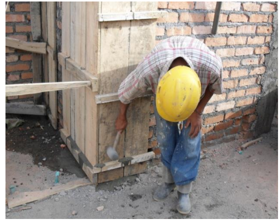
FIGURA 61 Proceso de golpeteo con martillo de caucho
