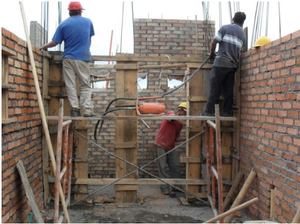
FIGURA 60 Proceso de vibrado en columnas y pantallas
