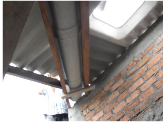
FIGURA 103 Colocación de los canales recolectores de agua lluvia
