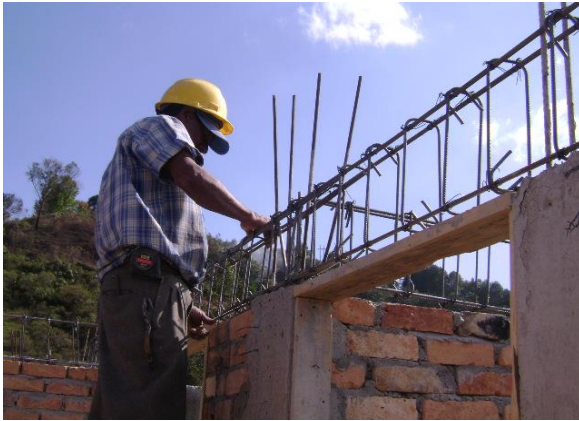
FIGURA 93 Colocación de los castillos de la viga de amarre
