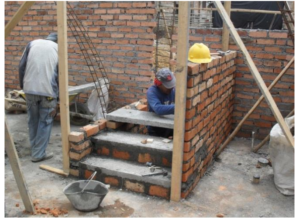
FIGURA 63 Confinamiento de los escalones con el muro de ladrillo común
