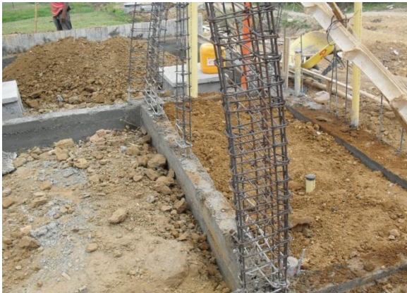
FIGURA 44 Enraze con material limo arcilloso de manera gradual
