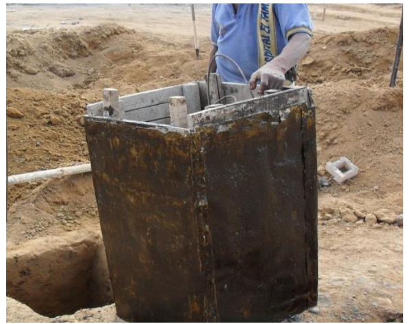
FIGURA 34 Retiro de la formaleta reutilizable
