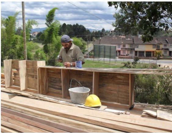
FIGURA 74 Fabricación artesanal de casetones
