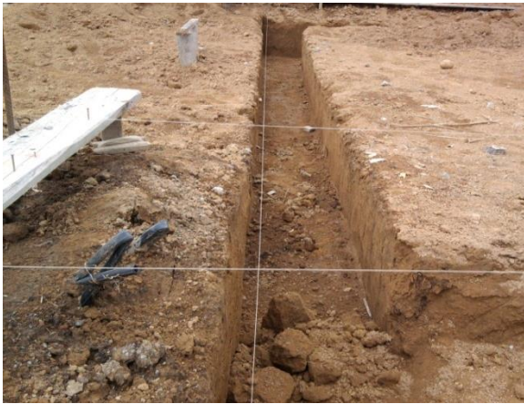
FIGURA 6 Hilos guía para excavaciones de las zanjas
