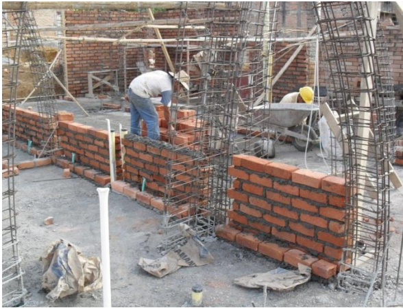
FIGURA 54 Muro en soga con ladrillo común
