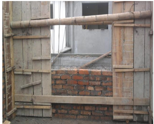
FIGURA 59 Alineación de pantallas con listones
