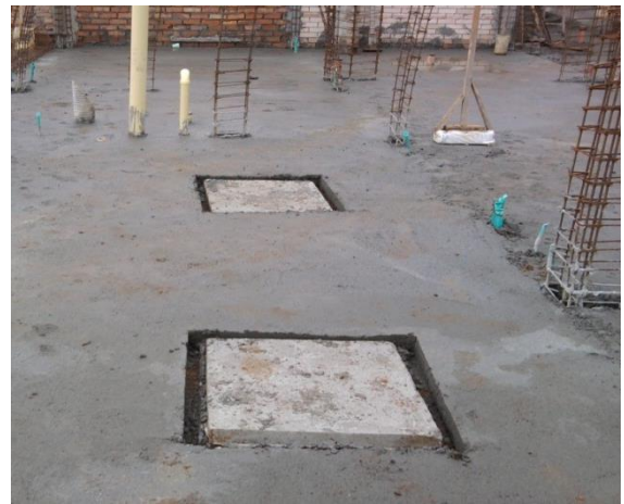
FIGURA 53 Chequeo de tapas de cajas de inspección con una correcta nivelación
