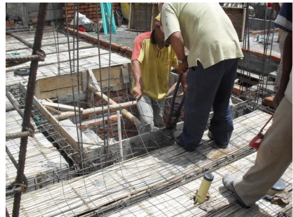
FIGURA 79 Recorte y acomodo de la malla electro-soldada
