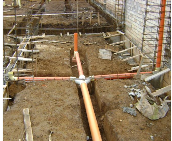
FIGURA 25 Aseguramiento de la tubería al castillo de la viga de cimentación
