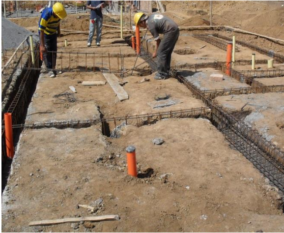
FIGURA 20 Instalación de los castillos de la viga de cimentación
