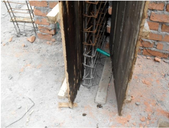
FIGURA 56 Colocación de formaletas a columnas y pantallas
