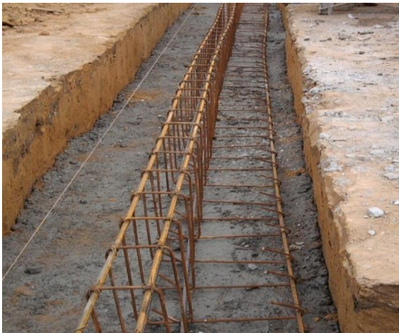
FIGURA 18 Castillo de viga de cimentación en forma de L
