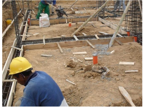
FIGURA 29 Colocación de la formaleta de la viga de cimentación
