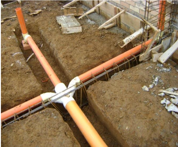
FIGURA 24 Adecuación de la tubería de agua lluvia para garantizar su pendiente
