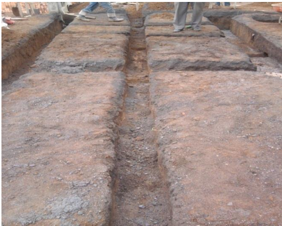
FIGURA 8 Zanja para tubería de agua lluvia
