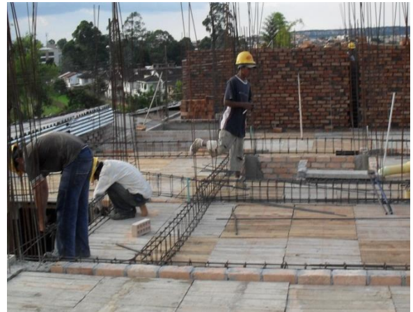
FIGURA 69 Colocación de estribos de la viga de entrepiso
