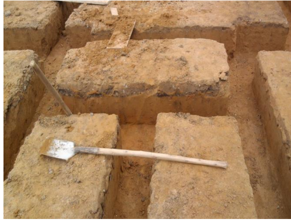
FIGURA 7 Limpieza de zanjas
