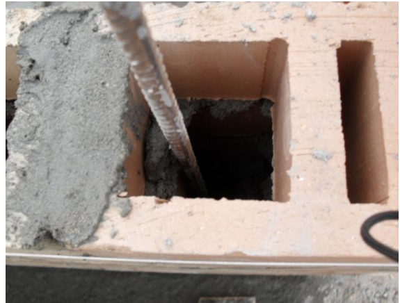
FIGURA 60 Refuerzo del muro estructural
