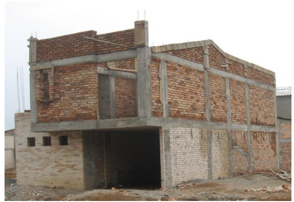
FIGURA 99 Colocación de la formaleta para la cinta de confinamiento
