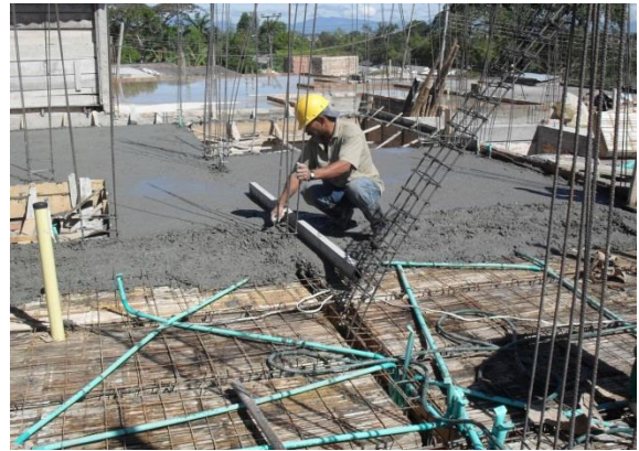
FIGURA 83 Tallado y atezado de la losa de entrepiso
