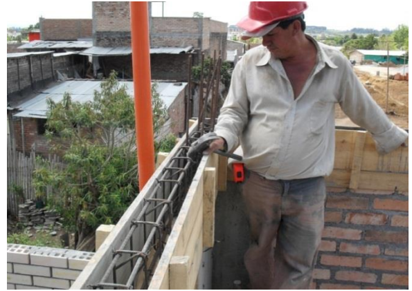
FIGURA 94 Colocación de la formaleta de la viga de amarre
