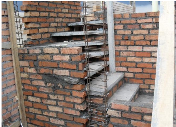
FIGURA 64 Colocación de los escalones de las gradas
