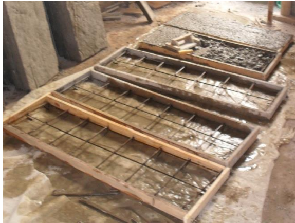
FIGURA 62 Refuerzo de las placas prefabricadas para las gradas
