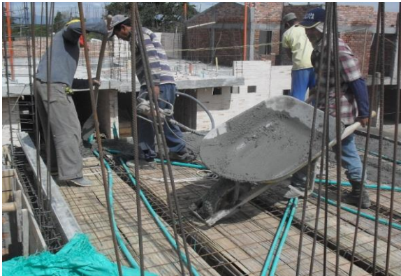
FIGURA 80 Vertido de concreto con carretas o buggis
