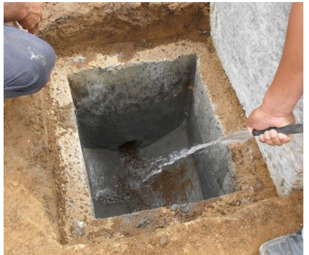
FIGURA 38 Chequeo de la funcionalidad de las cajas de inspección
