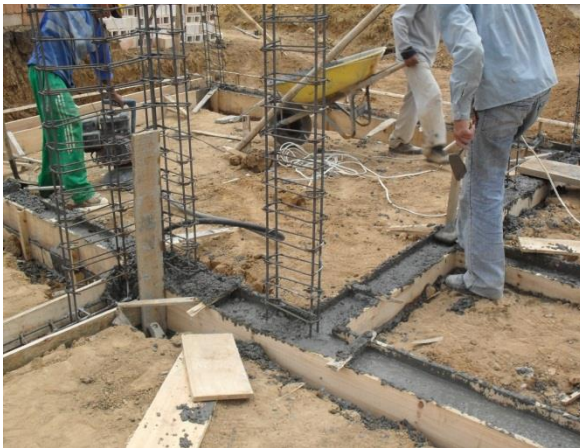
FIGURA 39 Fundición de la viga de cimentación
