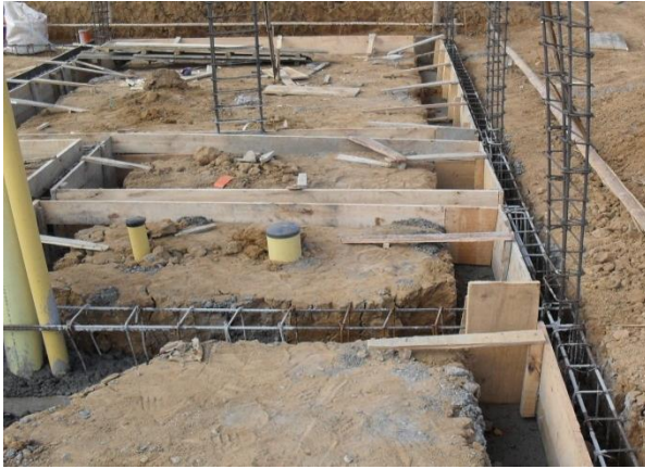
FIGURA 28 Colocación de la formaleta de la viga de cimentación
