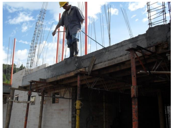
FIGURA 85 Proceso de curado (hidratación) de la losa de entrepiso
