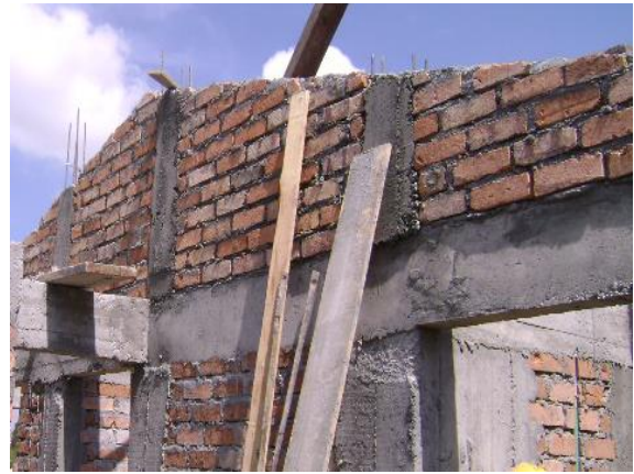
FIGURA 97 Levantamiento de columnas de confinamiento
