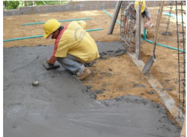
FIGURA 51 Atezado con llana de madera
