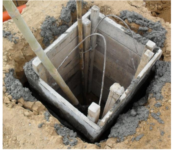
FIGURA 32 Fundición de la aja de inspección
