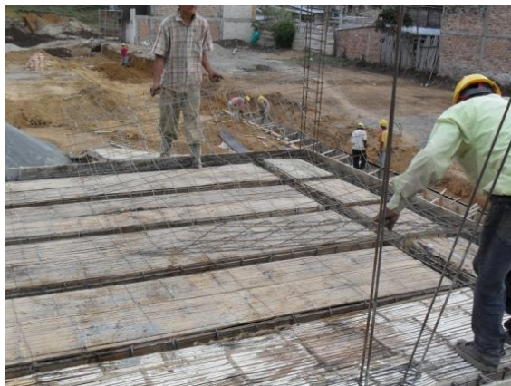
FIGURA 78 Instalación de malla electro-soldada
