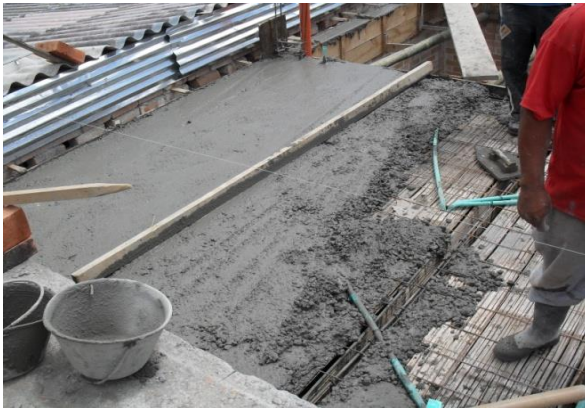
FIGURA 82 Chequeo del espesor de la losa con ayuda de hilos guía
