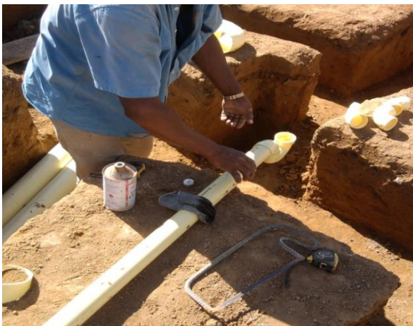
FIGURA 16 Limpieza y pegado de tubería sanitaria
