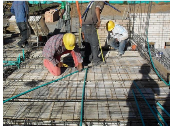
FIGURA 77 Instalación de la red de tubería eléctrica
