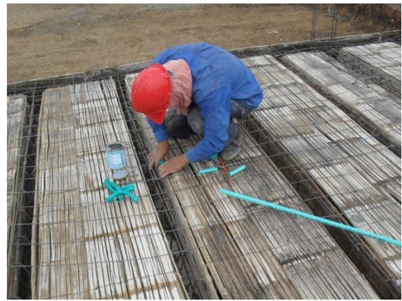
FIGURA 75 Colocación de casetones
