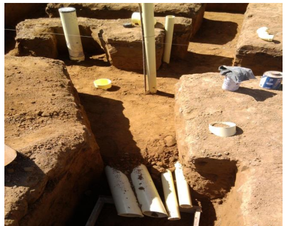
FIGURA 17 Acomodo de la tubería sanitaria
