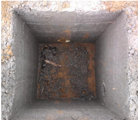
FIGURA 35 Limpieza de la caja de inspección
