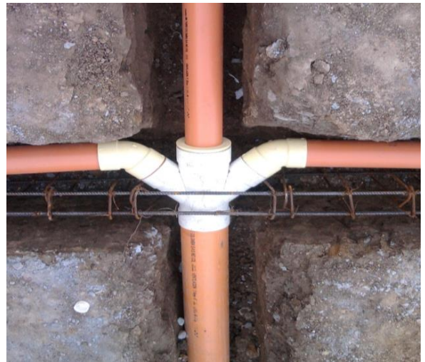
FIGURA 27 Chequeo para que la tubería no quede forzada o deflectada
