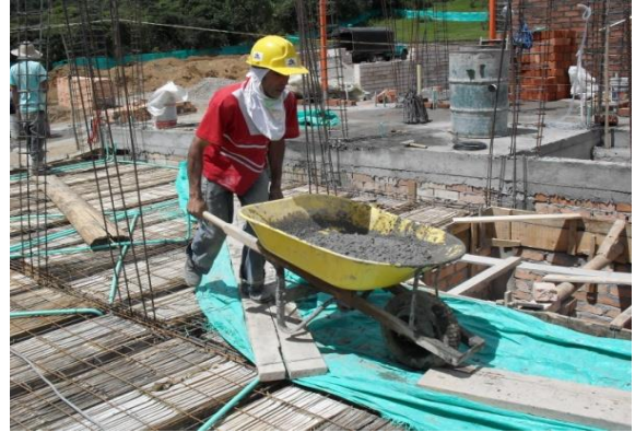
FIGURA 81 Protección del recorrido de los buggis
