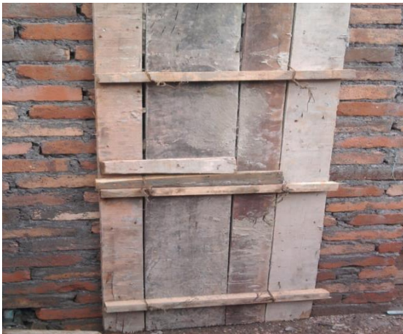
FIGURA 58 Torniquete con alambre de amarre
