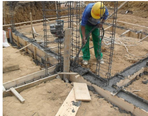
FIGURA 40 Proceso de vibrado
