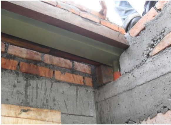
FIGURA 102 Colocación de los canales recolectores de agua lluvia
