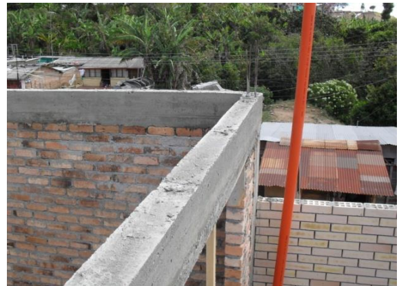
FIGURA 89 Retiro de la formaleta de la viga de amarre
