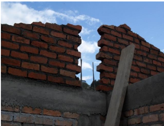
FIGURA 96 Levantamiento de hiladas de ladrillo común para elaborar las culatas.
