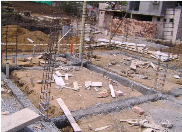
FIGURA 45 Retiro de la formaleta de la viga de cimentación
