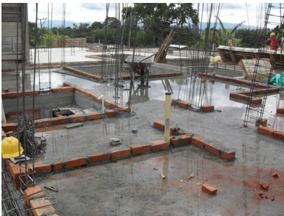
FIGURA 86 Planteo de los muros del segundo piso
