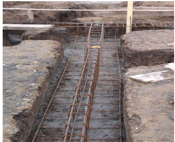
FIGURA 19 Castillo de viga de cimentación en forma de T invertido
