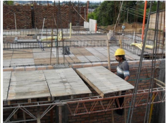
FIGURA 67 Colocación de los tableros de la estructura de soporte
