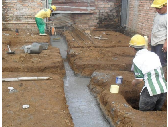
FIGURA 13 Aseo del solado de limpieza
