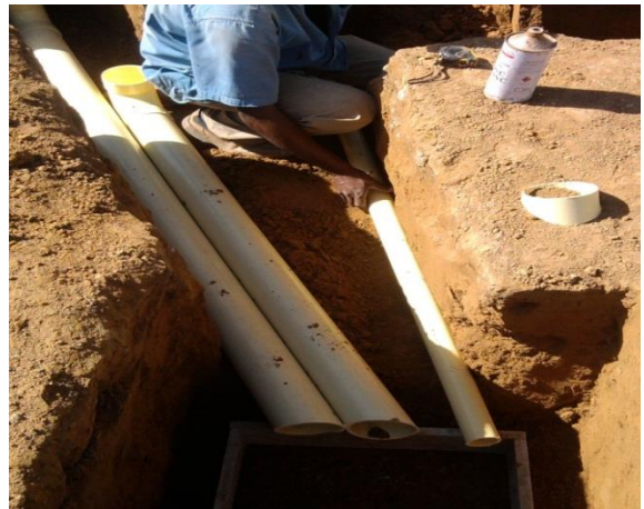
FIGURA 15 Recorte de la tubería sanitaria
