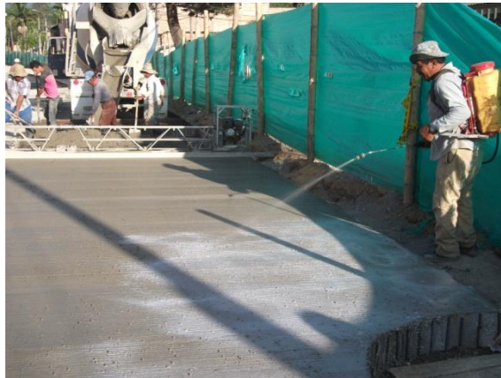
Foto No. 53 Aplicación de Antisol
