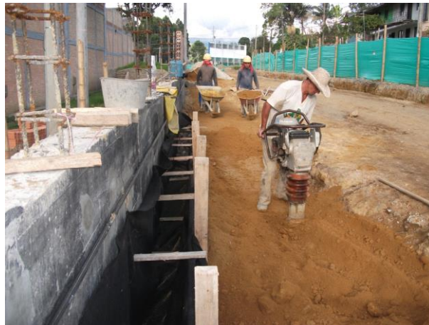
Foto No. 29 Construcción de relleno para estructuras
