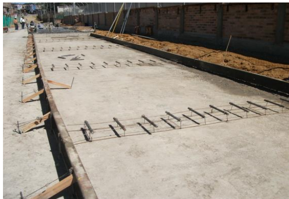
Foto No. 47 Instalación de canastillas y pasadores
