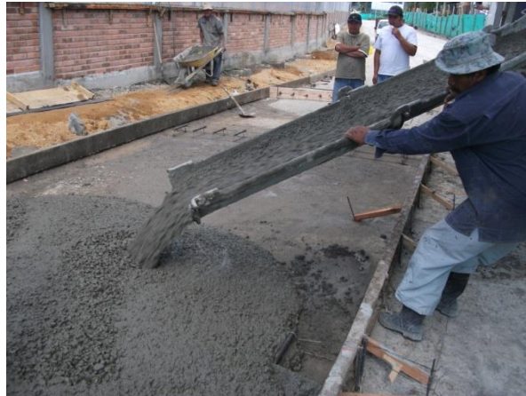
Foto No. 49 Vaciado del concreto
