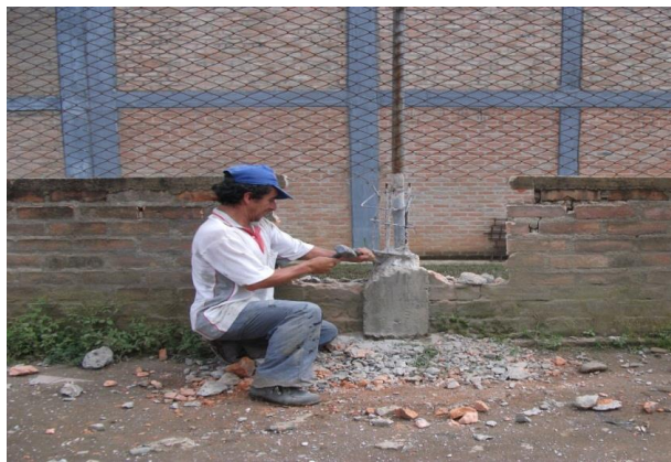
Foto No.8 Demolición manual de columnetas
