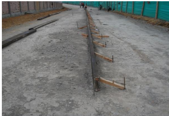
Foto No. 46 Colocación de formaleta
