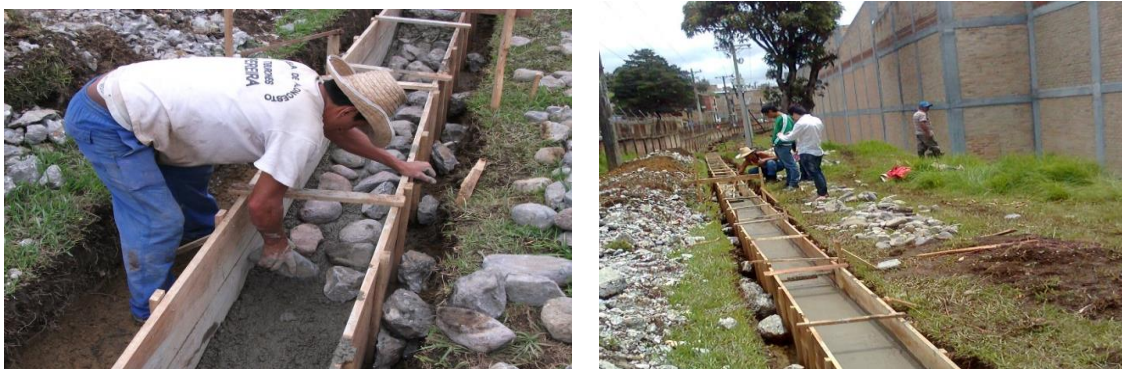
Foto No. 24 y 25 Construcción de cimentación en concreto ciclópeo
