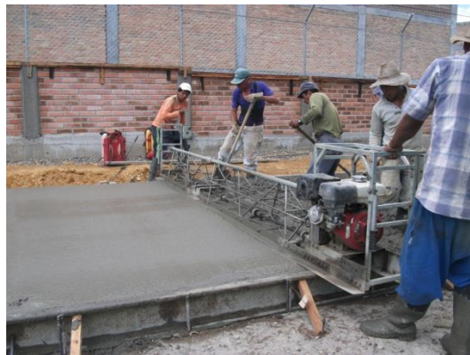
Foto No. 50 Vibrado del concreto
