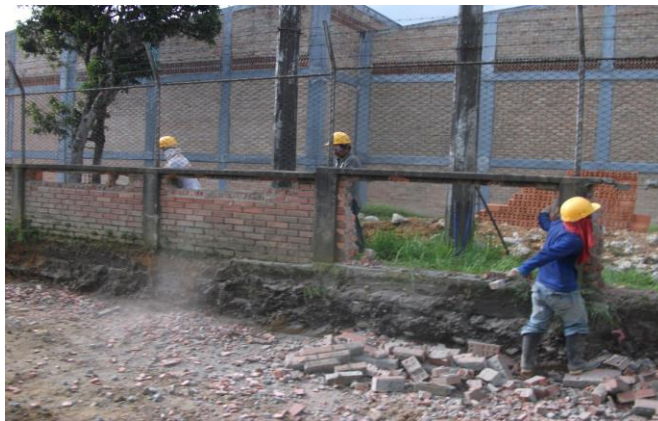
Foto No.7 Demolición manual de muro en ladrillo
