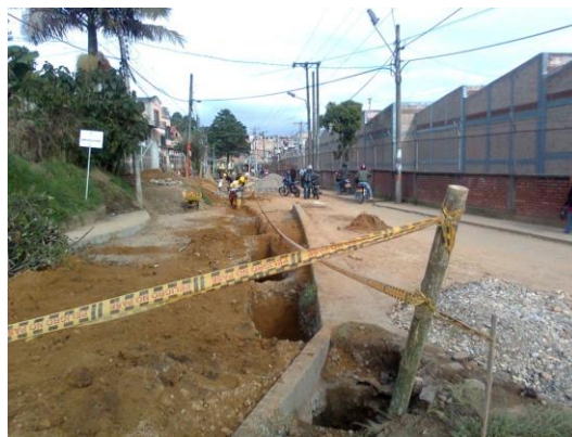
Foto No.16 Separador que fue demolido
