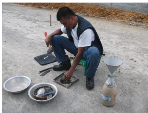
Foto No. 57 Ensayo de densidad en campo, mediante el método del cono de arena
