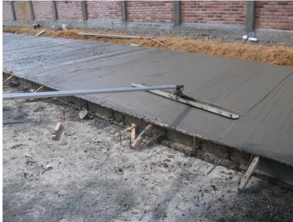
Foto No. 51 Acabado superficial
