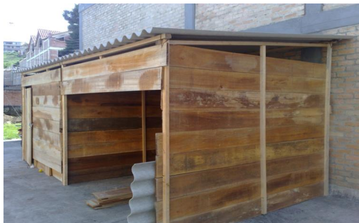
Foto No. 1 Campamento
