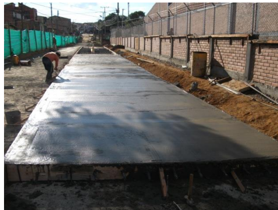
Foto No. 55 Desencofrado
