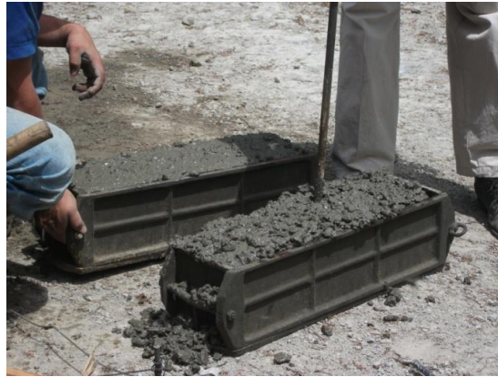
Foto No. 58 Fabricación de vigas para el ensayo de Modulo de Rotura
