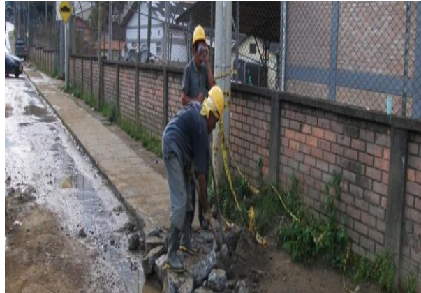
Foto N0. 13 Demolición manual de andenes
