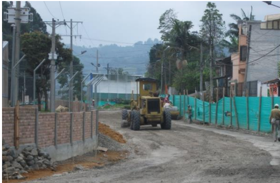
Foto No. 44 Extensión de sub-base compactación de sub-base
