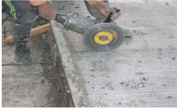
Foto No. 54 Aserrado de juntas
