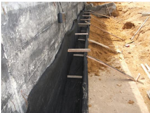
Foto No. 27 y 28 Suministro e instalación de subdrenaje
