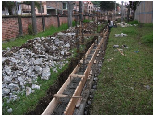
Foto No. 26 Construcción de viga de sobrecimiento
