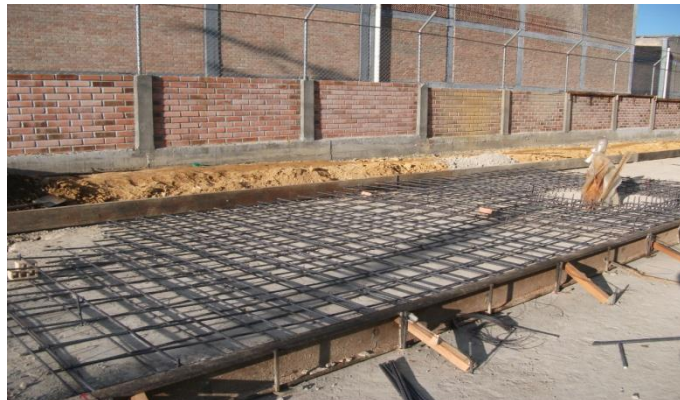
Foto No. 48 Instalación del refuerzo en losas atípicas
