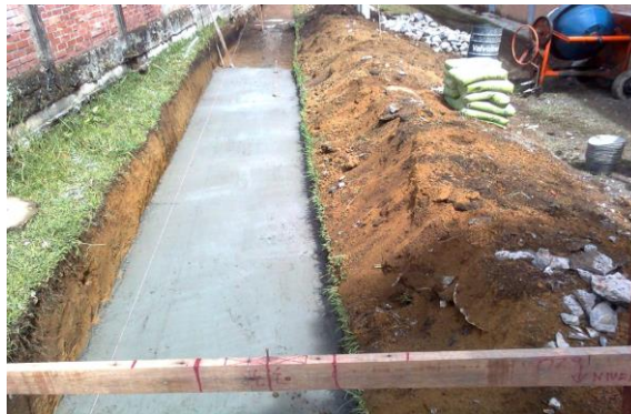
Foto No. 21 Fundición del solado de limpieza
