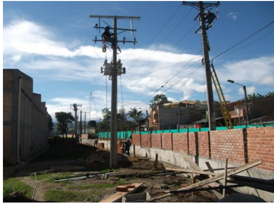
Foto No. 41 Reubicación de redes y traslado de postes
