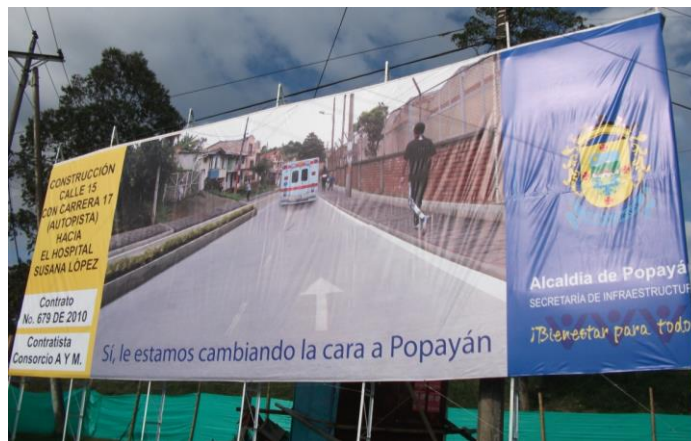
Foto No. 32 Disposición de la valla informativa
