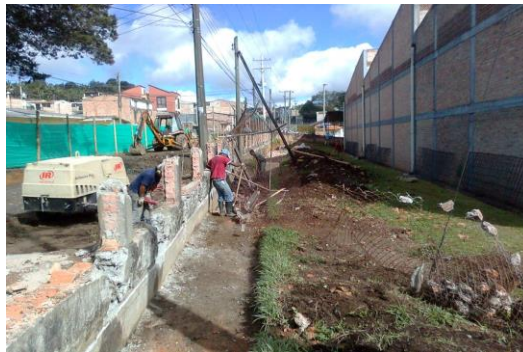
Foto No.9 Remoción de malla eslabonada
