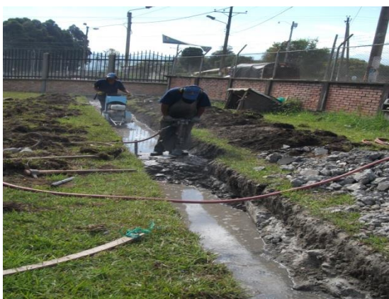
Foto No. 17 Corte de la placa con martillo de la placa de concreto neumático Retroexcavadora
