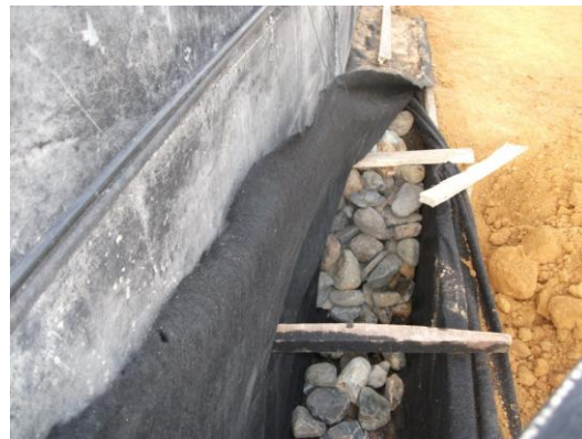
Foto No. 27 y 28 Suministro e instalación de subdrenaje
