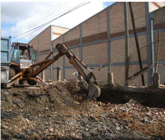
Foto No. 19 Excavación con la Retroexcavadora luego de la explanación
