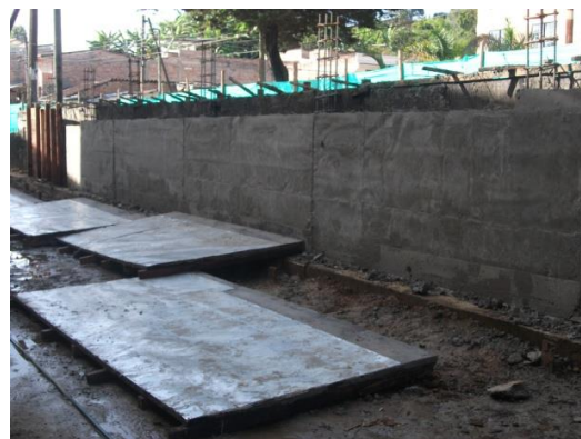
Foto No.23 Sección
