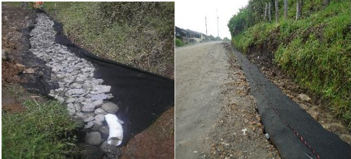
Figura 12. Construcción del Filtro
