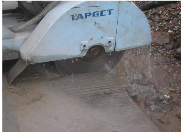
Figura 27. Corte de juntas
