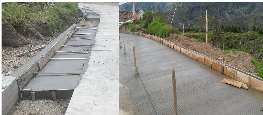
Figura 28. Cuneta y Bordillo en concreto
