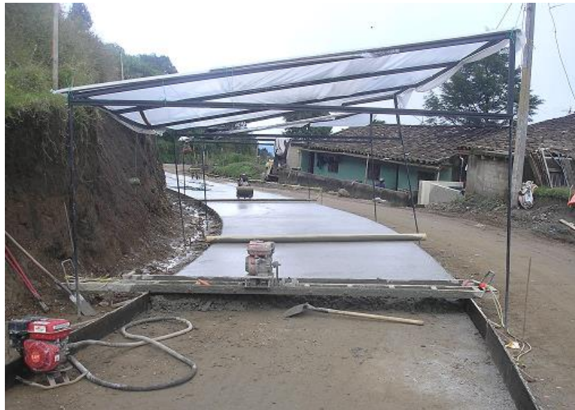
Figura 25. Vibrado del concreto
