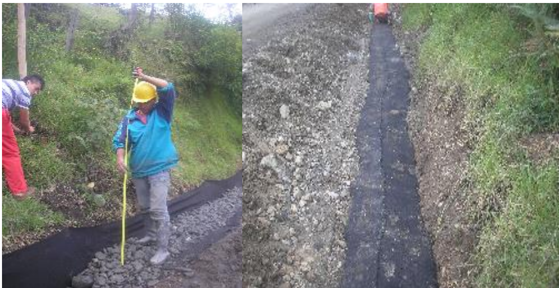
Figura 14. Construcción Filtro Adicional
