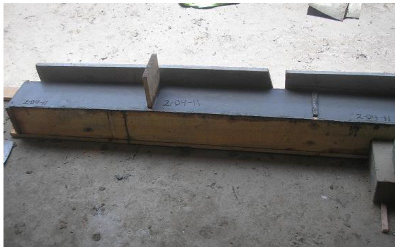
Figura 31. Construcción de Viguetas
