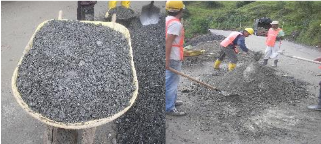
Figura 10. Dosificación y Mezcla del Concreto en Obra
