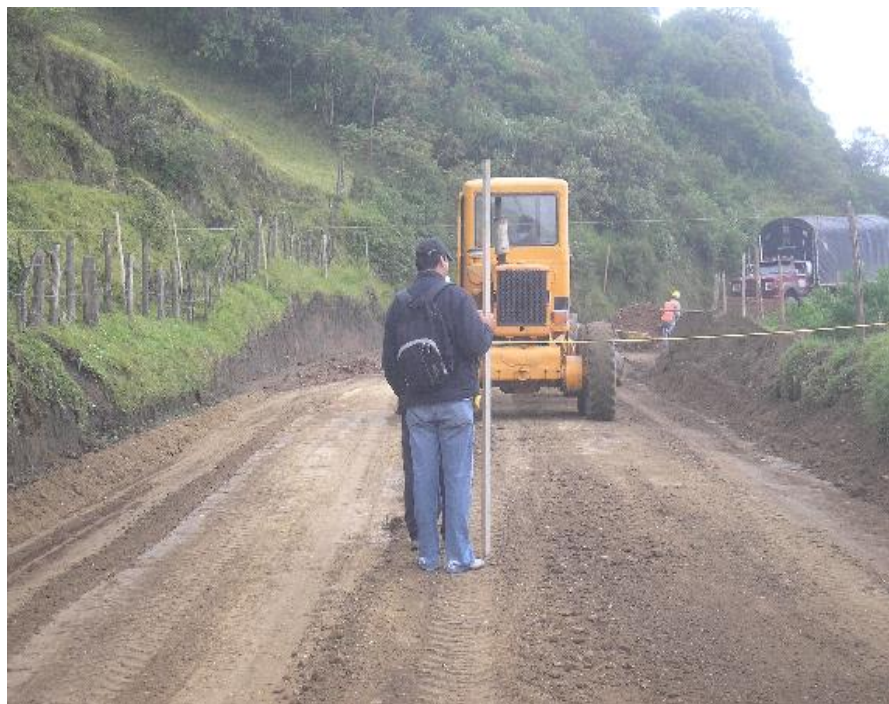
Figura 16. Nivelación de la subrasante, trazado de bombeo y peralte
