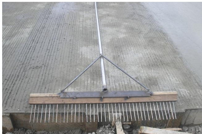
Figura 26. Cepillo para dar textura al pavimento
