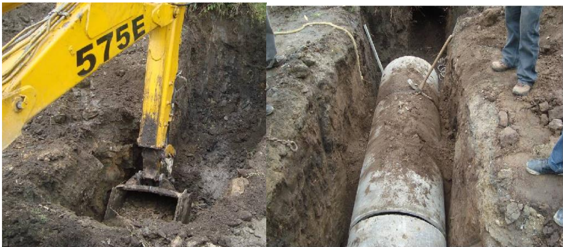
Figura 9. Excavación de zanja e instalación de Tubería
