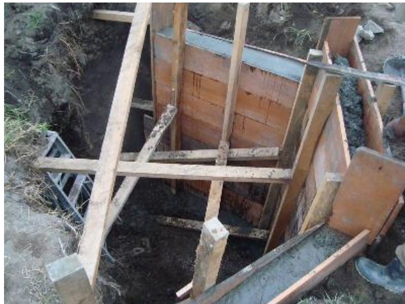
Figura 11. Formaleta y Vaciado del Concreto
