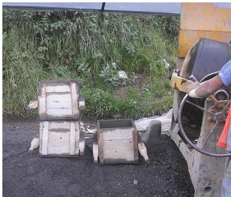
Figura 21. Dosificación de Materiales
