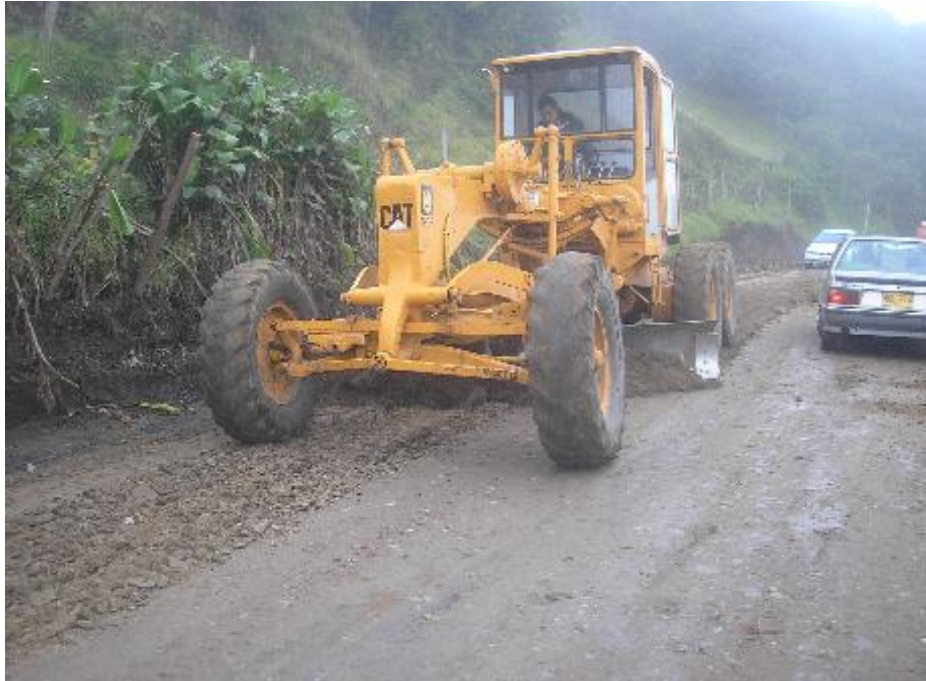
Figura 17. Acondicionamiento de la Subrasante
