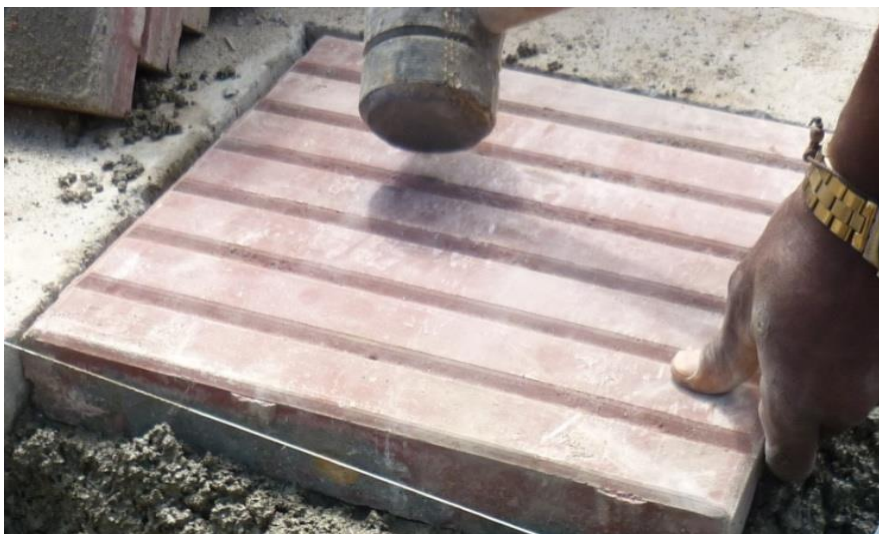
Fotografía 4: Aspecto de Loseta guiadora, Abastecida por METALTEC.
