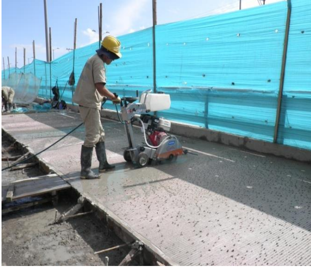
Fotografía 21: Elaboracion del corte de las juntas – Carrera 17 costado Suroccidental.
