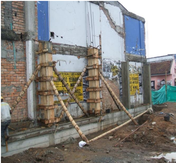
Fotografía 42: Fundición de columnas Carrera 17 entre calles 4 y 5.
