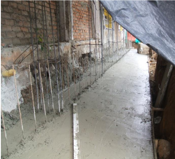
Fotografía 40: Terminado de la zapata Carrera 17 entre calles 4 y 5.
