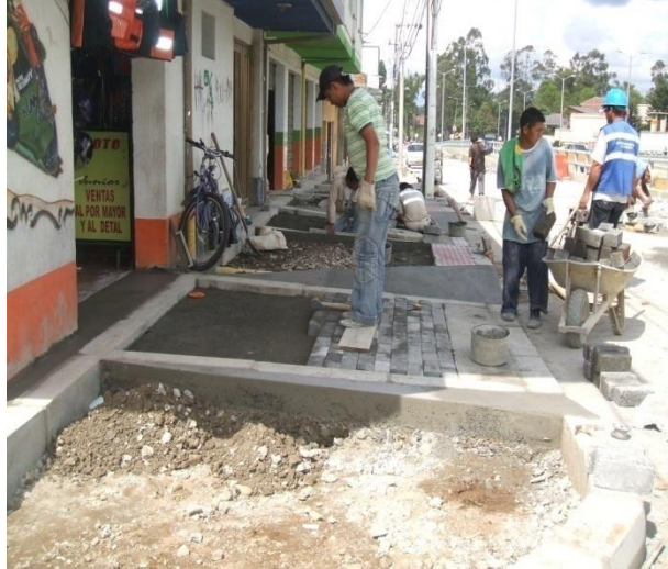
Fotografía 32: Colocación de los adoquines Carrera 17 con calle 3 esquina norte.
