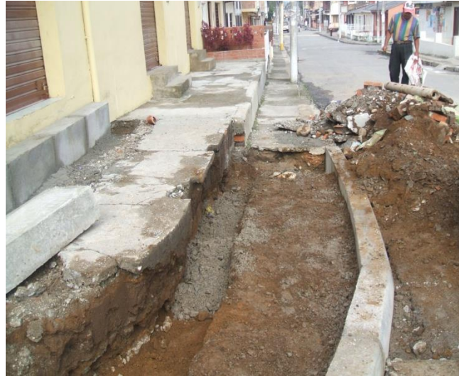
Fotografía 29: Instalación y nivelación de bordillos Carrera 17 con calle 3 esquina sur.
