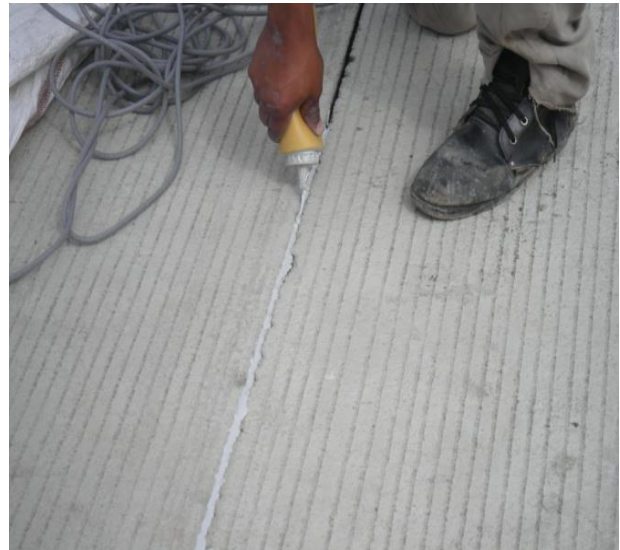
Fotografía 24: Aplicación del agente sellador de las juntas.
