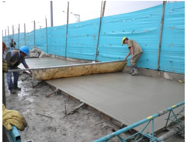
Fotografía 18: Micro-texturizado Carrera 17 con Calle 7 costado Suroccidental.
