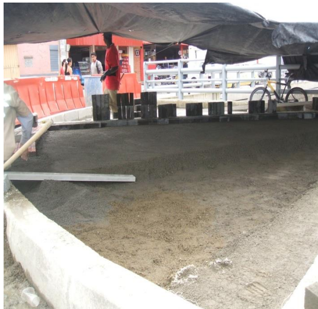
Fotografía 31: Extensión y nivelación de la capa de arena de asiento Carrera 17 con calle 5 isla costado sur.
