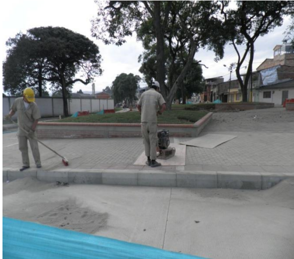
Fotografía 34: Compactación de adoquines Parque el Cadillal.
