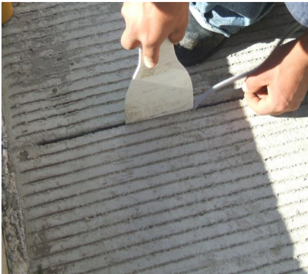
Fotografía 23: Posicionamiento del cordón en la junta.
