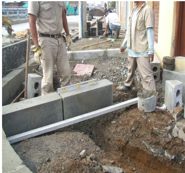
Fotografía 29: Instalación y nivelación de bordillos Carrera 17 con calle 3 esquina sur.
