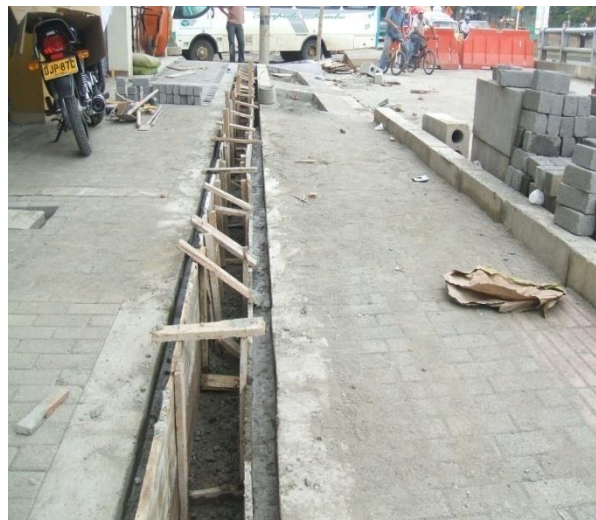
Fotografía 33: Extensión de la capa de arena de sello Carrera 17 entre calles 2 y 2A.
