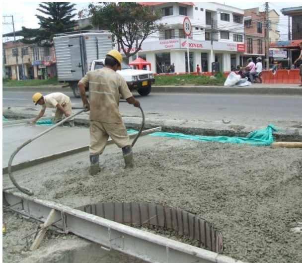
Fotografía 15: Vibrado interno del concreto - Carrera 17 entre Calles 8 – 8A costado Suroccidental.
