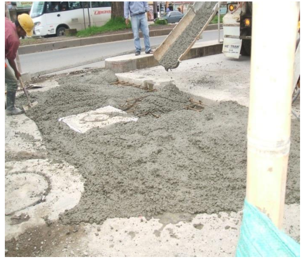
Fotografía 14: Riego y esparcimiento del concreto – Carrera 17 con Calle 8 esquina costado Suroriental.
