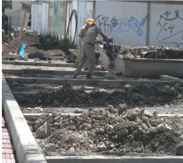
Fotografía 30: Riego, extensión, conformación y compactación de la capa de subbase Parque El Cadillal.
