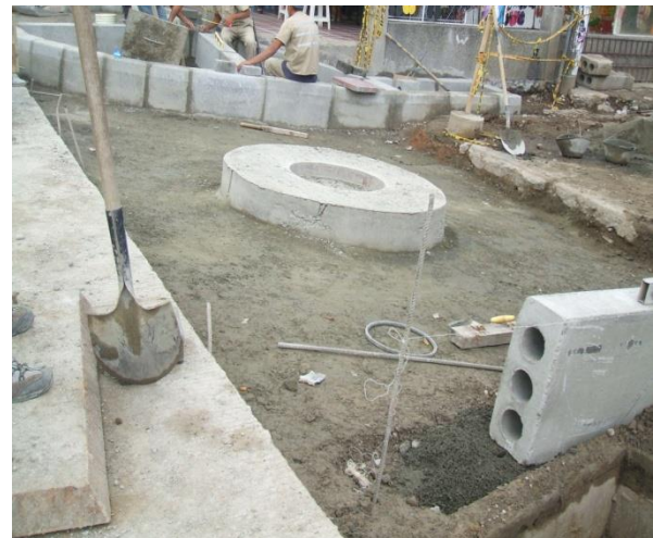
Fotografía 9: Terminado de la capa de subbase – Calle 6 esquina costado occidental.
