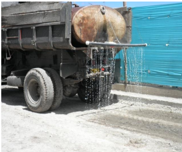
Fotografía 8: Humedecimiento de la capa de subbase granular– Carrera 17 costado Suroccidental.
