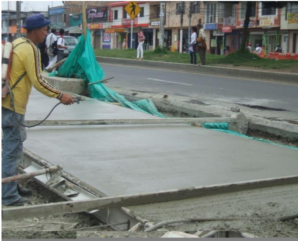
Fotografía 17: Aplicación del agente curado - Carrera 17 con Calle 7 costado Suroccidental.
