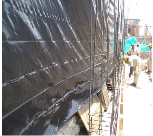
Fotografía 41: Formaleta Carrera 17 entre calles 4 y 5.
