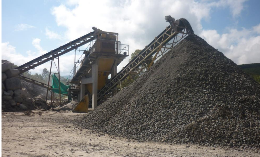
Fotografía 3: Subbase suministrada por CONEXPE.
