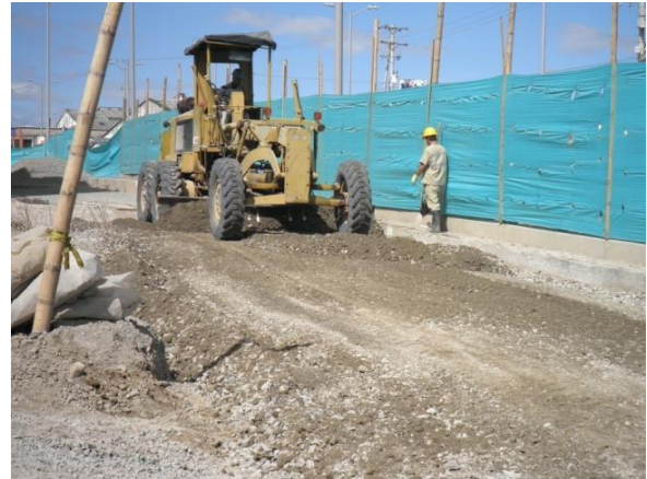
Fotografía 9: Terminado de la capa de subbase – Calle 6 esquina costado occidental.
