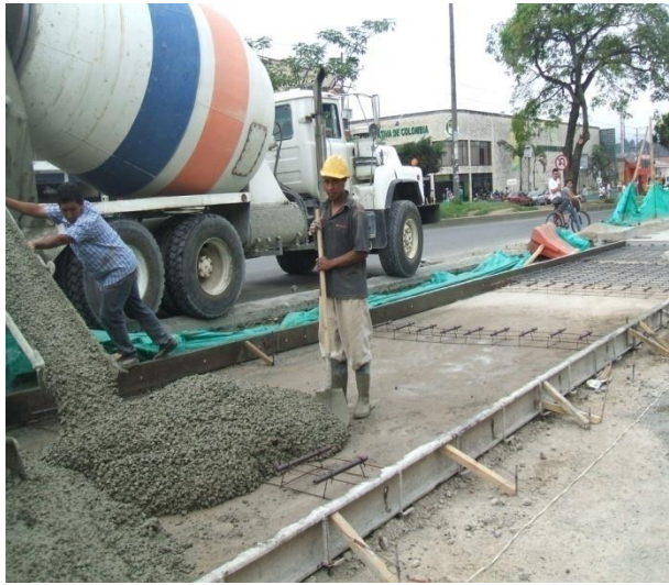
Fotografía 13: Vaciado del concreto – Carrera 17 entre Calles 7 – 8 costado Suroccidental.
