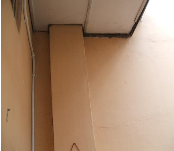
Fotografía 36: Control de vecindad Carrera 17 con calle 5 esquina.
