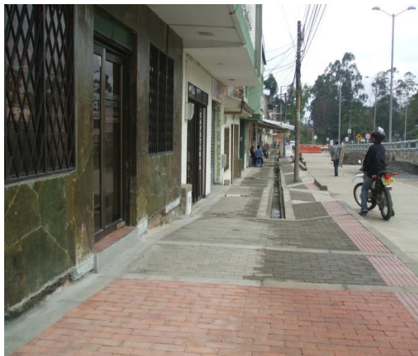
Fotografía 35: Terminado Carrera 17 con calle 2 esquina norte.
