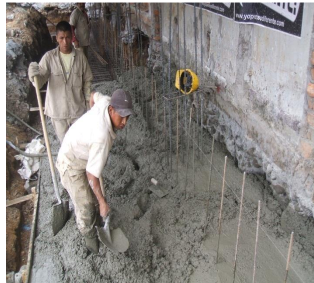
Fotografía 39: Fundición de la cimentación Carrera 17 entre calles 4 y 5.
