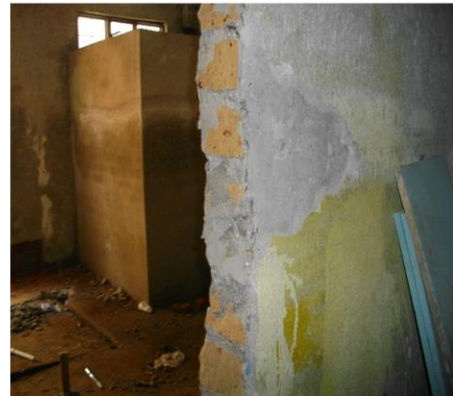
FOTO 24. DEMOLICION DE MUROS BATERIA SANITARIA
