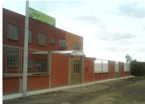
FOTO 44. VISTA DEL MURO FACHADA PRINCIPAL FINALIZADO
