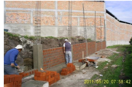
FOTO 27. TRABAJOS DE MAMPOSTERIA EN LADRILLO BLOQUE EN TIZON
