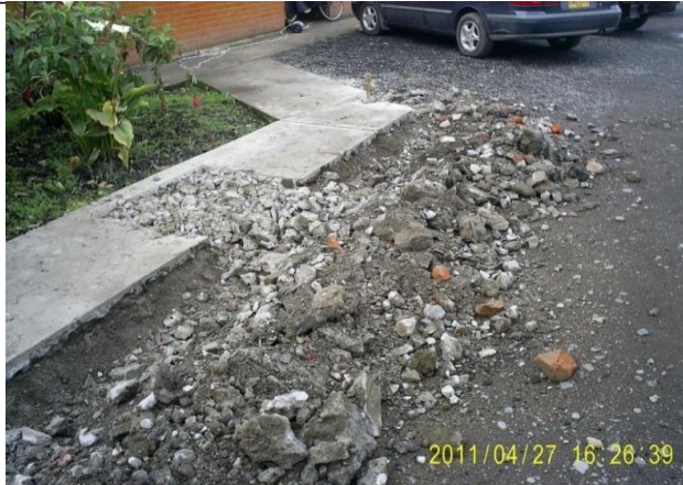
FOTO 11. DEMOLICION DE ANDEN EXISTENTE PARA IMPLANTACION DE ZAPATAS EN LA PARTE FRONTAL DE LA IPS
