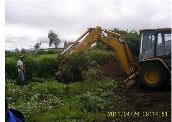
FOTO 7. CORTE PARA AMPLIACION DE LA VIA EXISTENTE
