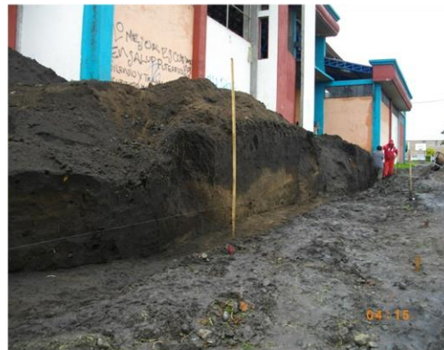
FOTO 12. PERFILADO DE MURO DE CONTENCIÓN
