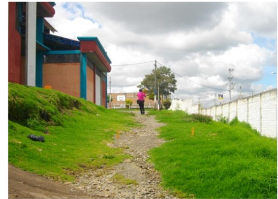
FOTO 10. LOCALIZACION Y REPLANTEO, ESTACAS Y NIVELES
