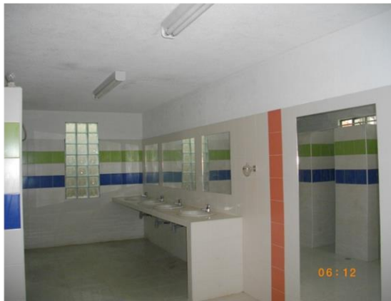
FOTO 34, 35 Y 36. INSTALACION VIDRIO BLOCK, ESPEJOS, LAVAMANOS Y SANITARIO
