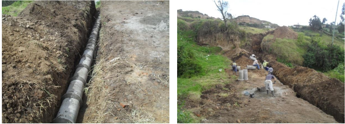
Fotos 3 y 4. Instalación de tubería de mortero de 10 pulgadas
