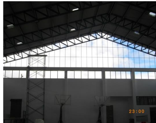
FOTO 40. VISTA CULATA PARA INSTALACION DE POLICARBONATO
