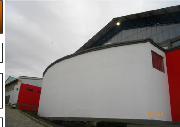
FOTO 87. PINTURA EXTERIORES COLISEO
