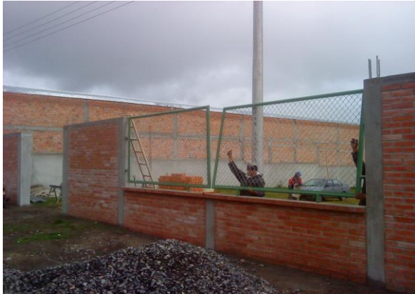
FOTO 41. SUMINISTRO E INSTALACION DE LAS MALLAS SOBRE FACHADA PRINCIPAL
