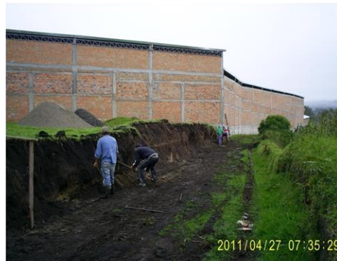
FOTO 9 Y 10. PERFILAMIENTO DE LA VIA AMPLIADA Y EXCAVACION PARA IMPLANTACION DE ZAPATAS
