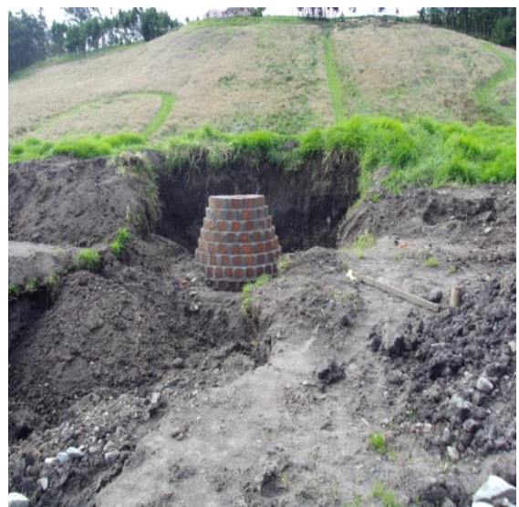
Fotos 1 y 2. Excavación a máquina y construcción cámara de inspección
