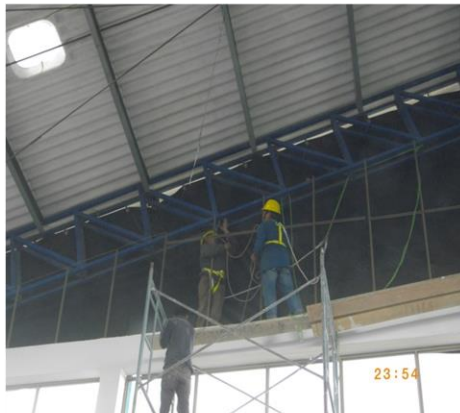
FOTO 39. INSTALACION ESTRUCTURA CULATA PARA SOPORTAR POLICARBONATO
