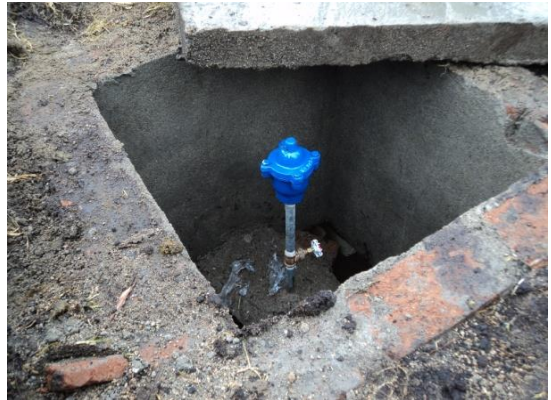
Fotos 3 y 4. Instalación de tubería PVC 2" y ventosa
