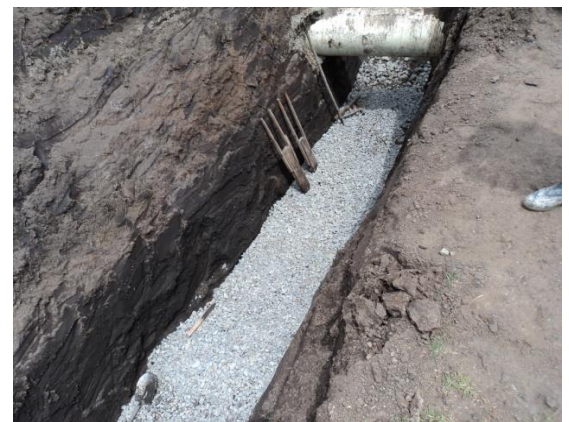
Fotos 3 y 4. Sellamiento tubería de mortero de 24" y relleno con material triturado
