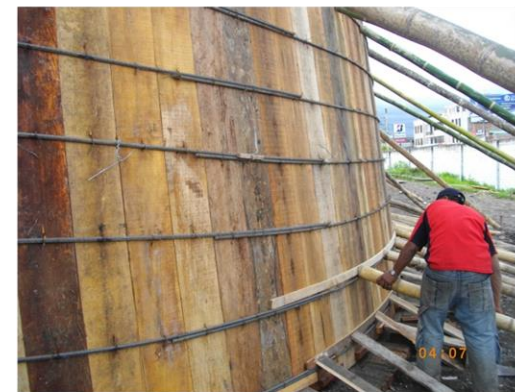
FOTO 13. FORMLETA DEL MURO DE CONTENCIÓN
