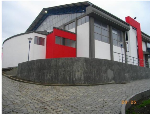
FOTO 86. VISTA DE MURO DE CONTENCION, PLAZOLETA, PINTURA, FAROLES, ADOQUIN
