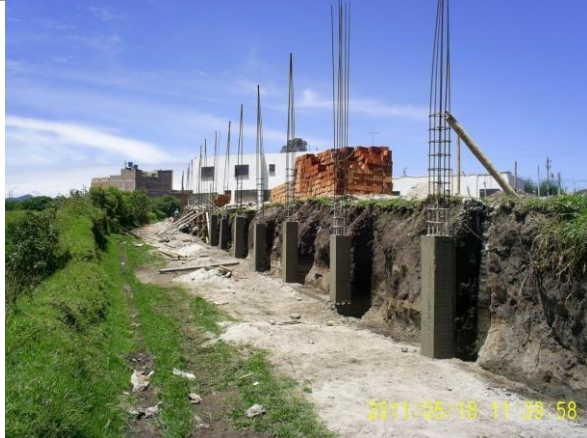
FOTO 26. VISTA DE LOS TRABAJOS FINALES DE FUNDICION DE PEDESTALES EN LA SECCION VIA
