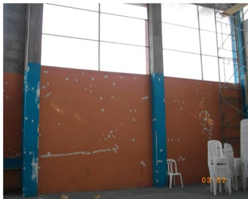
FOTO 44. RESANE Y PREPARACION SUPERFICIE INTERIOR COLISEO
