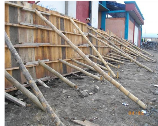
FOTO 15. APUNTALADO MURO DE CONTENCIÓN
