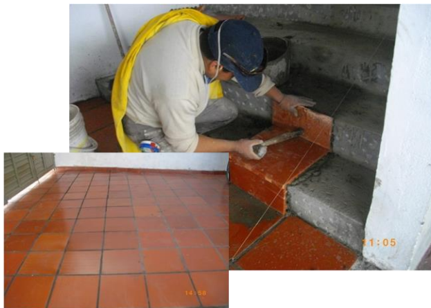
FOTO 91. INSTALACION PISOTABLETA DE GRESS
