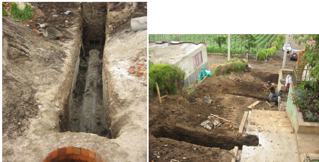
Fotos 3 y 4. Instalación tubería y acometidas domiciliarias
