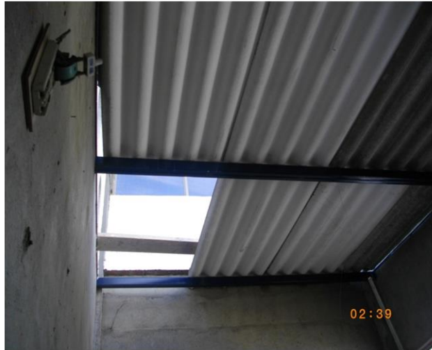
FOTO 58. REPOSICION CUBIERTA SECTOR TARIMA
