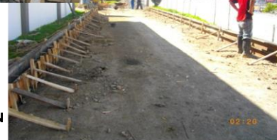
FOTO 68. CONSTRUCCION BORDILLOS
