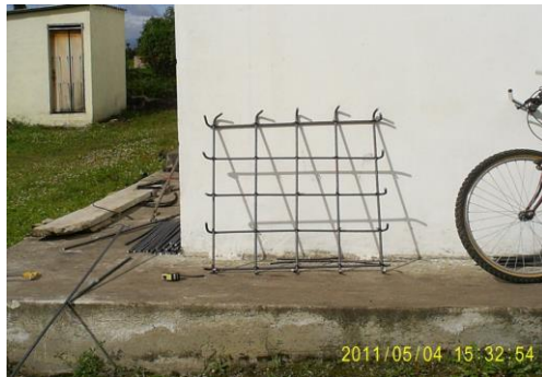
FOTO 18. ELABORACION DE CANASTILLA O PARRILLA PARA ZAPATAS CON VARILLA DE 1/2"
