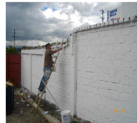
FOTO 96. PINTURA MURO EXISTENTE
