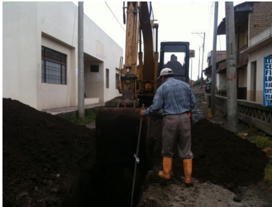
Fotos 1 y 2. Excavaciones a máquina y tubería de 8 pulgadas
