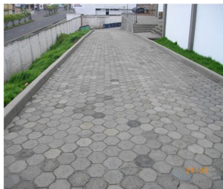
FOTO 89. VIA INTERNA ADOQUINADA
