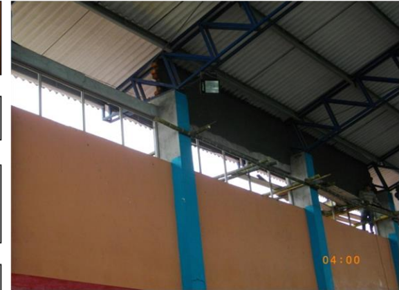
FOTO 21. MUROS MAMPOSTERIA Y REPellos
