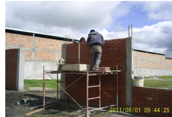
FOTO 32. PEGA DE LADRILLO VISTO SEGÚN PLANOS ARQUITECTONICOS
