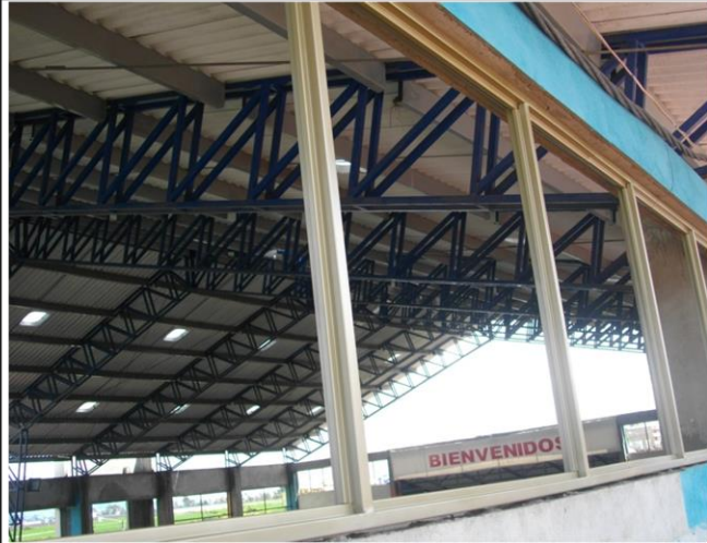
FOTO 20. LIMPIEZA DE ESTRUCTURA Y LIMPIEZA
