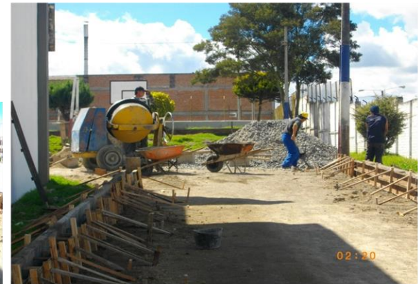
FOTO 69. VISTA TRABAJOS Y EQUIPOS
