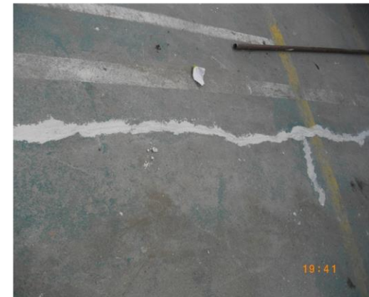
FOTO 79. ARREGLO Y PREPARACION DE SUPERFICIE PISO COLISEO
