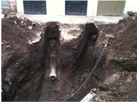
Fotos 1 y 2. Construcción de acometidas domiciliarias y sumideros
