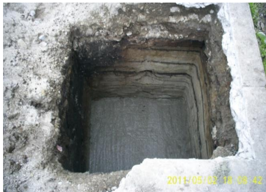
FOTO 13. VISTA DE LA FUNDICION DEL SOLADO EN CONCRETO E=10cm
