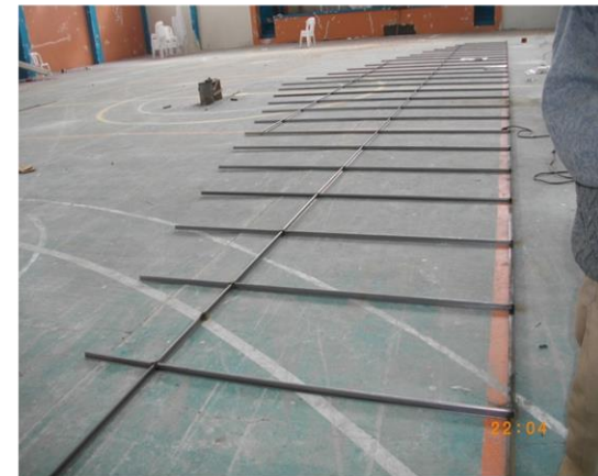
FOTO 38. ELABORACION ESTRUCTURA PARA VENTANERIA
