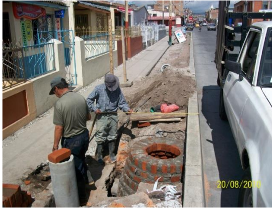
Fotos 1 y 2. Construcción de cámaras de inspección y adecuación acometidas domiciliarias
