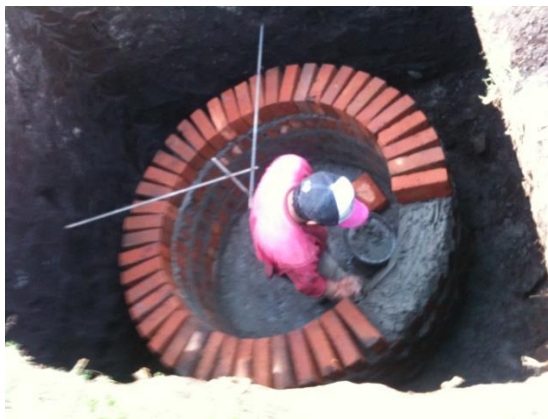
Fotos 3 y 4. Construcción de cámara de inspección y relleno y compactación final
