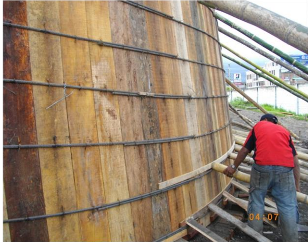
FOTO 14. CONSTRUCCION FORMAleta MURO DE CONTENCIÓN
