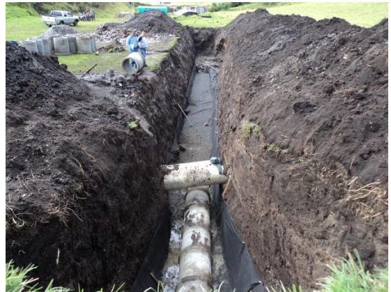
Fotos 7 y 8. Geotextil y tubería instalada correctamente
