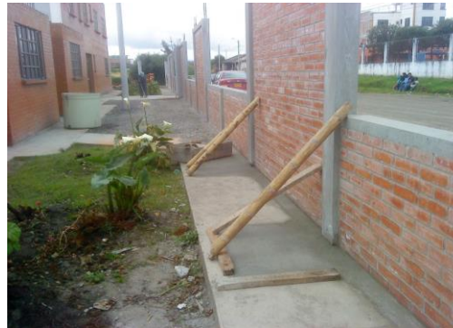
FOTO 34.. FUNDICION Y REPELLO DE ANDEN EN CONCRETO ENTRADA PRINCIPAL
