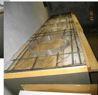
FOTO 29 Y 30. CONSTRUCCION MESONES BATERIA SANITARIA
