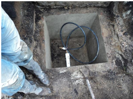
Fotos 5 y 6. Instalación de purga y tapa
