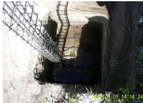
FOTO 19 Y 20. IMPLANTACION DE COLUMNAS Y PUESTA DE PARRILLA PARA ZAPATAS Y SU RESPECTIVA FUNDICION
