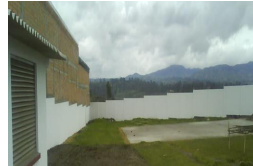
FOTO 45. TRABAJOS TERMINADOS DEL MURO POSTERIOR VISTO INTERNAMENTE
