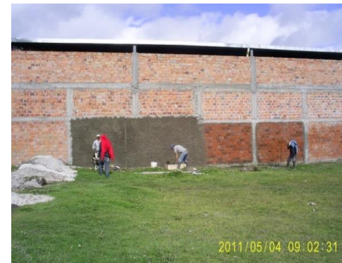
FOTO 14 Y 15. ALISTAMIENTO Y REPELLO DE MUROS COLINDANTES EXISTENTES
