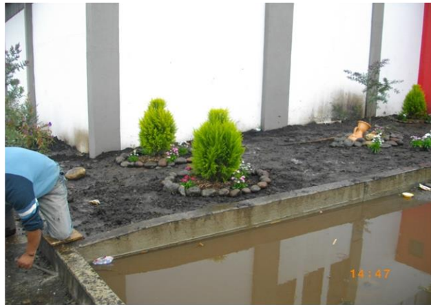
FOTO 97. ADECUACIONES GENERALES EXTERIORES
