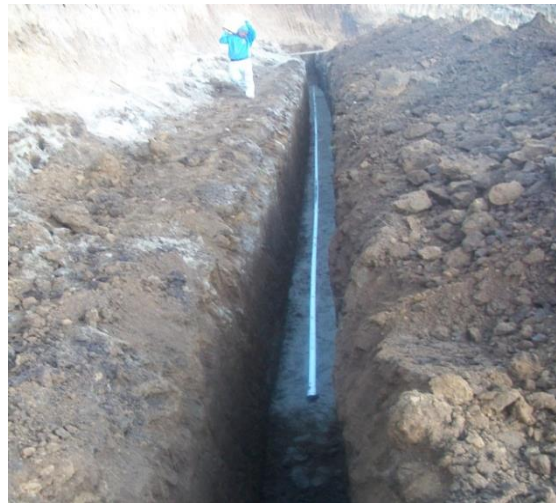
Fotos 6 y 7. Instalación de 403 m de tubería de 2" de PVC y de 48 m de 3" de PVC
