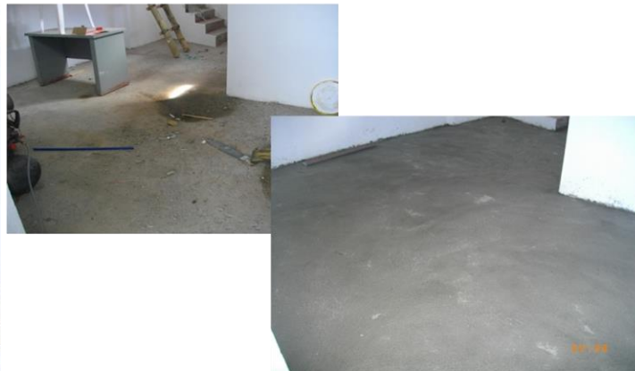
FOTO 55 Y 56. REPELOS DE PISOS INTERNOS
