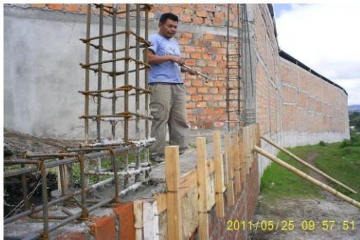
FOTO 28. FUNDICION DE VIGA DE ENTREPISO DE ACUERDO PLANOS ESTRUCTURALES
