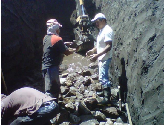
Fotos 5 y 6. Relleno con material rajón e inconvenientes con nivel freático
