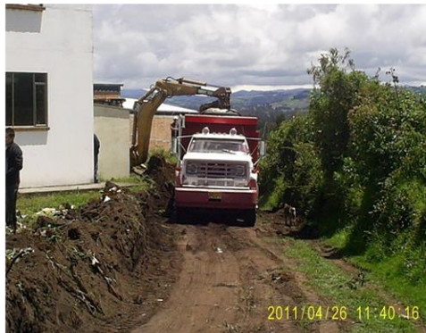
FOTO 8. CARGUE DEL MATERIAL DE EXCAVACION A LA VOLQUETA
