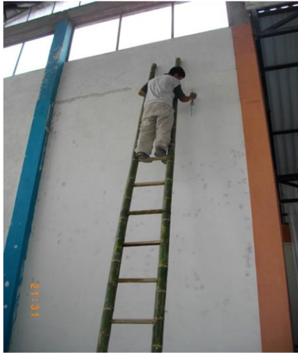
FOTO 47. REPARACION DE SUPERFICIE
