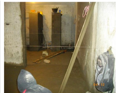
FOTO 25. MAMPOSTERIA NUEVA, REPellos PARED Y PISOS
