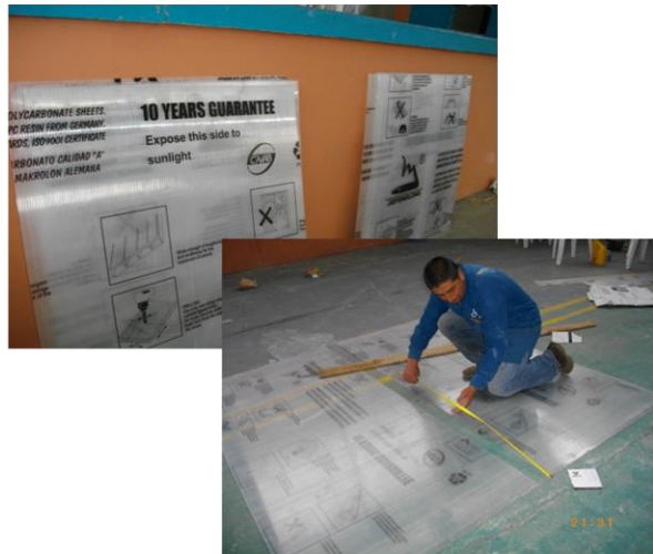
FOTO 37. MANIPULACION DEL POLICARBONATO
