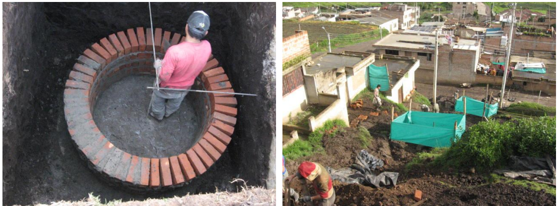
Fotos 1 y 2. Construcción y localización de cámaras de inspección
