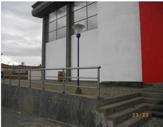
FOTO 88. VISTA DE BARANDA, FAROLES, GRADAS, PINTURA
