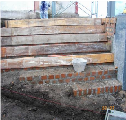
FOTO 54. CONSTRUCCION GRADAS EXTERNAS
