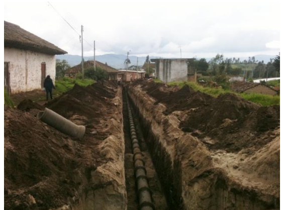
Fotos 1 y 2. Excavaciones a máquina y tubería de 8 pulgadas
