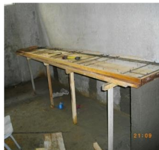
FOTO 29 Y 30. CONSTRUCCION MESONES BATERIA SANITARIA
