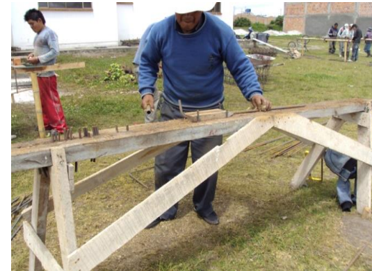
FOTO 17. ELABORACION DE FLEJES PARA COLUMNAS Y VIGAS DE CIMENTACION
