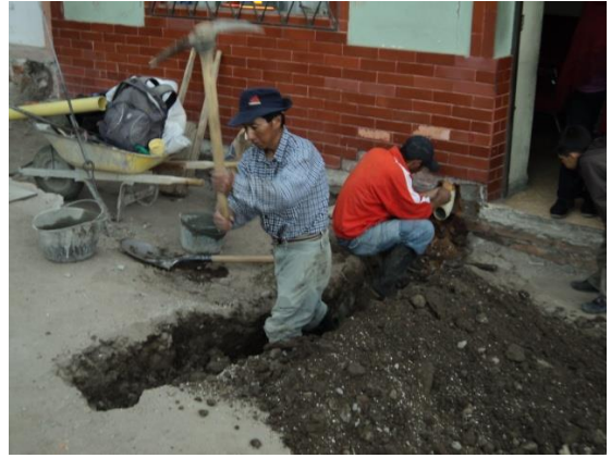
Fotos 1 y 2. Construcción de cámaras de inspección y adecuación acometidas domiciliarias
