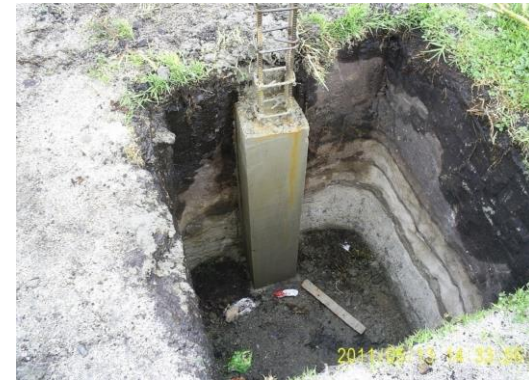
FOTO 22. VISTA FINAL DE LOS PEDESTALES EN CONCRETO
