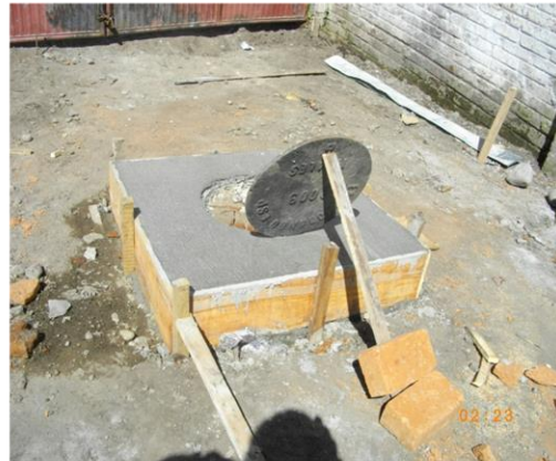
FOTO 77 Y 78. CONSTRUCCION DE SUMIDEROS Y CAJAS DE DESAGUES EXTERIORES
