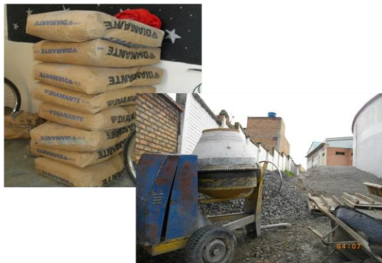
FOTO 16 Y 17. MATERIAL Y EQUIPO FUNDICION MURO DE CONTENCIÓN
