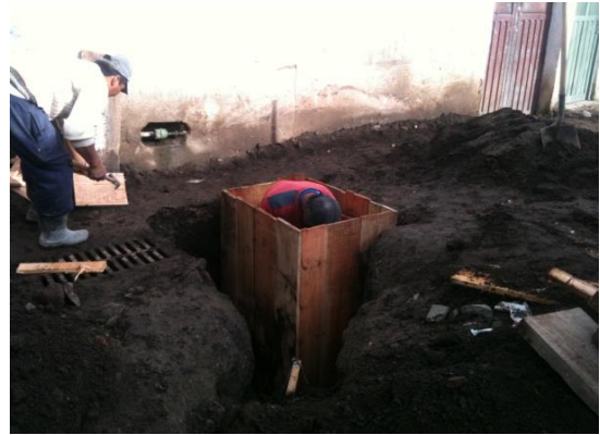
Fotos 1 y 2. Construcción de acometidas domiciliarias y sumideros
