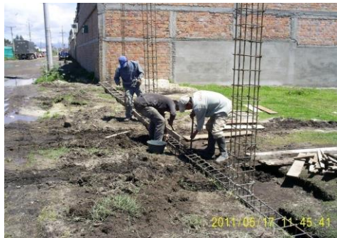
FOTO 23. ARMADO DE LA VIGA DE CIMENTACION SEGÚN PLANOS ESTRUCTURALES
