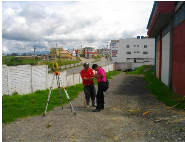
FOTO 9. EJECUCION DE OBRAS-EQUIPO TOPOGRAFICO
