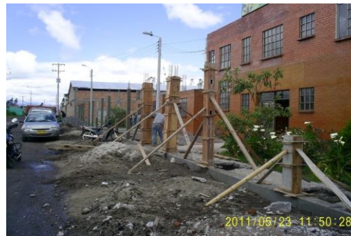
FOTO 29. ARMADO Y FUNDICION DE COLUMNAS PARTE FRONTAL DE LA IPS
