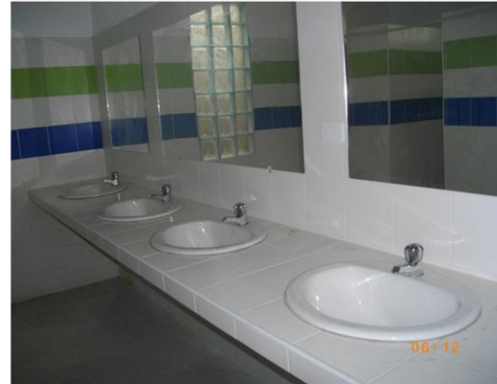
FOTO 34, 35 Y 36. INSTALACION VIDRIO BLOCK, ESPEJOS, LAVAMANOS Y SANITARIO
