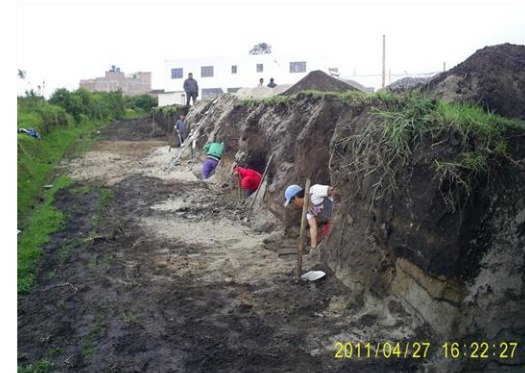
FOTO 9 Y 10. PERFILAMIENTO DE LA VIA AMPLIADA Y EXCAVACION PARA IMPLANTACION DE ZAPATAS
