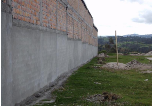
FOTO 16. VISTA DE LOS TRABAJOS FINALES DEL REPELLO DEL MURO
