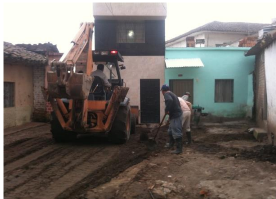
Fotos 3 Y 4. Relleno y compactación con material de préstamo
