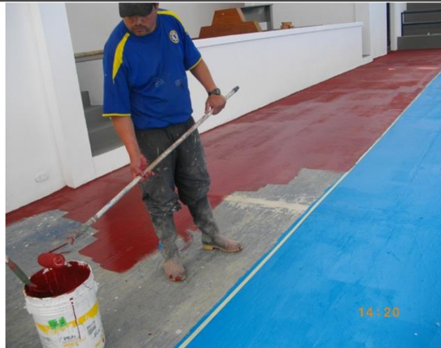
FOTO 80. PINTURA TIPO TRAFICO PISO INTERNO COLISEO INEDCI
