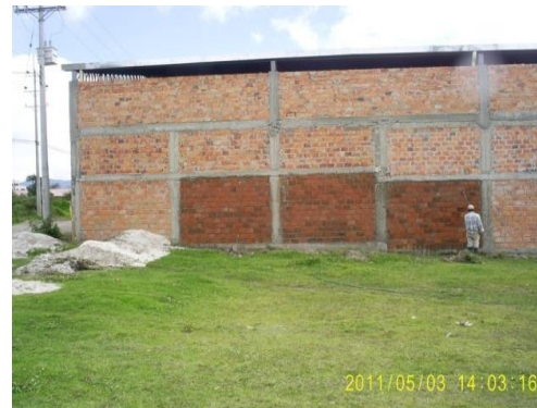
FOTO 14 Y 15. ALISTAMIENTO Y REPELLO DE MUROS COLINDANTES EXISTENTES
