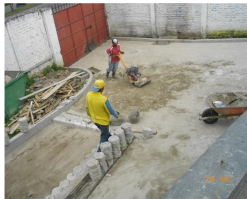
FOTO 73. COMPACTACION MECANICA CON RANA
