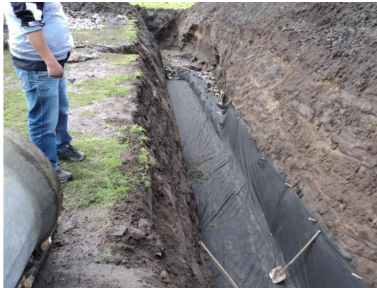
Fotos 7 y 8. Geotextil y tubería instalada correctamente
