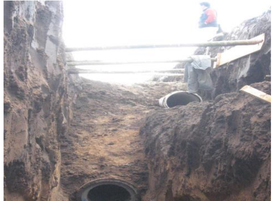
Foto 8. Movimiento líneas de aducción
