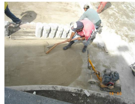
FOTO 74. EXTENDIDO CAPA DE ARENA
