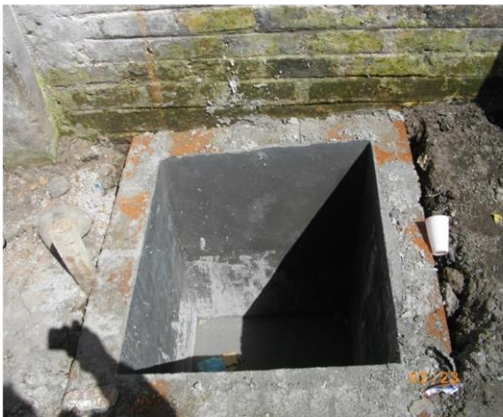
FOTO 77 Y 78. CONSTRUCCION DE SUMIDEROS Y CAJAS DE DESAGUES EXTERIORES
