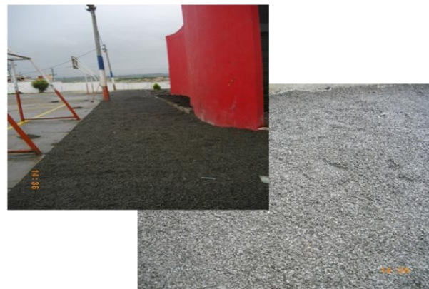
FOTO 94 Y 95. ADECUACION ACCESO COLISEO- NIVELACION Y COLOCACION DE GRAVILLA FINA
