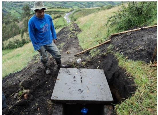
Fotos 5 y 6. Instalación de purga y tapa
