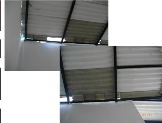
FOTO 59 Y60. REPOSICION CUBIERTA
