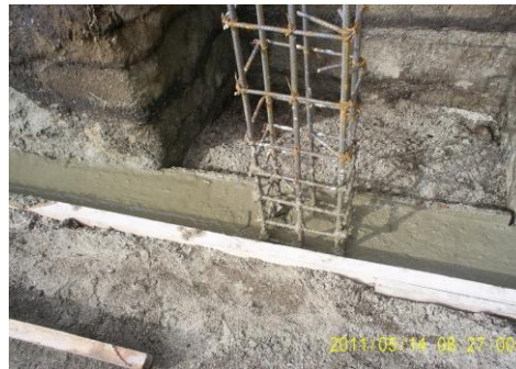
FOTO 24 Y 25. VISTA DE LA FUNDICION DE LA VIGA DE CIMENTACION PARTE FRONTAL Y POSTERIOR DE LA IPS
