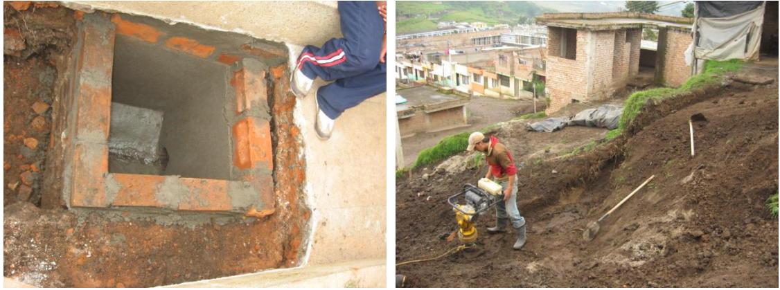
Fotos 5 y 6. Construcción de cajas y compactado
