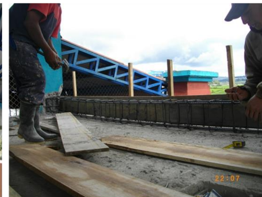
FOTO 46. ARMADO VIGA DE AMARRE 0.30x0.30 CONCRETO
