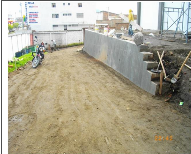
FOTO 64. REPARACION BASE PAVIMENTO EN ADOQUIN
