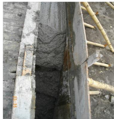
FOTO 18. FUNDICION MURO
