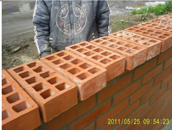
FOTO 31. VISTA DE LA ELABORACION DE LA ALFAJIA EN LADRILLO VISTO
