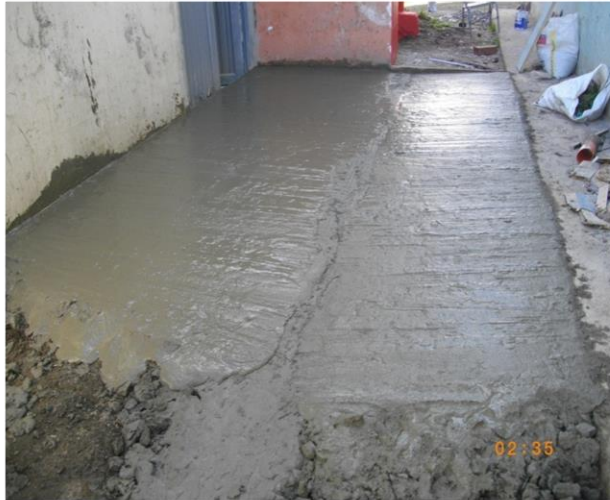
FOTO 75. PLACA DE CONCRETO ENTRADA BATERIA SANITARIA
