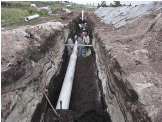
Foto 7. Tubería de PVC de 16"
