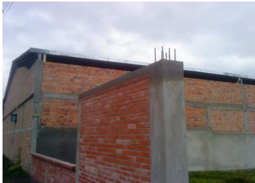
FOTO 33. VISTA DE LA VIGADE CORONACION SOBRE MURO LADRILLO VISTO
