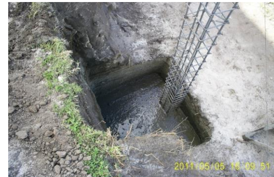
FOTO 19 Y 20. IMPLANTACION DE COLUMNAS Y PUESTA DE PARRILLA PARA ZAPATAS Y SU RESPECTIVA FUNDICION
