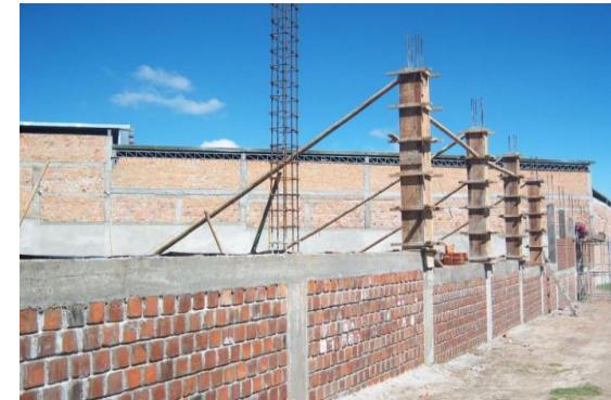
FOTO 37. VISTA DE FUNDICION DE VIGA DE ENTREPISO Y COLUMNAS
