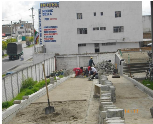
FOTO 70. ADOQUINADO DE VIA DE ACCESO
