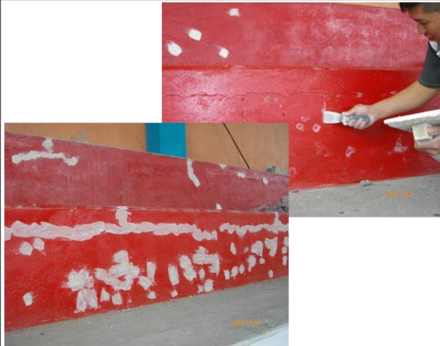
FOTO 42. RESANE GENERAL GRADERIAS
