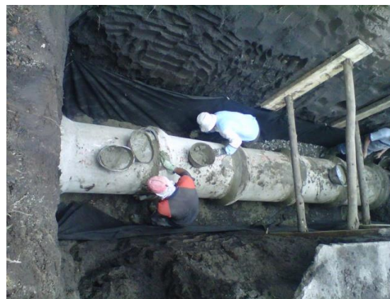
Fotos 3 y 4. Sellamiento tubería de mortero de 24" y relleno con material triturado
