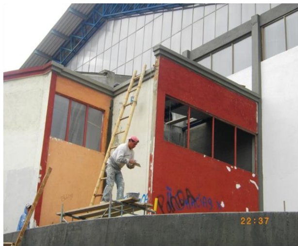
FOTO 52. REPARACION DE SUPERFICIES PAREDES EXTERIORES
