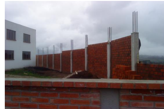
FOTO 40. VISTA DE LA TERMINACION DE LA PEGA DEL LADRILLO BLOQUE Y TERMINADO DE ALFAJIA CON SU REPELLO
