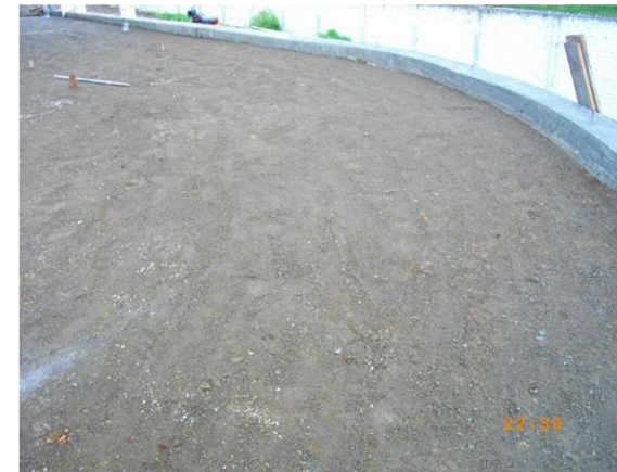
FOTO 65. BASE RECEBO COMPACTADO-PLAZOLETA
