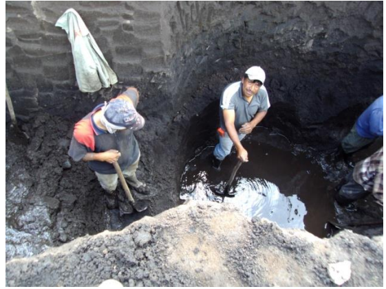
Fotos 5 y 6. Relleno con material rajón e inconvenientes con nivel freático
