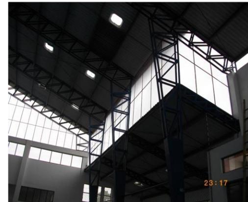
FOTO 41. ESTRUCTURA METALICA LATERAL Y POLICARBONATO INSTALADO
