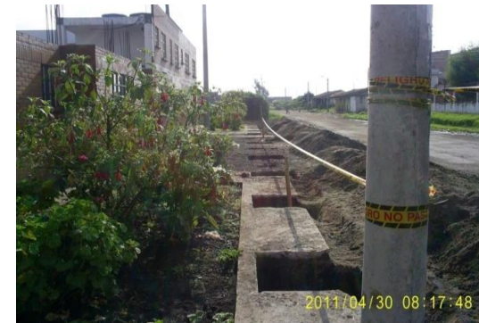
FOTO 12. VISTA DE LOS TRABAJOS FINALES DE EXCAVACIONES A MANO PARA FUNDICION DE SOLADO Y ZAPATAS
