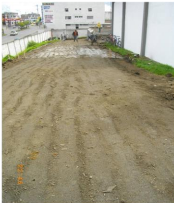
FOTO 66. VIA RECEBO COMPACTADO
