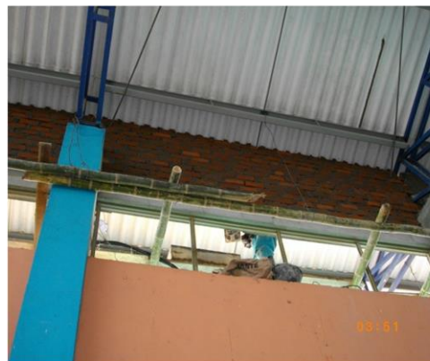
FOTO 45. MUROS MAMPOSTERIA Y REPELLOS
