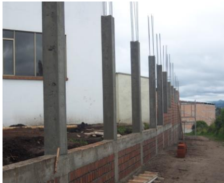
FOTO 38. VISTA DE COLUMNAS Y VIGA DE ENTREPISO
