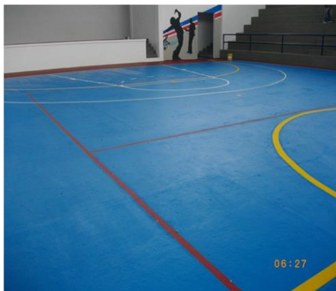
FOTO 82. PINTURA TRAFICO Y DEMARCACION
