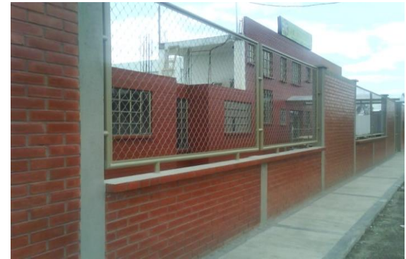
FOTO 42. VISTA DE LA MALLA INSTALADA Y MURO FINALIZADO CON SU REPECTIVO ANDEN
