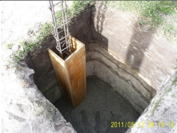
FOTO 21. FORMATEO PARA FUNDICION DE PEDESTALES EN CONCRETO
