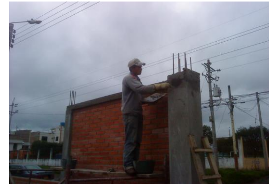
FOTO 35. REPELLO DE COLUMNAS Y VIGADE CORONACION MURO FACHADA PRINCIPAL
