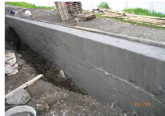
FOTO 19. MURO DE CONTENCIÓN FUNDIDO
