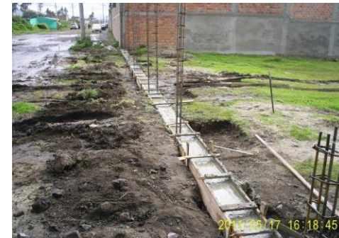
FOTO 24 Y 25. VISTA DE LA FUNDICION DE LA VIGA DE CIMENTACION PARTE FRONTAL Y POSTERIOR DE LA IPS
