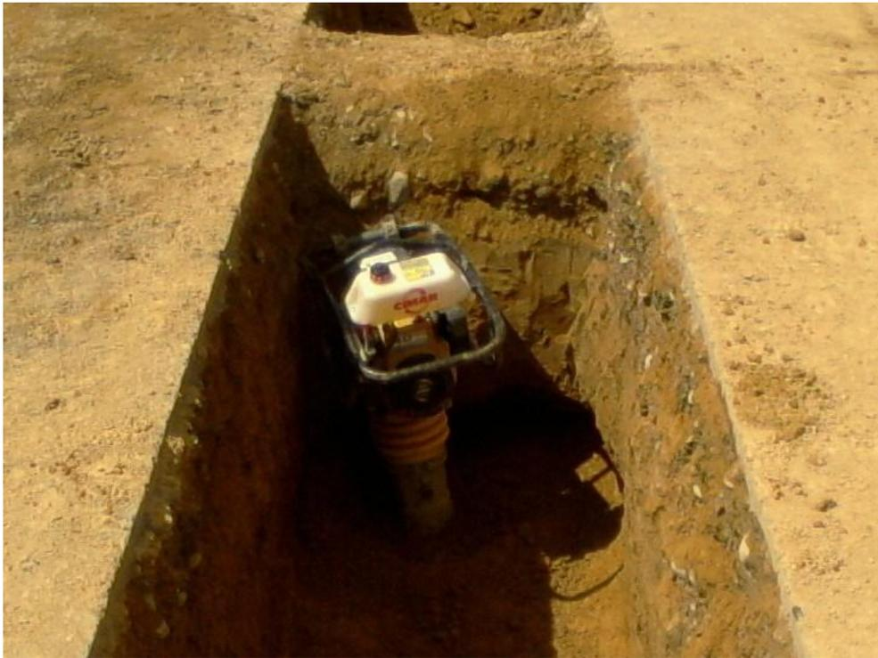
Compactación mecánica con material limo arcilloso tipo II
