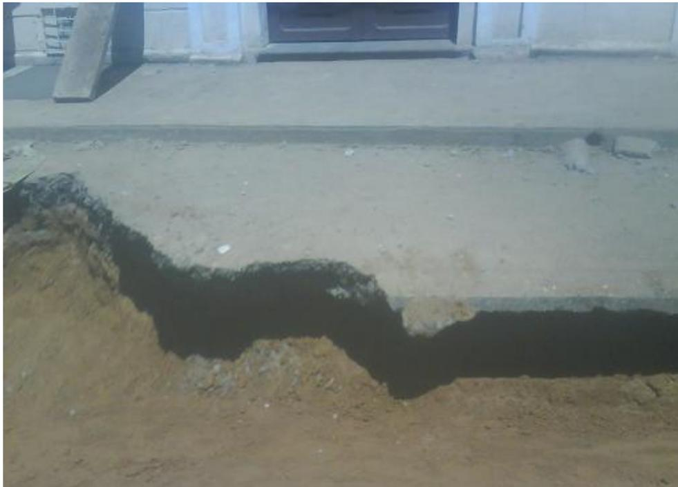
Desprendimiento de carpeta asfáltica por falta de apoyo
