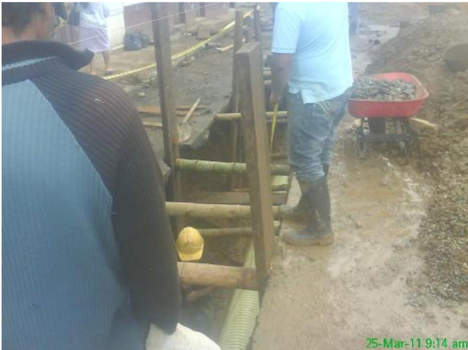
Instalación de tubería de 18" PVC, verificación de pendiente
