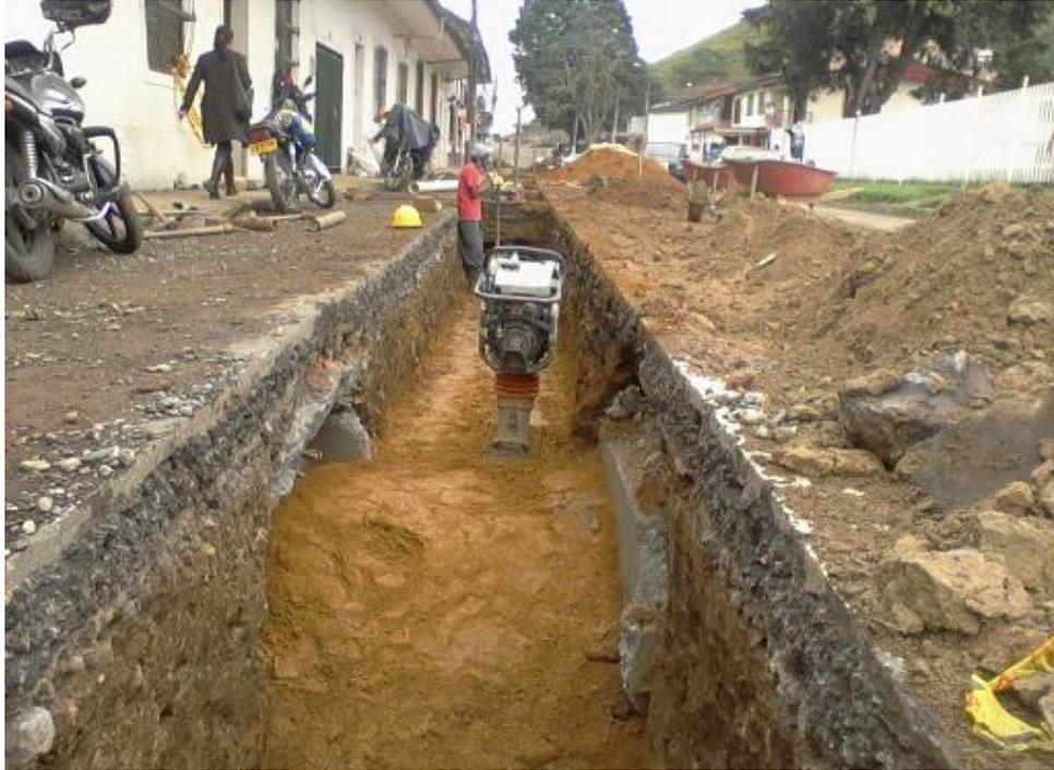
Compactación mecánica con material de relleno tipo II
