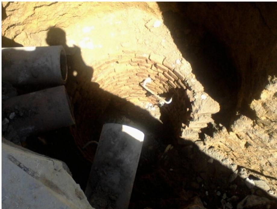
Demolición cámara de inspección en ladrillo
