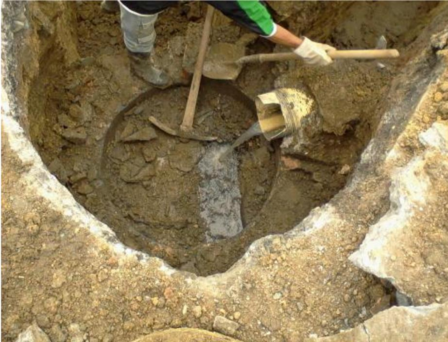
Demolición de cámara de inspección en ladrillo
