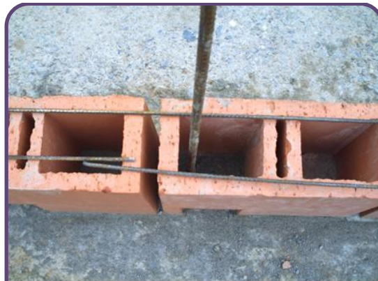
figura 35. UBICACION: Zona de Aulas PROCESO: Ubicación de los Grafiles o Refuerzo Horizontal en los Bloques de Mampostería.
