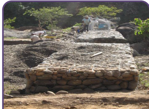
figura 77. UBICACION: Tanue Séptico y Filtro PROCESO: Construcción del Muro de Gaviones.
