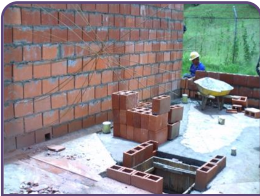
figura 33. UBICACION: Zona de Aulas PROCESO: Contrucción de las cajas de inspección dentro de las baterías sanitarias.
