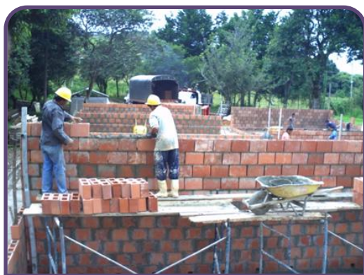
figura 34. UBICACION: Zona de Aulas PROCESO: Fundicion de las dovelas con mortero de relleno tipo grueso
