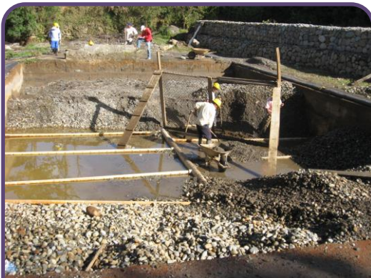
figura 74. UBICACION: Tanque Séptico y Filtro. PROCESO: Limpieza del Filtro Percolador de Flujo ascendente.
