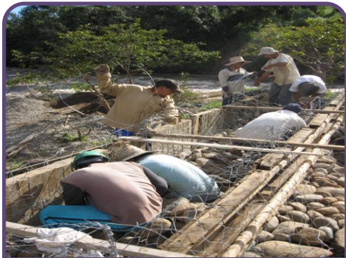
figura 76. UBICACION: Tanque Séptico y Filtro PROCESO: Construcción del Muro de Gaviones.
