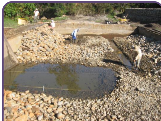
figura 75. UBICACION: tanque Séptico y Filtro PROCESO: Selección de la Grava para el Filtro.
