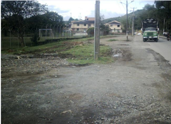
Figura 2. Inexistencia de Andenes.
