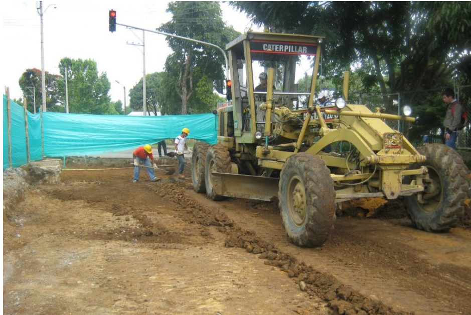
Figura 30. Nivelación de la Subrasante.
