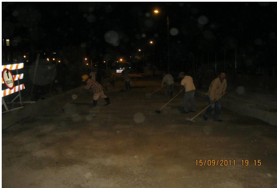
Figura 56. Preparación de la superficie, mediante barrido manual.
