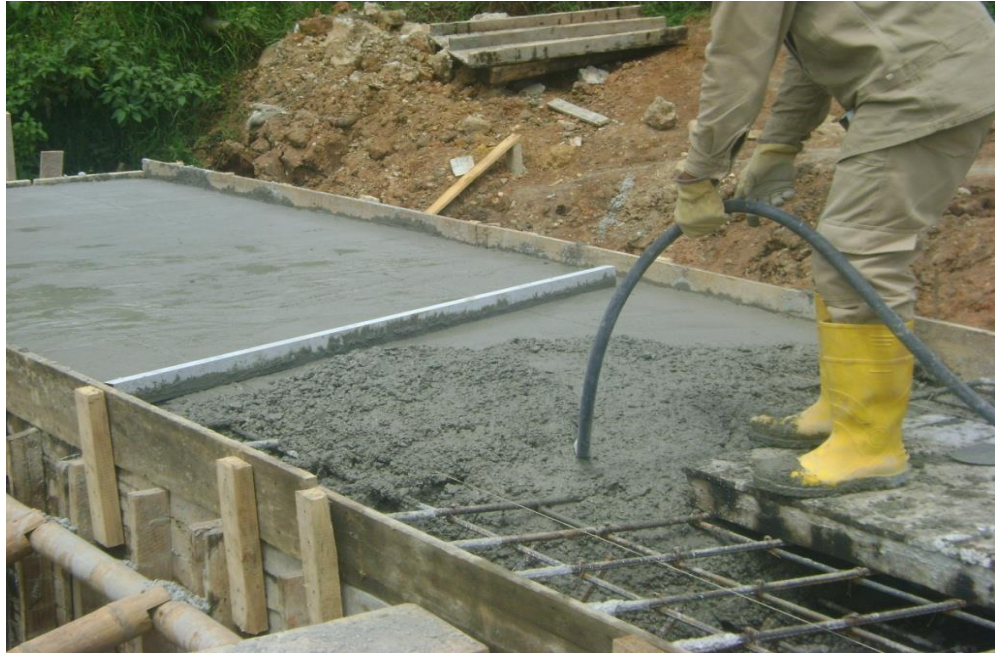
Figura 19. Vibrado interno del concreto mediante vibrador de aguja.
