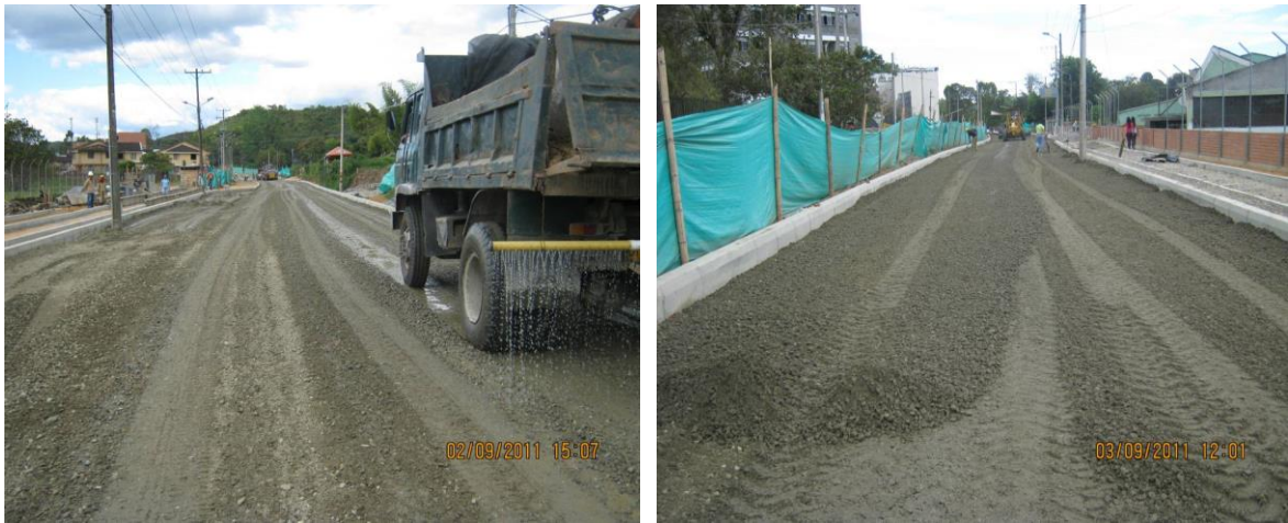
Figura 54. Humedecimiento de la base antes de compactar.
