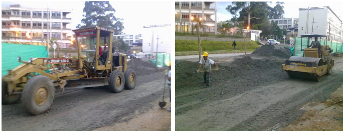
Figura 36. Perfilado y compactación de material de Sub-base sobre Fallo.
