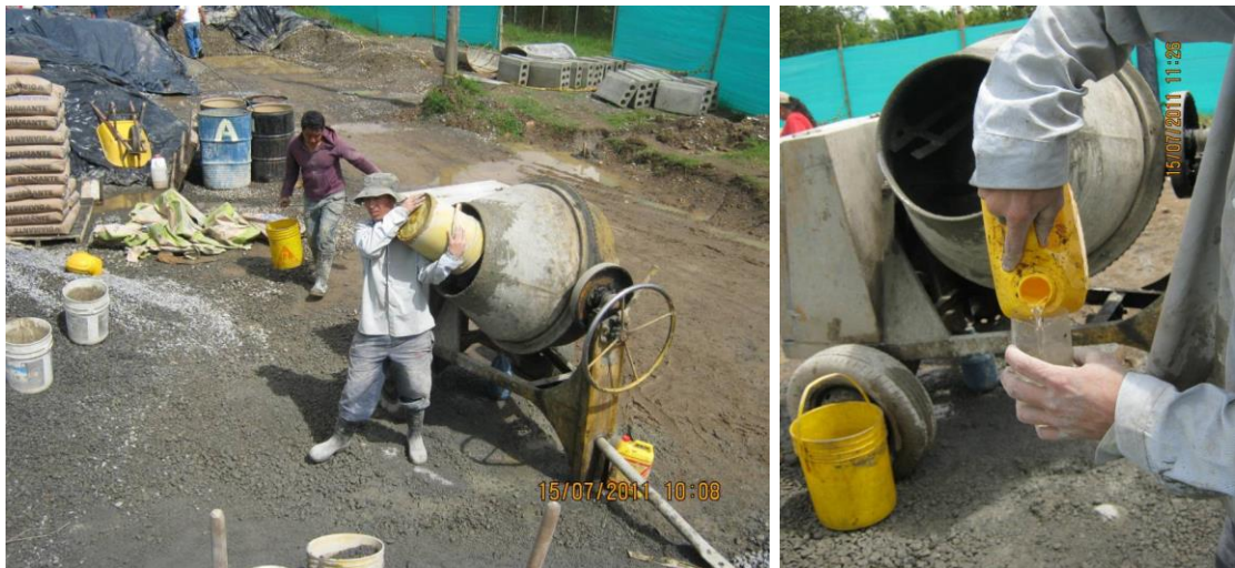
Figura 17. Dosificación y mezcla del concreto en Obra.
