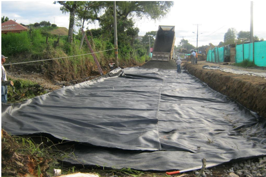
Figura 39. Instalación Geotextil Tejido a lo ancho de la calzada.
