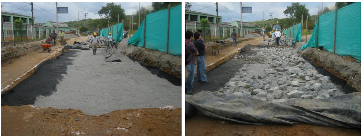
Figura 34. Instalación de cama de arena y piedra, sobre geotextil.
