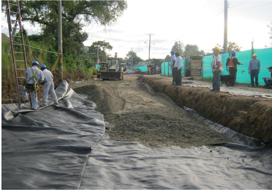
Figura 40. Extensión de material de Sub-base con retroexcavadora.
