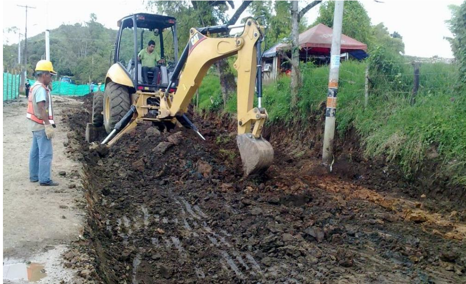
Figura 28. Trabajos de Excavación en Abs k0+250.
