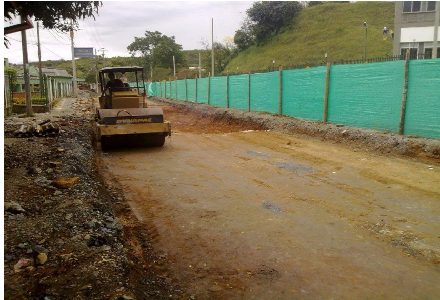
Figura 43. Compactación con Vibrocompactador.
