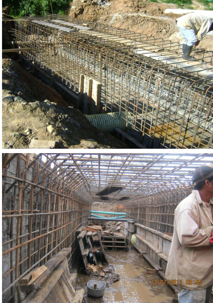
Figura 15. Acero de refuerzo en losa superior de Box Coulvert.
