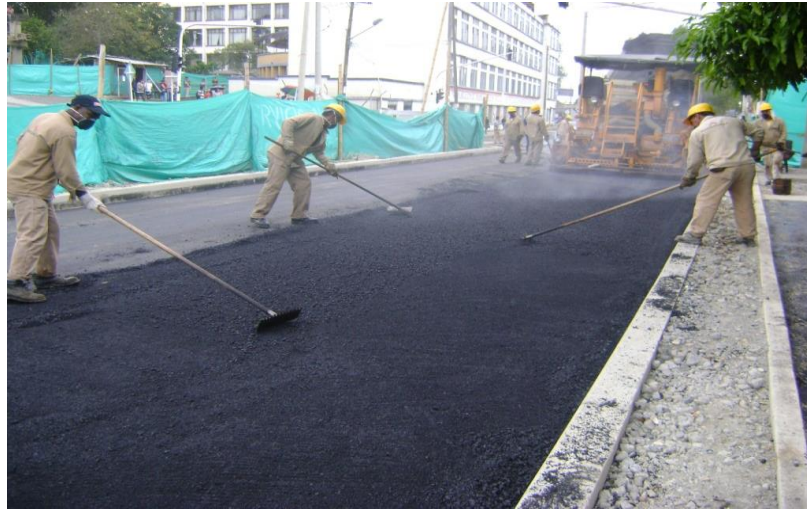
Figura 62. Venteadores trabajando sobre mezcla asfáltica extendida.
