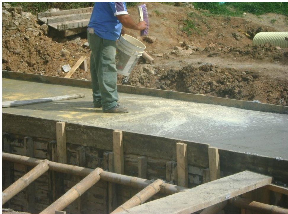
Figura 23. Curado del concreto en la losa superior de Box Coulvert.
