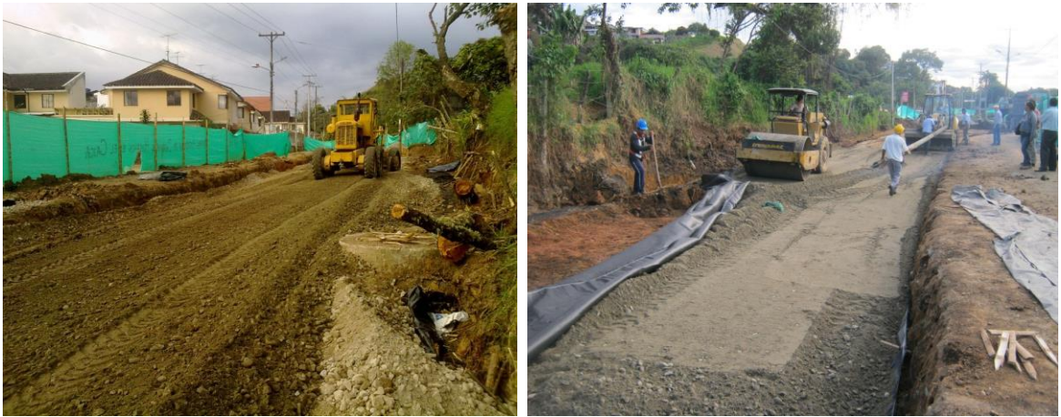
Figura 41. Perfilado y compactación de subrasante.
