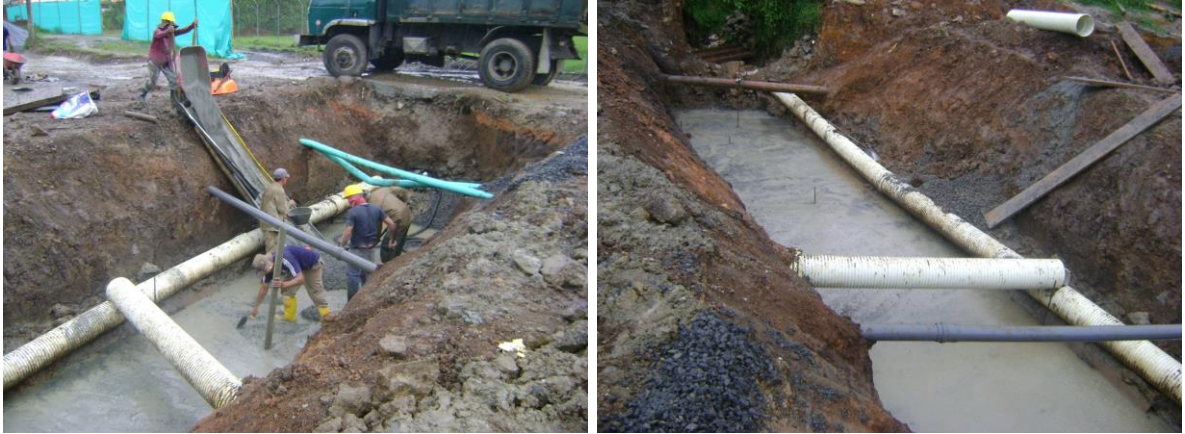
Figura 11. Vaciado, distribución y terminado de solado de Limpieza.
