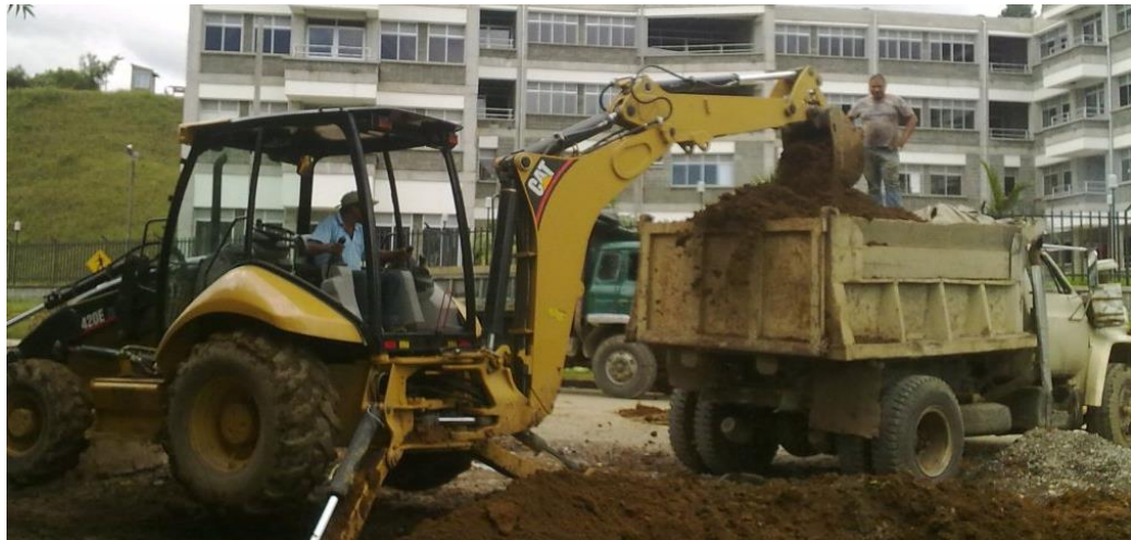
Figura 29. Remoción de Material con Retroexcavadora.
