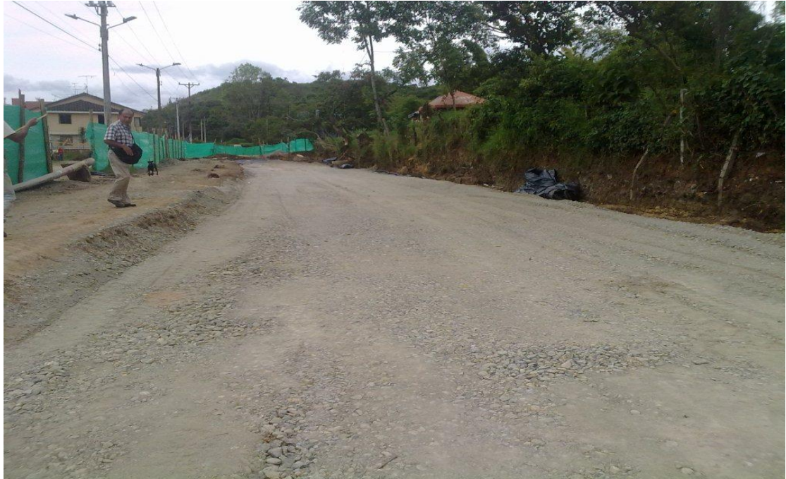
Figura 42. Mejoramiento de Subrasante con material de Sub-base granular.
