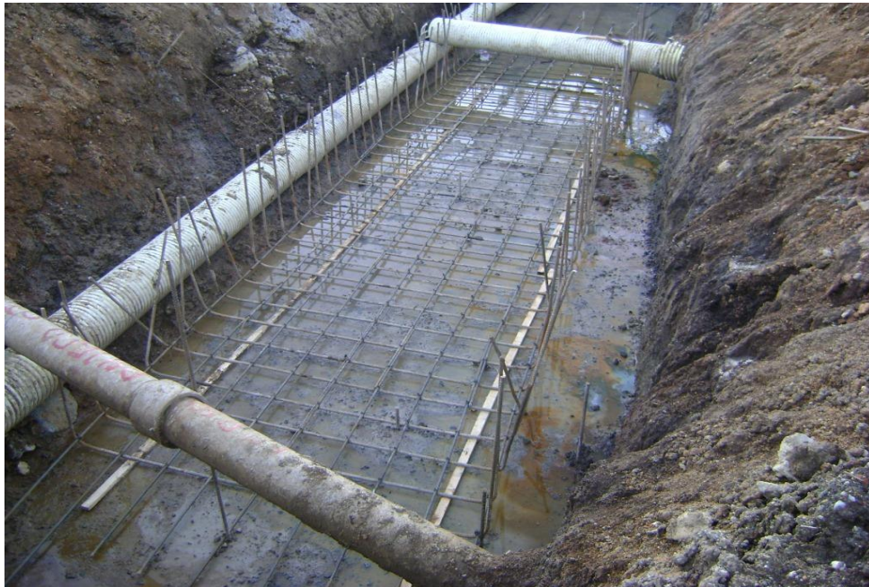
Figura 12. Refuerzo transversal y longitudinal en parrilla inferior de losa de piso.
