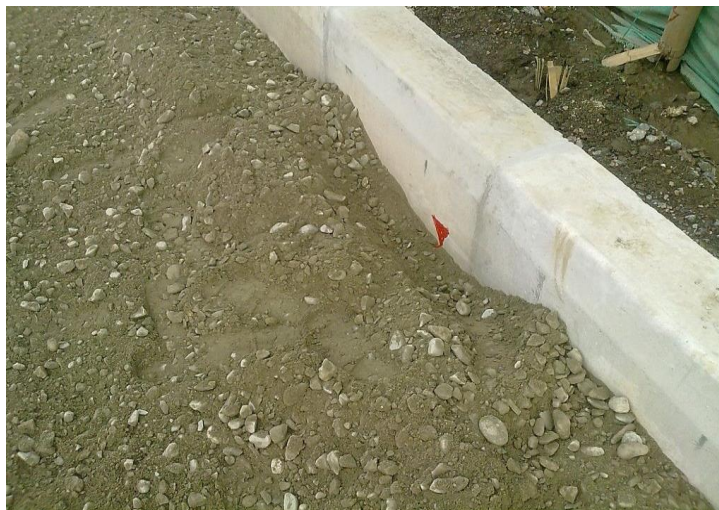
Figura 52. Niveletas para capa de Base Granular.
