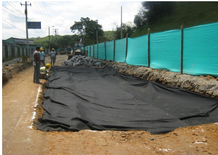
Figura 33. Instalación de Geotextil Tejido T2400.
