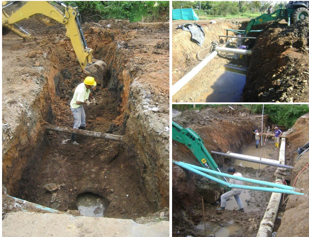
Figura 10. Excavación con medio mecánico y Manejo de Aguas de la quebrada.
