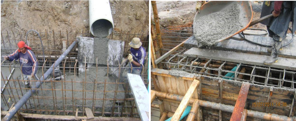
Figura 18. Vaciado del concreto.
