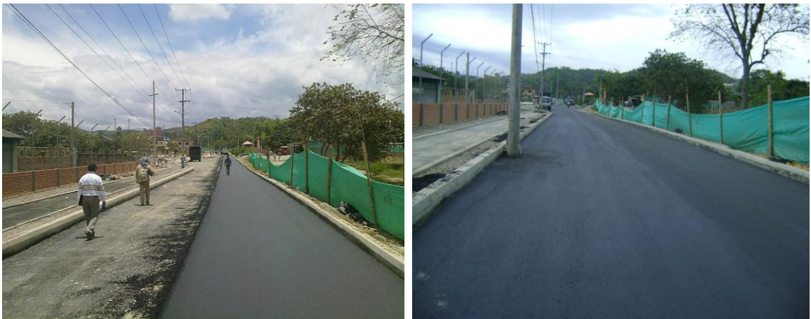
Figura 67. Carpeta asfáltica Compactada y terminada.
