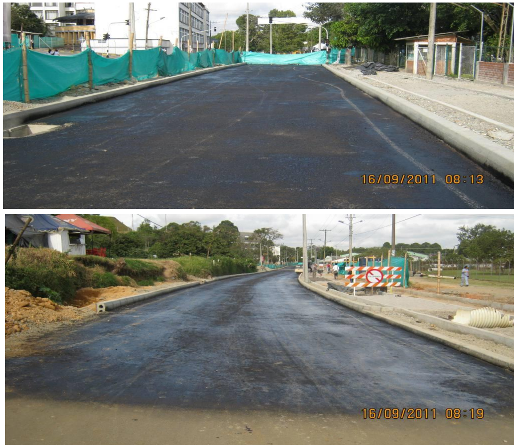
Figura 59. Superficie de la calzada imprimada.
