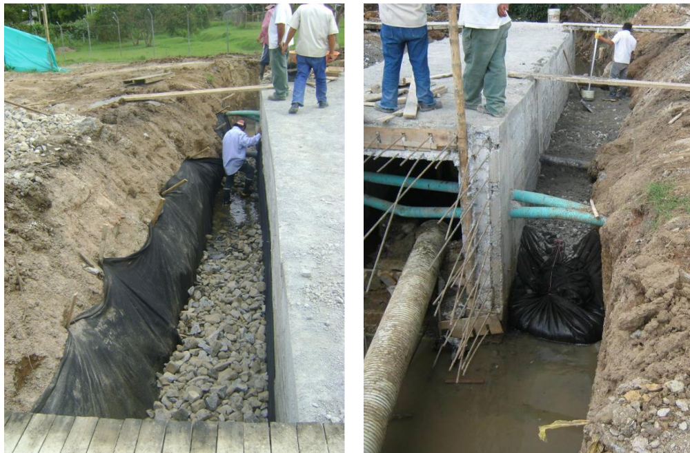
Figura 26. Construcción del filtro Adicional.
