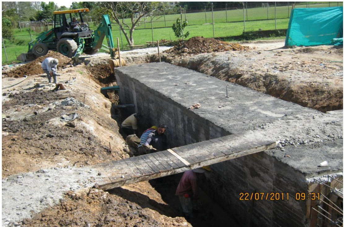
Figura 20. Desencofrado de Box Coulvert, Abs k0+207.
