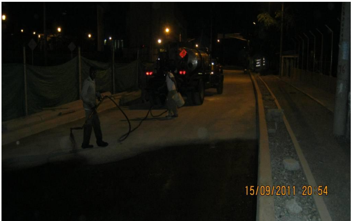
Figura 58. Aplicación del riego de imprimación.
