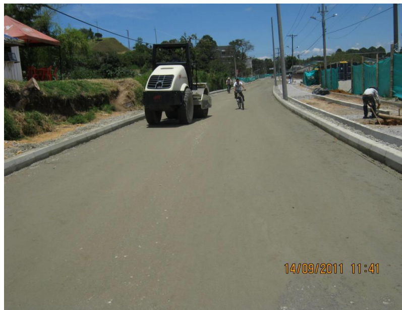
Figura 55. Compactación de la base con vibrocompactador.
