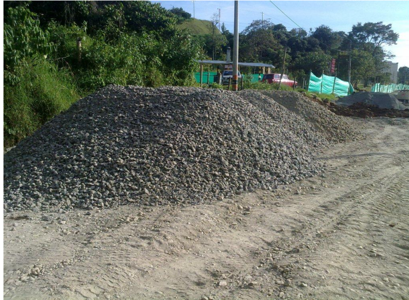
Figura 46. Material de Sub-base Granular acordonado en obra.
