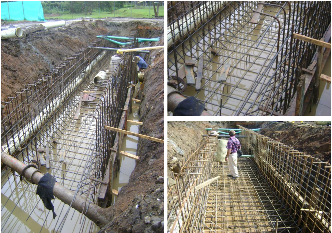
Figura 14. Acero de refuerzo para losa de piso y muros laterales.
