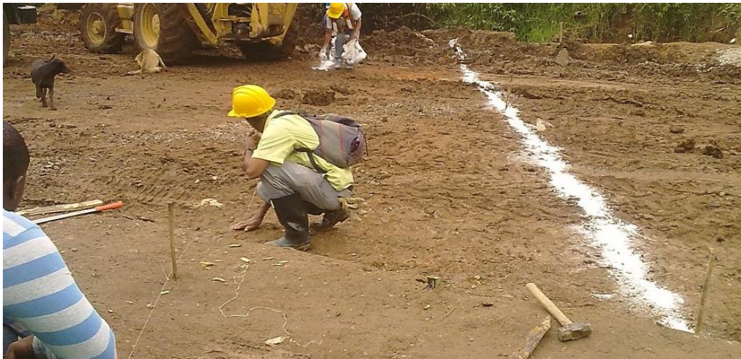
Figura 9. Demarcación con cal del ancho de excavación.
