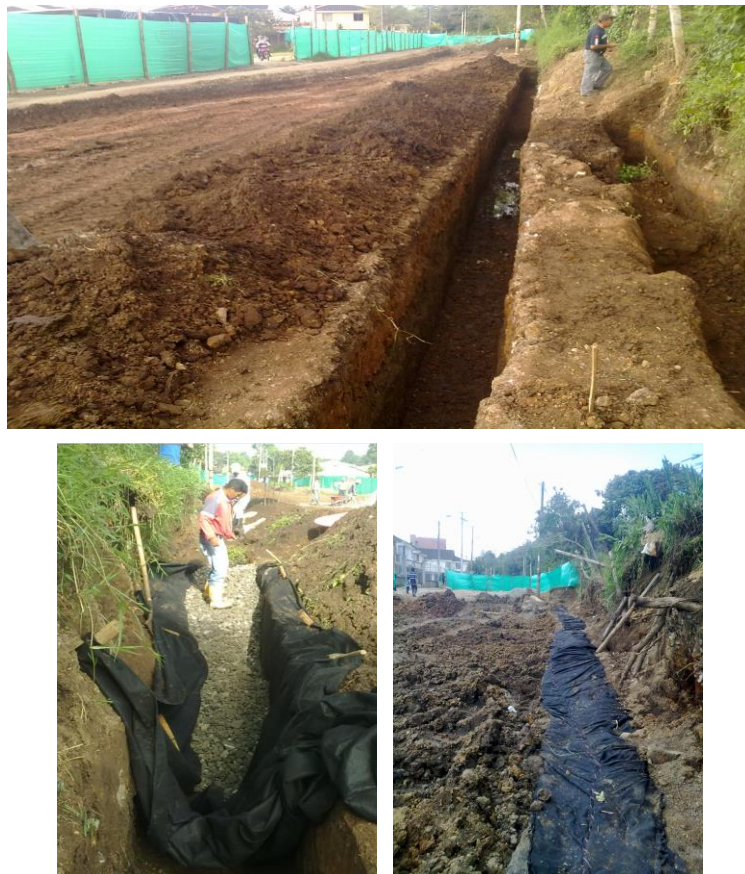
Figura 24. Construcción del Filtro.
