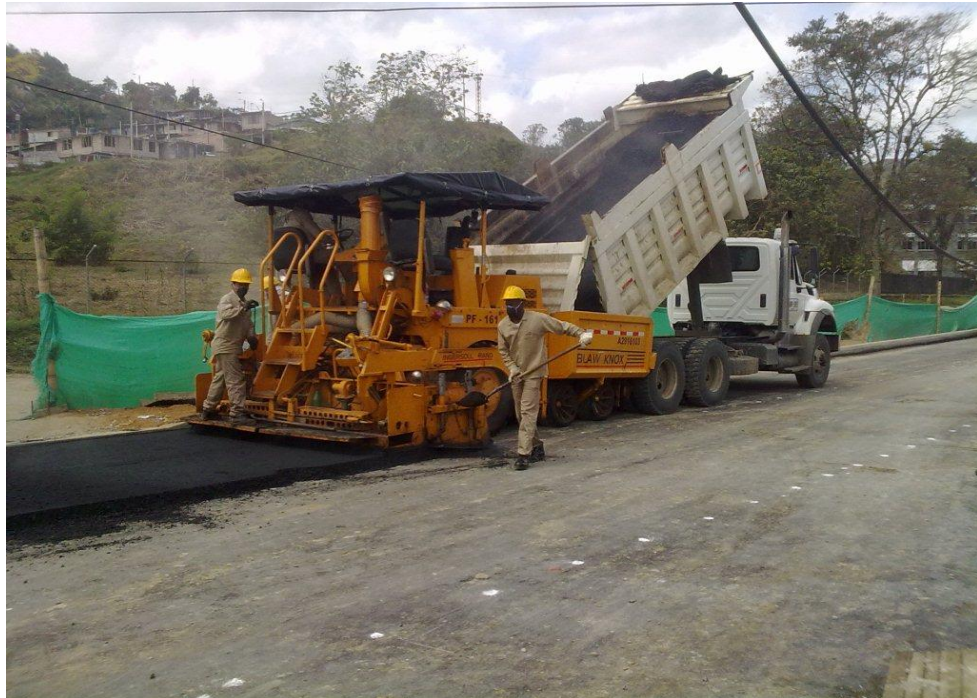
Figura 60. Vertimiento de la mezcla en la Finisher.
