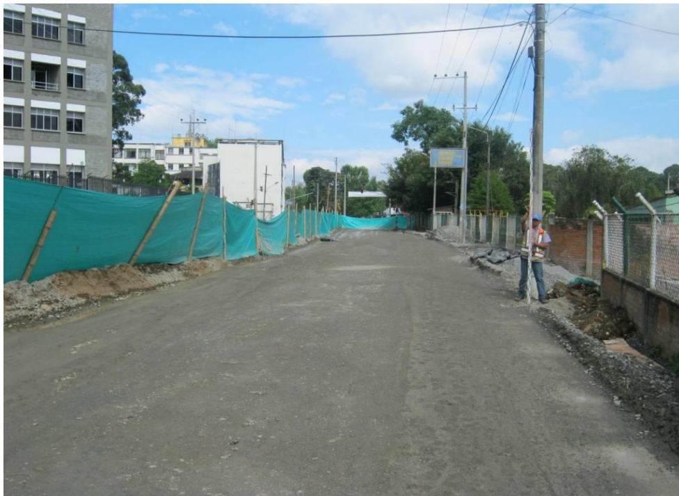
Figura 49. Capa de Sub-base compactada y terminada.
