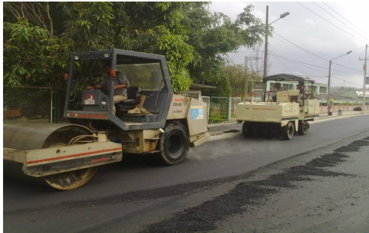
Figura 66. Compactación intermedia y final, Compactador Neumático.
