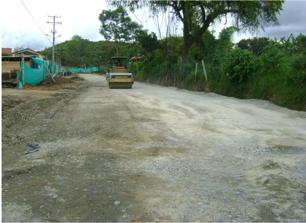
Figura 48. Compactación con Vibrocompactador.
