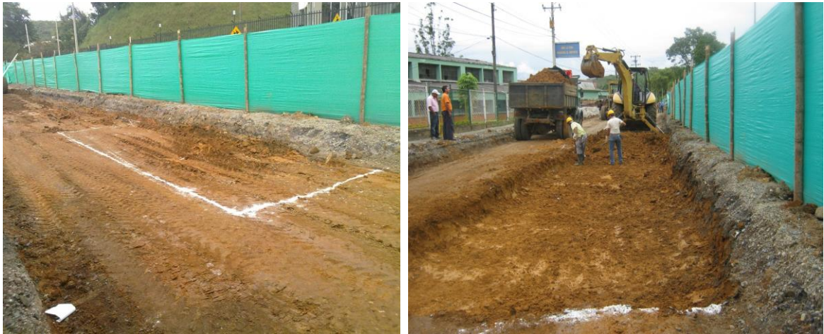
Figura 32. Demarcación, Excavación y remoción de material del fallo.
