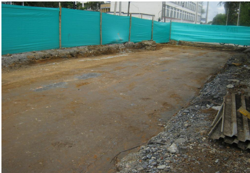
Figura 44. Subrasante nivelada y compactada.
