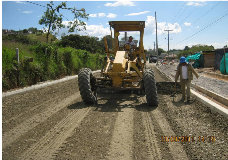
Figura 53. Nivelación de la capa de base con motoniveladora.
