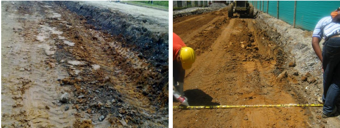
Figura 31. Suelo orgánico, presente en la subrasante.
