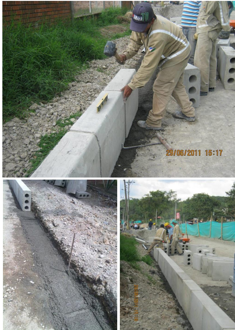
Figura 51. Instalación de sardinel Prefabricado sobre Sub-base.
