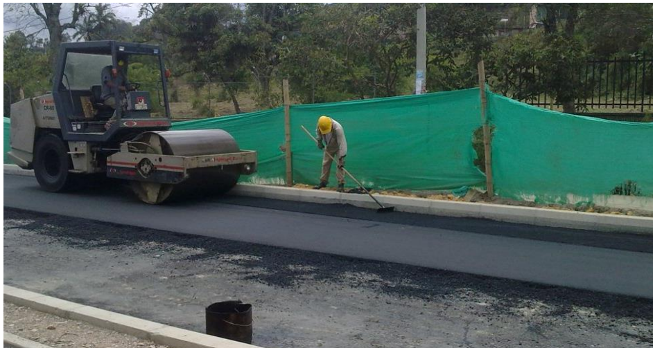
Figura 63. Compactación primaria con compactador de rodillo liso.
