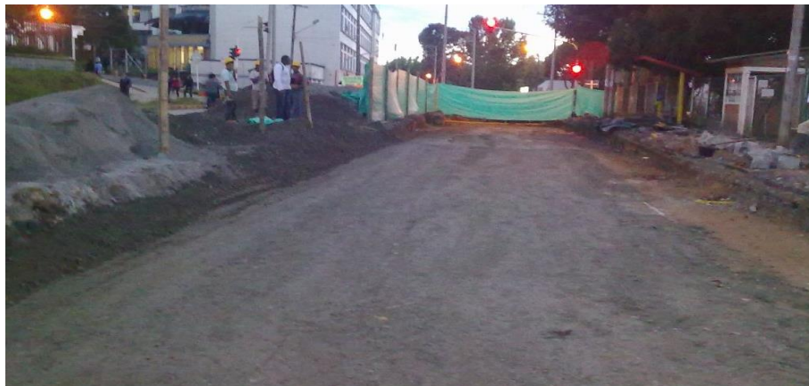
Figura 37. Subrasante después de su respectivo mejoramiento.
