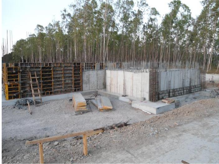
**Figura 6. Formaleta Nevy para muros de cimentación**
