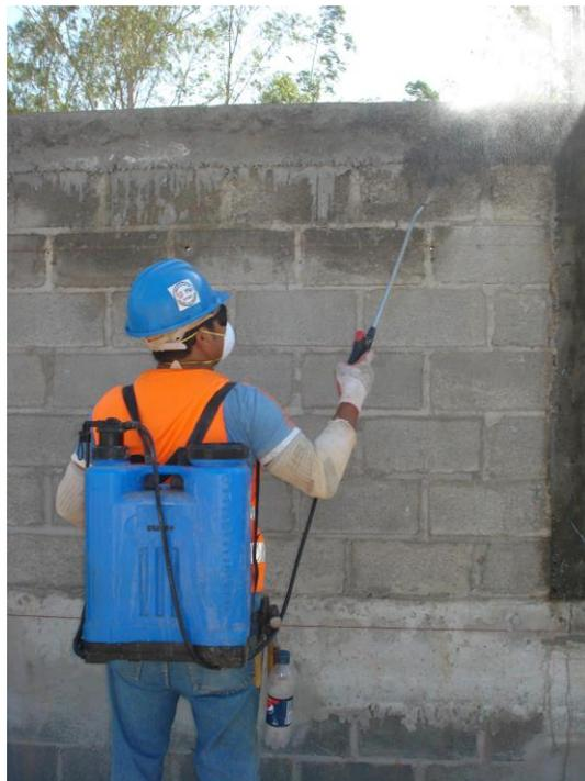
**Figura 26. Aplicación del curador**
