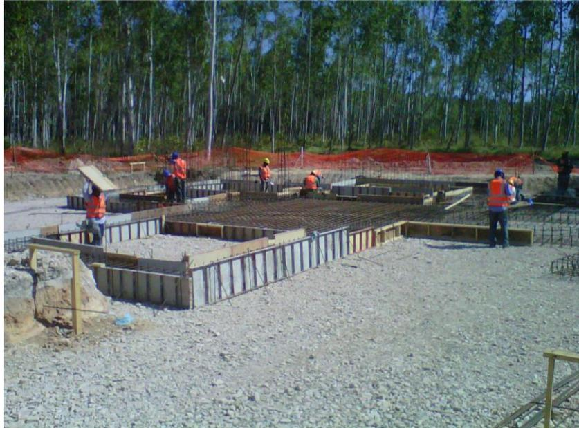
**Figura 3. Armadura y Formaleta para zapatas**
