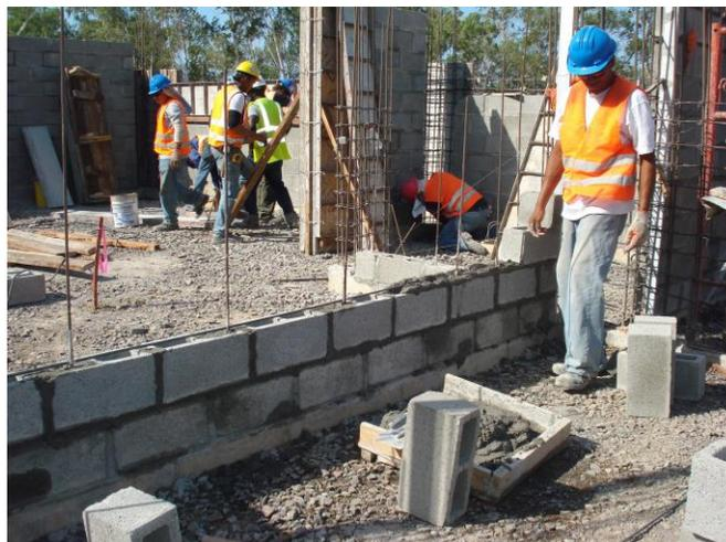
Figura 10. Construcción muro en mampostería
