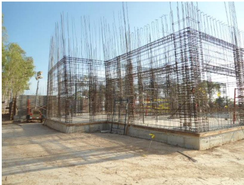
**Figura 17. Acero figurado y colocado**
