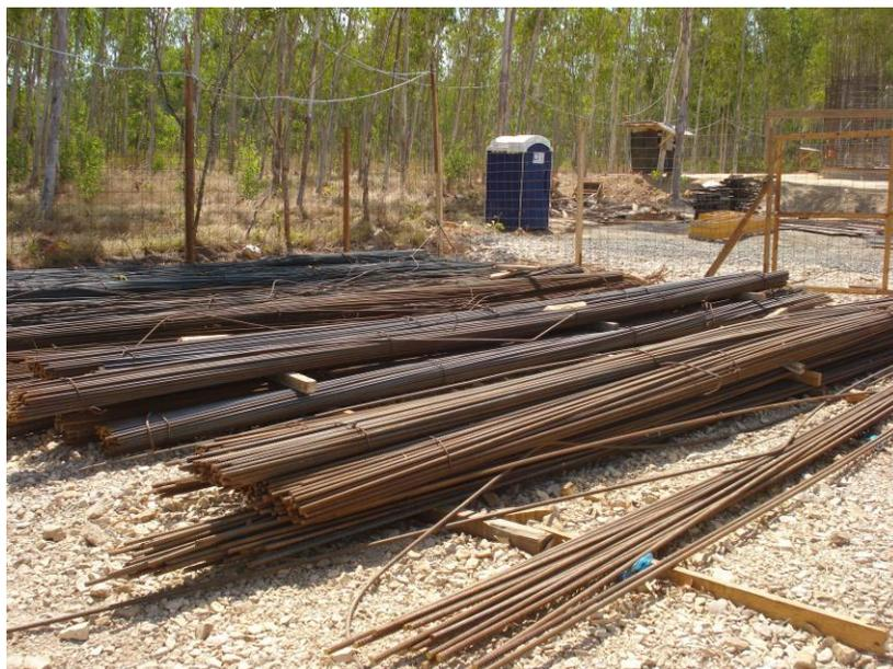
**Figura 16. Almacenamiento barras acero sin cortar**
