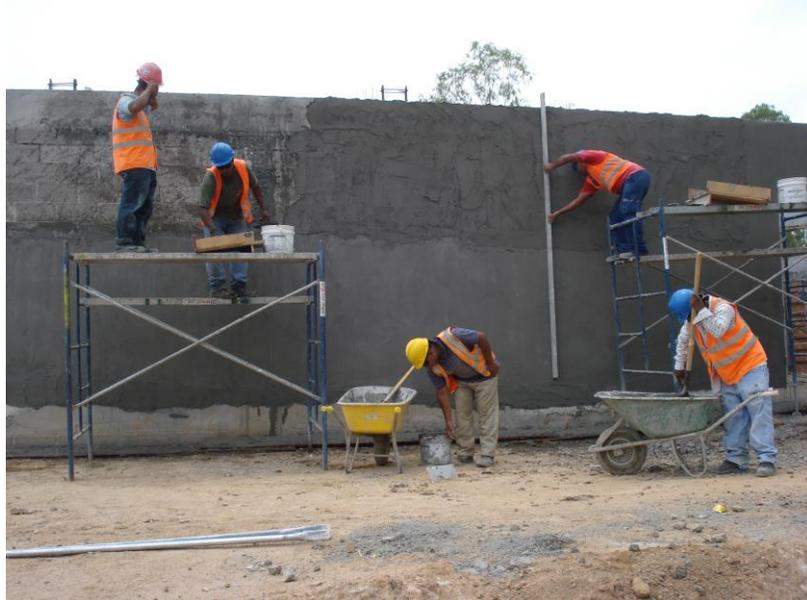
**Figura 29. Aplicación del repello**
