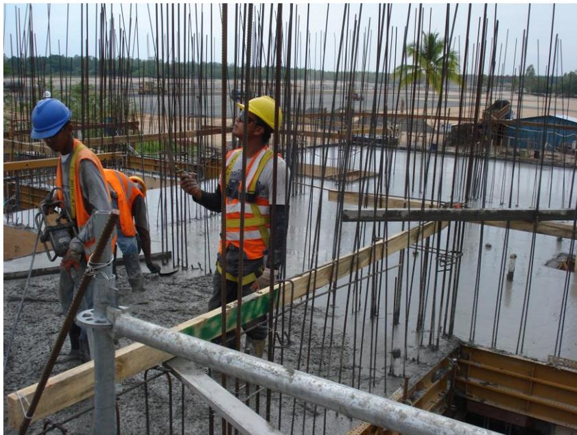
**Figura 25. Proceso de fundición losa**
