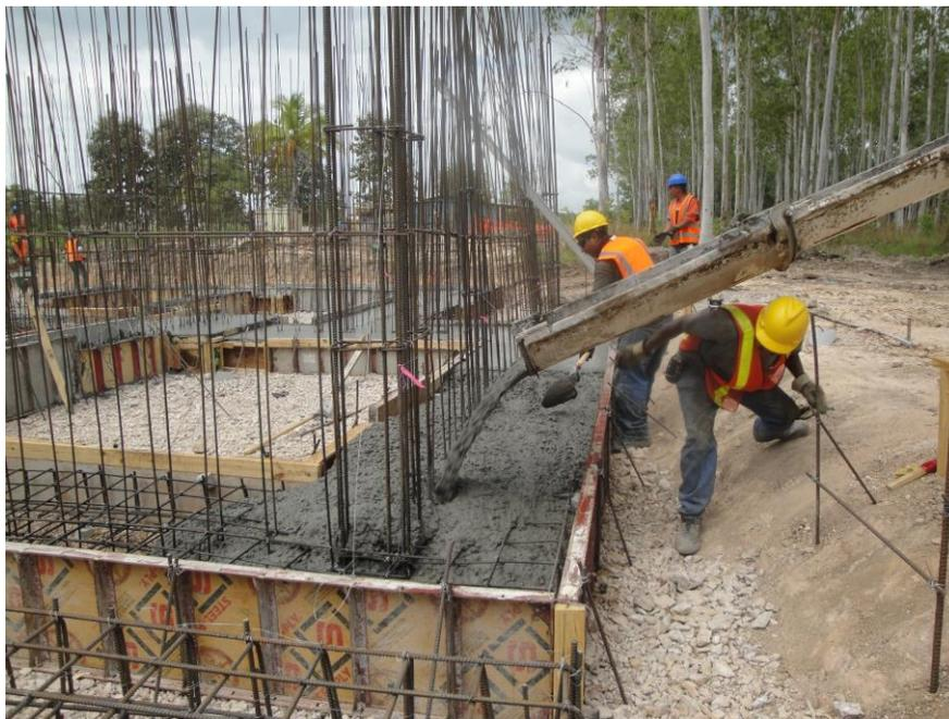
**Figura 4. Vaciado del concreto en zapatas**
