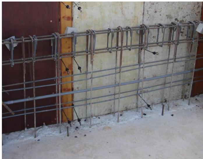
**Figura 19. Loop Ties y taches de acero**
