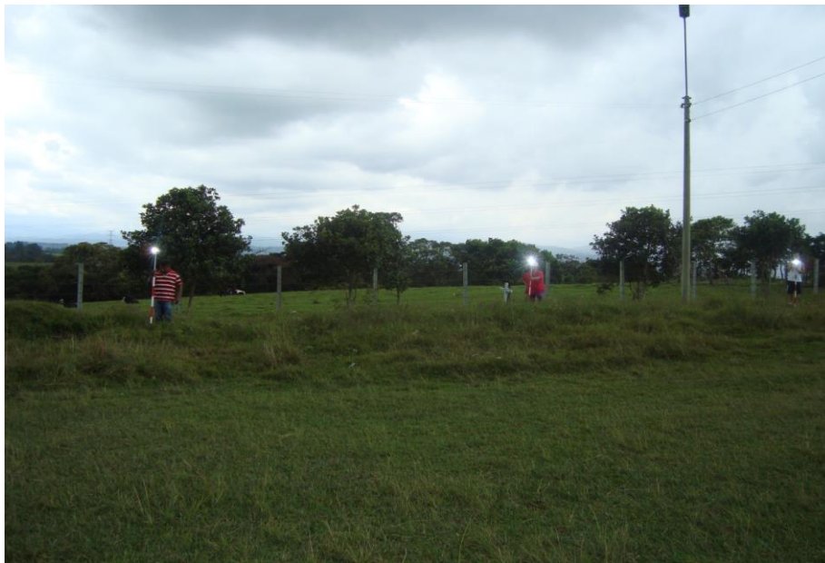
Foto N°2: Toma de puntos de topografía.
