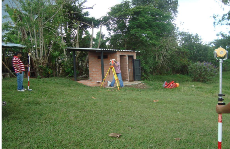
Foto N°3: Toma de puntos de topografía.
