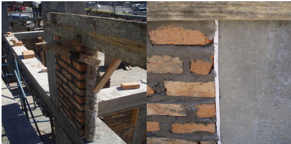
FIGURA 27. Detalle dilatacion de muros
