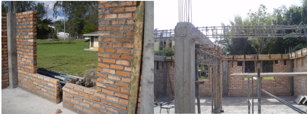
FIGURA 26. Demolicion de muros y vigas
