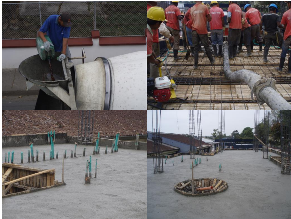
FIGURA 42. Fundición de la losa de entrepiso y aplicación del aditivo acelerante al concreto premezclado
