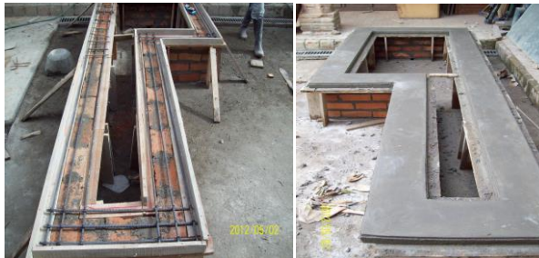
FIGURA 11. Procedimiento de construcción de las materas
