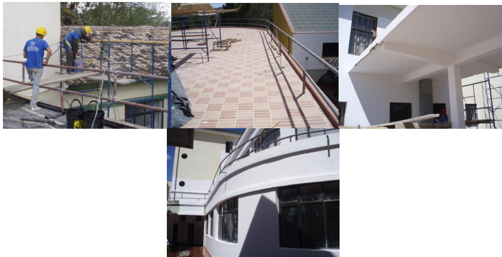
FIGURA 49. Equipo para trabajar en alturas, pega de enchape para pisos, estuco y pintura de muros
