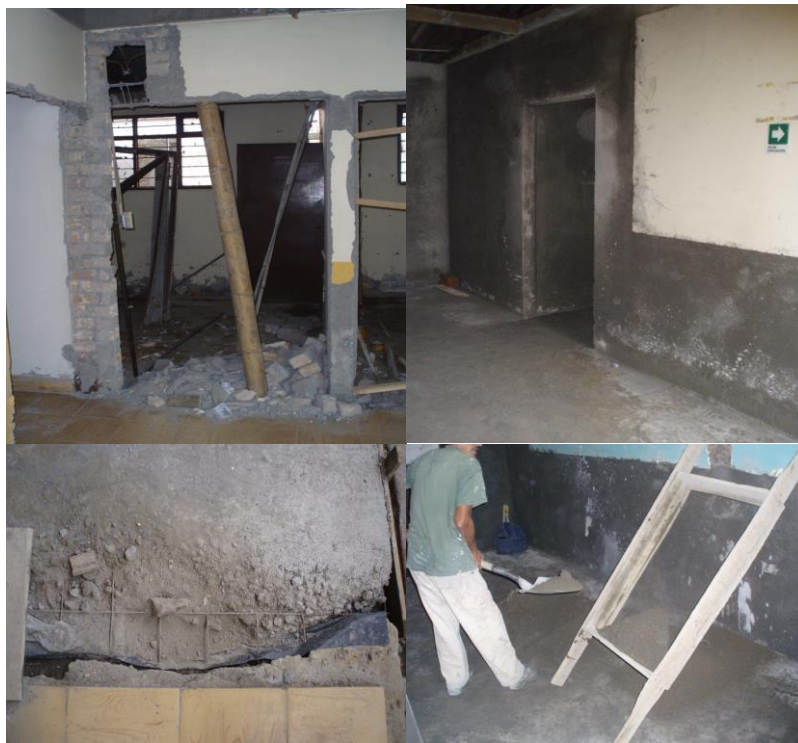
FIGURA 55. Geotextil del piso primario, repello de muros
