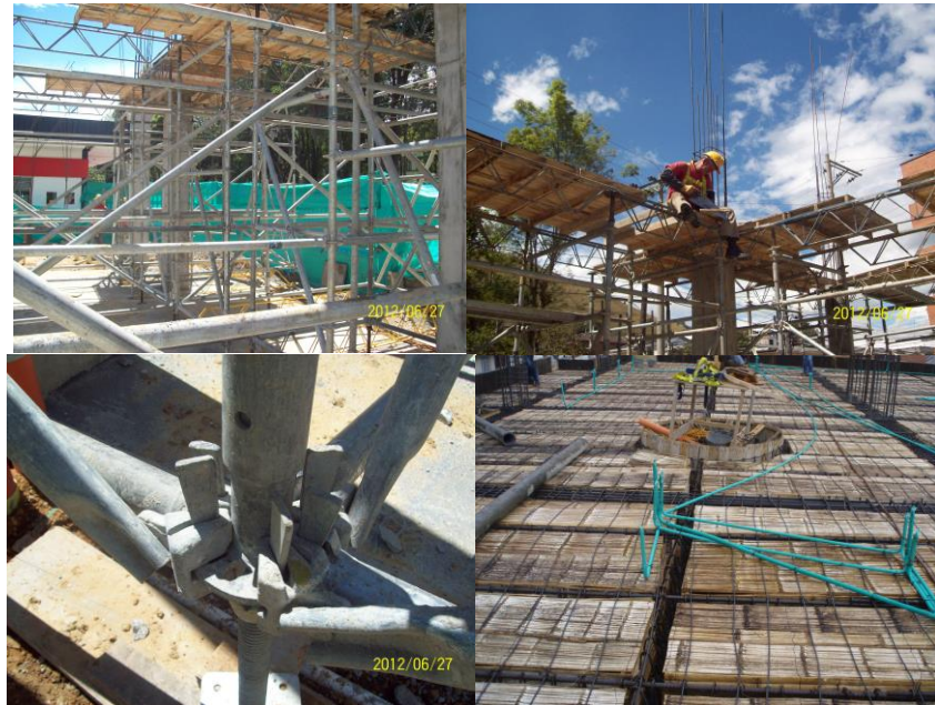
FIGURA 41. Formaleta para la losa de entrepiso y casetones
