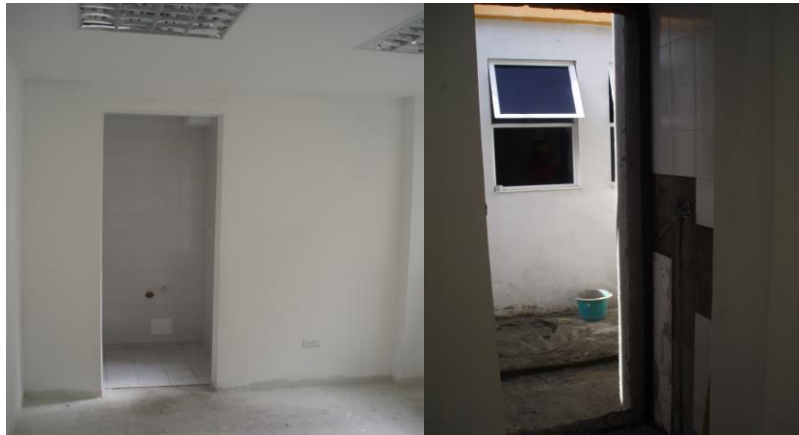
FIGURA 30. Construcción de media caña en las esquinas y apertura de puertas en muros existentes
