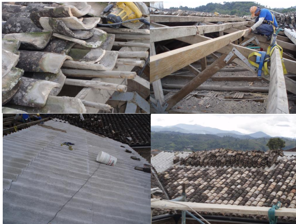
FIGURA 10. Procedimiento del cambio de estructura
