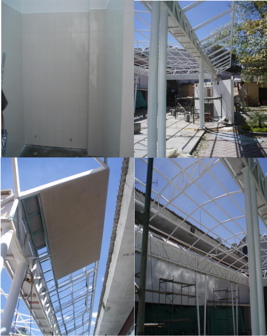
FIGURA 46. Avance de obra
