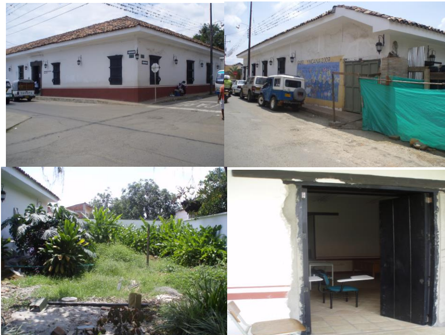
FIGURA 50. Fachadas exteriores, salones y patio posterior
