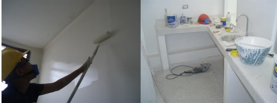
FIGURA 54. Aplicación de pintura epoxica
