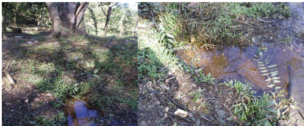
FIGURA 22. Brote de agua en la zona de la porteria sur de ingenierías
