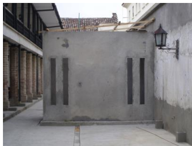
FIGURA 12. Terminación de la fase constructiva
