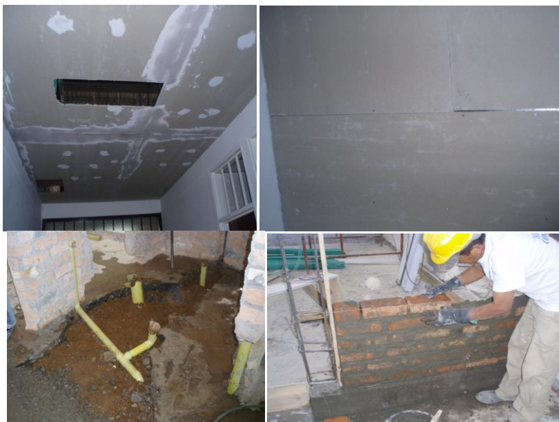
FIGURA 35. Colocación de cielo falso, demolición y construcción de muros
