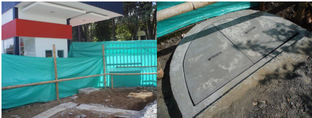
FIGURA 37. Acomodo de límites y elementos de desagüe
