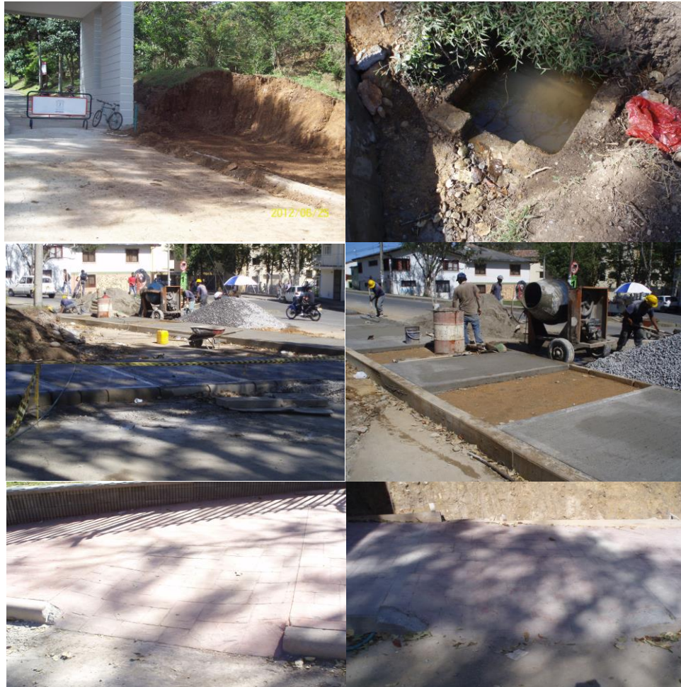
FIGURA 24. Movimiento de tierra para construir los andenes, construcción del filtro para el brote de agua, fundición de los andenes y ubicación de las rampas para discapacitados
