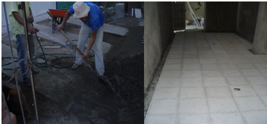
FIGURA 31. Mezcla del mortero de nivelacion y pega de piso
