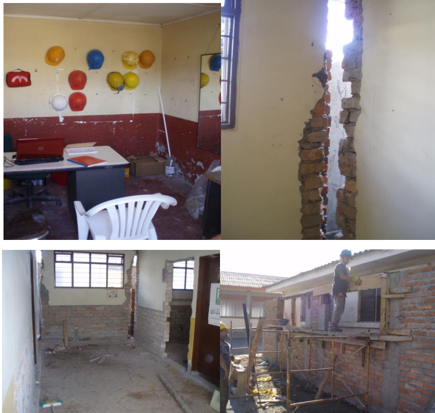
FIGURA 53. Oficina de la obra, demolición y levantamiento de muros
