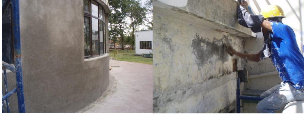
FIGURA 48. Rasqueteo y repello de muros
