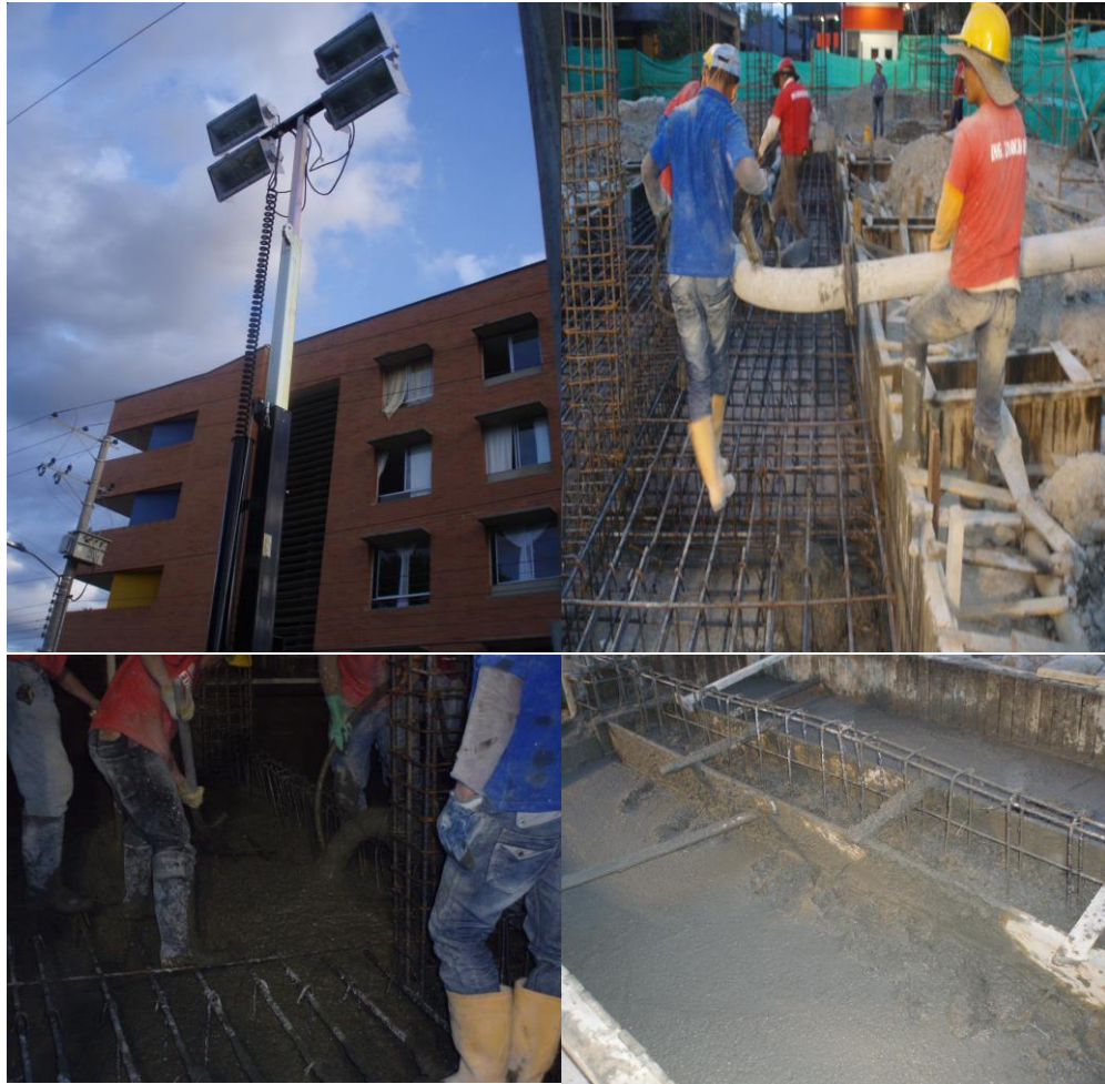
FIGURA 39. Fundición de zapatas en horas de la noche
