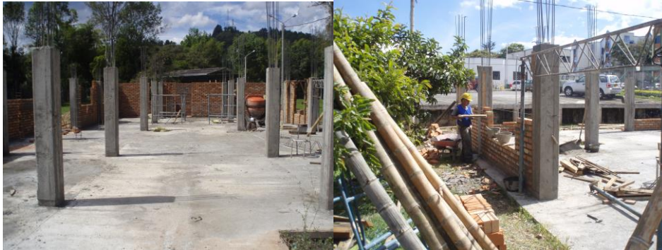
FIGURA 25. Construcción de columnas y levantamiento de muros
