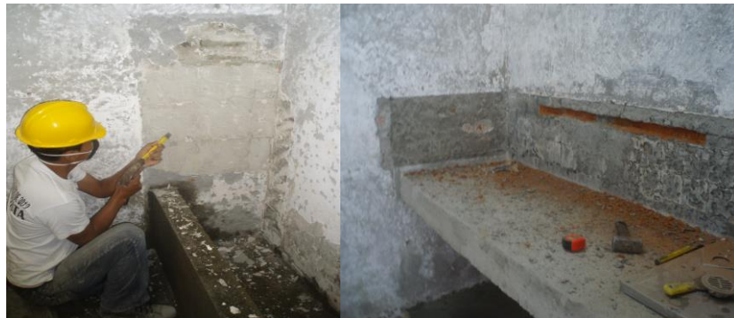
FIGURA 34. Demolicion del enchape de la cafeteria
