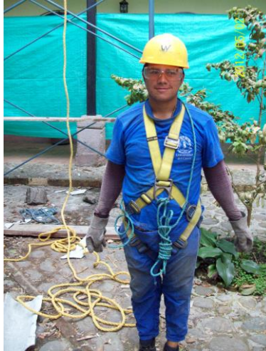
FIGURA 7. Implementación del equipo de seguridad para trabajar en alturas
