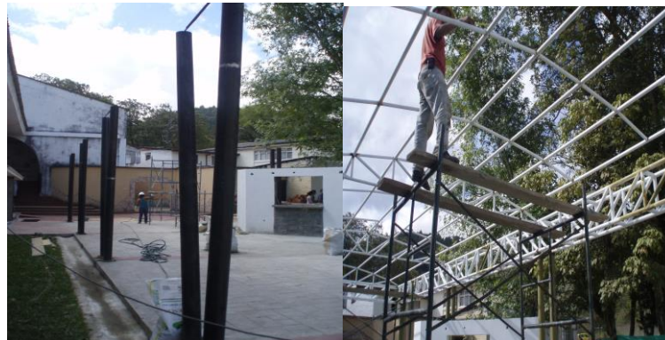
FIGURA 45. Colocacion de la estructura de cubierta
