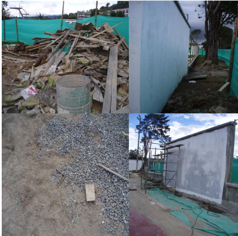
FIGURA 13. Aspecto físico en el lugar de la obra
