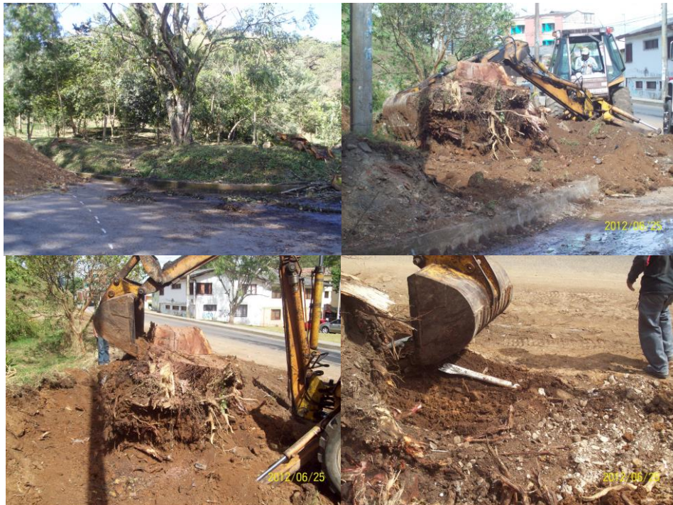
FIGURA 23. Retiro de Raices en la zona de construccion
