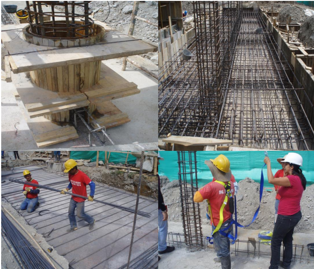
FIGURA 38. Ubicación del refuerzo, colocación de formaleta e implementación de elementos de seguridad
