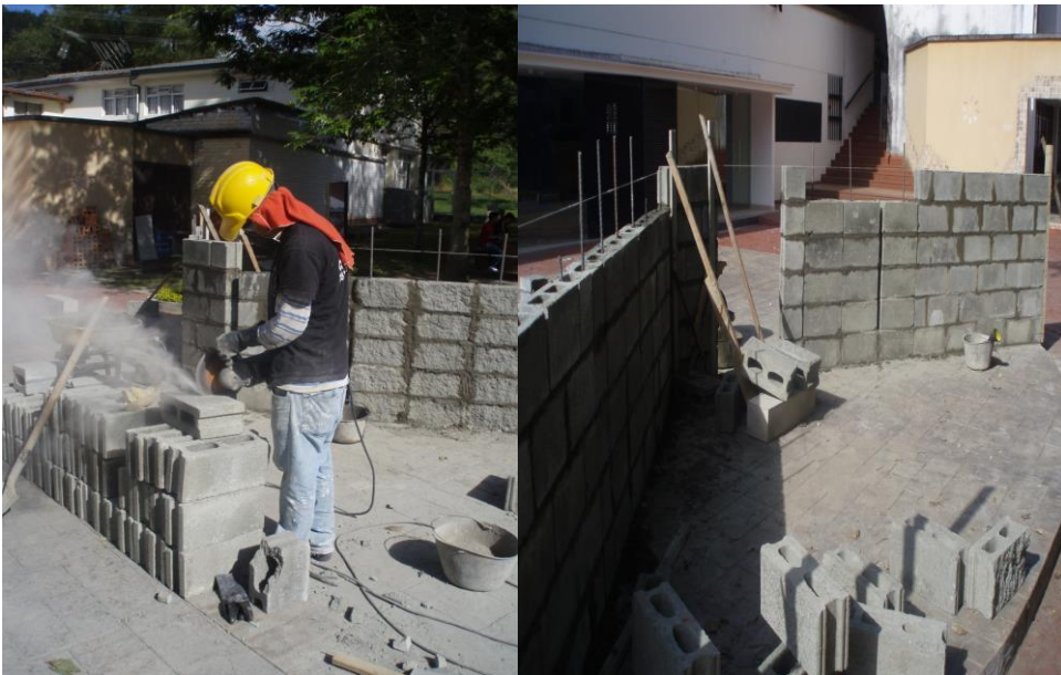
FIGURA 43. Corte de bloques y levantamiento de muros con los mismos
