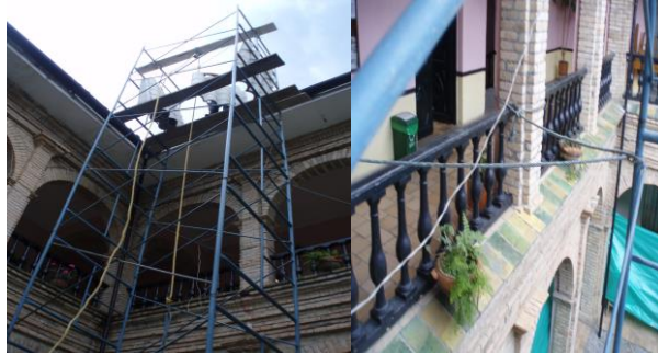
FIGURA 8. Equipo a utilizar para trabajos en alturas
