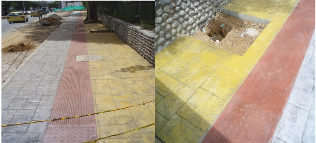
FIGURA 21. Terminación del estampado de los Andenes
