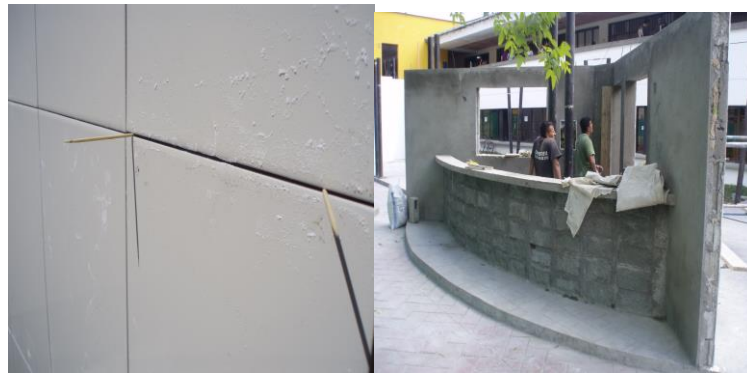
FIGURA 44. Enchape de los baños y construccion mini tienda
