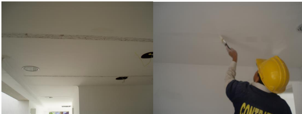
FIGURA 29. Obras de Restauración en el cielo falso
