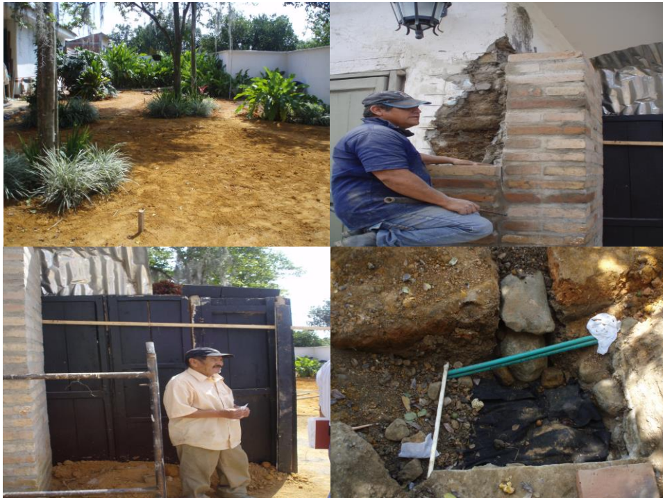
FIGURA 51. Trabajos en el portalon y en el patio posterior
