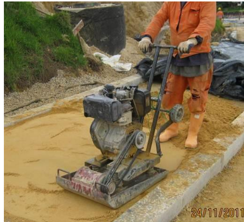
Fotografía 6. Compactador de placa (Rana).
