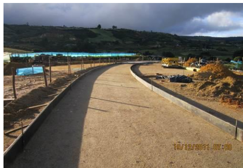
Fotografía 23. Capa de base terminada.
