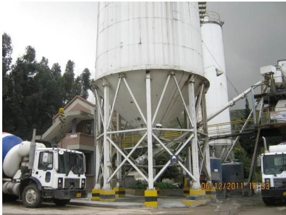
Fotografía 1. Planta de concreto sur CEMEX
