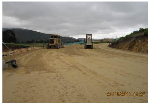
Fotografía 22. Construcción capa de base granular.
