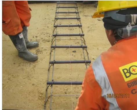
Fotografía 25. Alineación de canastilla.
