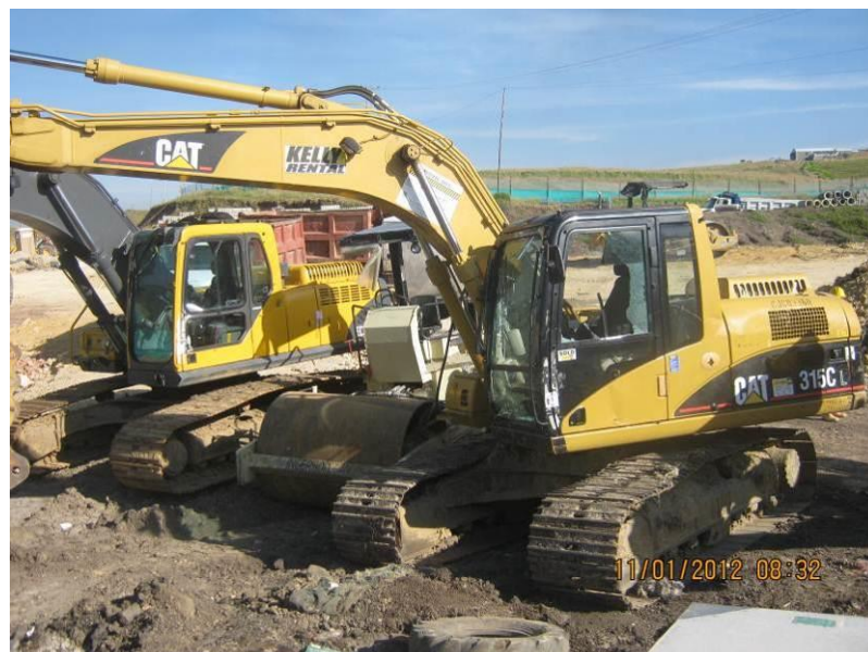
Fotografía 11. Excavadoras hidráulicas de orugas.
