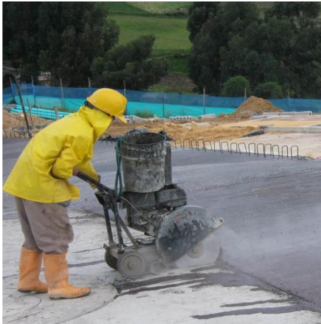
Fotografía 14. Cortadora de pavimento.
