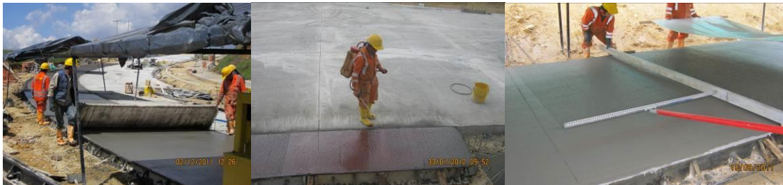
Mosaico fotográfico 9. Micro, macro texturizado y aplicación de antisol.
