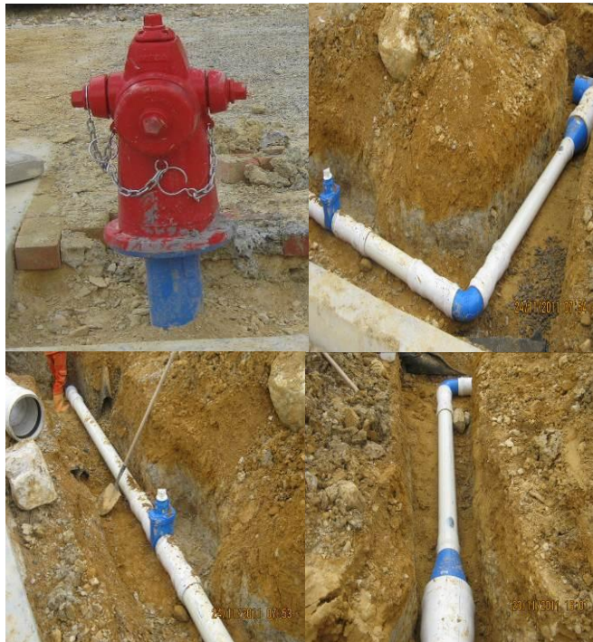
Mosaico fotográfico 5. Accesorios y tubería red de acueducto - APOLO AVA
