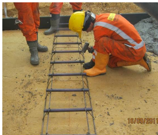
Fotografía 26. Anclaje de canastillas.
