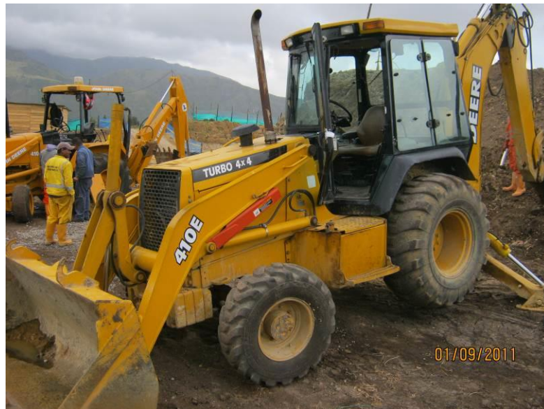
Fotografía 10. Excavadoras hidráulicas de llanta tipo pajaritas.
