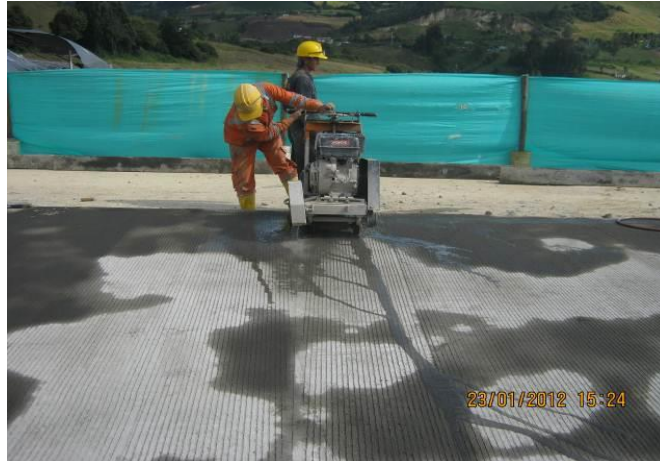
Fotografía 29. Corte de juntas.
