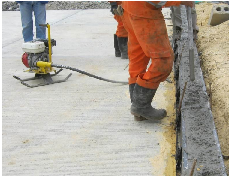
Fotografía 16. Vibrador de aguja.
