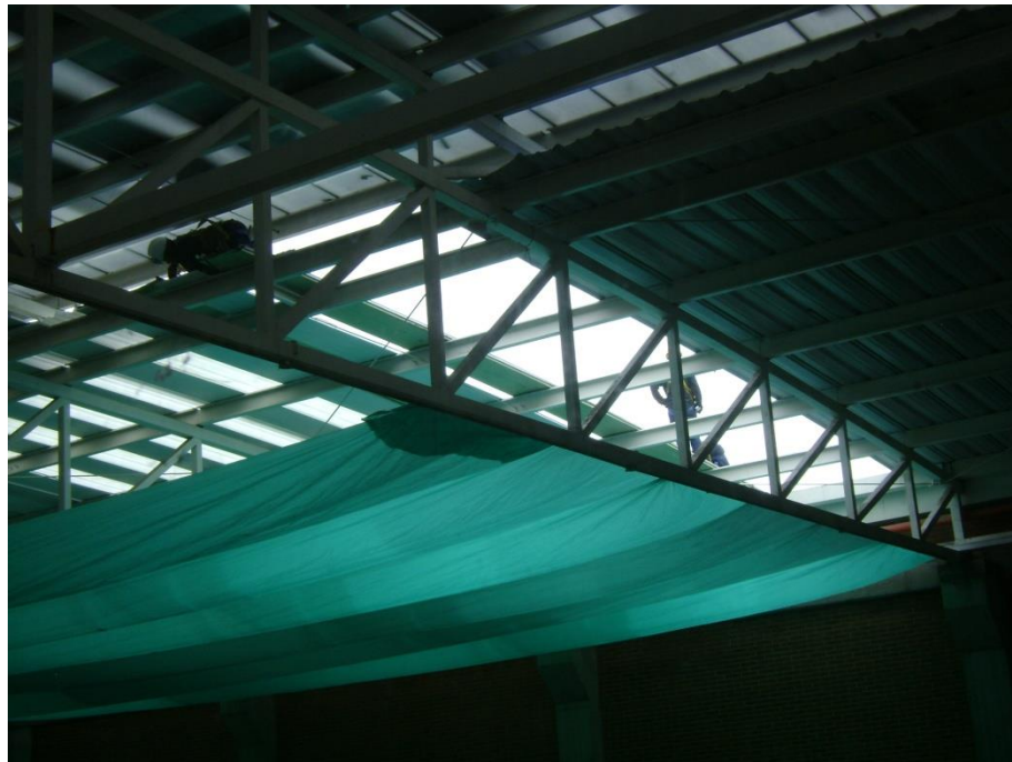
IMAGEN 8. INSTALACIÓN DE TEJAS COSTADO SUR.
