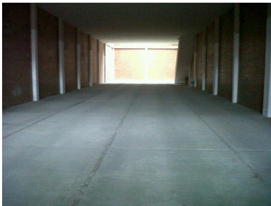
IMAGEN 46. PRIMER PISO BODEGA ALEDAÑA ALMACENAMIENTO TIGERCOMPANIES.
