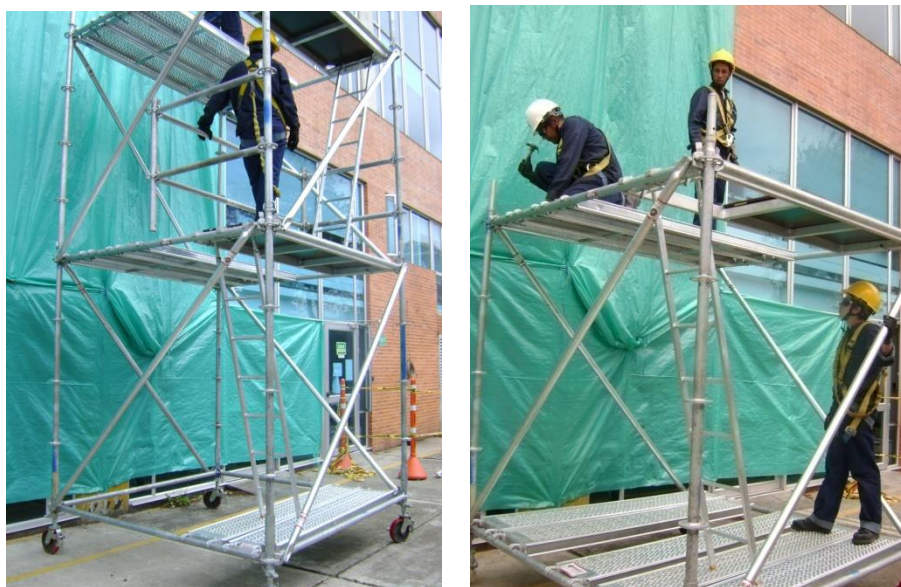
IMAGEN 7. ARMADO DE ANDAMIO PARA ACCESO.
