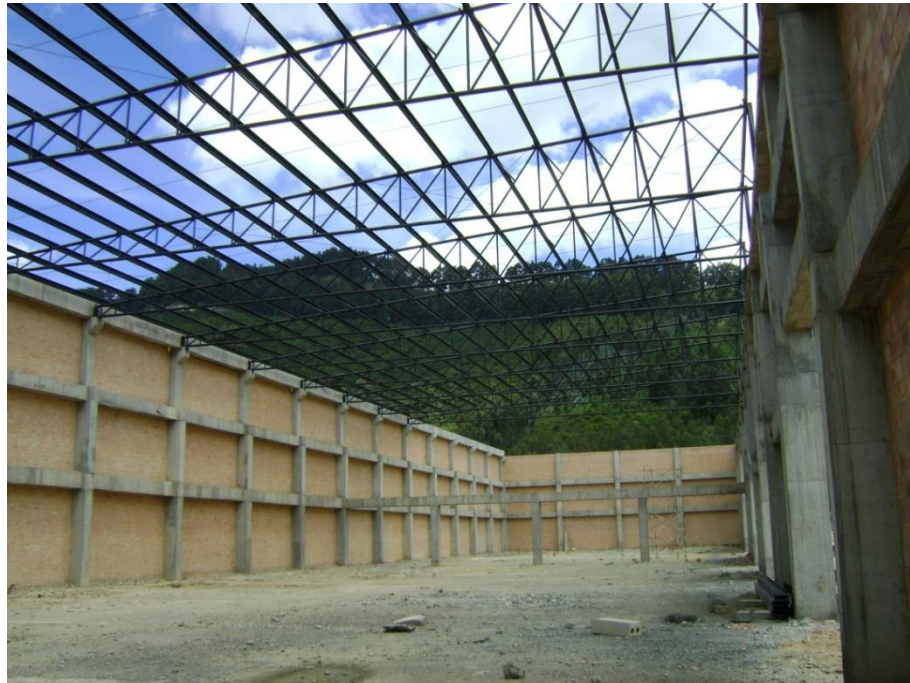
IMAGEN 35. ESTADO ACTUAL DE BODEGA PARQUE INDUSTRIAL TIBITO.
