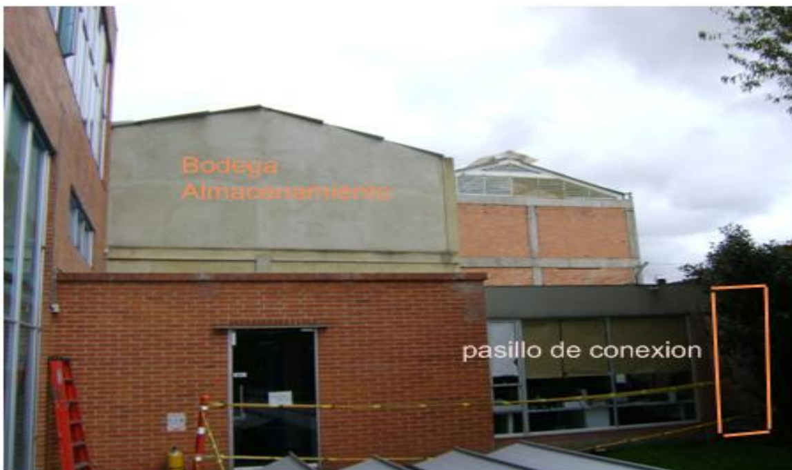
IMAGEN 48. PASILLO DE FUTURA CONEXIÓN ENTRE BODEGA Y OFICINAS ACTUALES.
