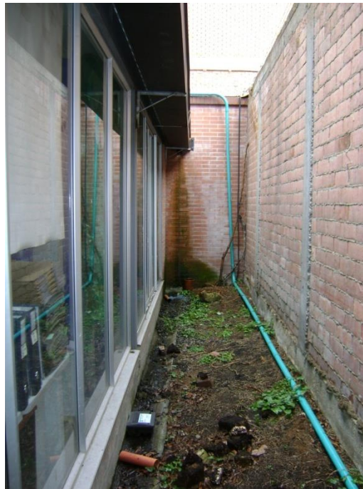
IMAGEN 49. PASILLO DE TRANSITO ENTRE BODEGA Y OFICINAS ACTUALES.
