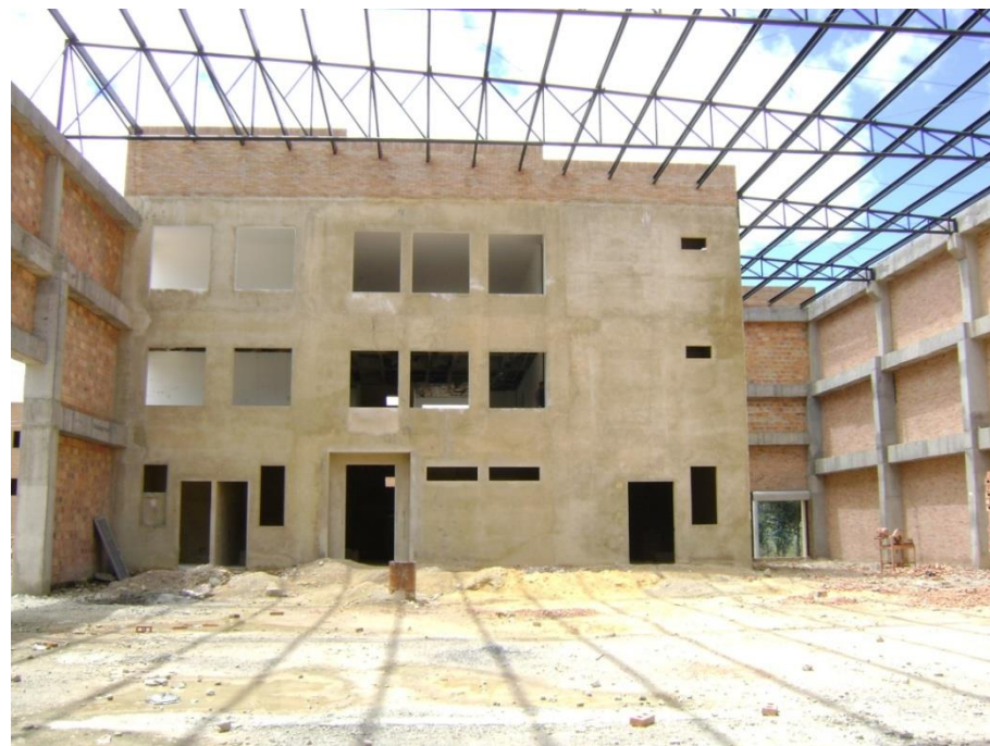
IMAGEN 36. ESTADO ACTUAL OFICINAS PARQUE INDUSTRIAL TIBITO.
