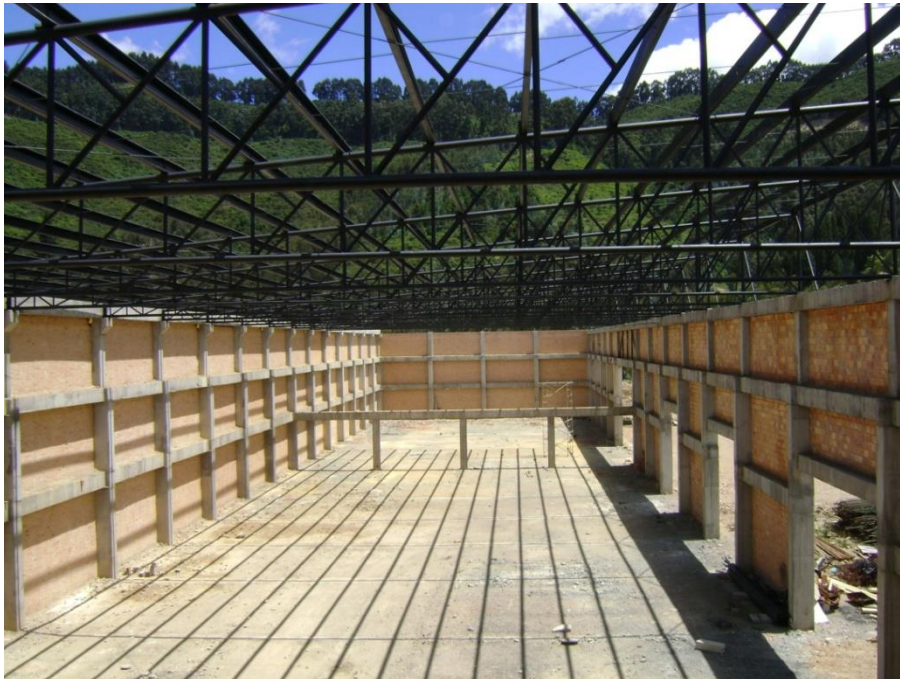
IMAGEN 37. ESTADO ACTUAL DE BODEGA DE ALMACENAMIENTO PARQUE INDUSTRIAL TIBITO.
