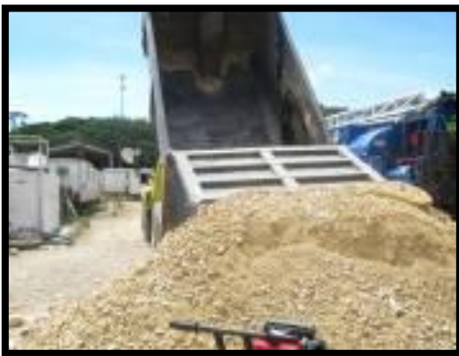
12.Fotografía -Colocando Material Afirmado-
