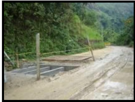
46.Fotografía -Construcción de Quiebrapatas-
