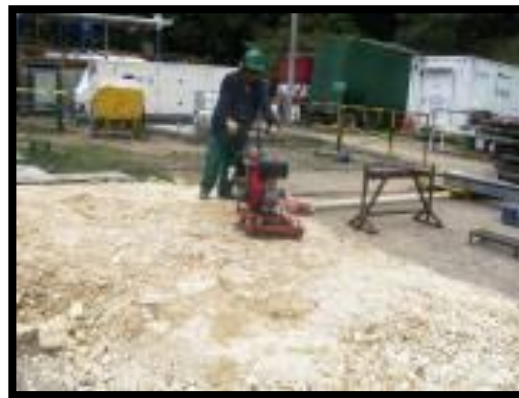
13.Fotografía -Compactación con Rana-
