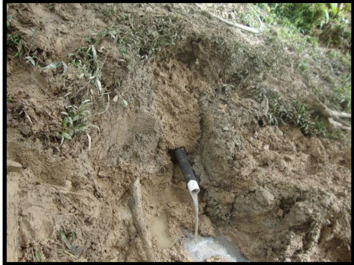
10.Fotografía -Dren Horizontal Funcionando-
