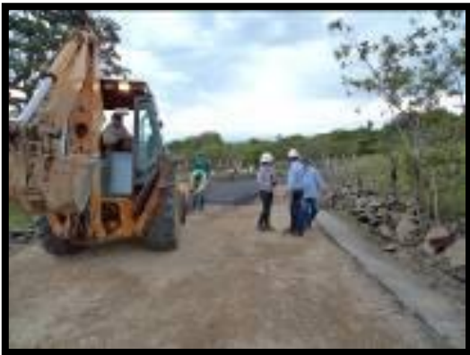
36.Fotografía -Retiro de Carpeta Deteriorada-
