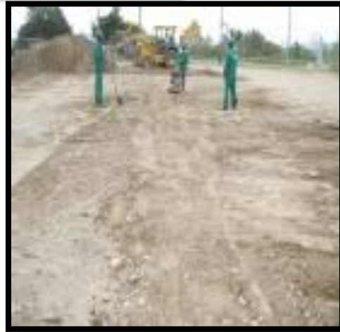
25-26.Fotografías -Relleno y Compactación de Zanjas-
