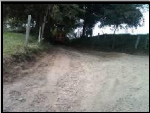
40.Fotografía -Cruce Vereda Madroño (Antes)-
