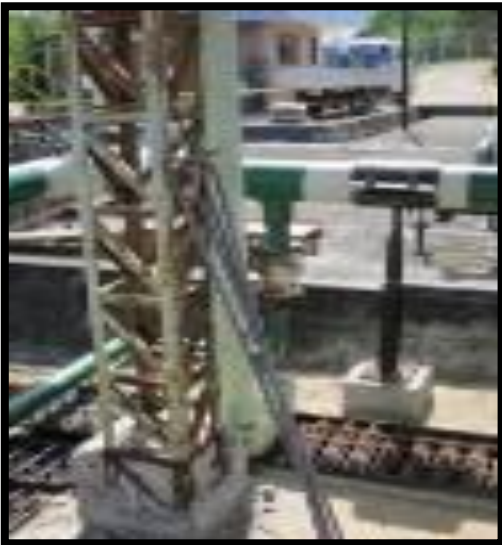
21.Fotografía -Estructura Metálica (Antes)-
