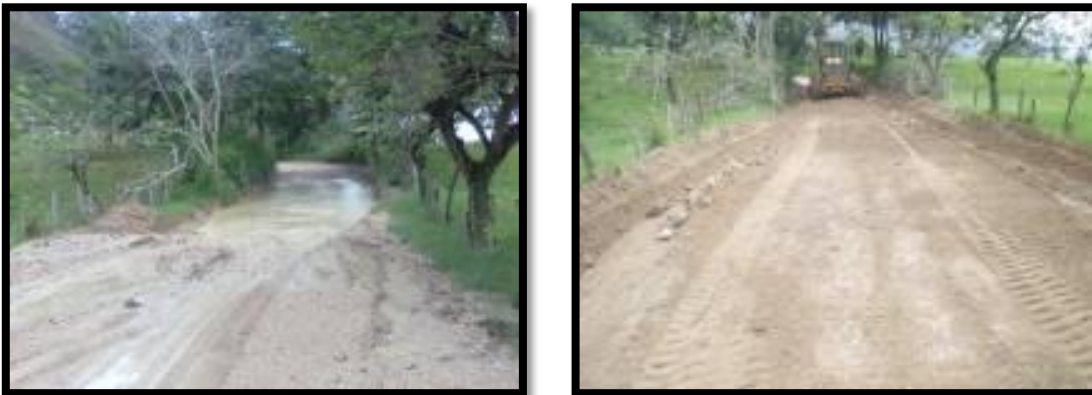
45.Fotografía -Mejoramiento de la Vía en la Vereda las Mesas-
