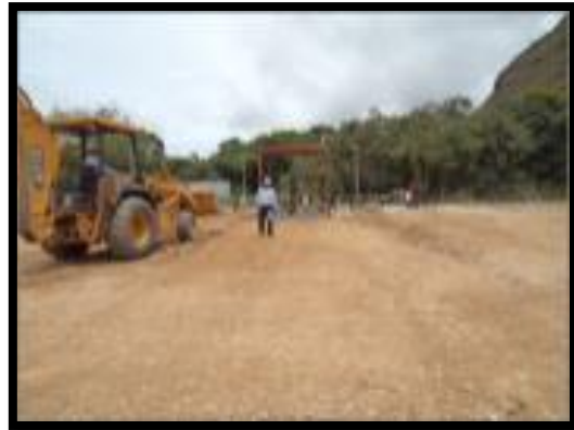
15.Fotografía -Retroexcavadora Extendiendo Material-
