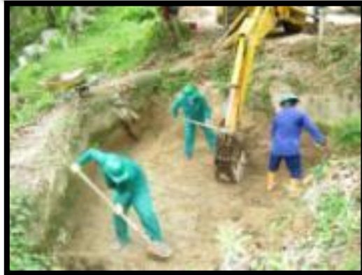
39.Fotografía -Limpieza de Alcantarilla-
