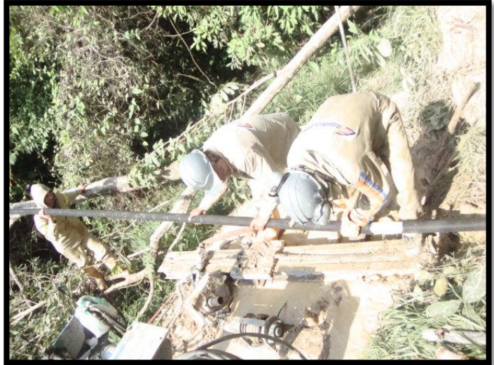
11.Fotografía -Instalación de Tubería de Desagüe de los Drenes Horizontales-
