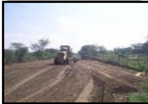
18.Fotografía -Parqueadero (Después)-
