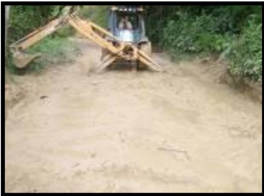
43.Fotografía -Excavación para Cajeo-
