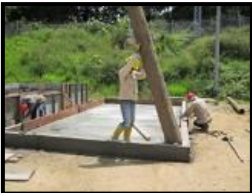
34.Fotografía -Instalación de Formaleta-
