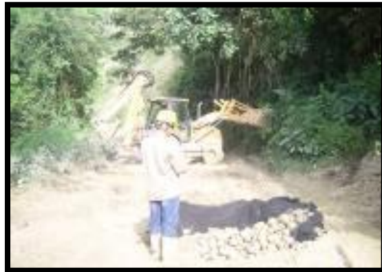
44.Fotografía -Relleno de Cajeo con Piedra-
