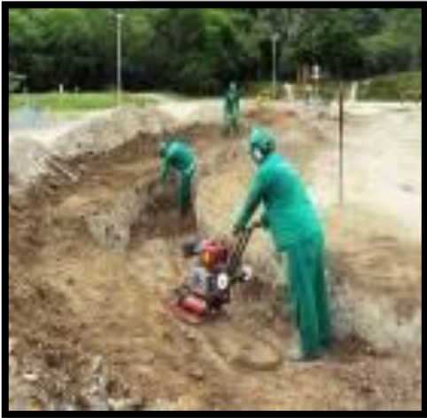
25-26.Fotografías -Relleno y Compactación de Zanjas-
