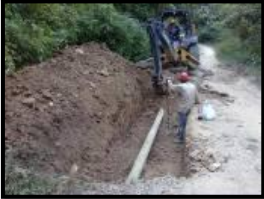
26.Fotografía -Apique y Exposición de Líneas-
