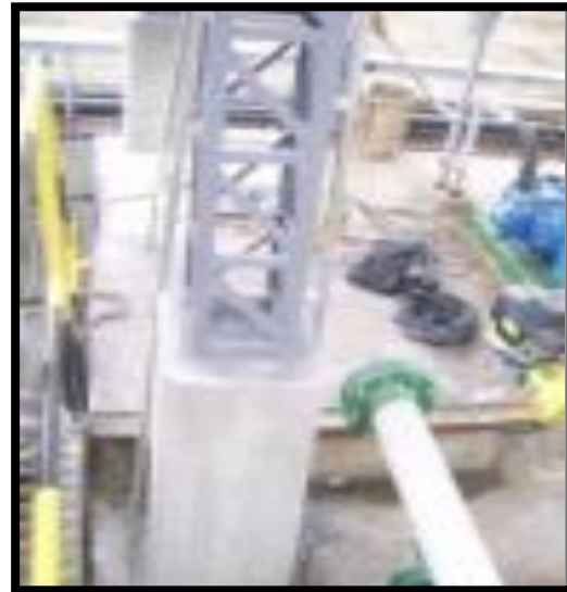
22.Fotografía -Estructura Metálica (Después)-
