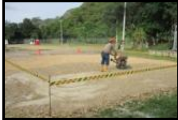
24.Fotografía -Compactación con Rana-
