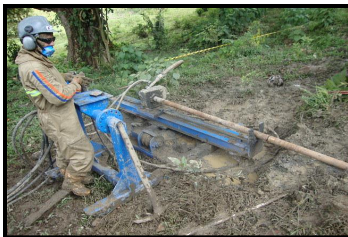
9.Fotografía -Equipo Hidráulico Perforando-
