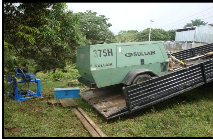
8.Fotografía -Equipo de Perforación-
