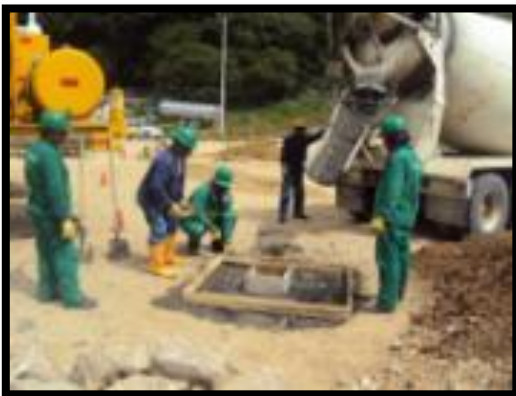
32.Fotografía -Vaciado de Concreto-
