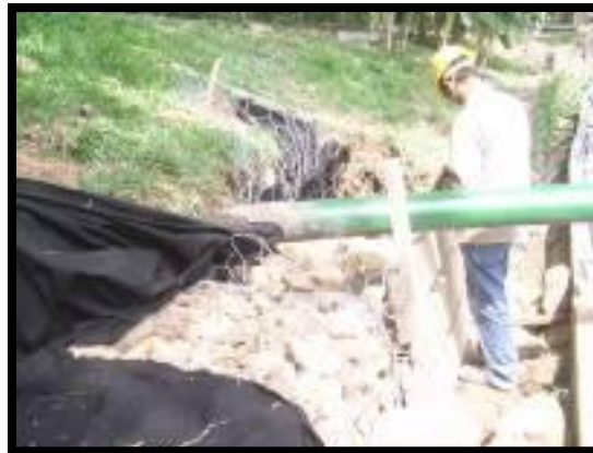
16.Fotografía -Reparación de Gaviones-
