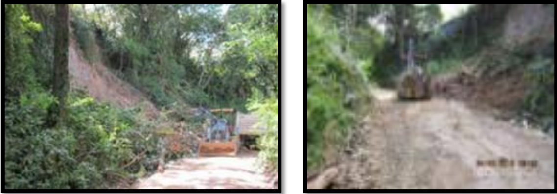
55.Fotografía -Remoción de Derrumbe en la Vereda El Hurón (24-10-2012)-
