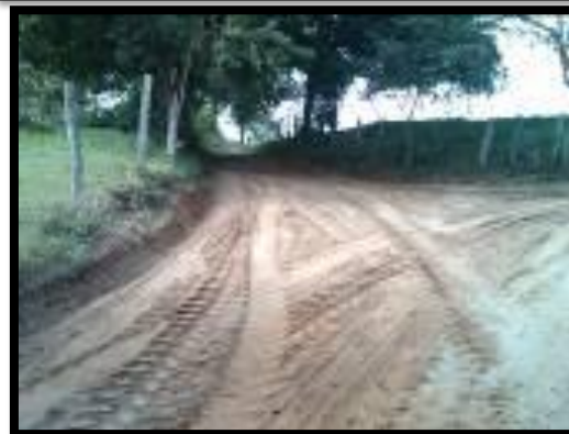
41.Fotografía -Cruce Vereda Madroño (Después)-
