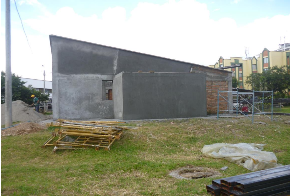
Fachada lateral de el laboratorio
