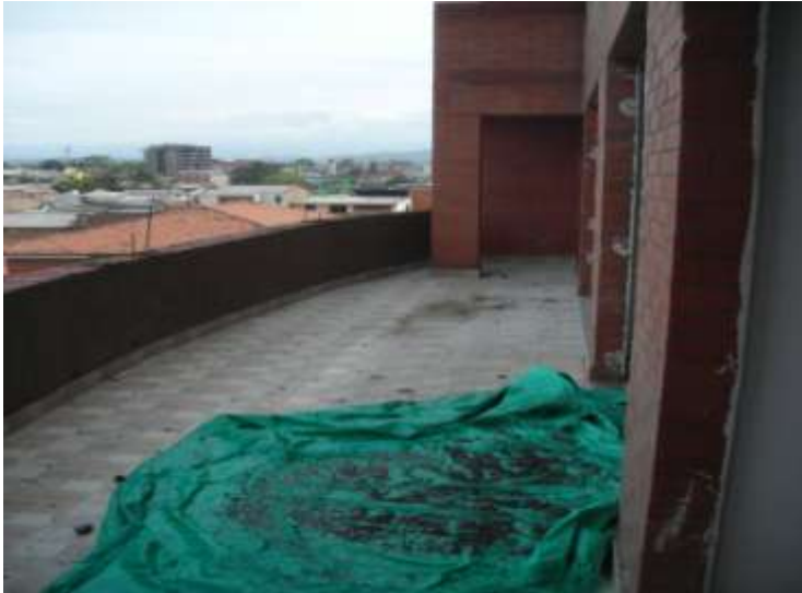
Fotografía 1. Repello de rotondas (balcones de los pent-house)
