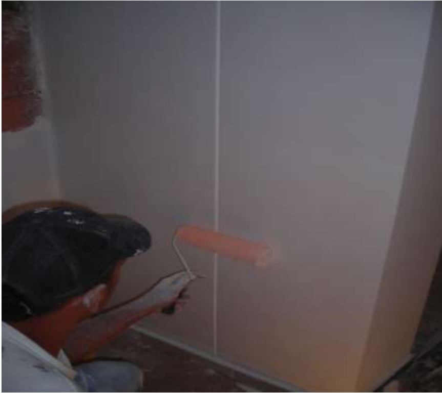
Fotografía 15. Pintura de muros 2° mano (Contratista Ricardo Idrobo)
