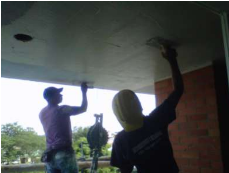
Fotografía 10. Aplicación de Graniplast en el cielo de los balcones del 7° piso
