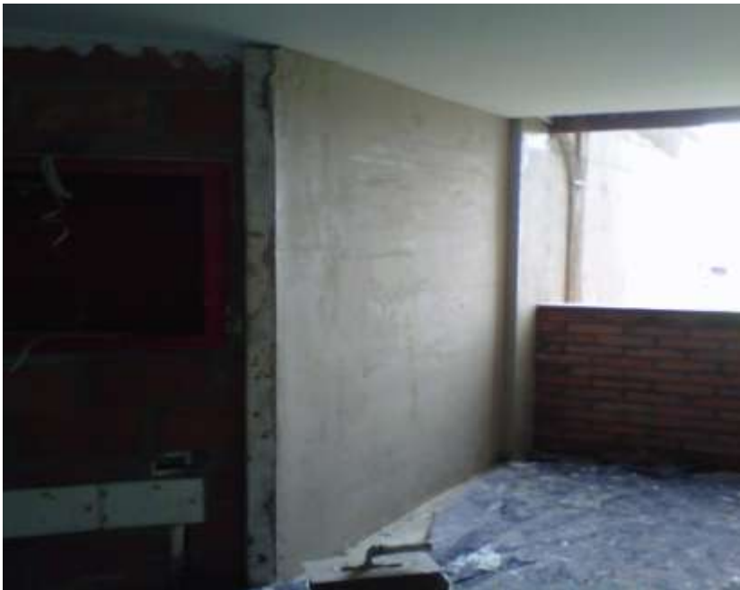
Fotografía 7. Relleno acrílico 8º piso
