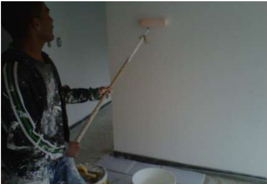
Fotografía 16. Pintura de muros 3° mano (Contratista Ricardo Idrobo)
