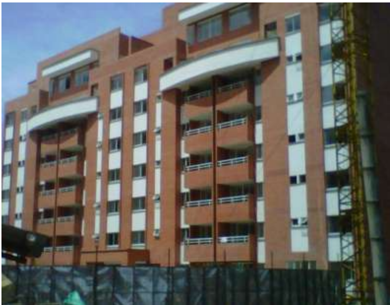
Fotografía 9. Fachada principal con la ejecución total de Graniplast
