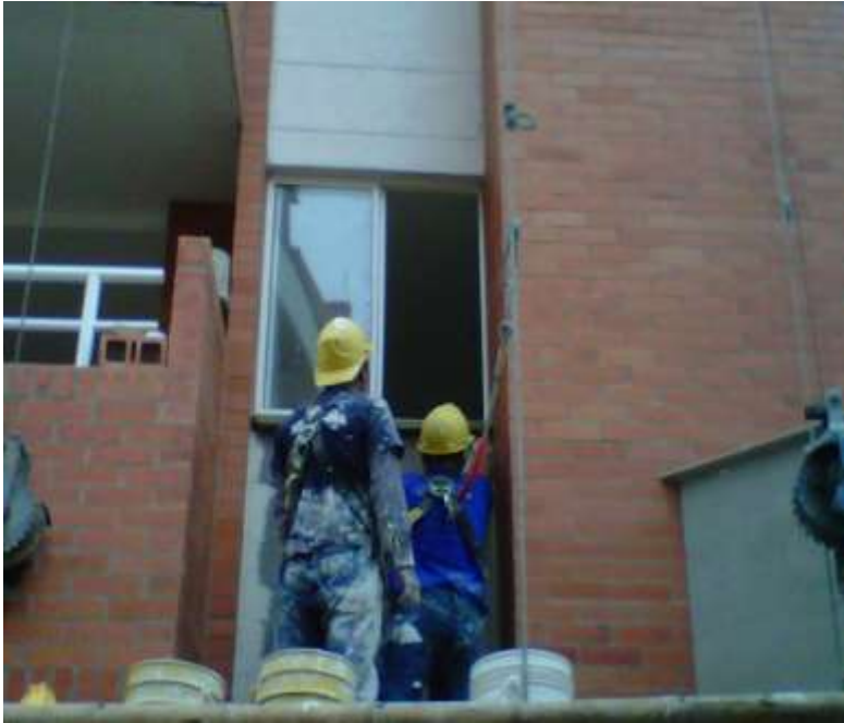
Fotografía 8. Aplicación de Graniplast en fachada principal de la Torre A
