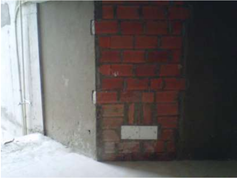
Fotografía 6. Relleno acrílico 7º piso
