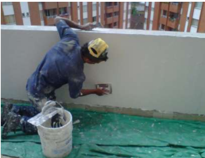
Fotografía 11. Aplicación de Graniplast en balcones del 7° piso, parte interna
