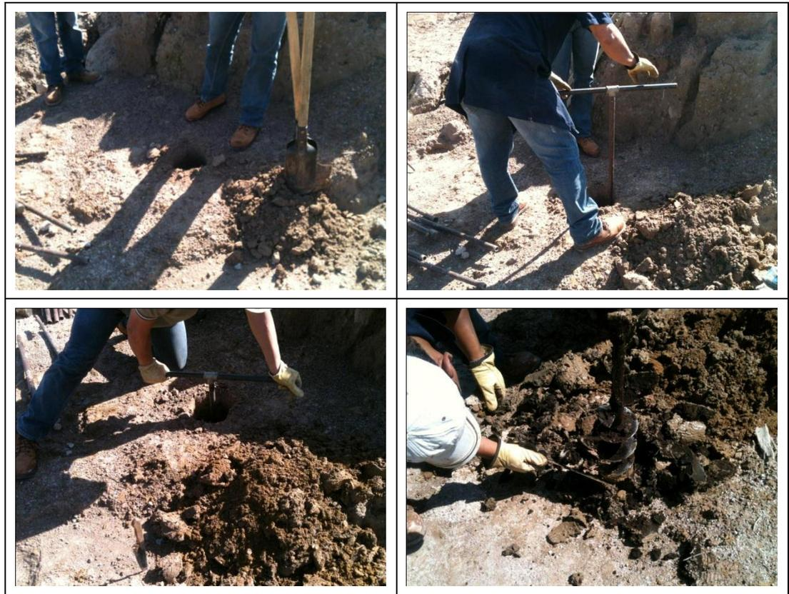
**Figura 3. 6** Perforación con equipo manual
