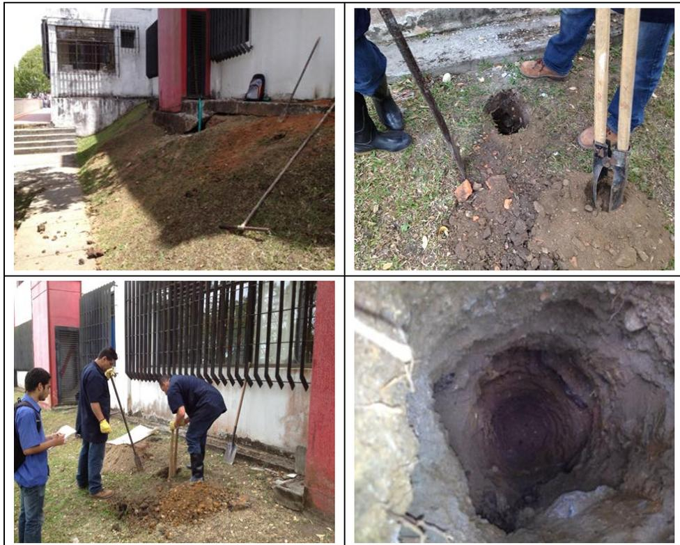
**Figura 1. 8** Perforación con equipo manual
