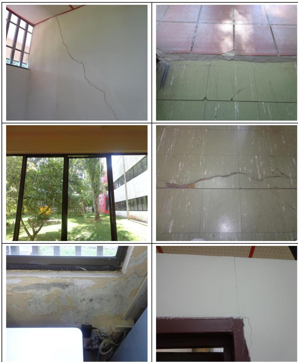
**Figura 1. 3** Grietas en paredes y pisos
