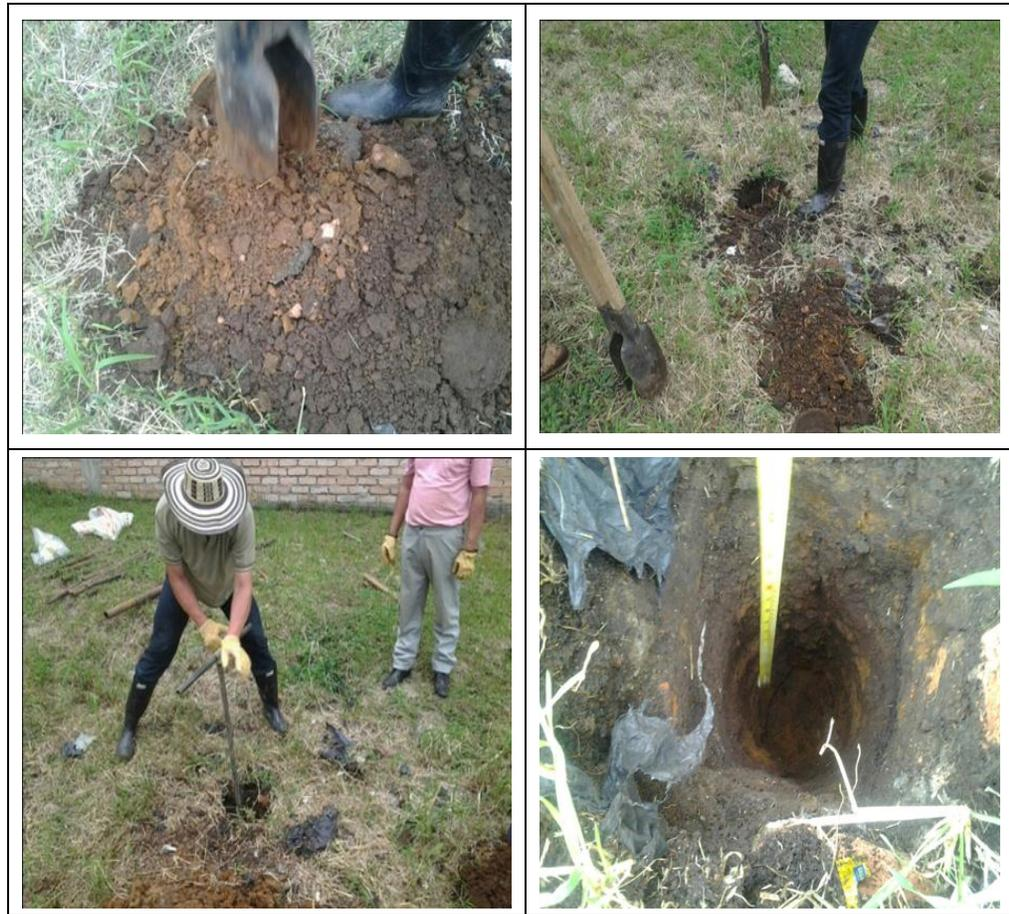
**Figura 2. 2** Perforación con equipo manual
