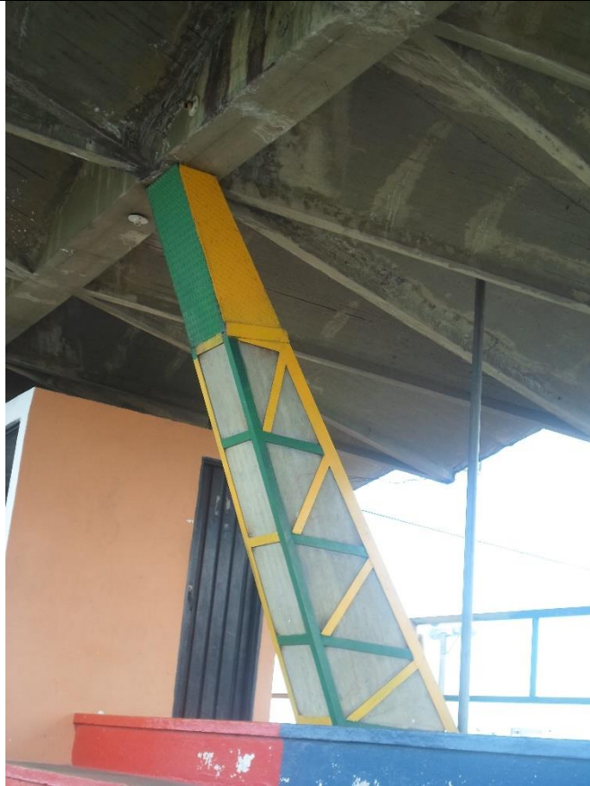
REFORZAMIENTO CON ÁNGULOS AL PÓRTECO Y SISTEMA CABLE-TUBO
