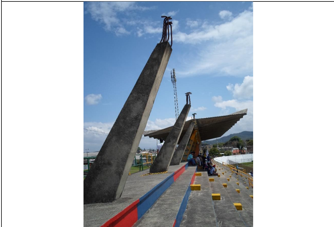
CUBIERTA EN EL MÓDULO CENTRAL(2) – ACERO DE REFUERZO COLUMNAS SUPERIORES DEL MODULO 1
