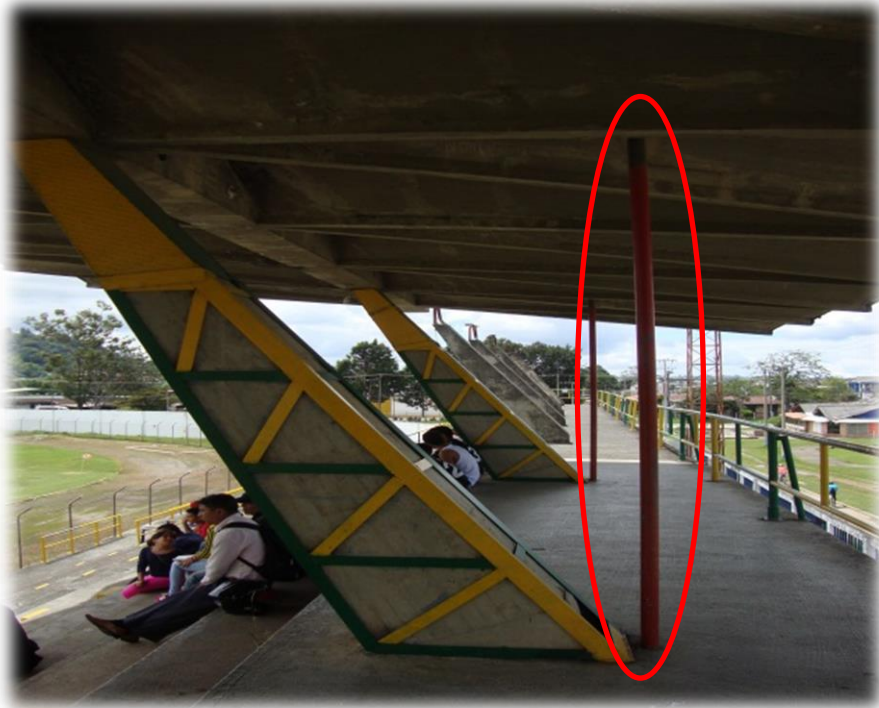
Fig. 21. Sistema cable-tubo
