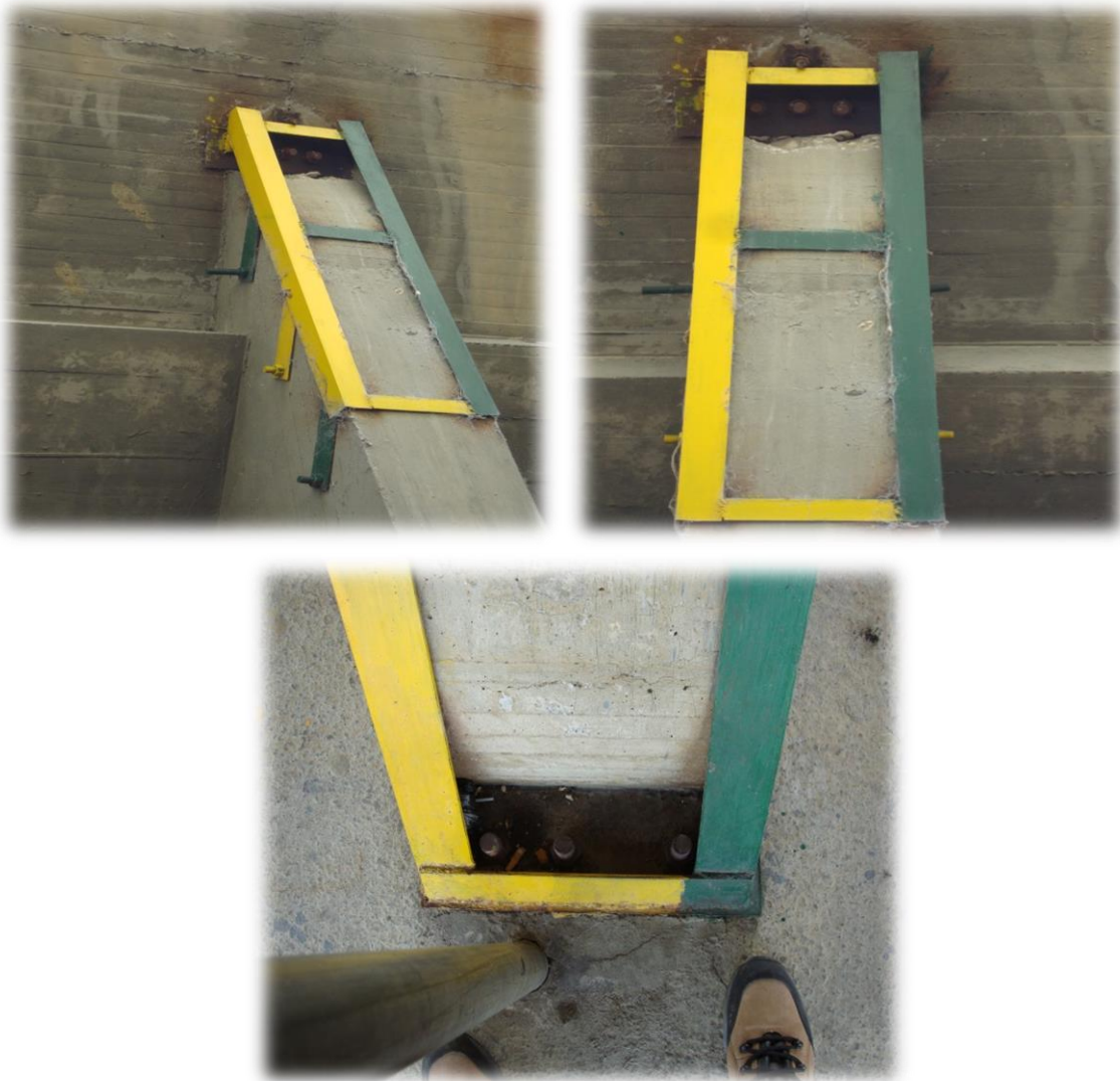
Fig. 18, 19, 20. Anclaje en la cubierta.
