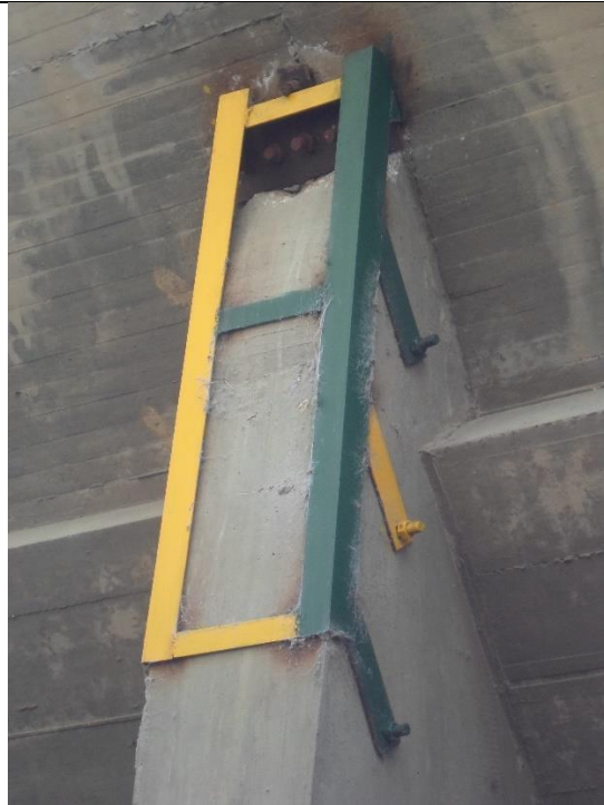
REFORZAMIENTOS CON ÁNGULOS NIVEL INFERIOR DE LA LOSA
