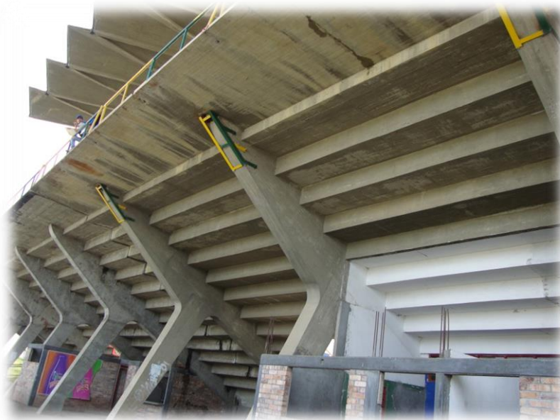
Fig. 17. Modulo central de la tribuna occidental.
