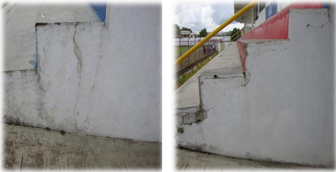
Fig. 4-5-6 Fisuras en gradería
