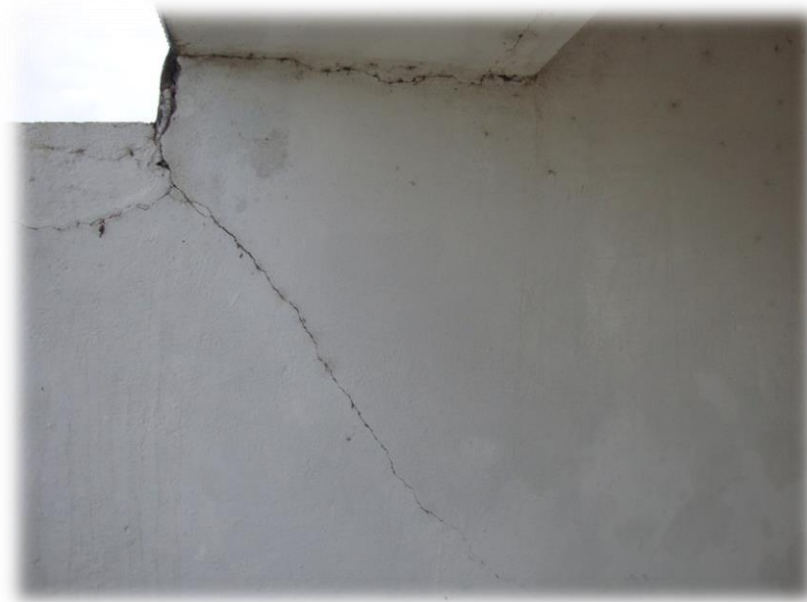
Fig. 4-5-6 Fisuras en gradería
