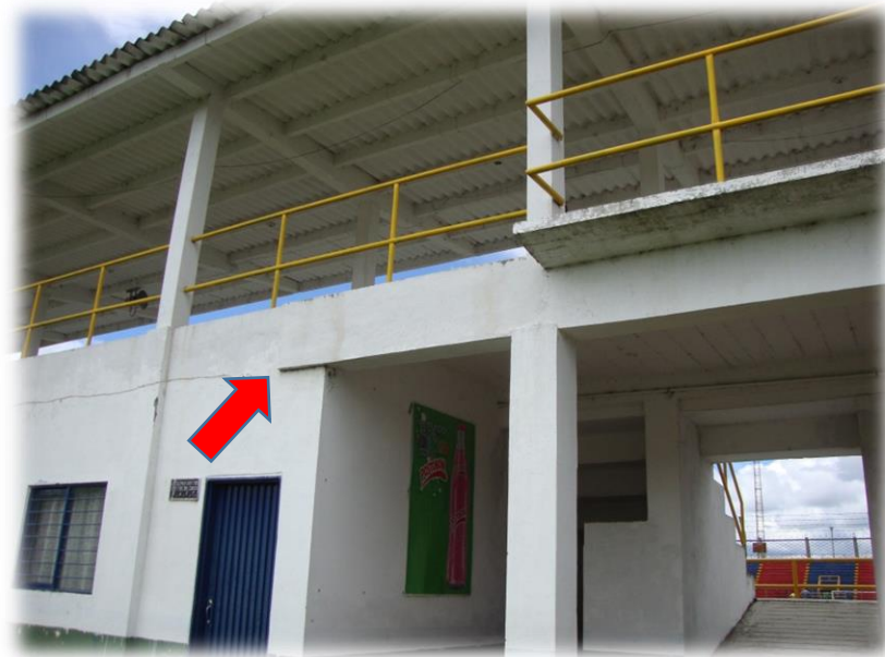
Fig. 1. Discontinuidad de viga
