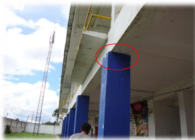
Fig. 7. Recalzado en columnas principales.
