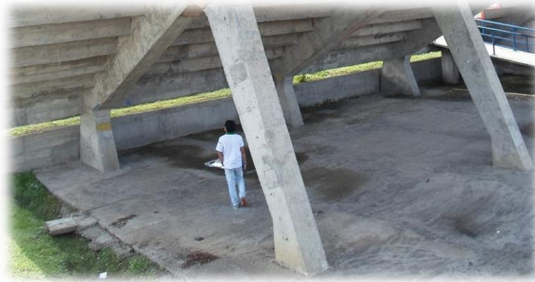
Fig. 23. Cimentación de módulo 1
