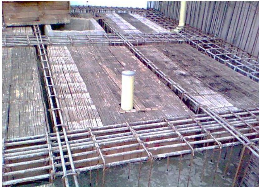
**Fotografía 51. Instalación de casetones en losa de cimentación**
