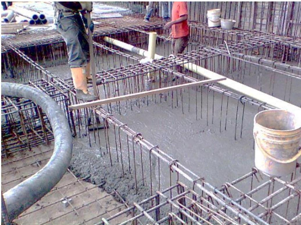
**Fotografía 15. Fundición de torta inferior de losa de cimentación.**
