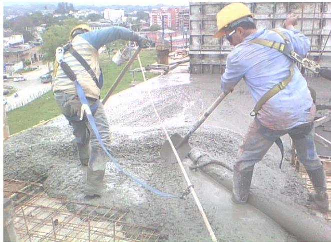
**Fotografía 13. Línea de vida para protección en trabajos de altura.**
