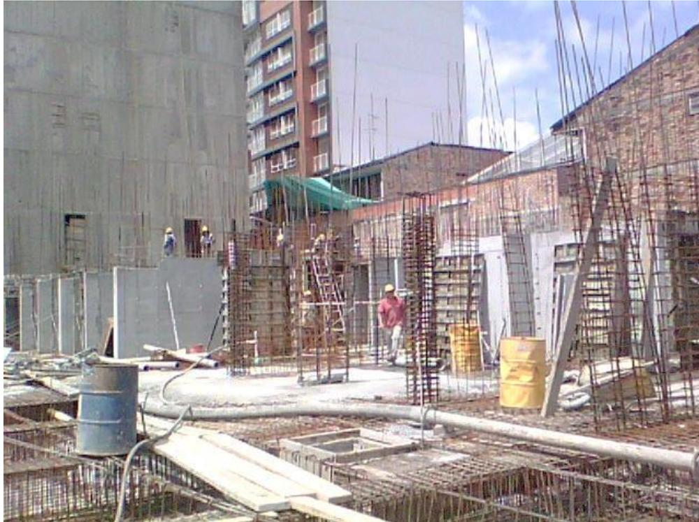
**Fotografía 54. Avance de fundiciones de pantallas de sótano**
