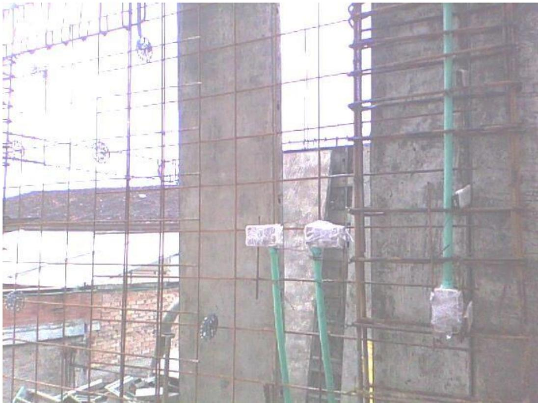
**Fotografía 22. Instalaciones eléctricas en pantalla estructural**
