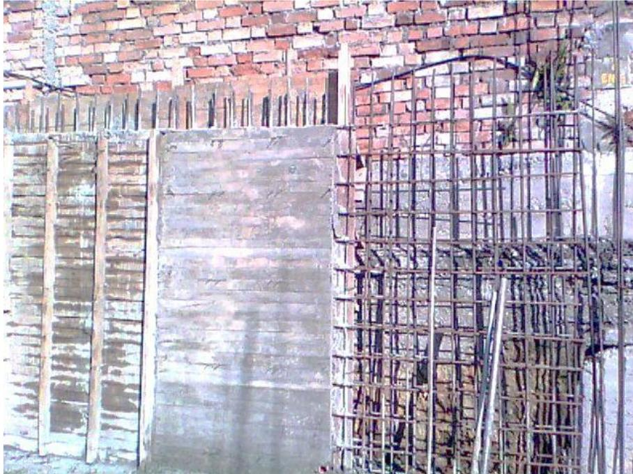
**Fotografía 55. Construcción de muro de contención**
