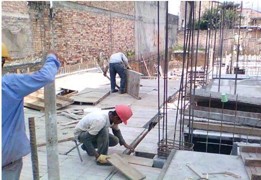
**Fotografía 63. Detalle del soporte del encofrado de la losa de semisótano.**
