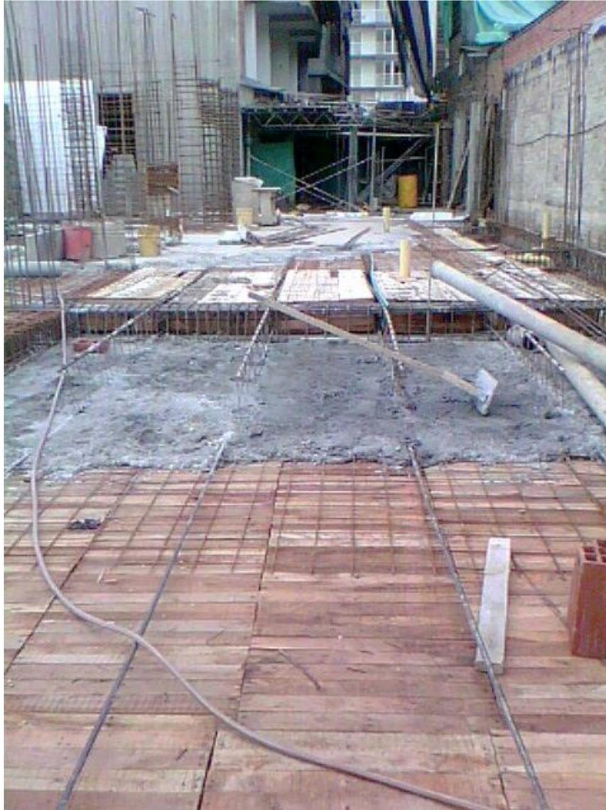
**Fotografía 67. Tramo fundido de losa aligerada de semisótano**
