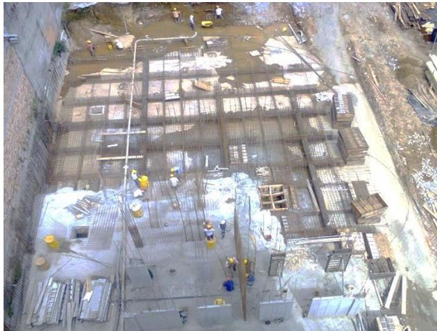
**Fotografía 31. Avance del proceso constructivo de losa de cimentación, vista aérea**
