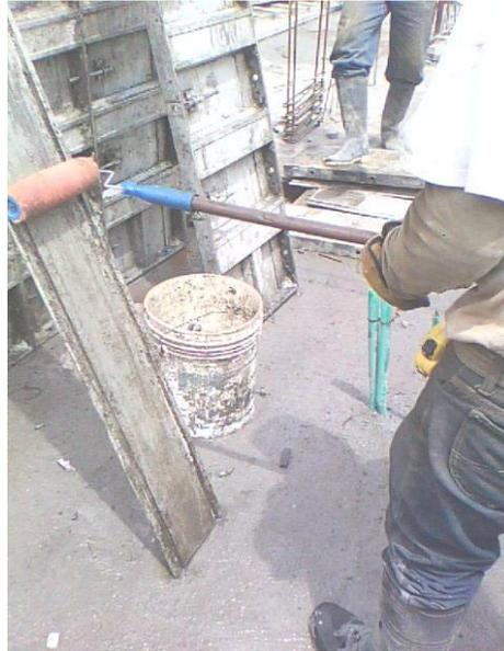
**Fotografía 32. Lubricación con ACPM de la formaleta de muros.**
