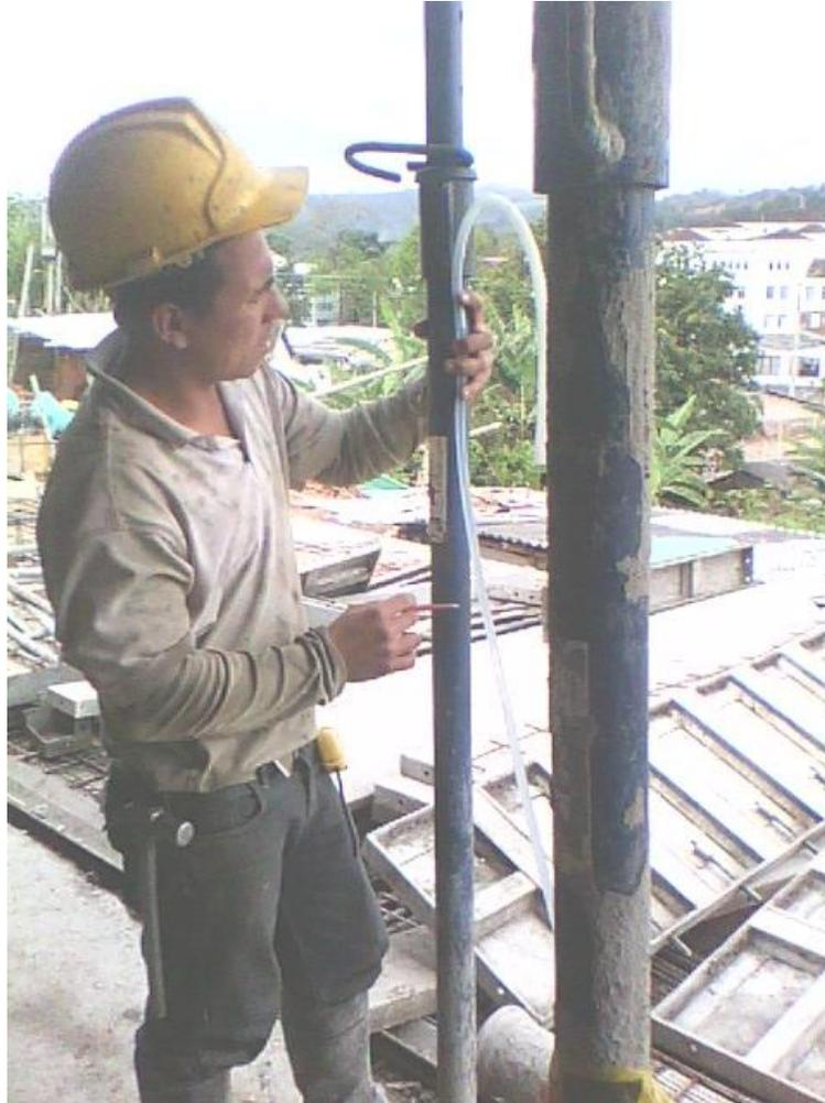
**Fotografía 40. Revisión de niveles de losa**
