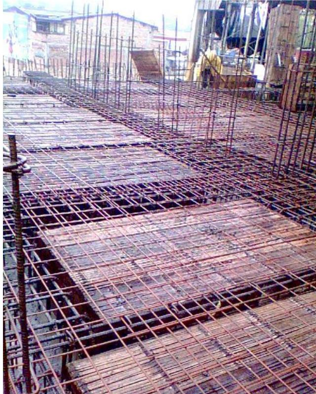
**Fotografía 6. Distribución malla superior losa de cimentación.**
