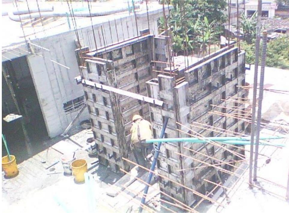
**Fotografía 91. Encofrado de pantallas de ascensor**
