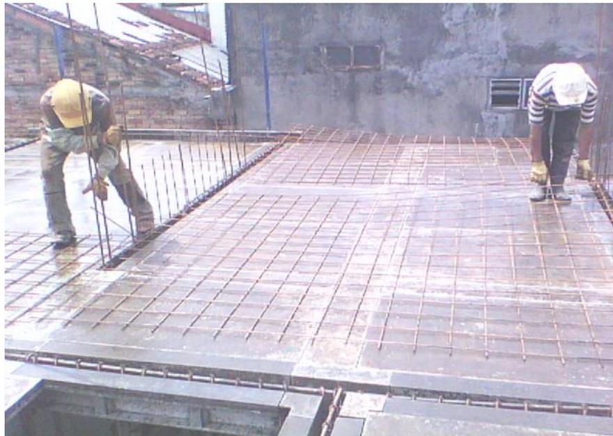
**Fotografía 7. Instalación del acero inferior de la losa del piso 2**
