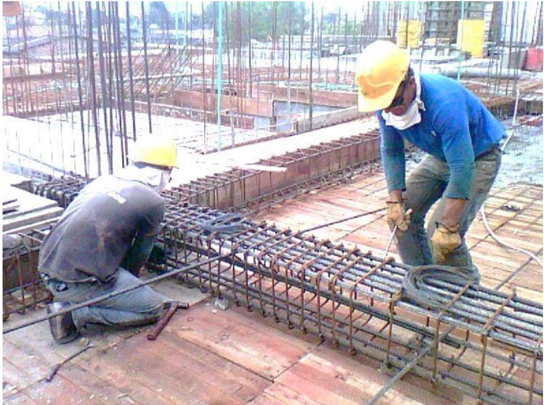
**Fotografía 64. Amarre de viga E, losa de semisótano**
