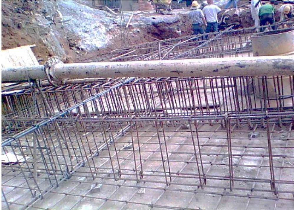
**Fotografía 5. Parrilla de acero inferior de la losa de cimentación**
