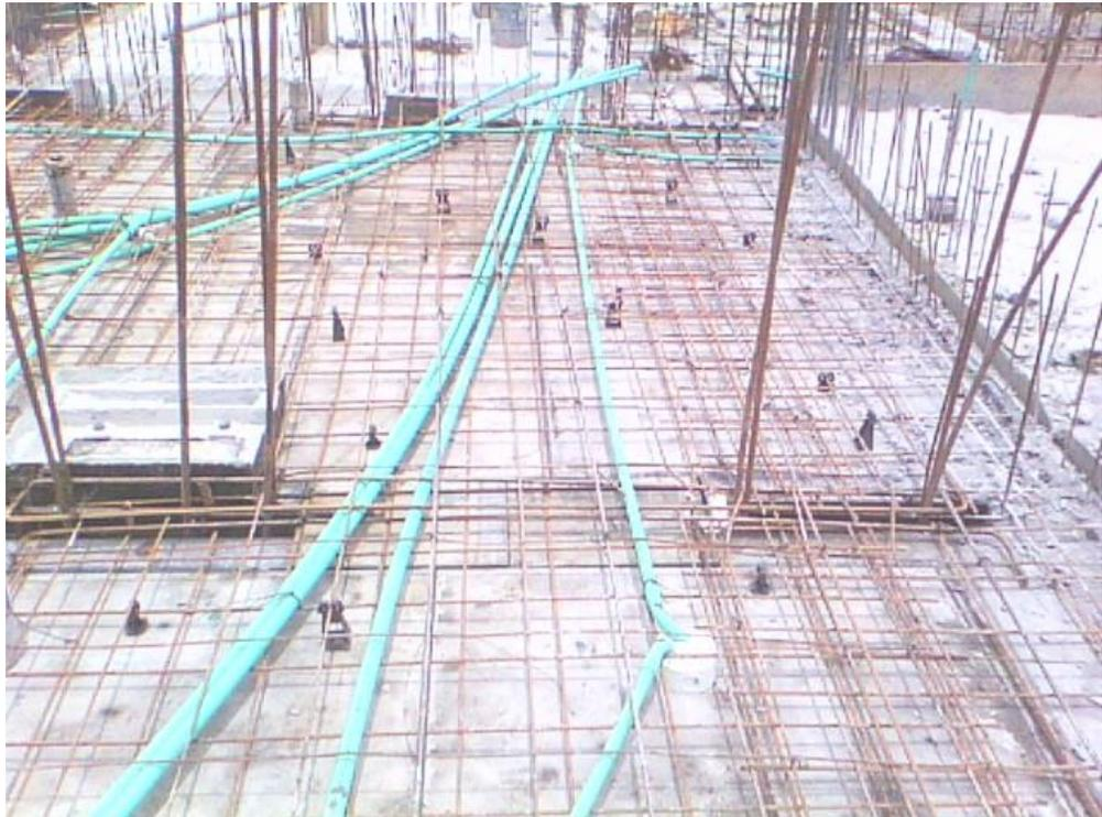
**Fotografía 8. Instalación de separadores de malla de losa**
