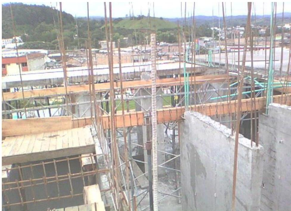
**Fotografía 92. Inicio de encofrado de madera de los de punto fijo piso 2**
