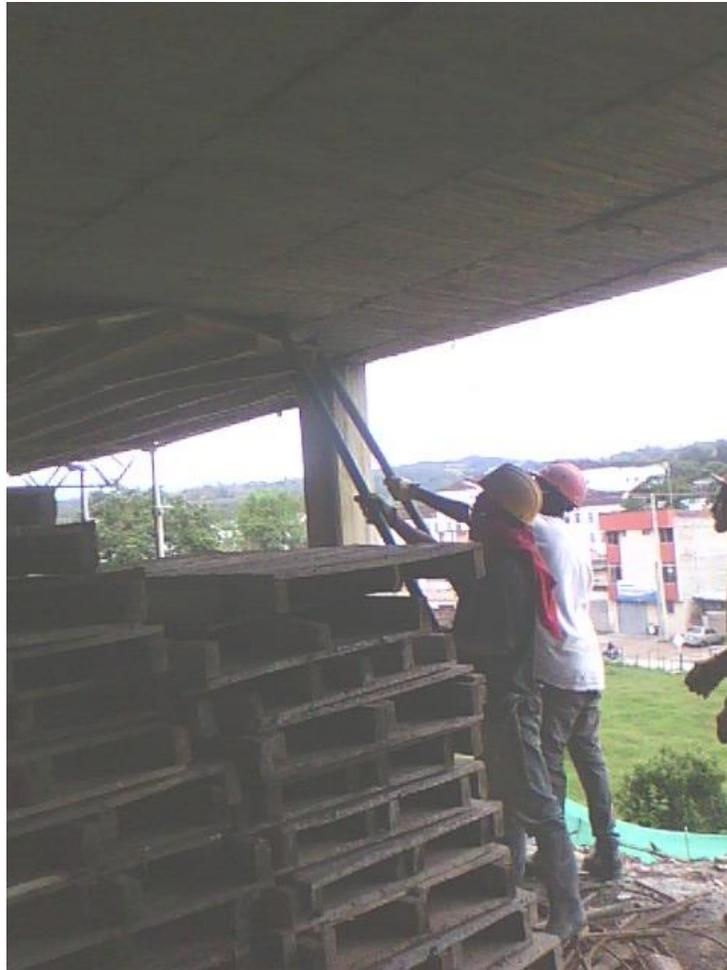
**Fotografía 27. Desencofrado de losa en el sótano de la Torre C.**
