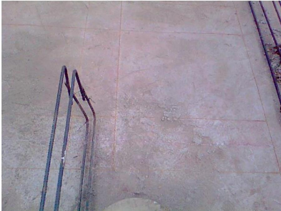
**Fotografía 45: Localización de paramentos de las vigas de cimentación**
