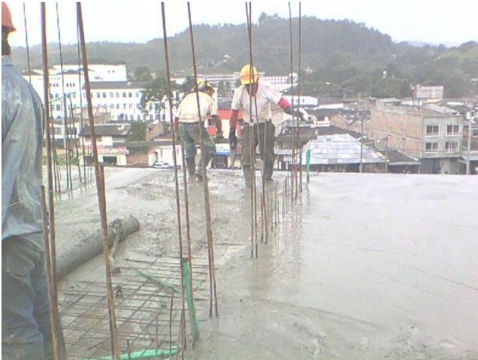
**Fotografía 81. Fundición de losa de apartamento 104.**
