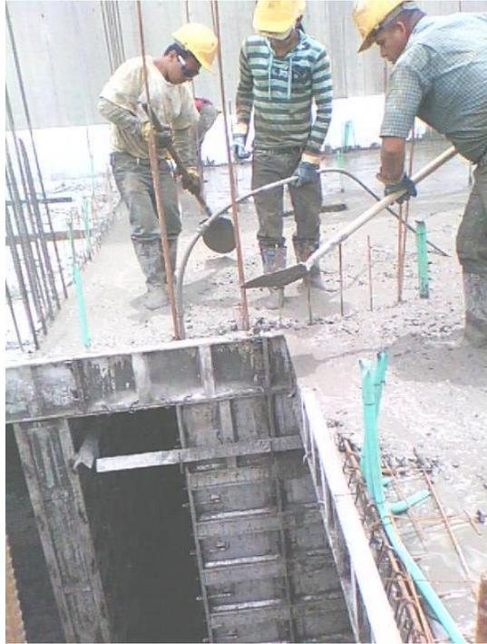
**Fotografía 20. Uso de Vibrador eléctrico en fundición de pantalla**
