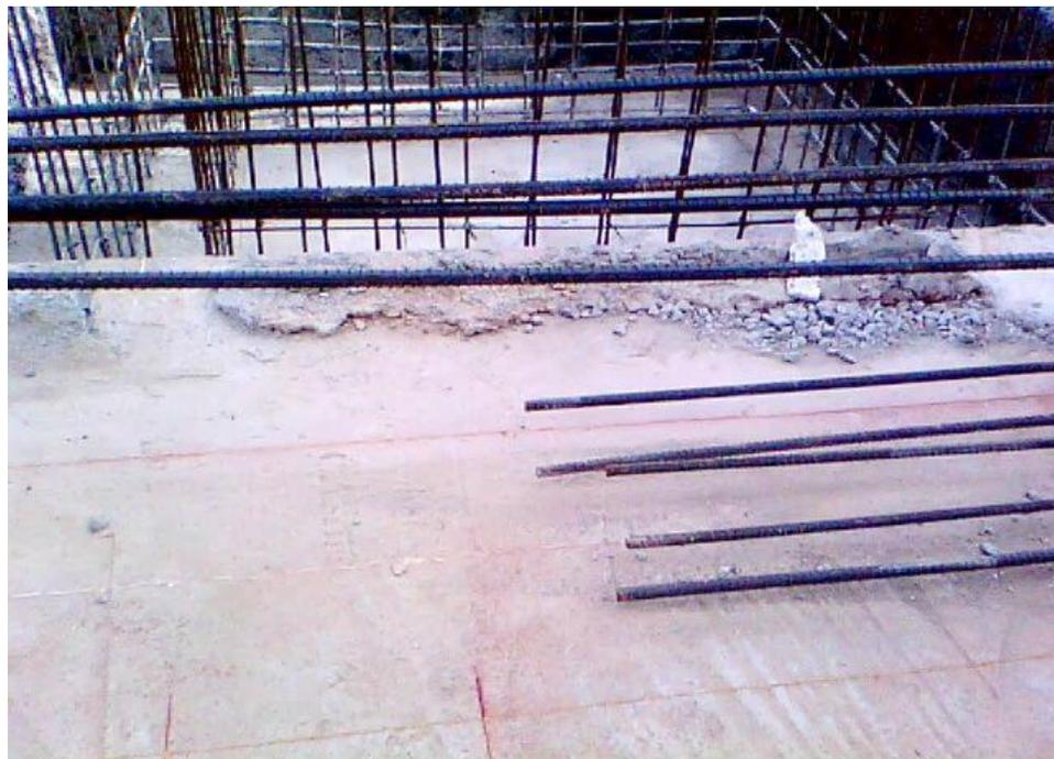
Fotografía 2. Demarcación de viga en losa de cimentación.
