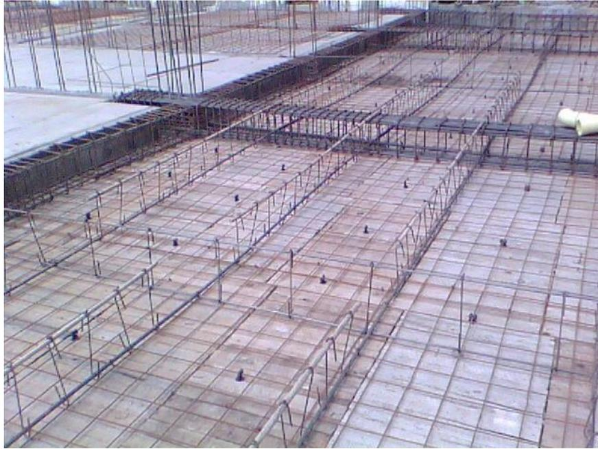
**Fotografía 65. Encofrado con madera y con forsa de losa de nivel -1.30.**
