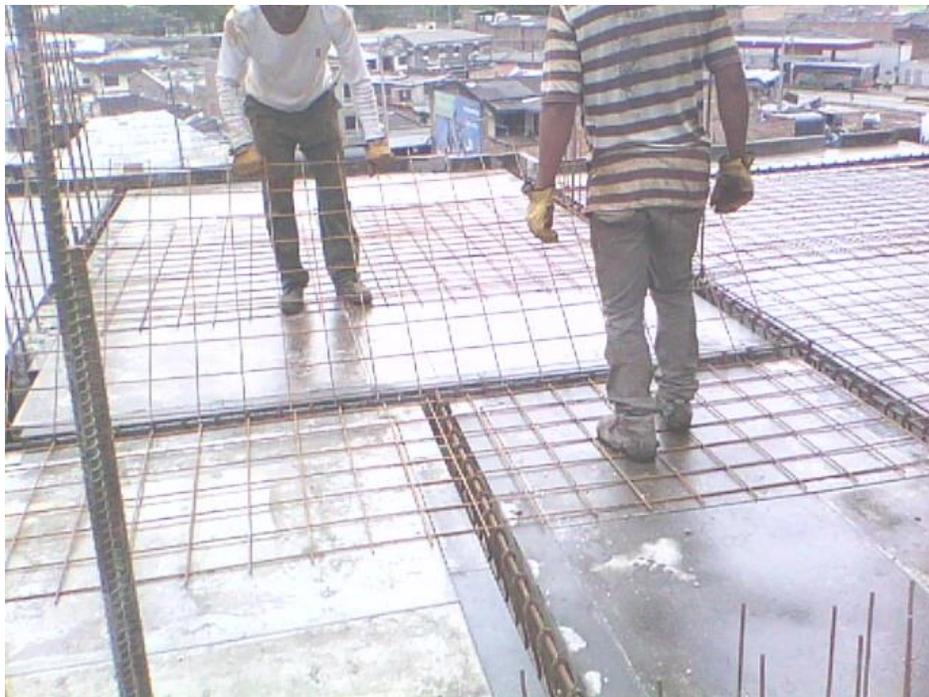
**Fotografía 77. Instalación de malla inferior de losa.**
