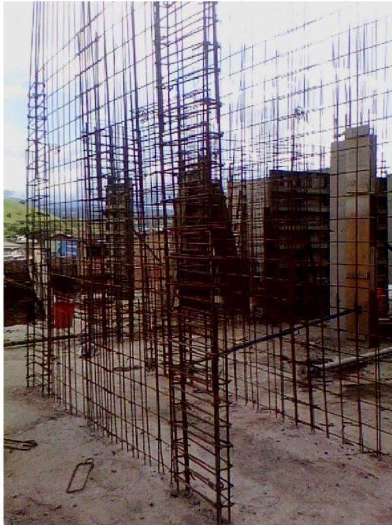
**Fotografía 53. Armado de acero de pantallas estructurales**
