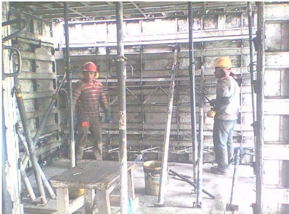
**Fotografía 37. Uso de tensores para asegurar plomos en los muros.**
