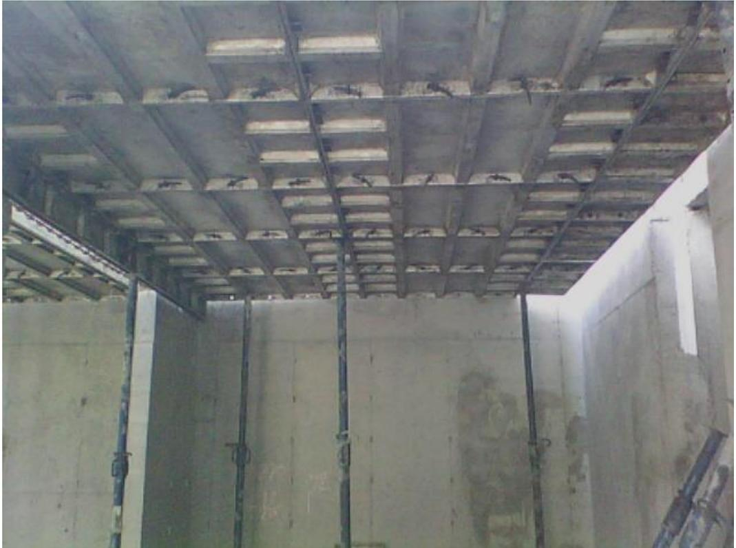
**Fotografía 61. Encofrado de losa Nivel -1.30 con forsa.**
