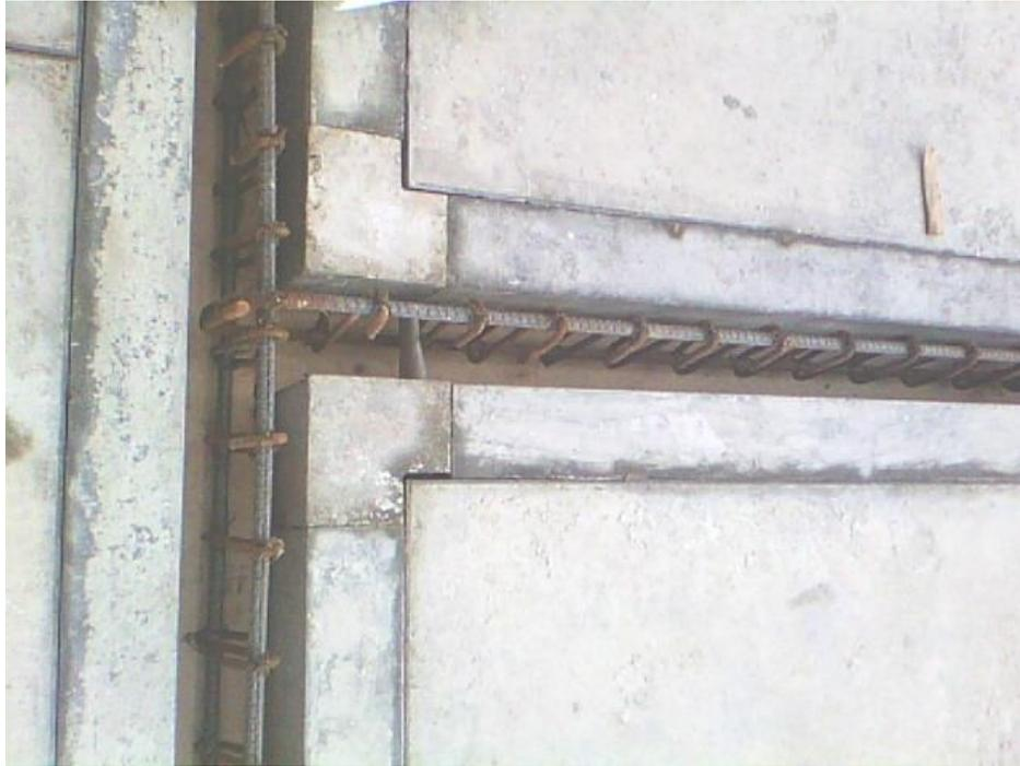
**Fotografía 76. Detalle de encofrado de dinteles con formaleta forsa.**
