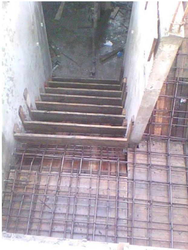
**Fotografía 70. Encofrado y refuerzo de escalera de semisótano**
