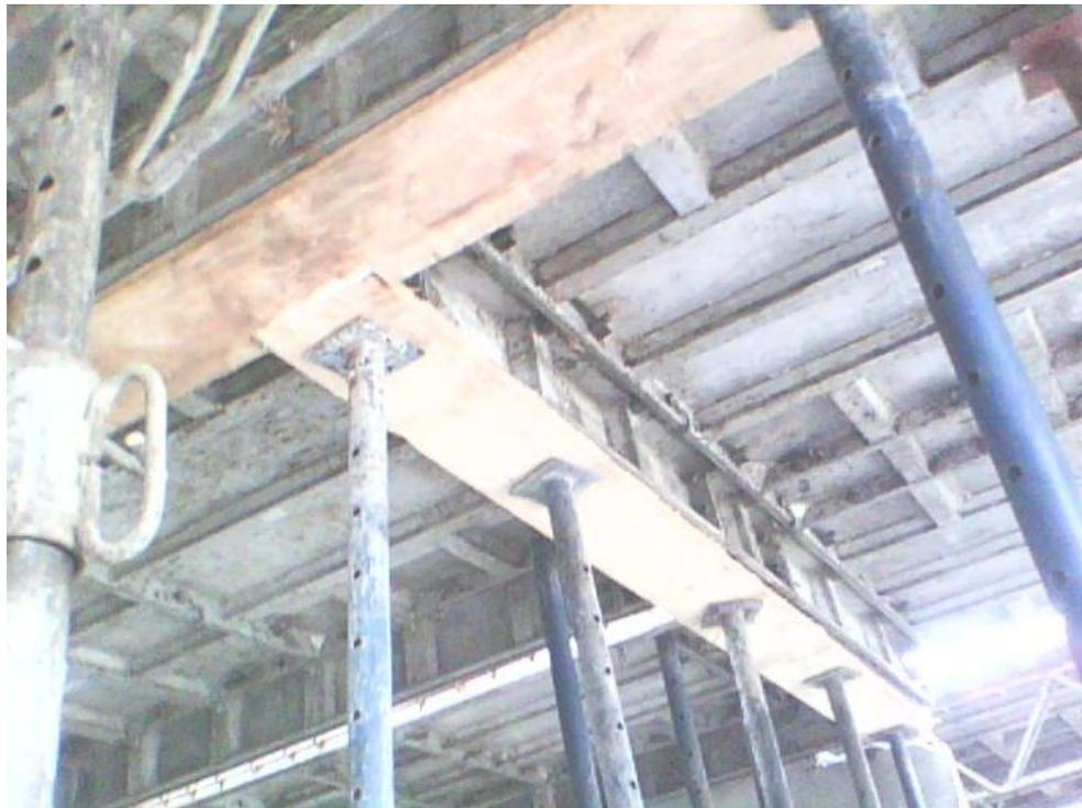
Fotografía 73. Detalle de refuerzo con tacos metálicos del encofrado de la losa.
