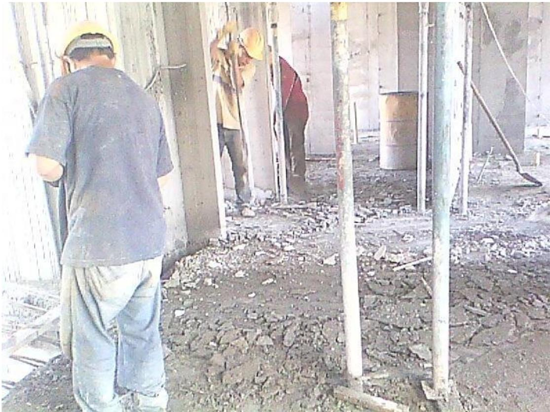
**Fotografía 25. Aseo de la estructura, retiro de desperdicios de concreto.**
