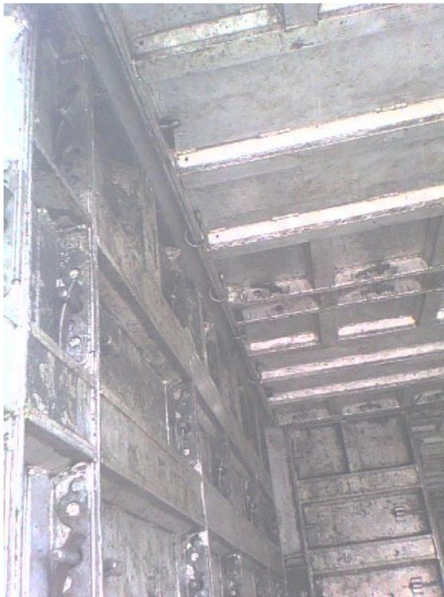
**Fotografía 38. Unión de formaleta de losa y muro mediante perfiles conectores**
