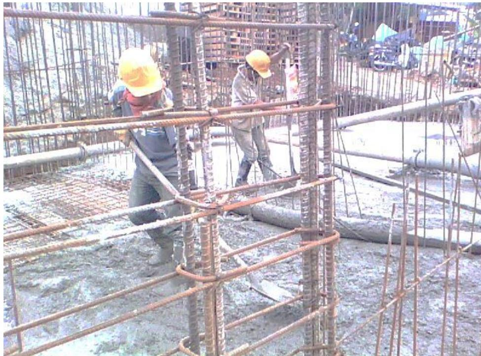
Fotografía 59. Fundición del último tramo de losa de cimentación
