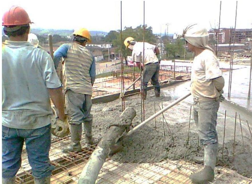
**Fotografía 66. Fundición de losa maciza a nivel de semisótano**
