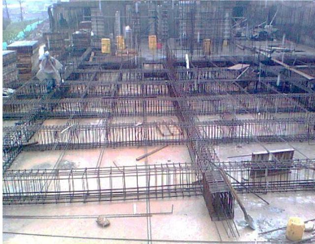
**Fotografía 30. Avance del proceso constructivo de la losa de cimentación**
