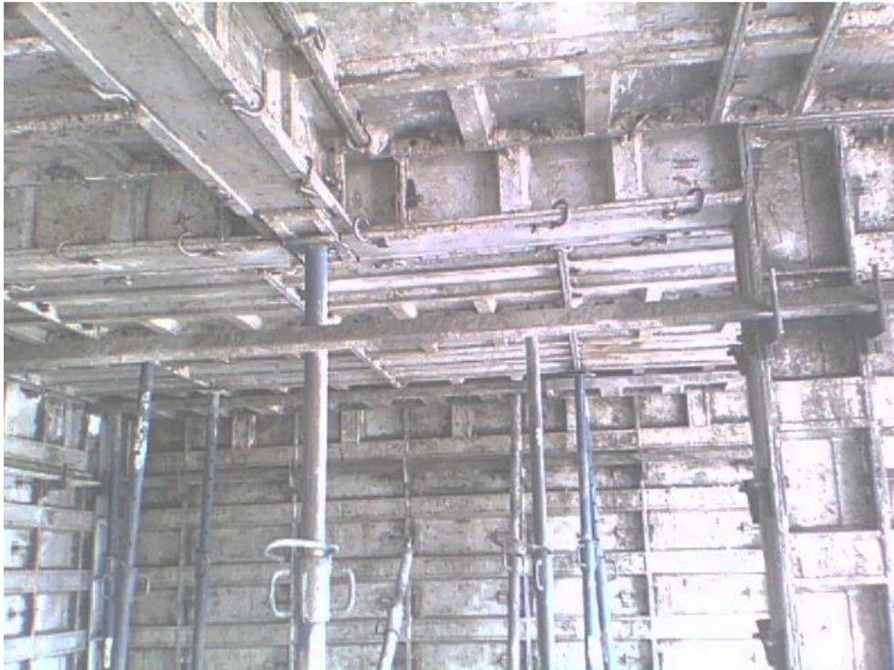
**Fotografía 39. Gato metálico soportando un losa puntal**
