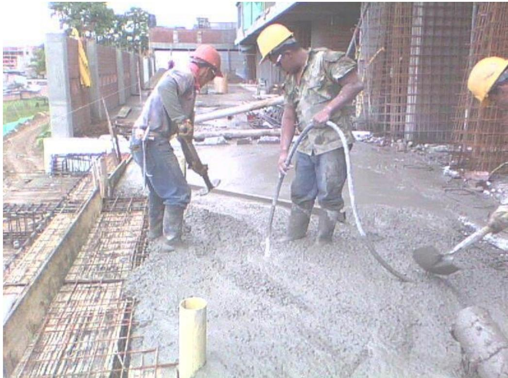
**Fotografía 17. Vibrado del concreto en losa aligerada.**
