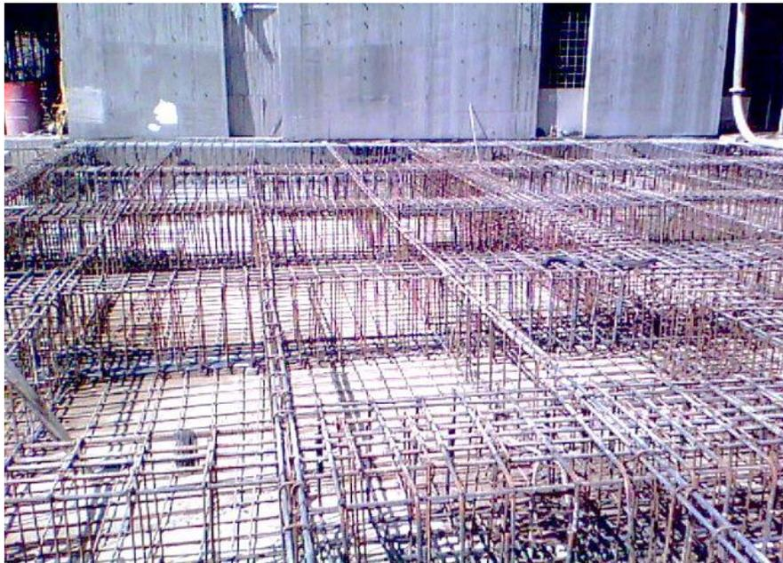
**Fotografía 47. Acero de refuerzo de losa de cimentación**
