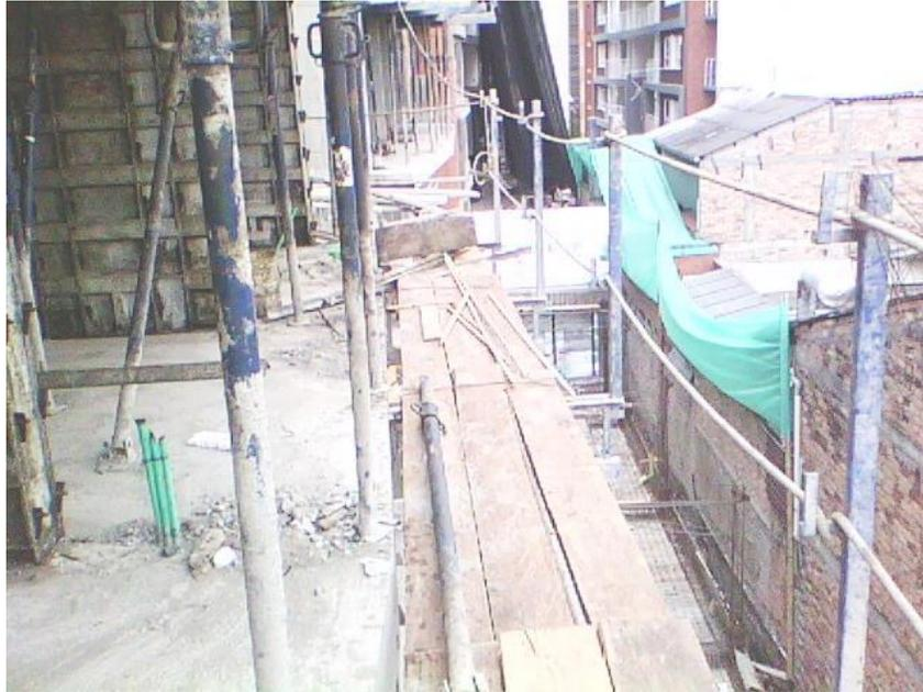
**Fotografía 88. Ensamble de palomeras y disposición de línea de vida**
