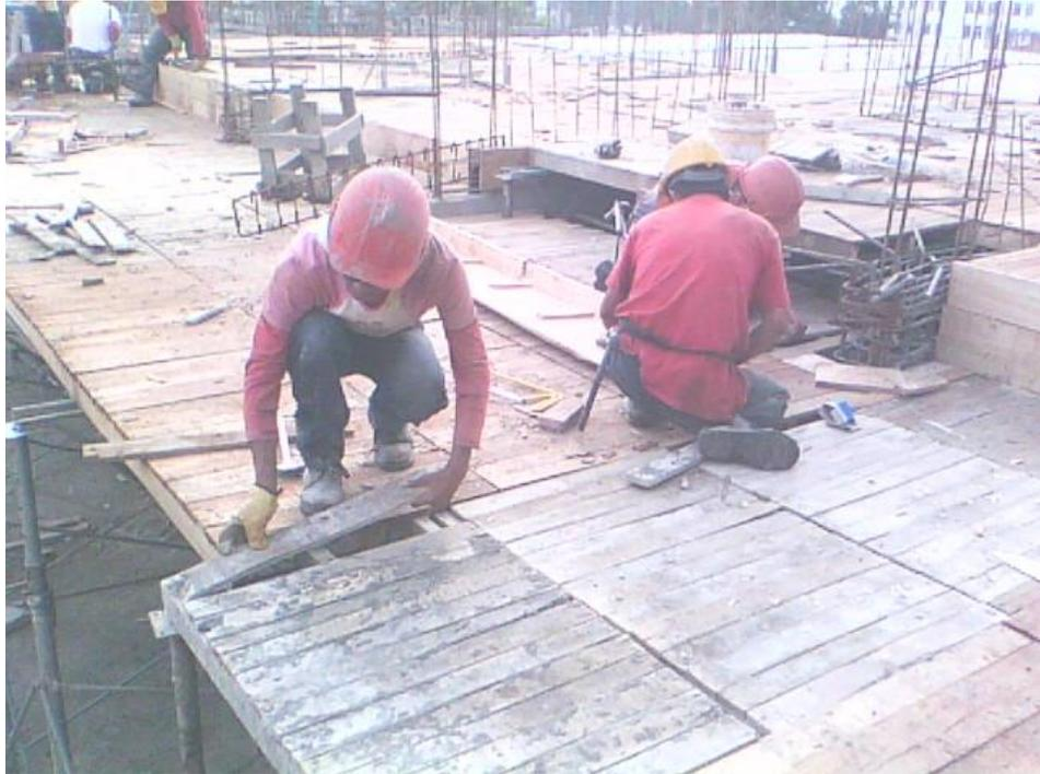
**Fotografía 74. Entablarado de losa nervada de primer piso.**
