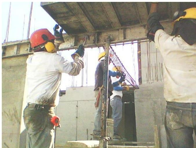
**Fotografía 14. Uso de orejeras para el armado de forsa.**
