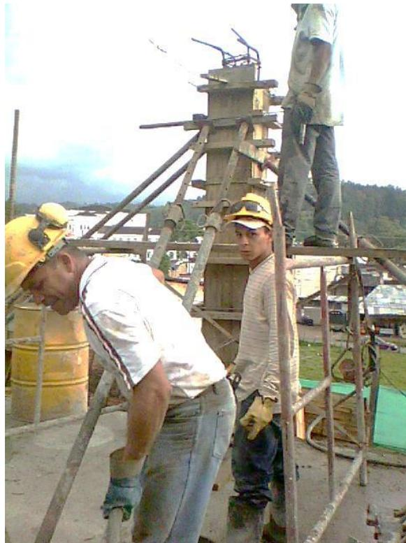
**Fotografía 56. Fundición de una columna para apoyo de losa de semisótano**
