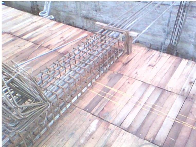
**Fotografía 83. Tramo encofrado para plazoleta de primer piso**
