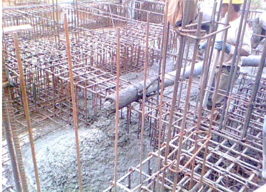
**Fotografía 50. Fundición de torta inferior en losa de cimentación**
