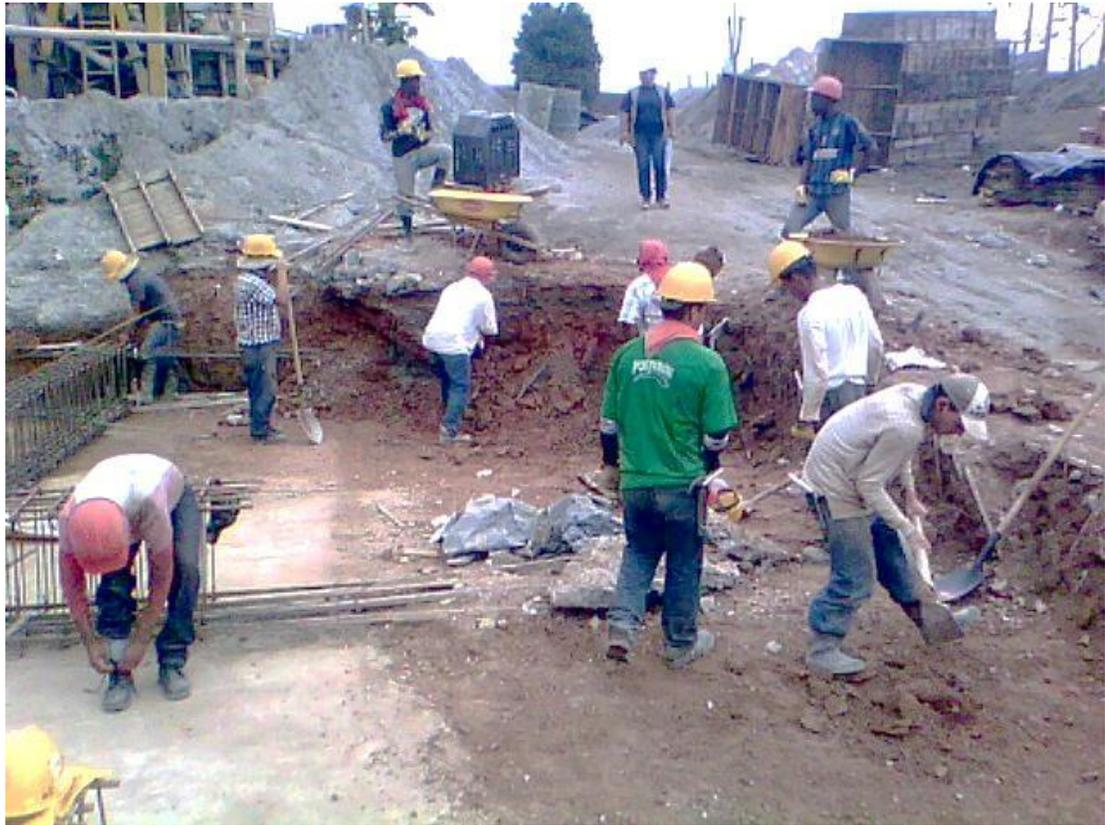
**Fotografía 57. Excavación a nivel de losa de cimentación**
