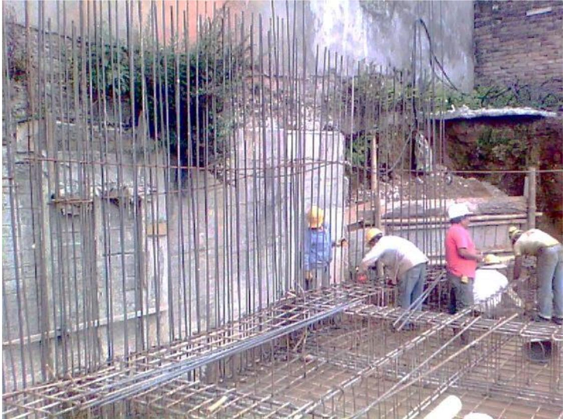
**Fotografía 49. Instalación de acero de muro de contención**
