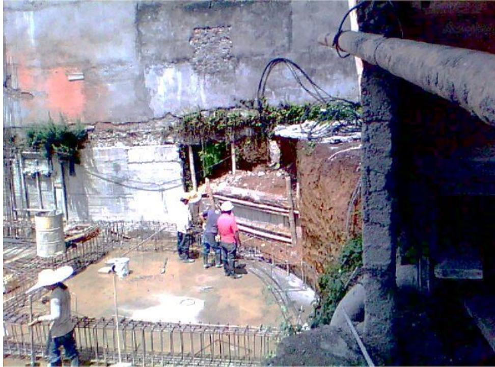
Fotografía 58. Localización y amarre de viga de cimentación en curva
