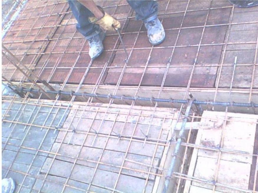
Fotografía 78. Detalle de refuerzo de grafiles de malla inferior de losa.
