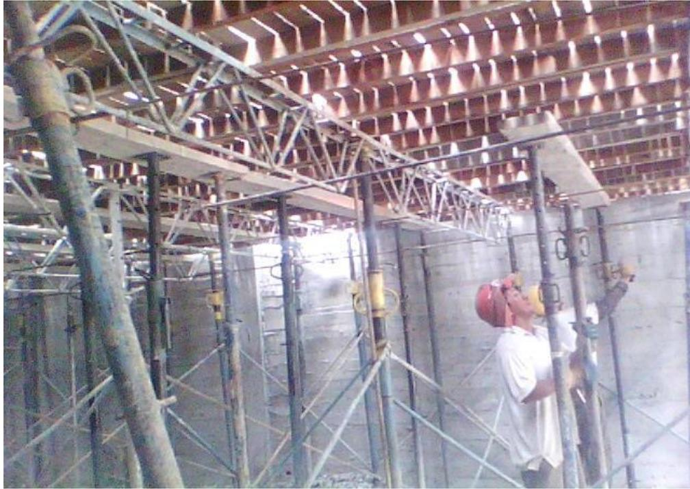
**Fotografía 62. Instalación de tableros para encofrado de losa de semisótano.**
