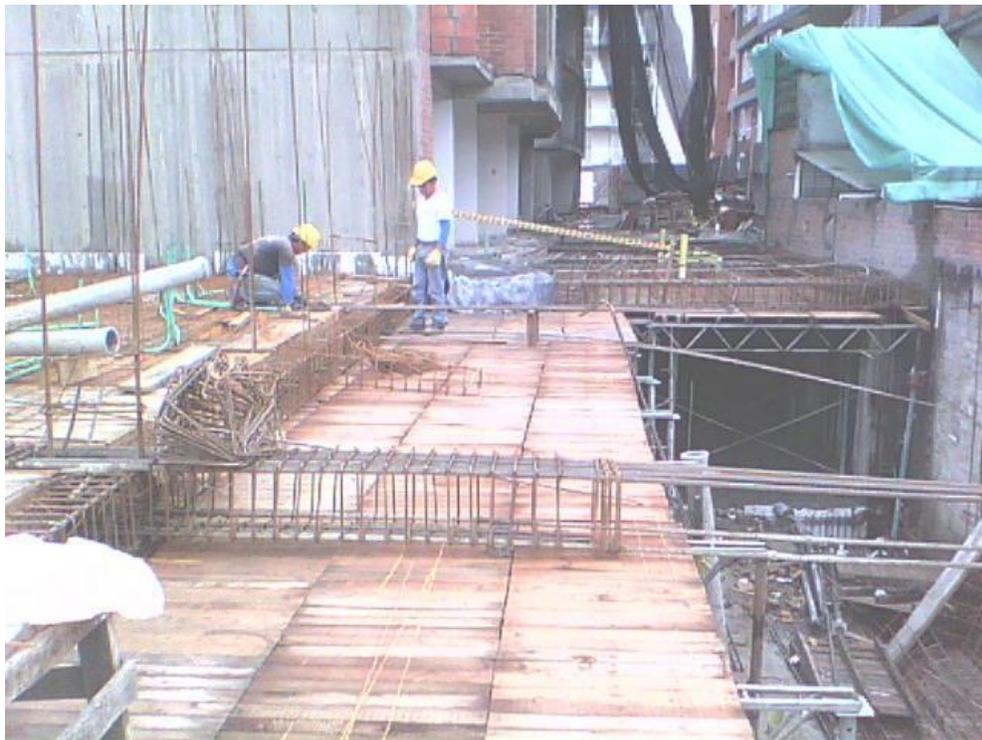
**Fotografía 42. Intersección de losa de apartamentos con losa de plazoletas**
