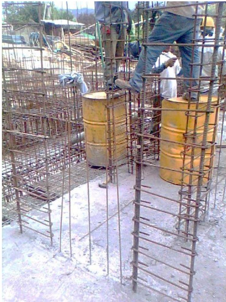
**Fotografía 52. Cortes de fundición en losa de cimentación**
