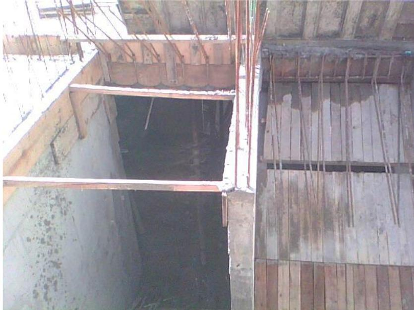
**Fotografía 69. Arranques de acero de escalera de semisótano**
