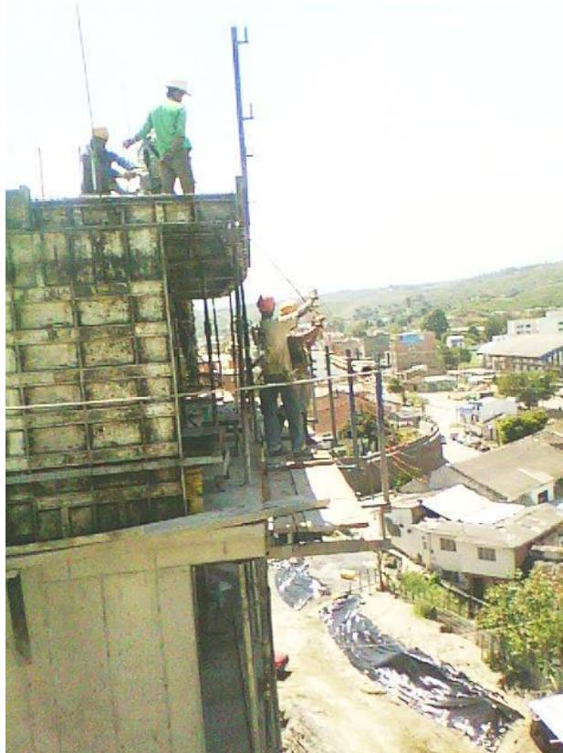
**Fotografía 89. Uso de palomeras para subir material de construcción.**
