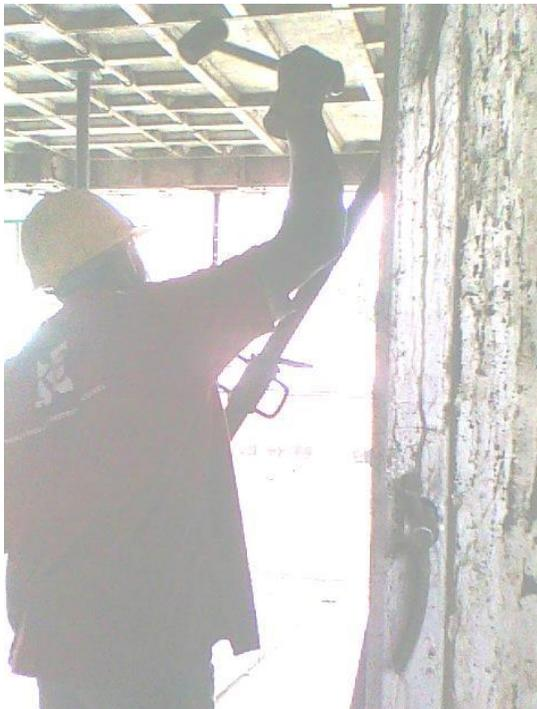
**Fotografía 21. Vibrado manual de pantalla durante la fundición**
