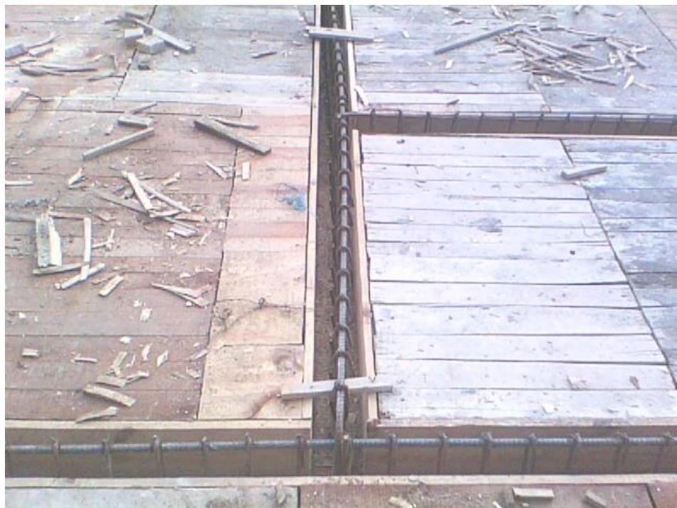
**Fotografía 75. Detalle de encofrado de dinteles con madera.**
