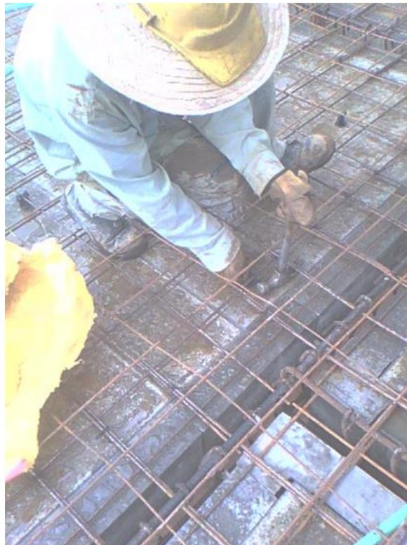
Fotografía 79. Instalación de separadores de malla
