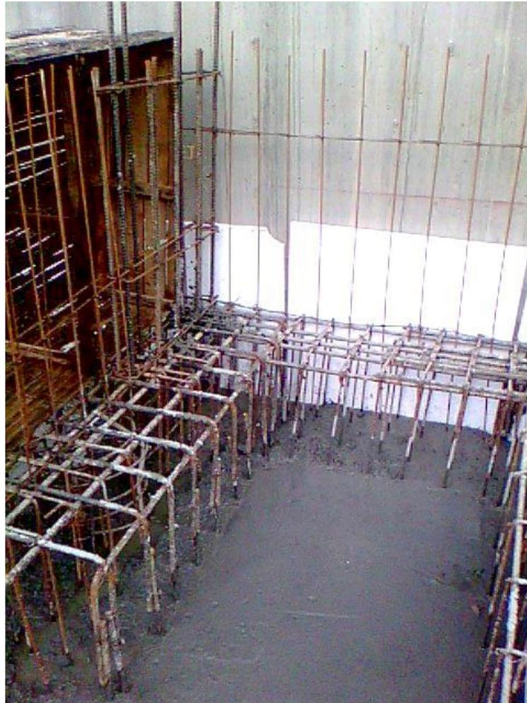
**Fotografía 48. Arranques de acero para pantallas**
