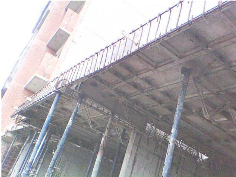
Fotografía 72. Detalle del encofrado forsa de la losa de primer piso
