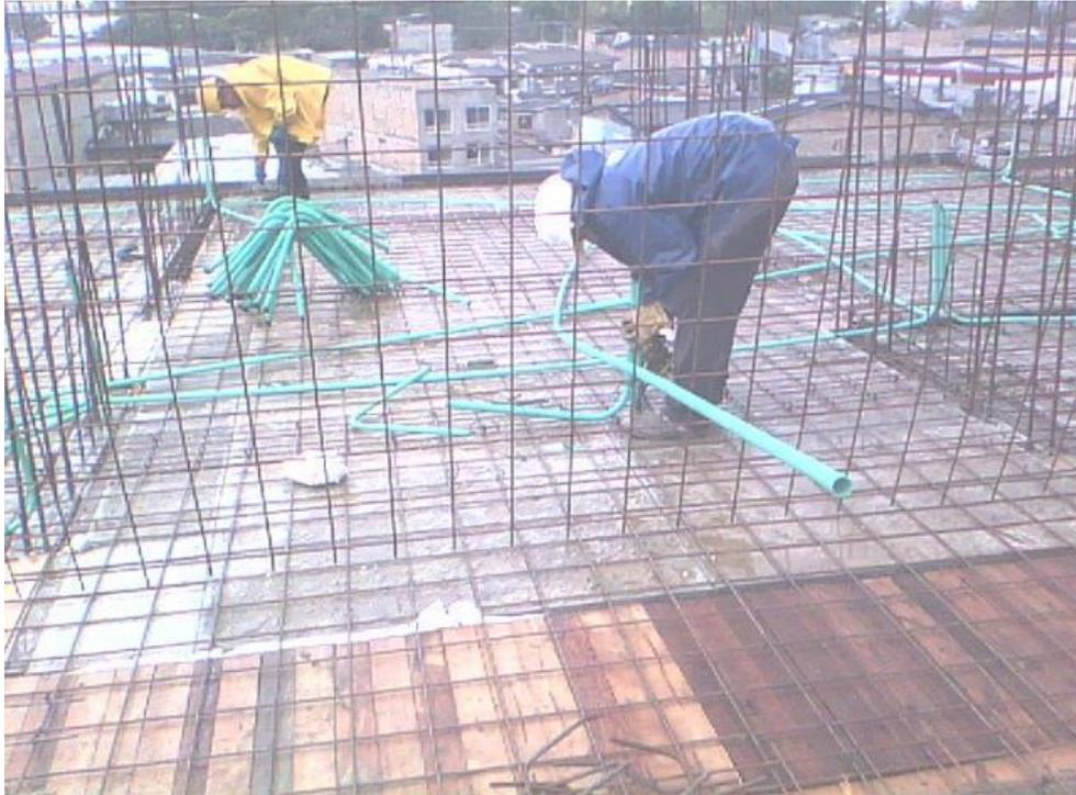
**Fotografía 80. Instalaciones eléctricas en losa de primer piso**
