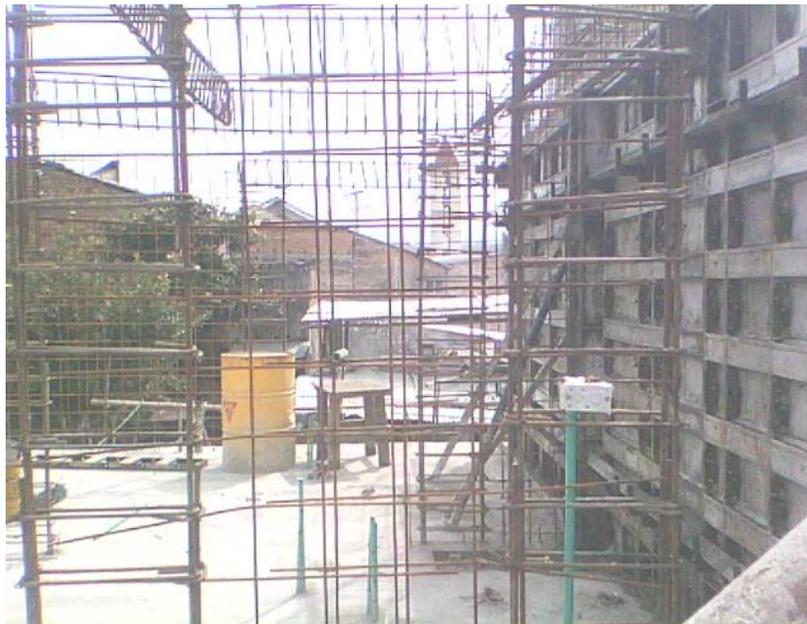
**Fotografía 29. Acero de refuerzo de una pantalla estructural.**
