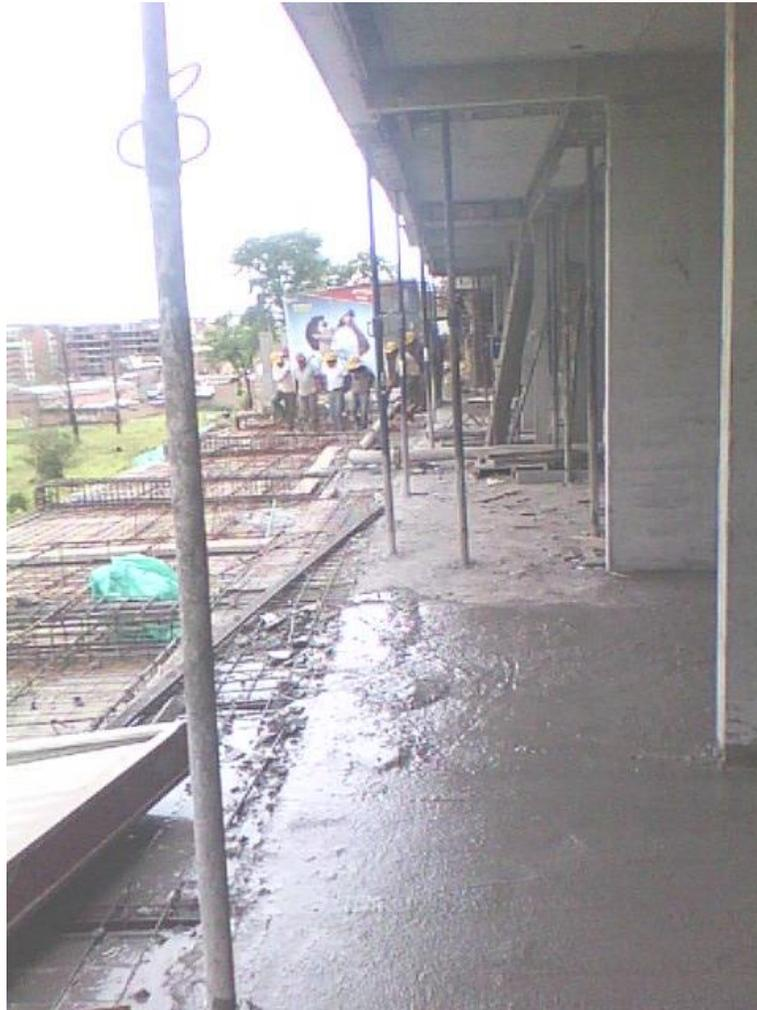
**Fotografía 28. Refuerzo de losa después del desencofrado**
