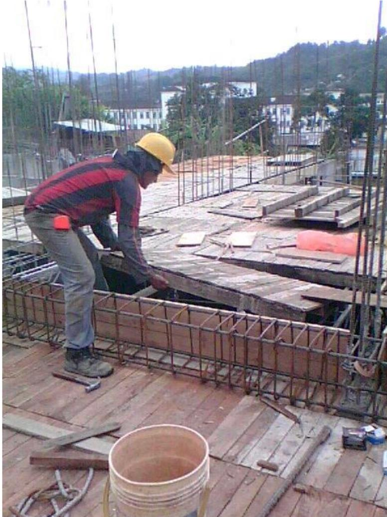
**Fotografía 41. Encofrado de madera de losa aligerada**
