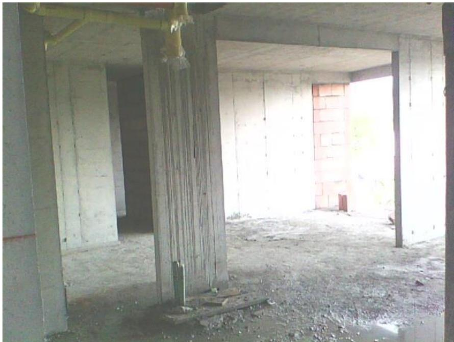
**Fotografía 43. Dintel para conectar dos pantallas estructurales**
