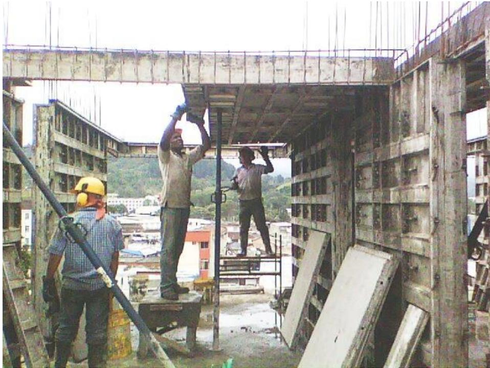
**Fotografía 85. Ensamble y aseguramiento de la formaleta de losa**
