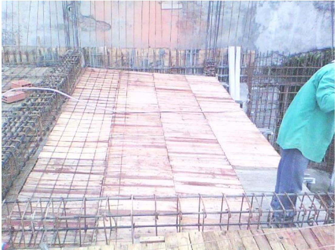
**Fotografía 71. Encofrado de rampa del nivel -1.30 (semisótano).**
