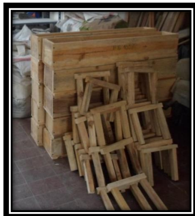
Ilustración 5. Formaleta de madera para vigas de concreto reforzado.
