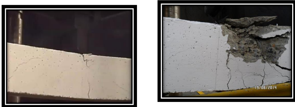
Ilustración 30. Fisuras en vigas con condición balanceada.
