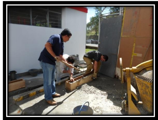
Ilustración 11. Equipo general, materiales y proceso de fundición de vigas.
