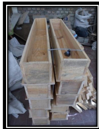
Ilustración 5. Formaleta de madera para vigas de concreto reforzado.
