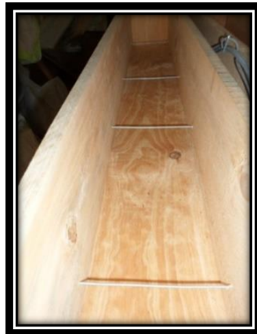
Ilustración 10. Niveladores de alambre y posición del castillo para garantizar la profundidad efectiva y el recubrimientos.
