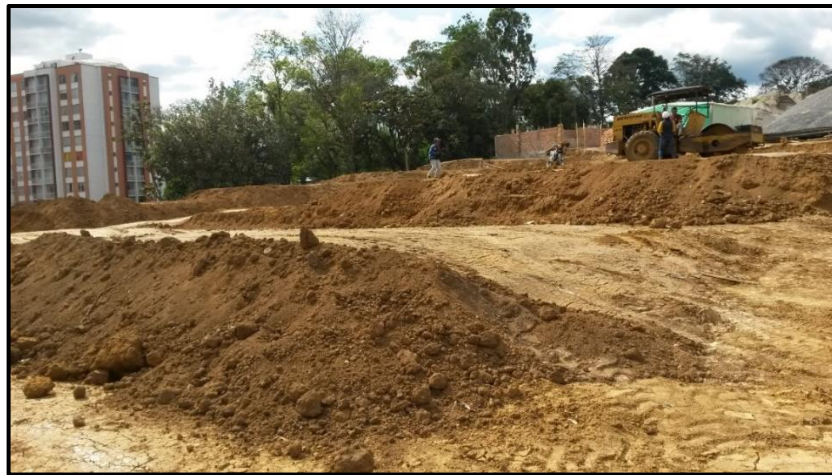
Figura 4 - Bordos de las terrazas compactas sin cortar con la retroexcavadora. Fuente: Fotografía tomada por la pasante
