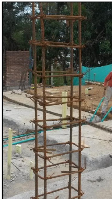
Figura 23 - Refuerzo de columneta. Fuente: Fotografía tomada por la pasante
