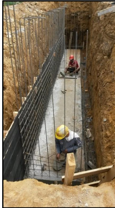
Figura 41 - Refuerzo de muro de contención.
