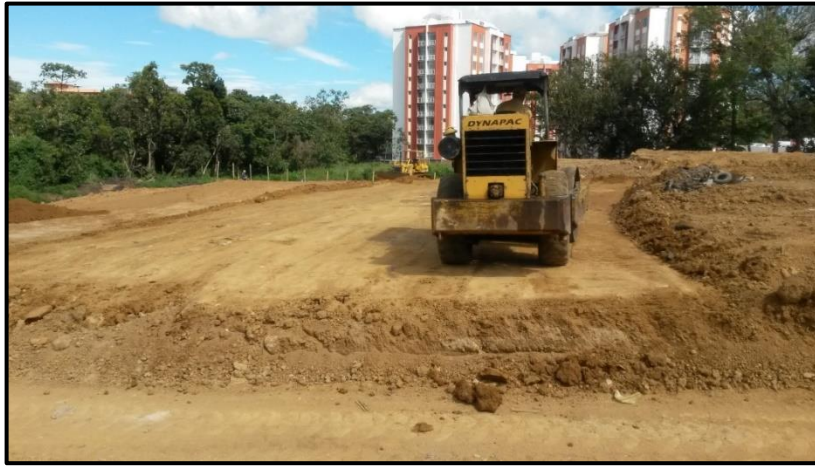
Figura 3 - Compactación de tierra amarilla en capas de 0.40 m. Fuente: Fotografía tomada por la pasante
