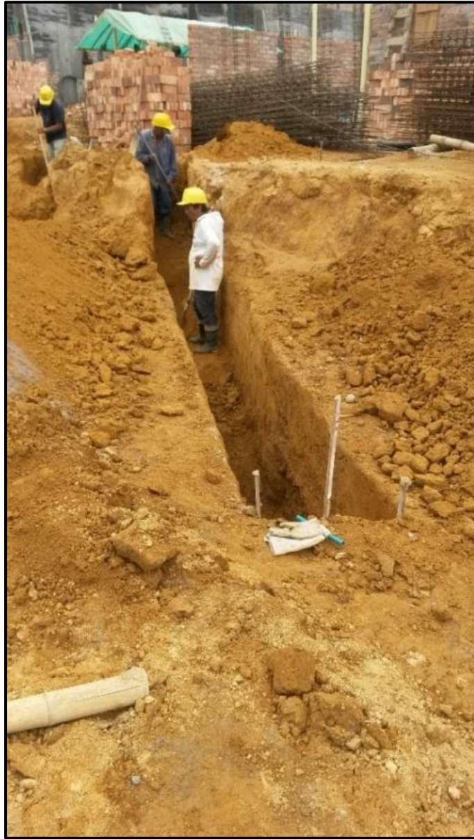
Figura 49 - Excavación de acometida. Fuente: Fotografía tomada por la pasante
