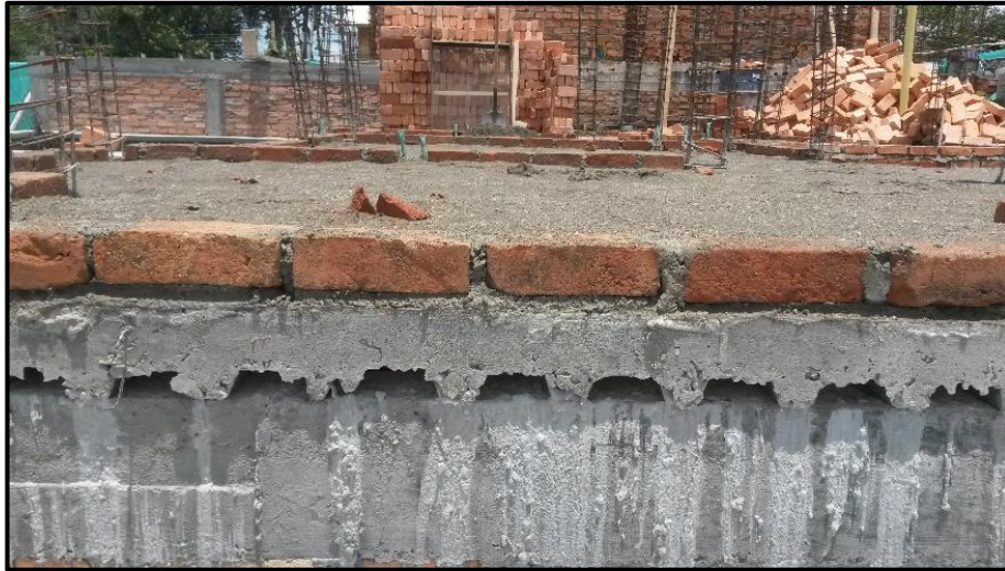
Figura 35 - Primera hilada de ladrillos de muros de mampostería de segundo piso. Fuente: Fotografía tomada por la pasante
