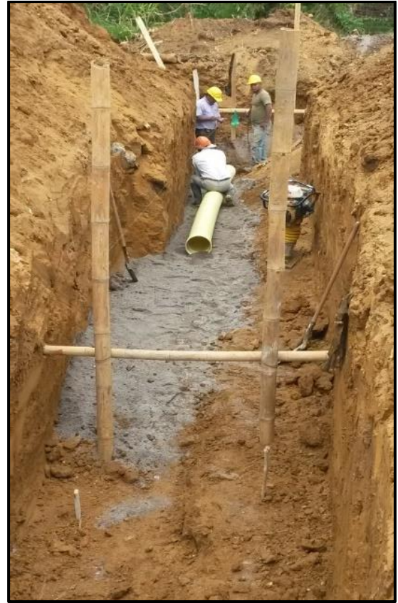
Figura 48 - Colocación de tubería principal. Fuente: Fotografía tomada por la pasante
