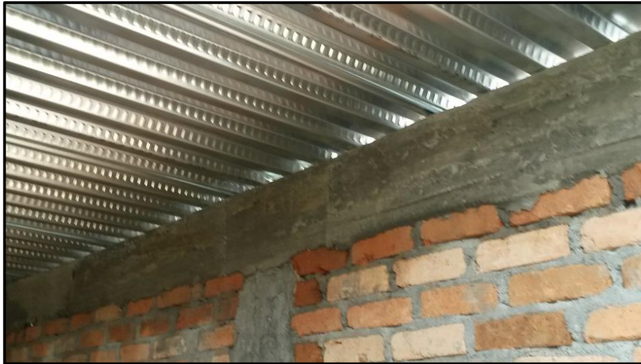
Figura 28 - Corpalosa sobre vigas de amarre Fuente: Fotografía tomada por la pasante
