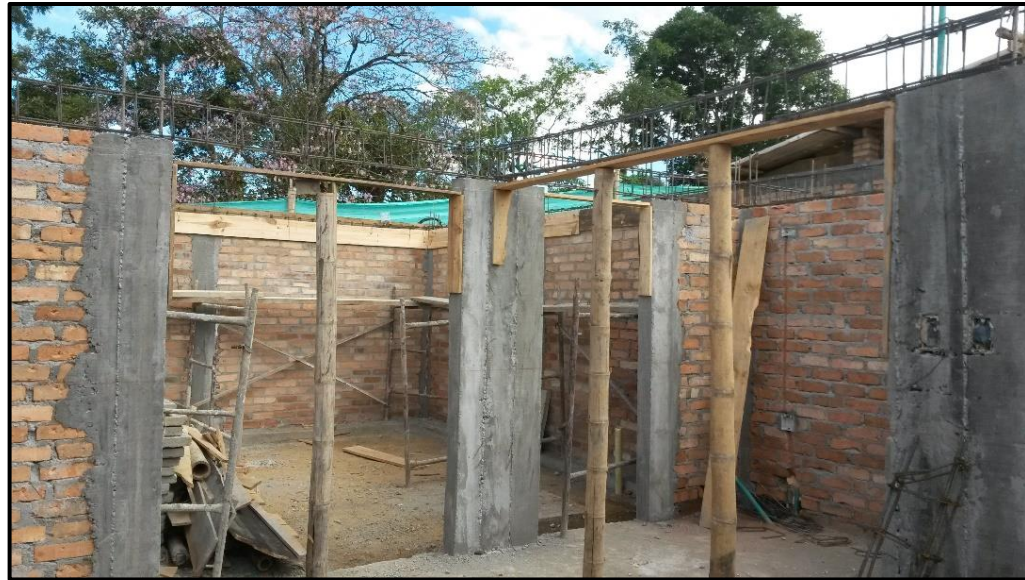
Figura 24 - Refuerzo de vigas de amarre. Fuente: Fotografía tomada por la pasante pasante
