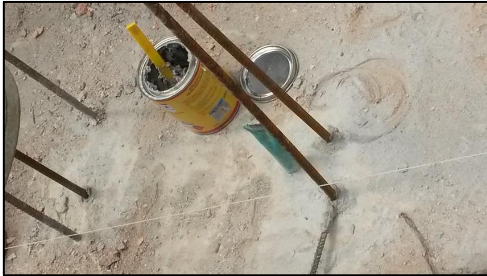
Figura 21 - Colocación de anclajes. Fuente: Fotografía tomada por la pasante
