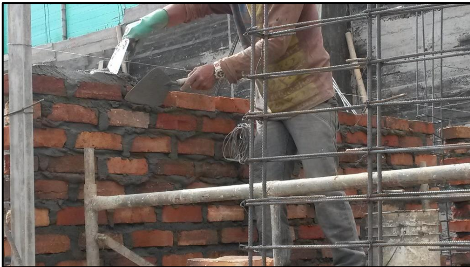
Figura 19 - Construcción muro de mampostería.
