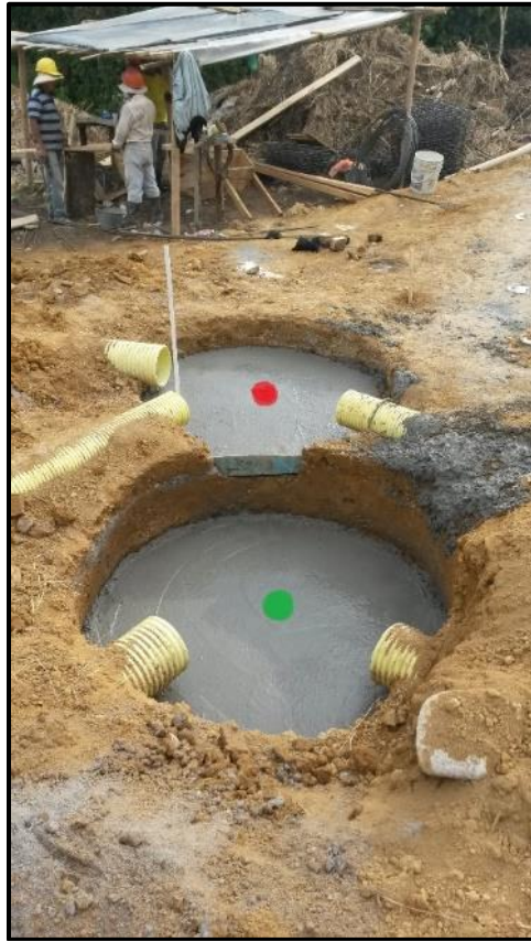
Figura 47 - Fundición de recamaras. Fuente: Fotografía tomada por la pasante
