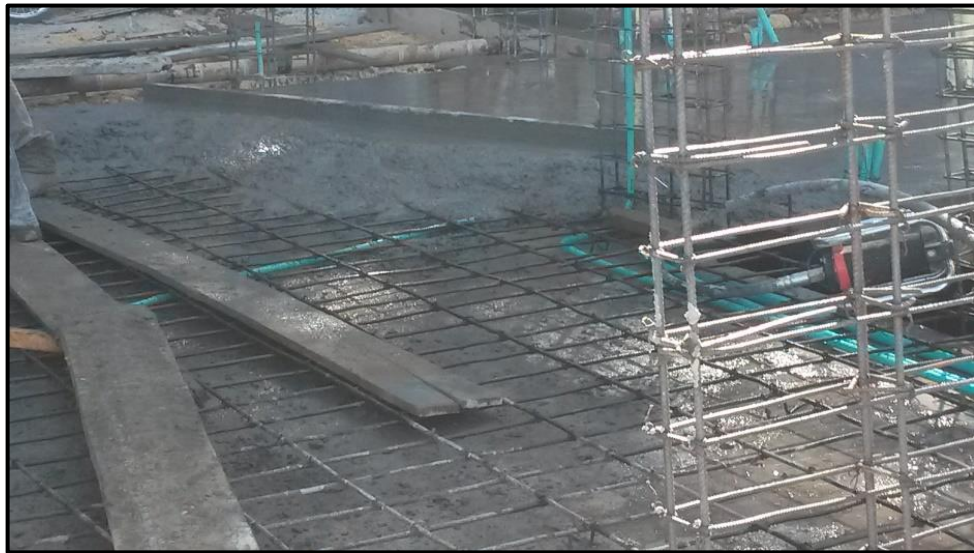
Figura 14 - Fundición de losa de cimentación. Fuente: Fotografía tomada por la pasante
