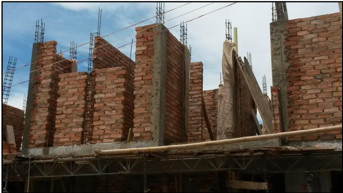
Figura 36 - Columnetas de segundo piso. Fuente: Fotografía tomada por la pasante
