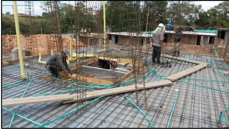
Figura 32 - Fundición de losa de entre piso. Fuente: Fotografía tomada por la pasante
