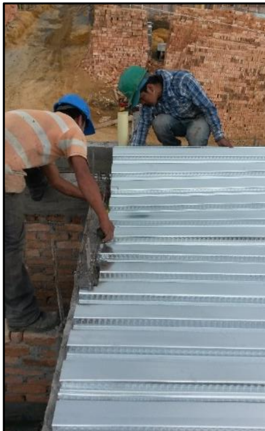
Figura 27 - Colocación de Corpalosa. Fuente: Fotografía tomada por la pasante
