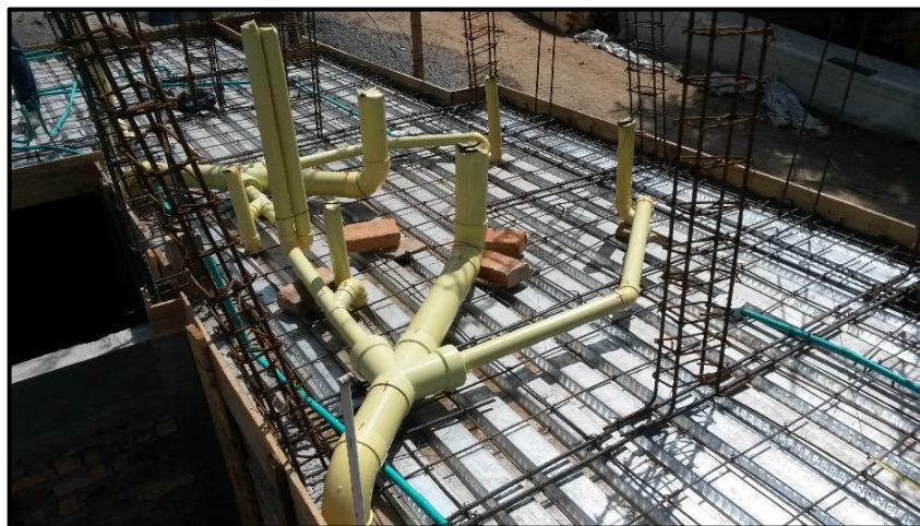
Figura 31 - Tubería sanitaria de segundo piso. Fuente: Fotografía tomada por la pasante
