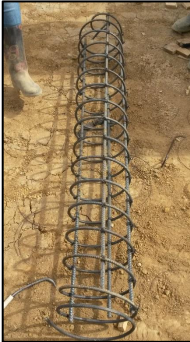
Figura 40 - Refuerzo de pilote.
