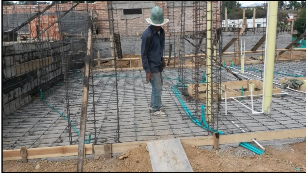
Figura 13 - Losa de cimentación lista para fundir. Fuente: Fotografía tomada por la pasante
