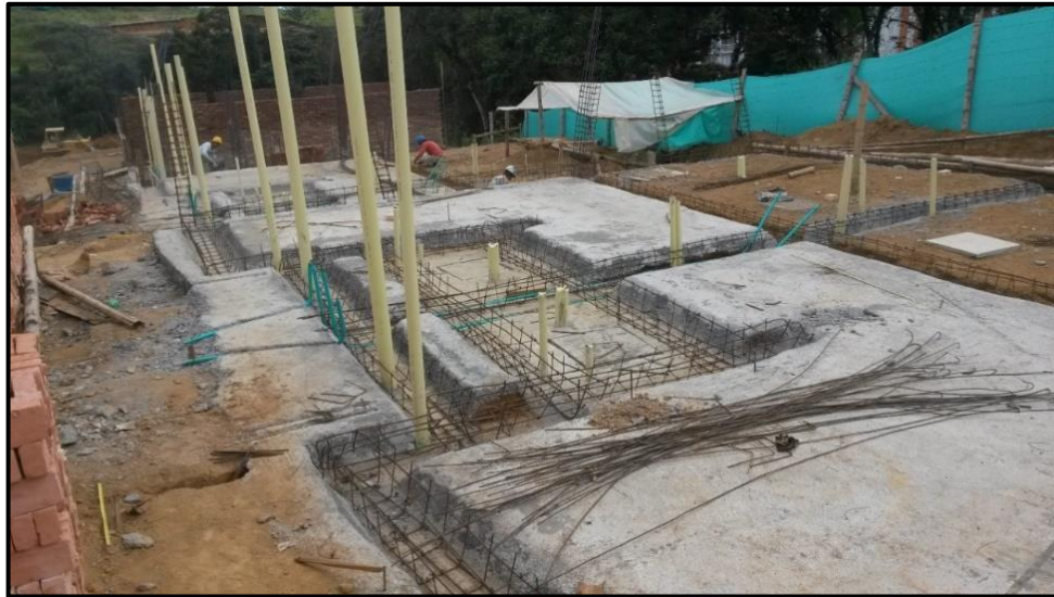
Figura 10 - Cimentación según diseño estructural de empresa Solarte. Fuente: Fotografía tomada por la pasante
