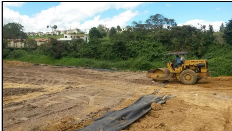
Figura 2 - Relleno en proceso de compactación con geotextil en los bordes. Fuente: Fotografía tomada por la pasante
