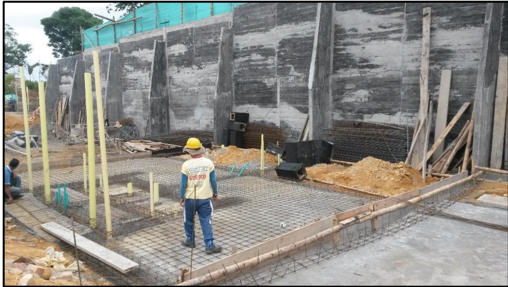
Figura 39 - Muros de contención manzana E. Fuente: Fotografía tomada por la pasante
