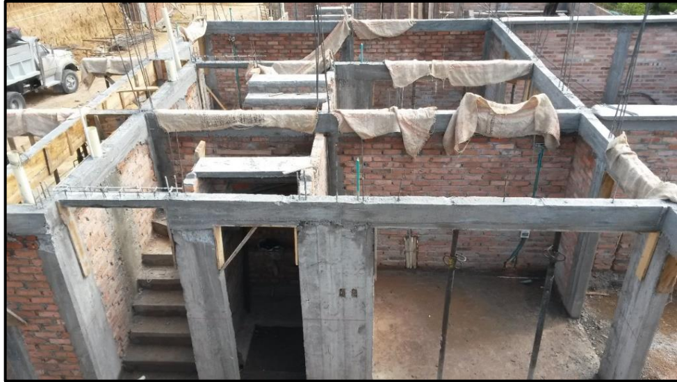
Figura 25 - Vigas de amarre fundidas. Fuente: Fotografía tomada por la pasante
