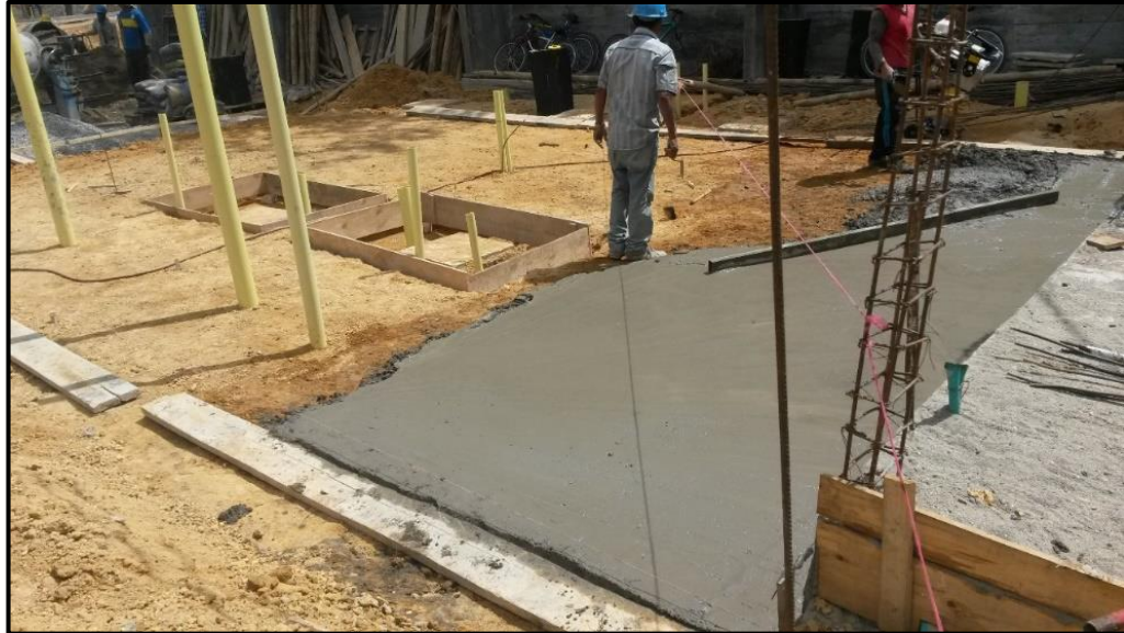
Figura 12 - Colocación de solado para la losa de cimentación. Fuente: Fotografía tomada por la pasante
