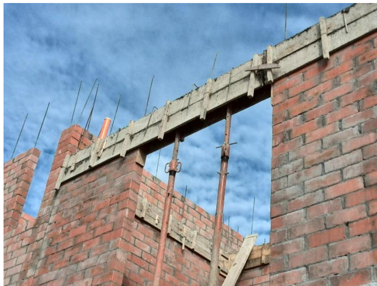
Figura 24. Fundición viga de amarre casa 6
