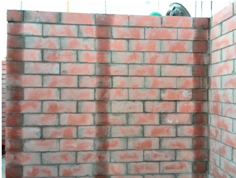
Figura 16. Chequeo de llenado de dovelas forma humeda
