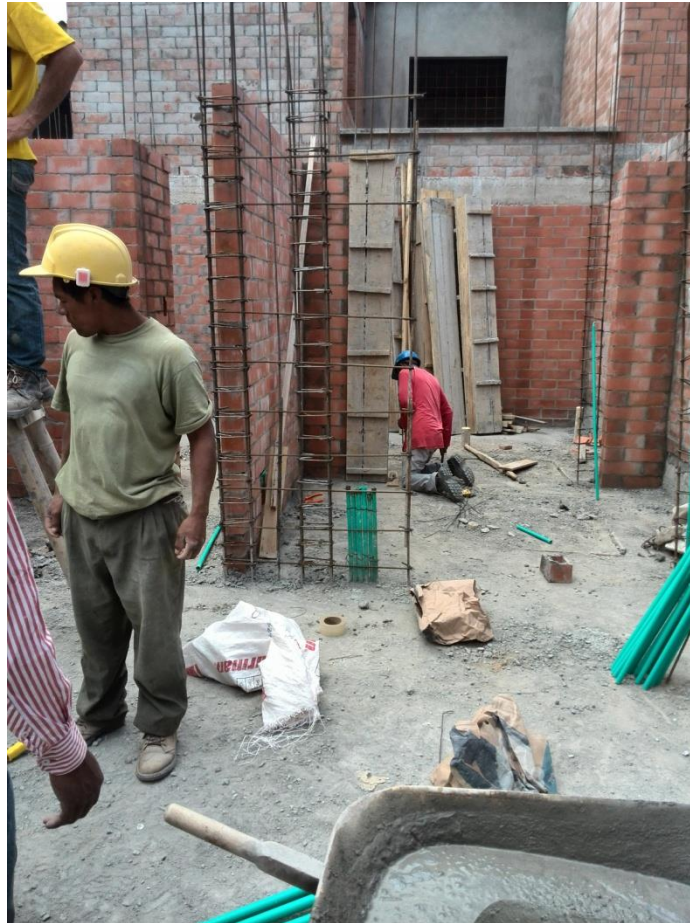
Fuente: Construcción casa 21 (Registro fotográfico Propio)
