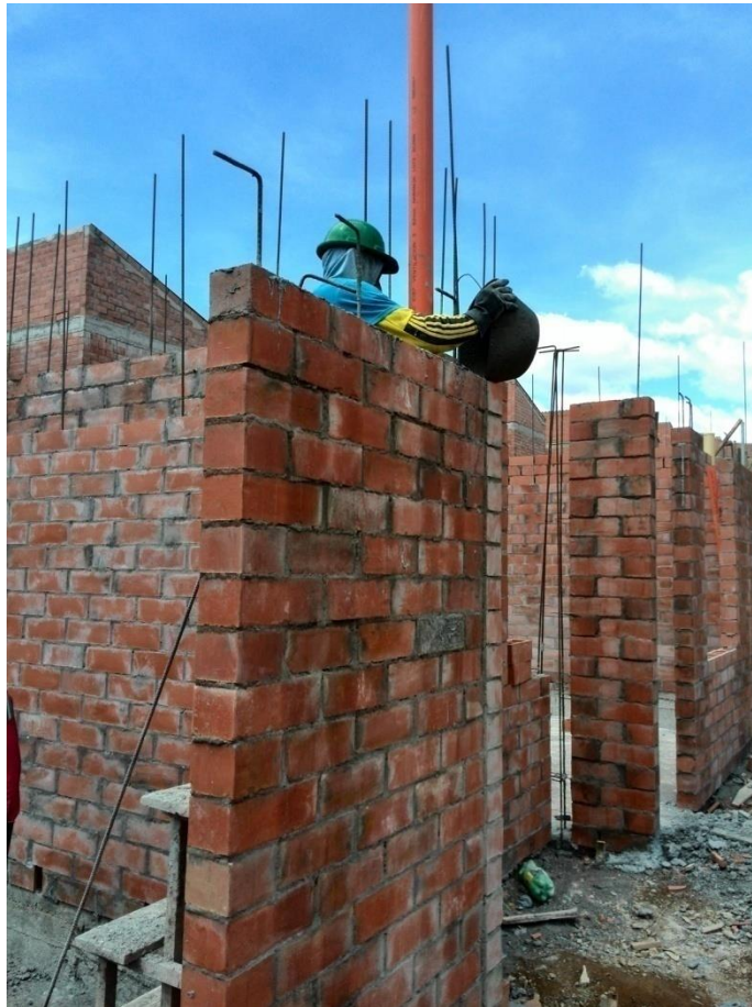
Fuente: Construcción casa 6 (Registro fotográfico Propio)
