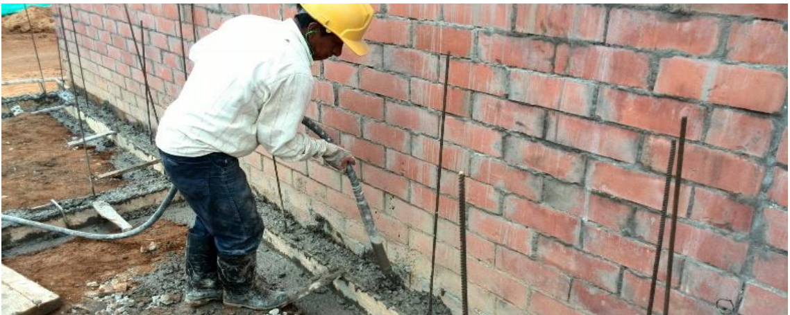
Vibrado de cimentaciones de viviendas
