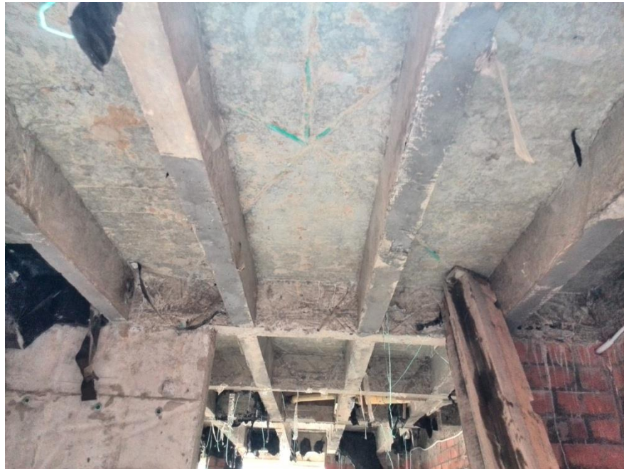
Figura 22. Desencofrado de losa de entrapiso
