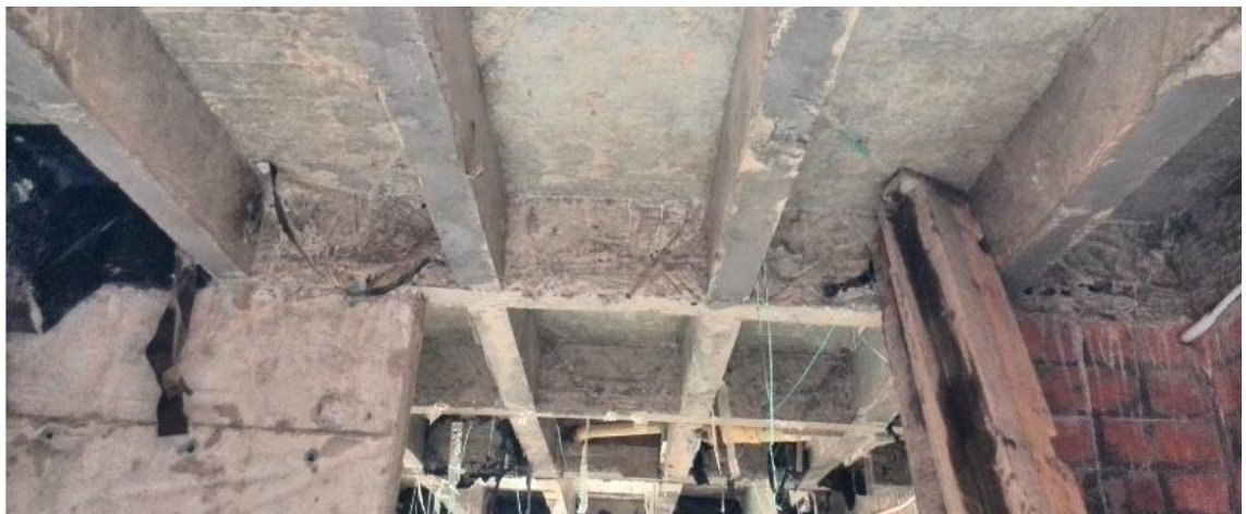
Losa de entepiso viviendas
