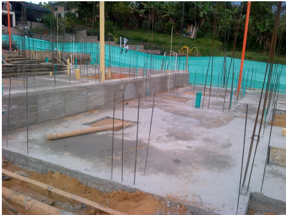
Figura 11. Plancha de cimentación casa 9 terminado
