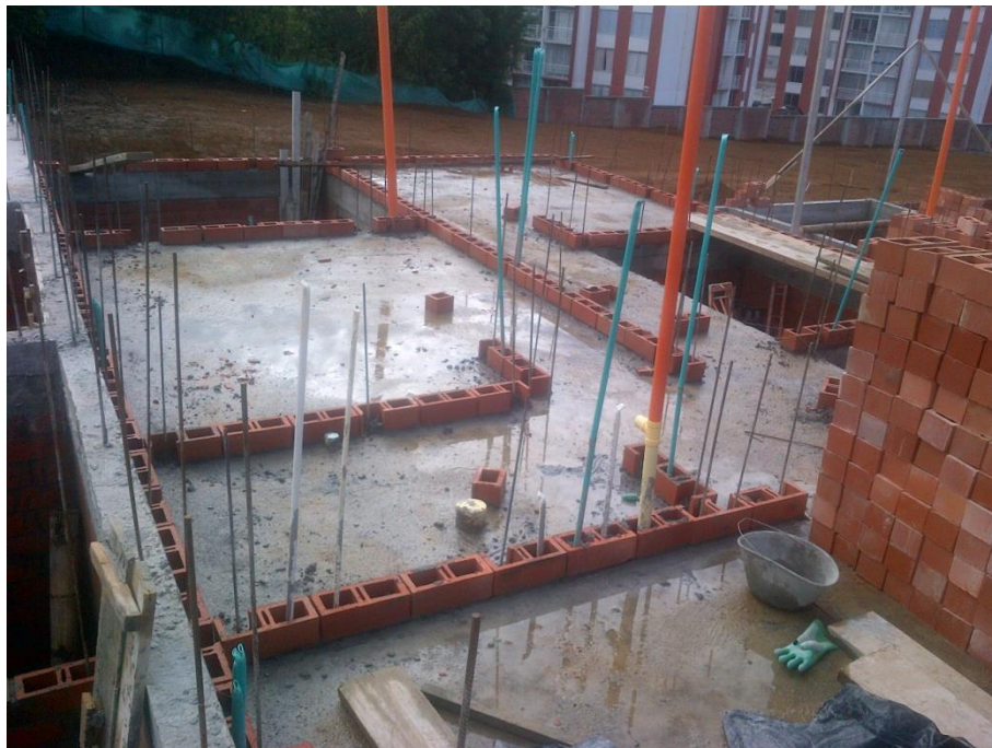
Figura 23. Planteo de muros segundo piso casa 13
