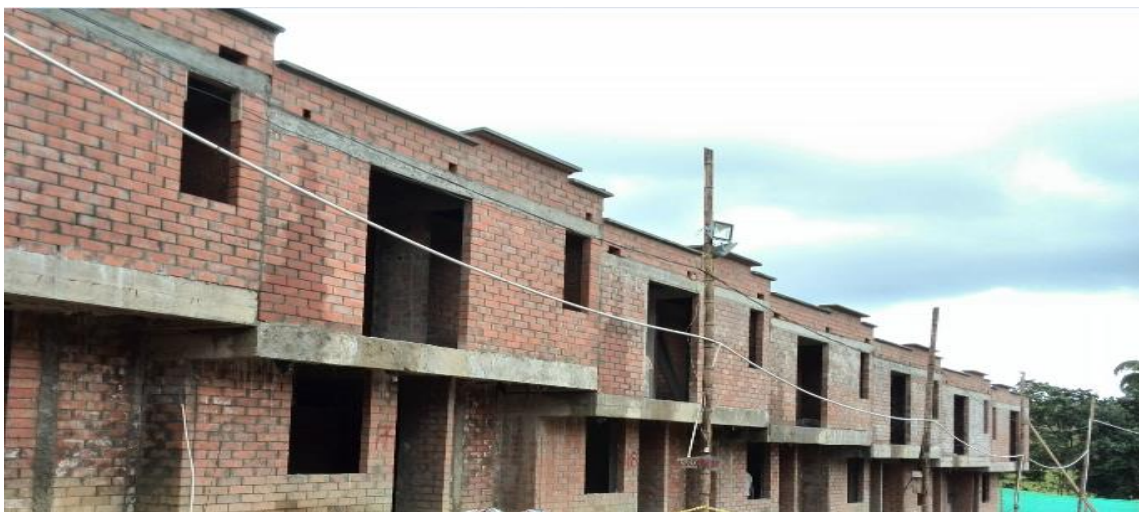
Viviendas terminadas obra negra Condominio Monserrat
