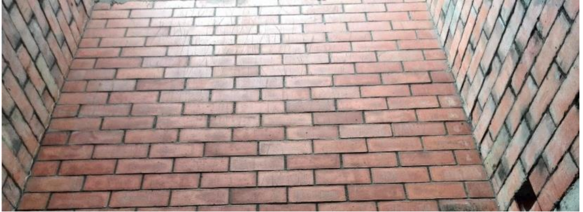
Muros a la vista viviendas
