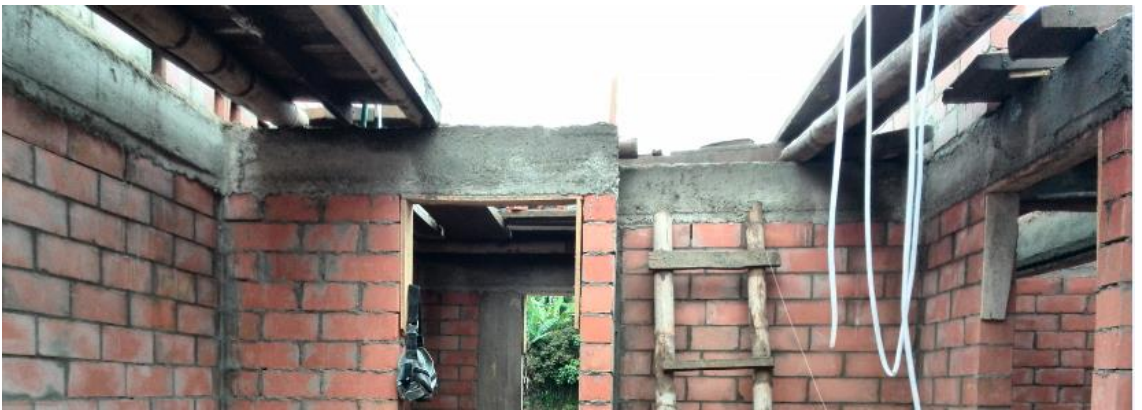
Vigas de amarre viviendas
