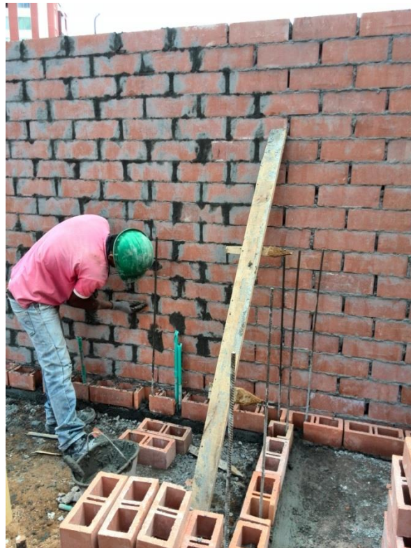
Fuente: Construcción casa 4 (Registro fotográfico Propio)
