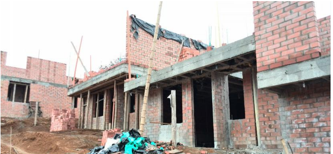
Terminación viviendas 1 a 22 Condominio Monserrat
