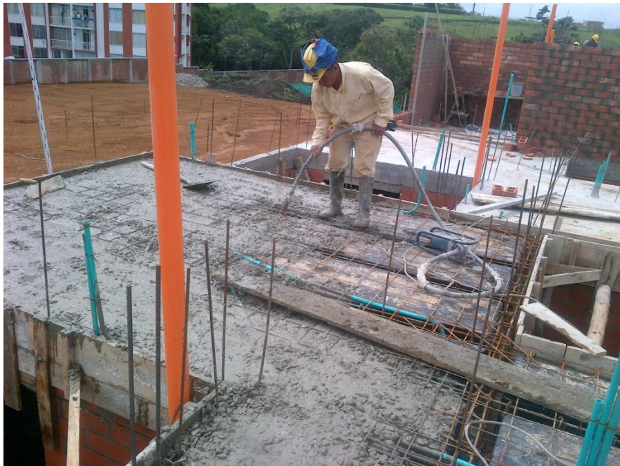
Figura 20. Vibrado de losa de entrepiso casa 12
