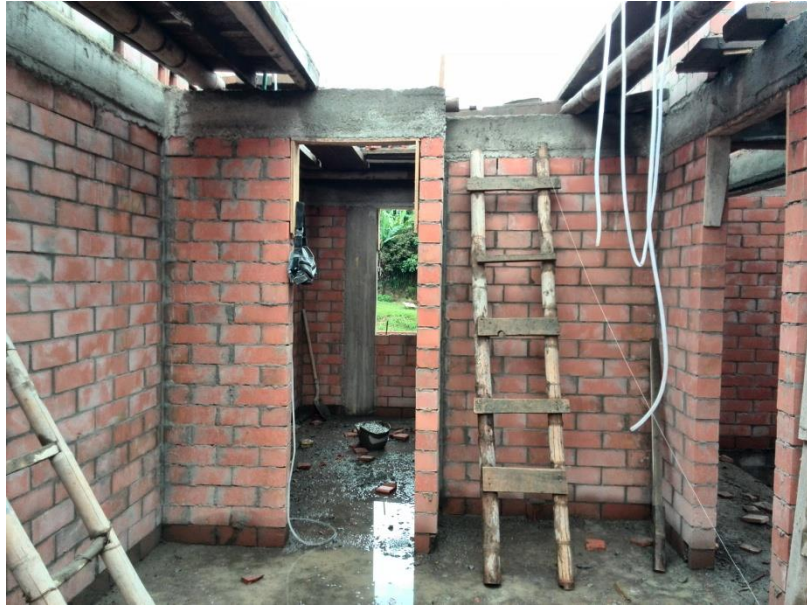
Fuente: Construcción casa 11 (Registro fotográfico Propio)
