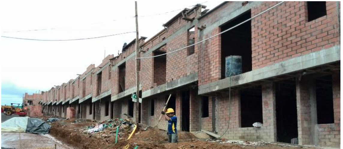
Construcción de viviendas Condominio Monserrat
