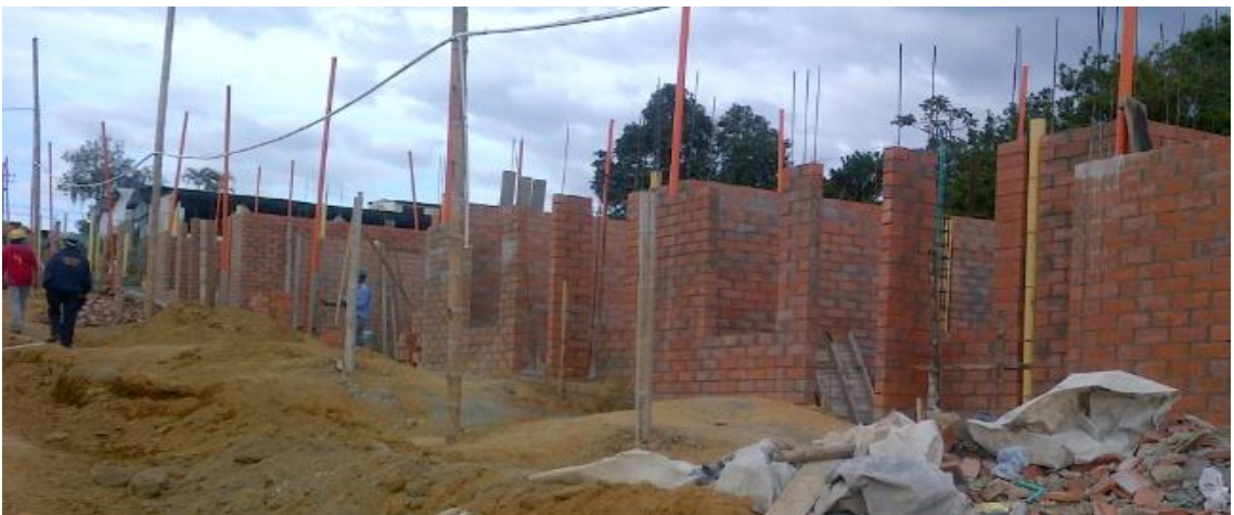
Mampostería primeros pisos viviendas
