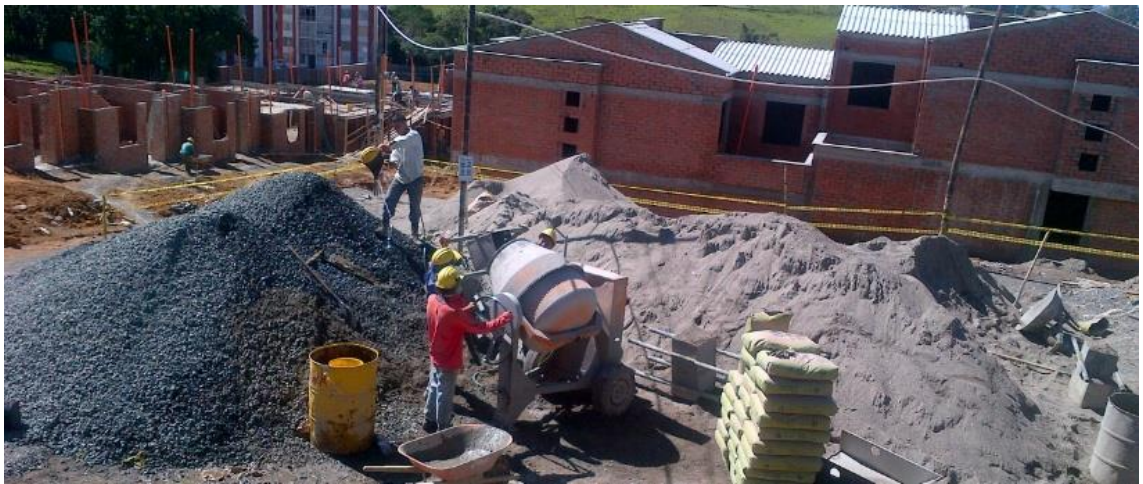
Preparación de concreto
