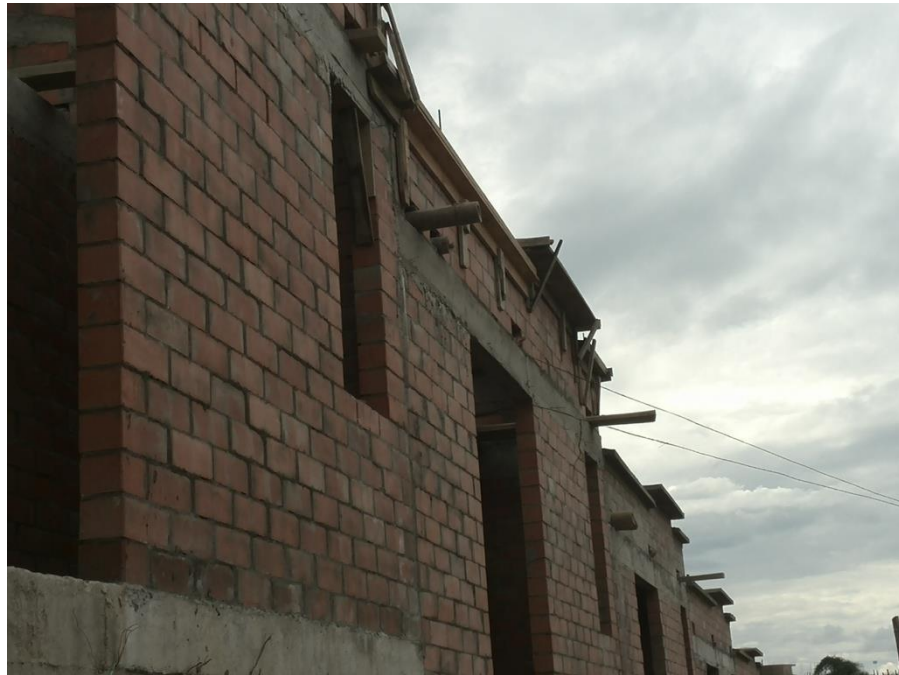
Figura 26. Formaleta alfajía casa 7 Condominio Monserrat
