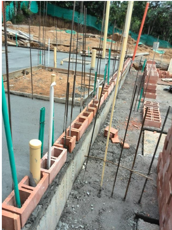
Fuente: Construcción casa 9 (Registro fotográfico Propio)
