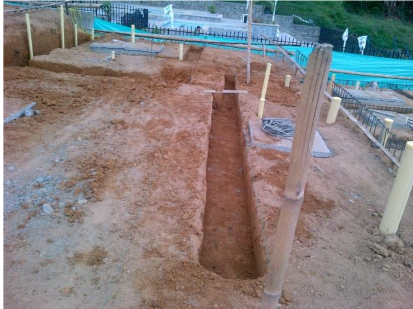
Figura 6. Zanjas para tuberías sanitarias y pluviales casa 8
