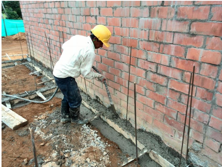
Figura 10. Vibrado de Cimentaciones
