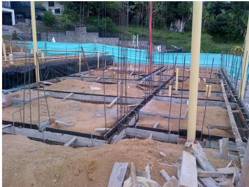
Figura 9. Zapatas corridas casa 9
