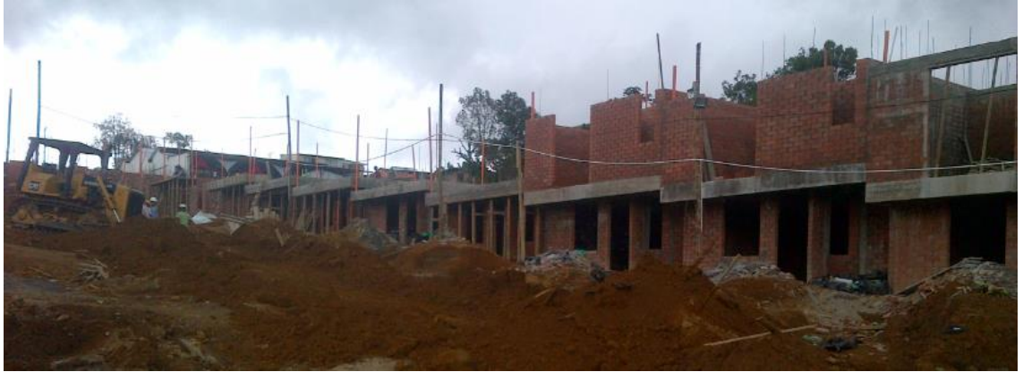
Mampostería segundos pisos viviendas
