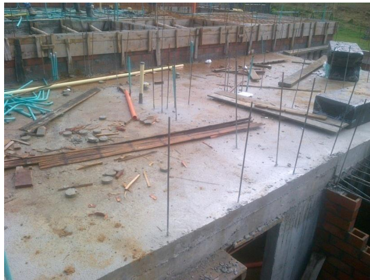
Fuente: construcción casa 13 (Registro fotográfico Propio)
