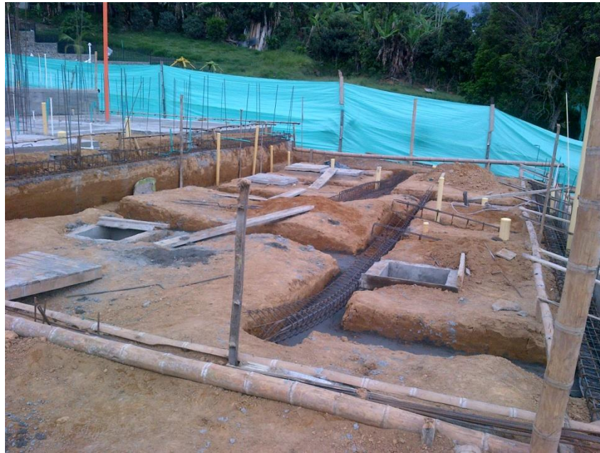
Figura 9. Colocación de acero en cimentación
