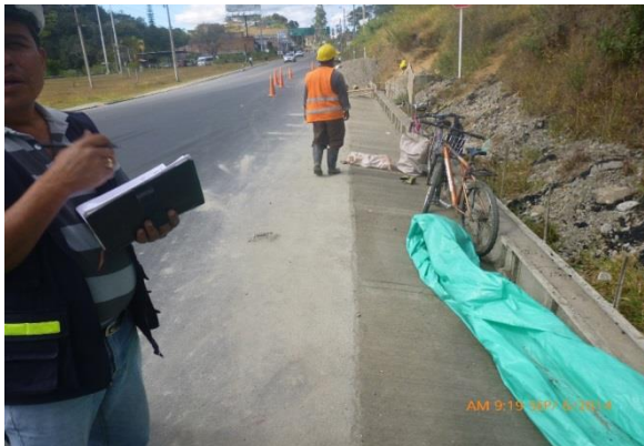
Imagen No. 33 terminado final de la cuneta.
