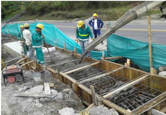
Imagen No. 87 vaciado del concreto por medio mecánico.
