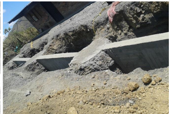
Imagen No. 59 construcción de pantallas entre pila y pila.
