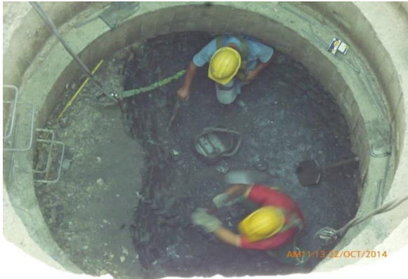
Imagen No. 68 excavación para instalación de formaleta. Imagen No. 69 formaleta y localización de los drenes.
