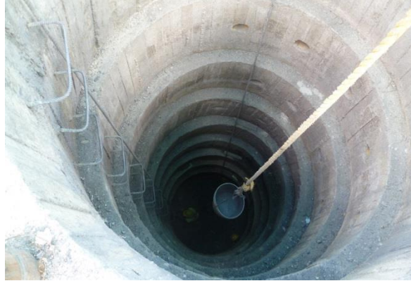
Imagen No. 72 pozo de abatimiento casi terminado.
