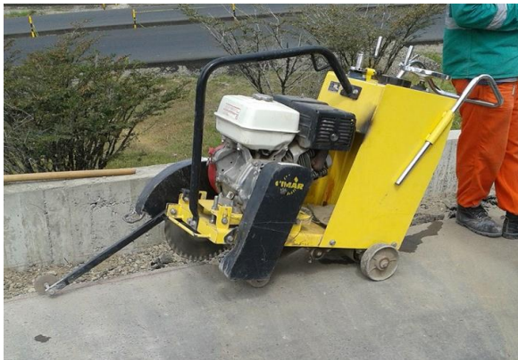
Imagen No.29 corte de pavimento.
