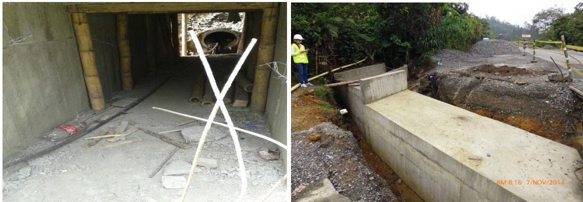
Imagen No. (98 y 99) proceso de curado de la estructura.
