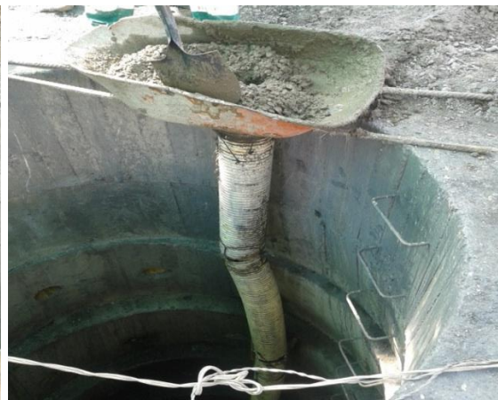
Imágenes No. (70 y 71) vaciado del concreto sobre los diferentes anillos del pozo.
