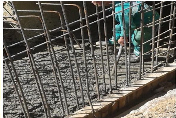
Imagen No. 95 vibrado de concreto.
