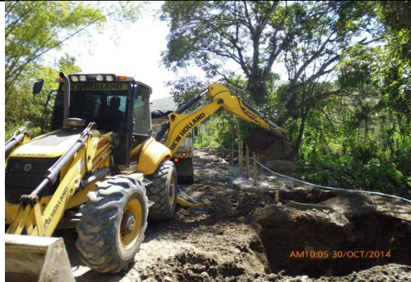
Imagen No. 57 excavación para muro berlinés.
