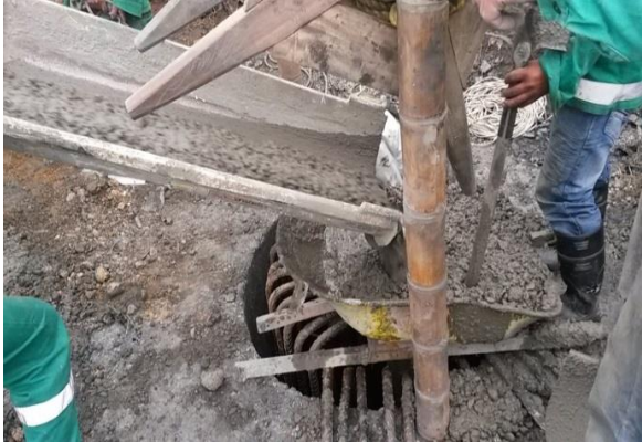
Imagen No. 53 fundición del núcleo del caisson.
