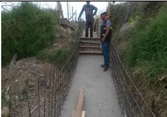
Imagen No. 38 losa de disipador segunda escala.
