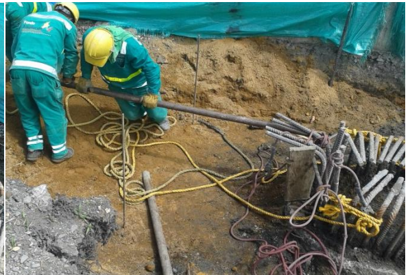
Imágenes No. (82 y 83) figurado de acero para amarre con la viga.
