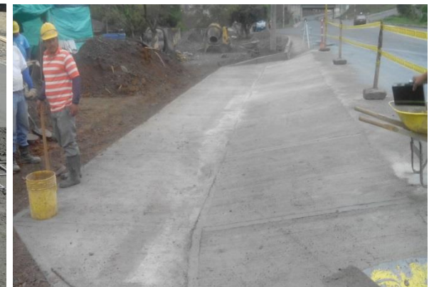
Imagen No.22 dilataciones y curado del concreto.
