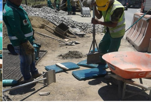
Imagen No.61 llenado de los sacos de suelo cemento.
