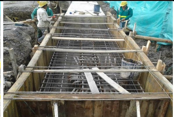
Imagen No. 86 instalación de formaleta.
