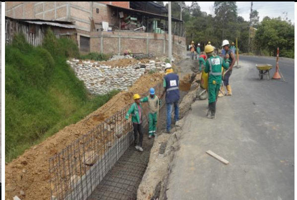
Imagen No.26 instalación de acero de refuerzo para muro.
