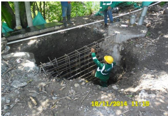
Imagen No. 58 acero de refuerzo para muro berlinés.
