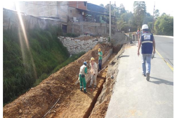
Imagen No.24 Excavación de diente para muro.
