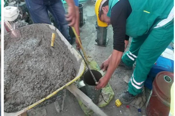
Imagen No. 54 ensayo de asentamiento.
