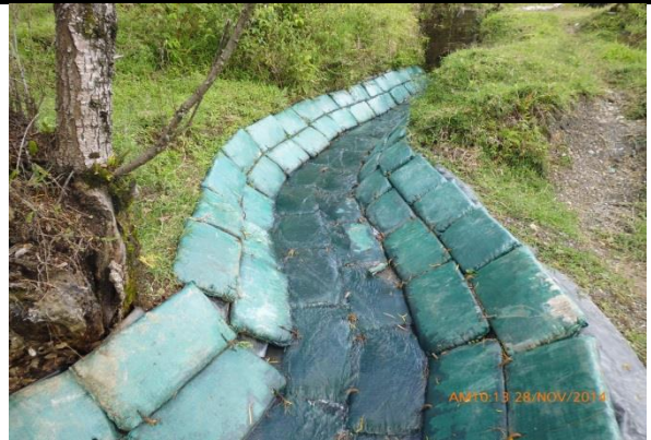
Imagen No. 64 sacos anclados a la geo membrana.
