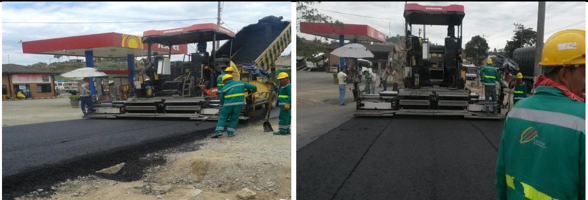
Imagen No. (13 y 14) disposición de la mezcla asfáltica a la pavimentadora y distribución sobre la superficie a pavimentar.
