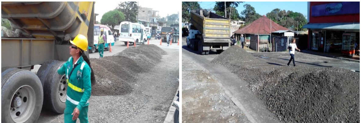
Imágenes No. (5 y 6) disposición del material granular en cordón uniforme.
