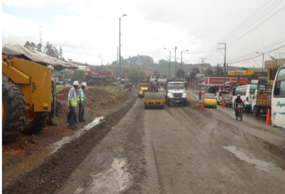
Imagen No.9 Compactación del material granular.
