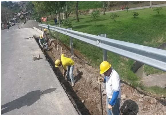
Imagen No.23 Excavación de terreno para muro.
