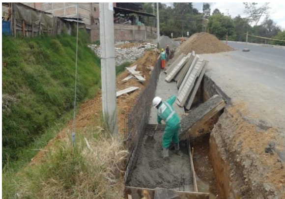
Imágenes No. (27 y 28) instalación de formaleta y vaciado de concreto.
