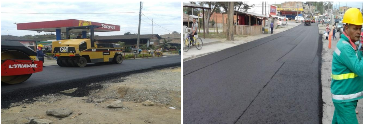
Imagen No. (15 y 16) extendido y compactación de pavimento flexible.
