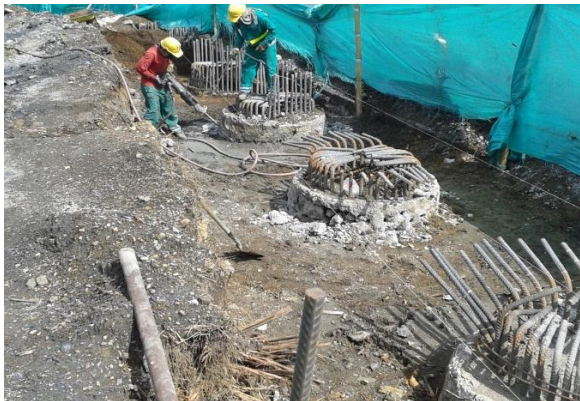
Imágenes No. (82 y 83) figurado de acero para amarre con la viga.
