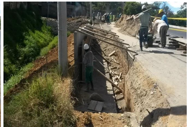
Imagen No.26 instalación de acero de refuerzo para muro.
