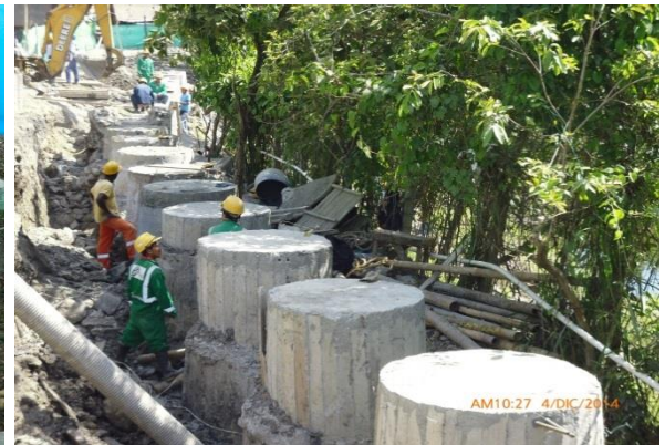
Imagen No. 56 fundición del núcleo del caisson.
