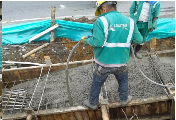
Imagen No. 88 vibrado del concreto.
