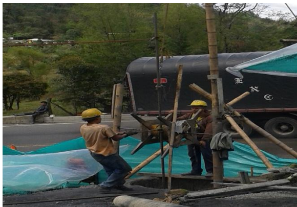
Imágenes No. (51 y 52) instalación de acero de refuerzo para núcleo del caisson.
