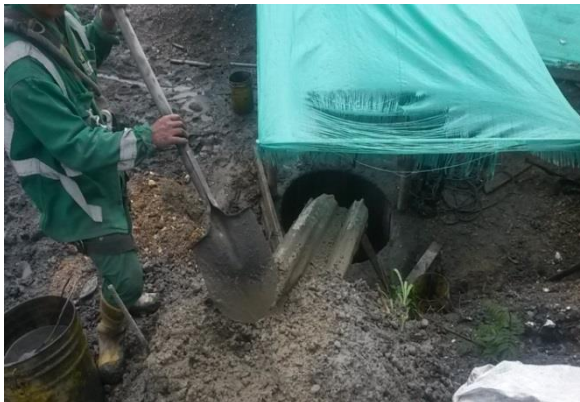
Imagen No. 48 vaciado de concreto en el anillo.
