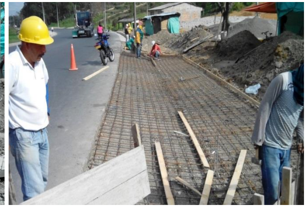
Imagen No.20 instalación de acero y formaleta.
