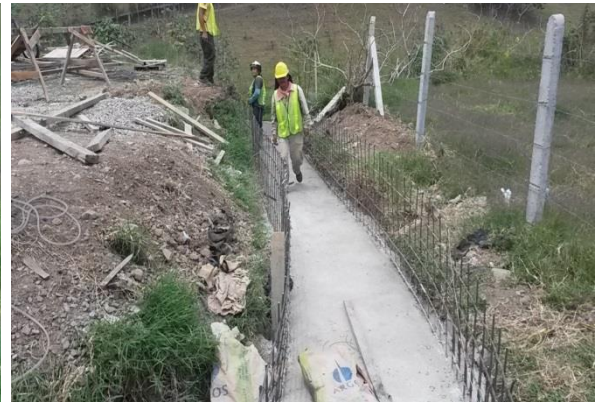
Imagen No. 36 solado de limpieza e instalación de acero. Imagen No. 37 losa de disipador primera escala.
