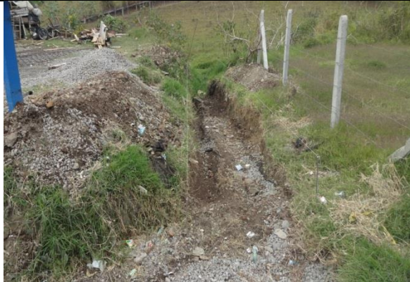
Imagen No. 35 excavación y conformación de terreno para disipador.
