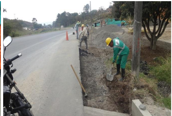
Imagen No.30 conformación de terreno para cuneta.
