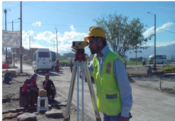
Imagen No.11 Recibo de la superficie por topografía.
