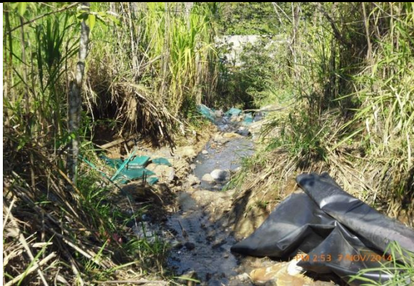
Imagen No. 63 geo membrana para cuneta flexible.
