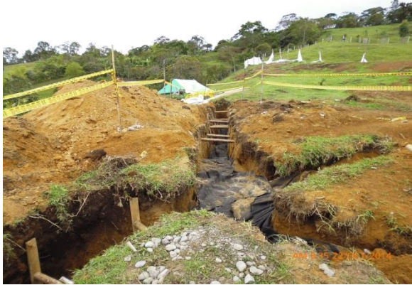
Imagen No. (80 y 81) colocación del geo textil para posterior relleno con material del sitio y revegetalización.
