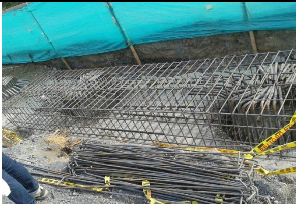
Imagen No. 85 figurado e instalación de acero.
