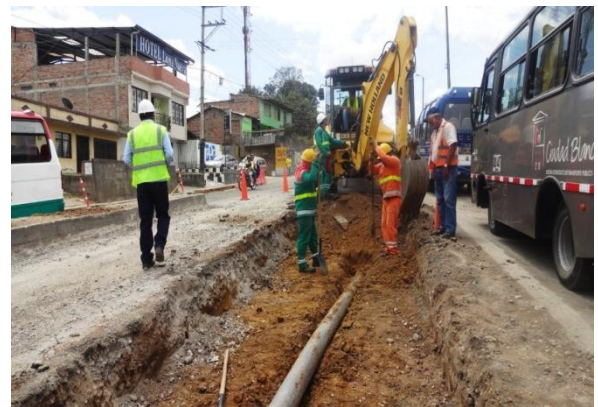
Imagen No.3 excavación de capas granulares.
