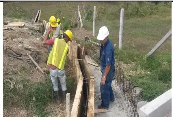
Imagen No. 39 instalación de formaleta pared disipador.
