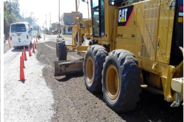
Imagen No.8 extendido del material granular.
