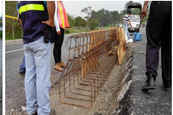
Imagen No. 43 instalación de acero y formaleta.
