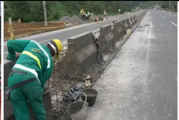
Imagen No. 45 resanado final del concreto.
