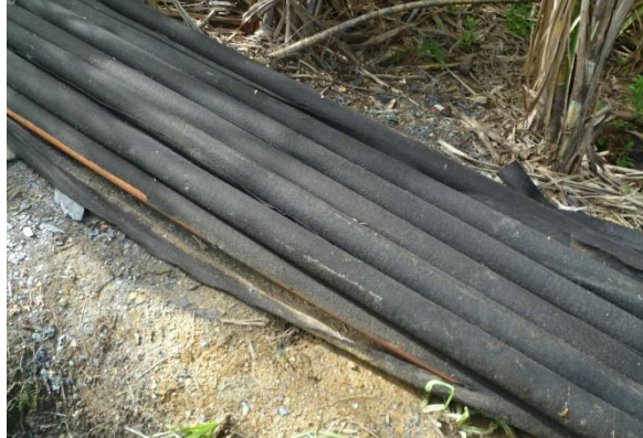
Imagen No. 73 tubería envuelta con geo textil para drenes horizontales.
