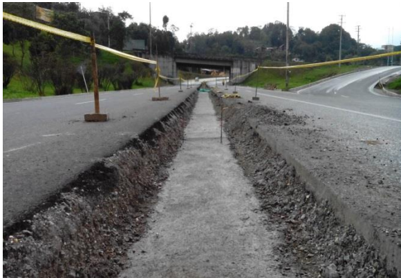
Imagen No. 42 solado de limpieza para NY.
