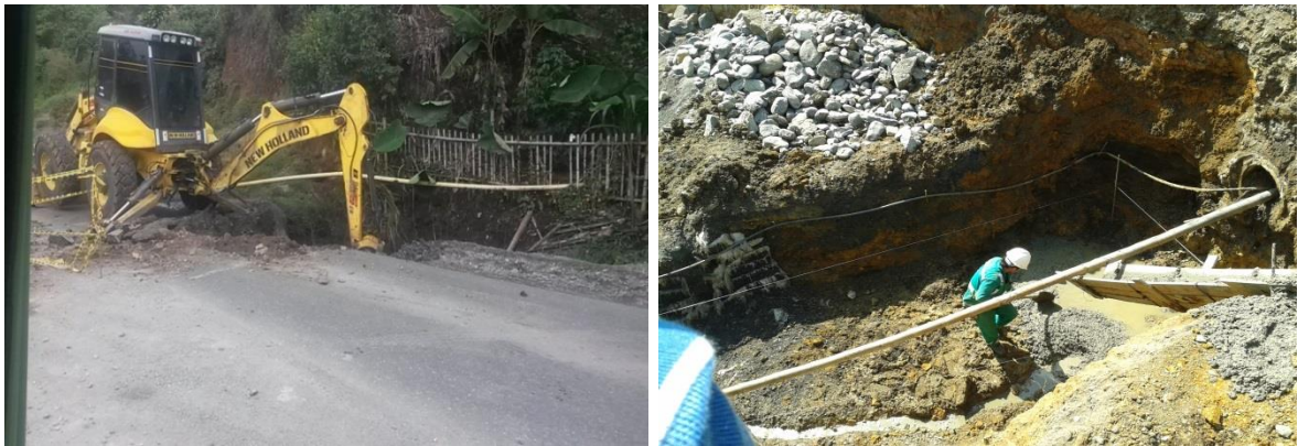
Imagen No. (90 y 91) excavación y mejoramiento de terreno para construcción de box culvert.
