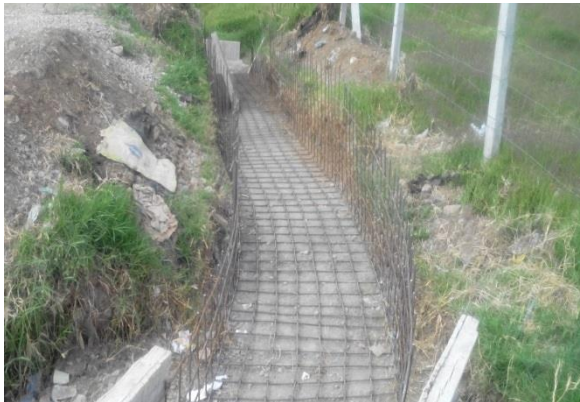
Imagen No. 36 solado de limpieza e instalación de acero. Imagen No. 37 losa de disipador primera escala.
