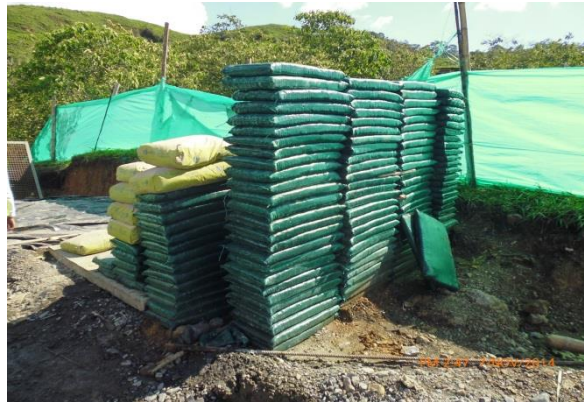
Imagen No.62 sacos de suelo cemento para posterior construcción de cuneta flexible.
