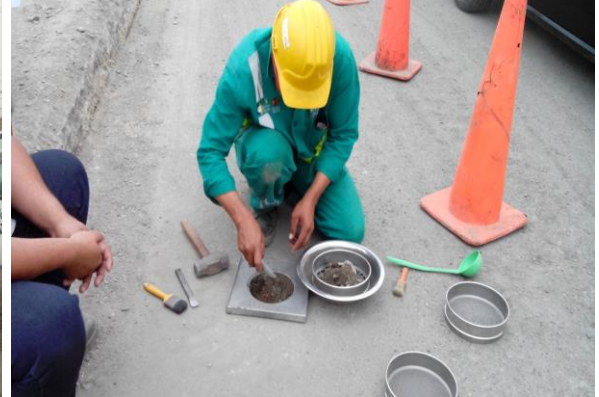
Imagen No.10 Toma de densidades por método de cono y arena.
