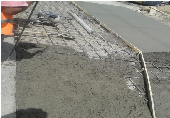
Imagen No.21 vaciado y vibrado del concreto.
