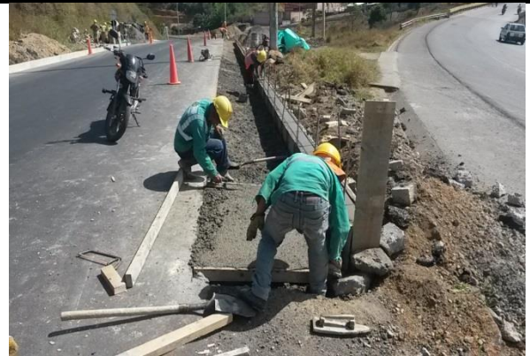
Imágenes No. (31 y 32) instalación de formaleta, vaciado y compactación del concreto.
