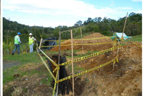
Imagen No. 77 excavación para instalación de filtro.
