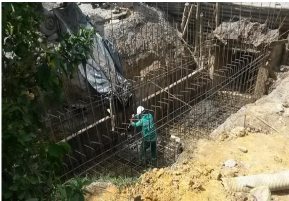
Imagen No. 94 vaciado del concreto para losa de box.
