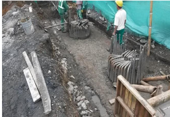
Imagen No. 84 solado de limpieza para instalación de acero de viga cabezal.
