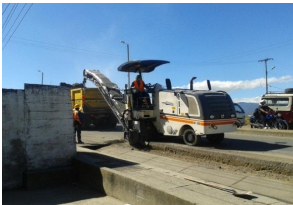
Imagen No.2 corte de pavimento asfáltico.
