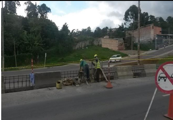
Imagen No. 44 vaciado y vibrado del concreto.
