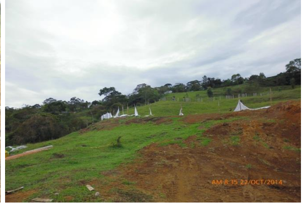
Imagen No. (80 y 81) colocación del geo textil para posterior relleno con material del sitio y revegetalización.
