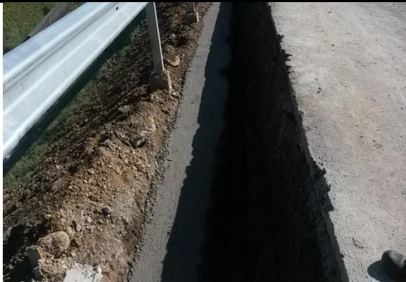
Imagen No.25 Solado de limpieza.
