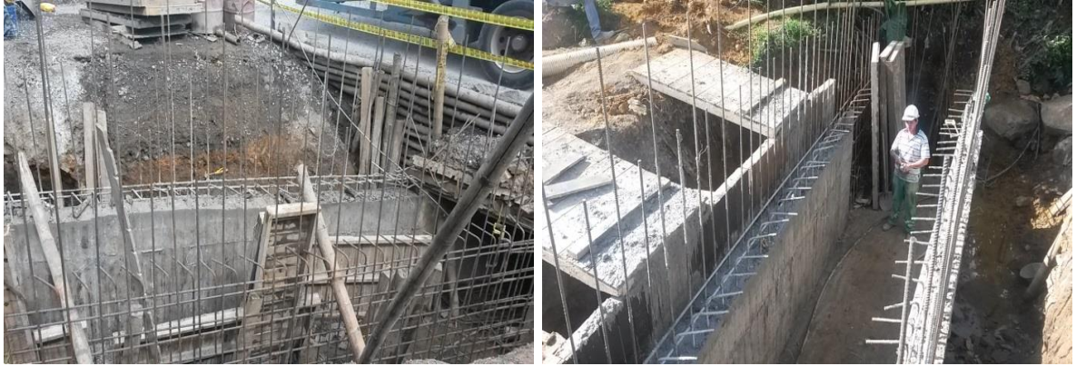
Imágenes No. (96 y 97) construcción de las paredes del box culvert.
