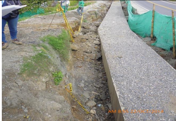
Imagen No. 89 proceso de curado de la viga.
