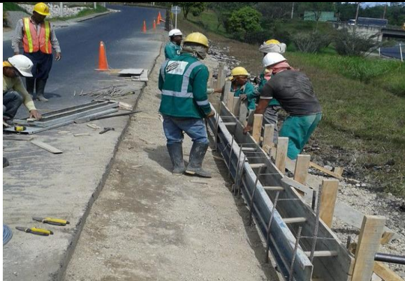
Imágenes No. (31 y 32) instalación de formaleta, vaciado y compactación del concreto.
