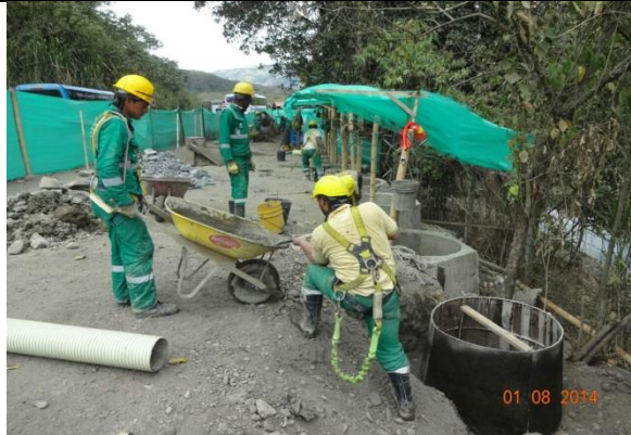
Imagen No. 50 fundición de anillos para posterior construcción del núcleo de las pilas.
