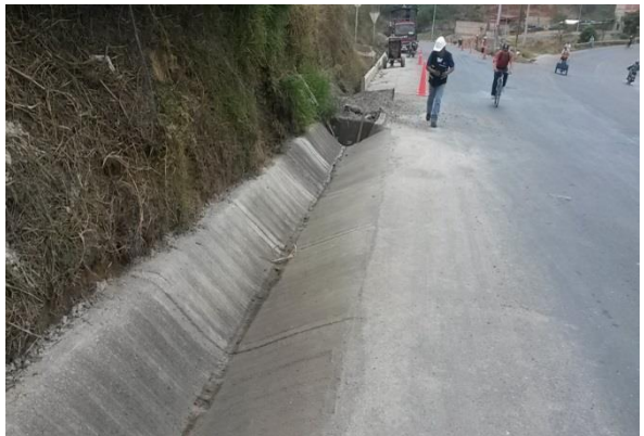
Imagen No. 34 cuneta en sección triangular.
