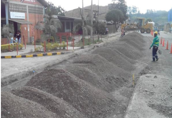
Imagen No.7 disposición del material granular.
