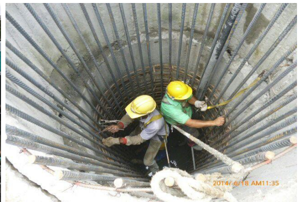
Imágenes No. (51 y 52) instalación de acero de refuerzo para núcleo del caisson.
