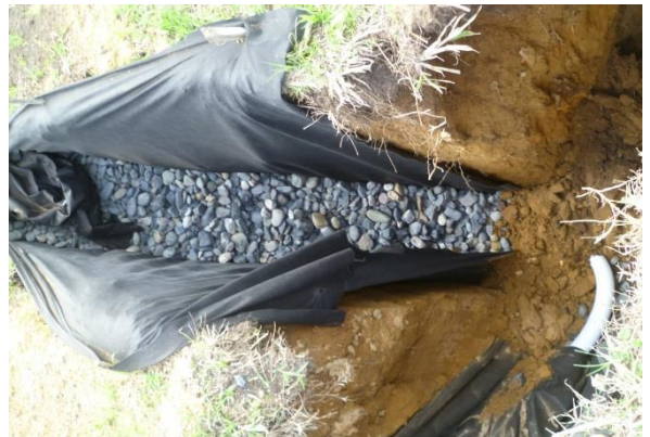
Imagen No. 79 instalación de geo textil, tubería y material granular.
