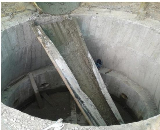
Imágenes No. (70 y 71) vaciado del concreto sobre los diferentes anillos del pozo.
