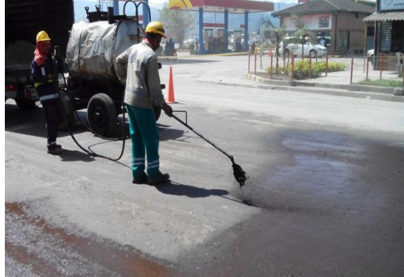
Imagen No.12 riego de imprimación
