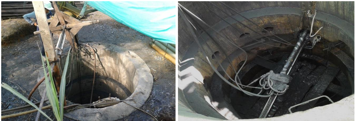
Imágenes No. (74 y 75) equipo empleado para la perforación de los drenes.
