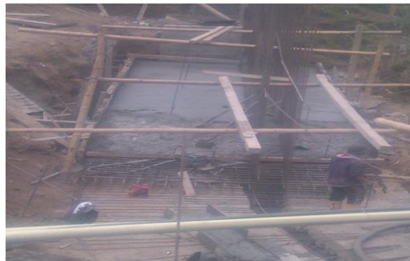
Imagen No.59. Fundición de la zapata del muro k28+880
