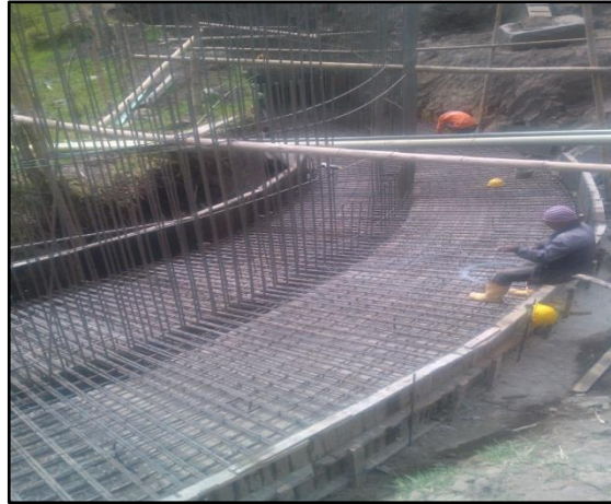
Imagen No.58. Acero de la zapata del muro k28+880
