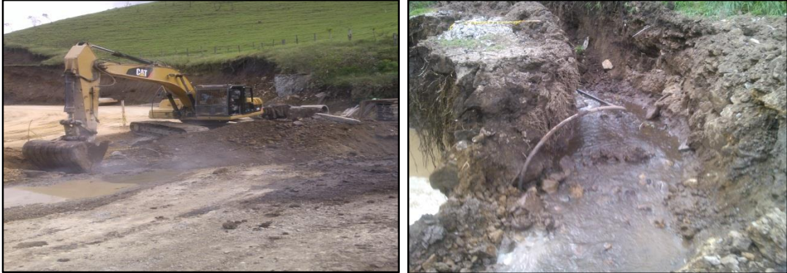
Imagen No.64. Excavación del box coulver k28+880
