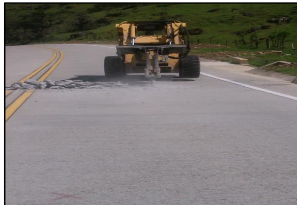
Imagen No.18. Equipo de demolición: minicargador con martillo
