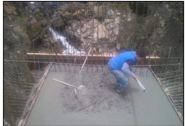
Imágenes No.41. Fundición losa superior Box Coulver k34+190
