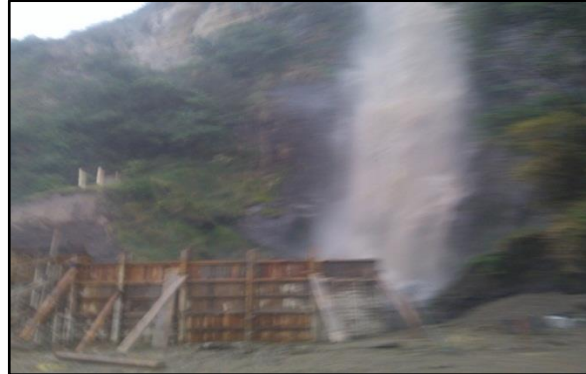
Imagen No.42 Formaleta segunda sección de muros Box Coulver k34+190, en una lluvia intensa
