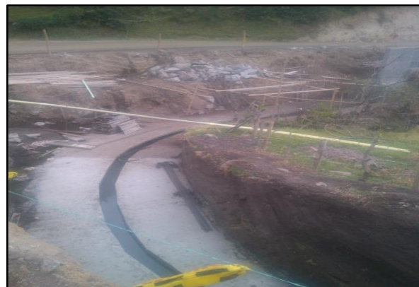
Imagen No.57. Solado de limpieza y excavación del dentellón k28+880
