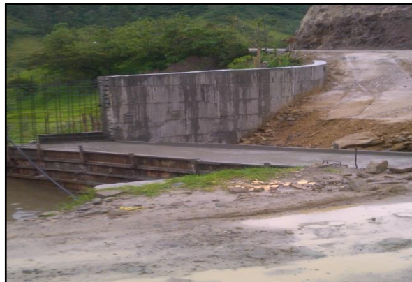
Imagen No.62. Fundición de losa superior box coulver k28+910
