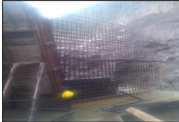
Imagen No.31. Acero vertical y horizontal de muro de contención
