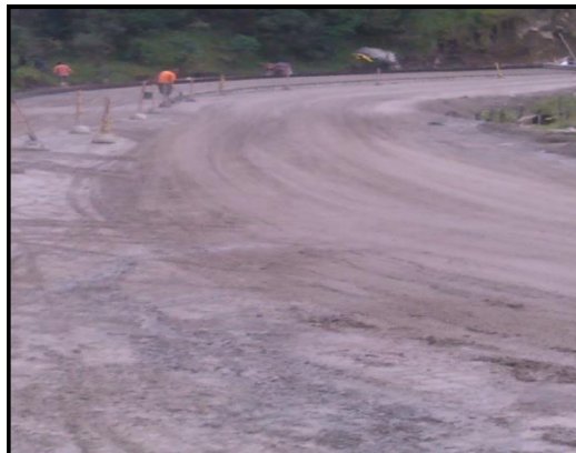
Imagen No.65. Compactación de subbase k34+150
