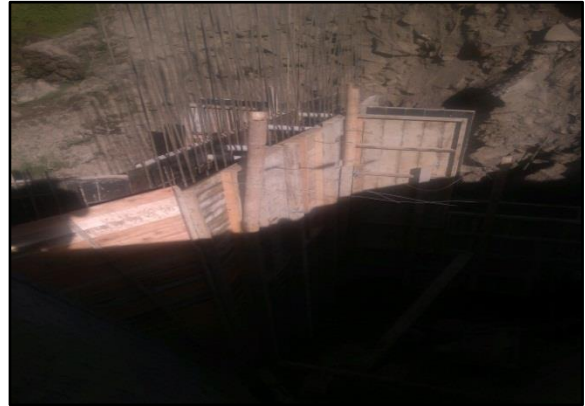
Imágenes No.39. Proceso de fundición muro de contención y contrafuerte Box coulver k34+190
