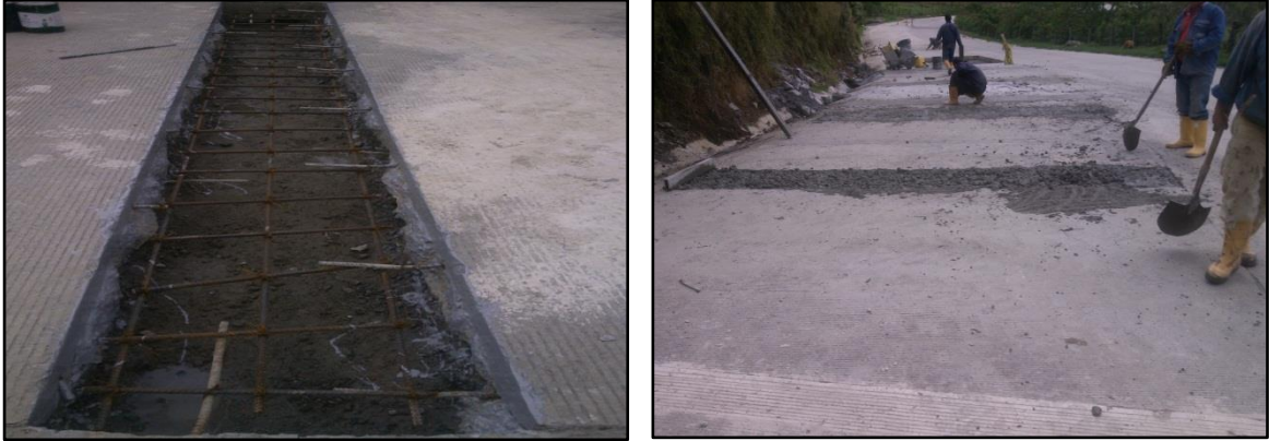
Imágenes No.24. Reparaciones con concreto Mr40
