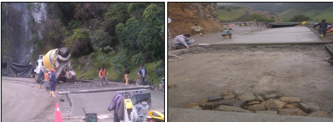
Imágenes No.67 Pavimentación K34+347 y k34+370 respectivamente
