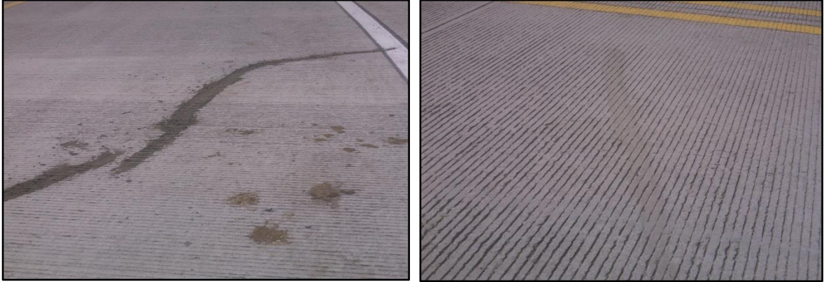
Imágenes No.25. Reparación de losas con fisuras
