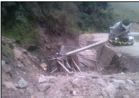
Imágenes No.40. Terminación de la primera sección del muro y contrafuerte Box Coulver k34+190 Muro izquierdo y derecho respectivamente
