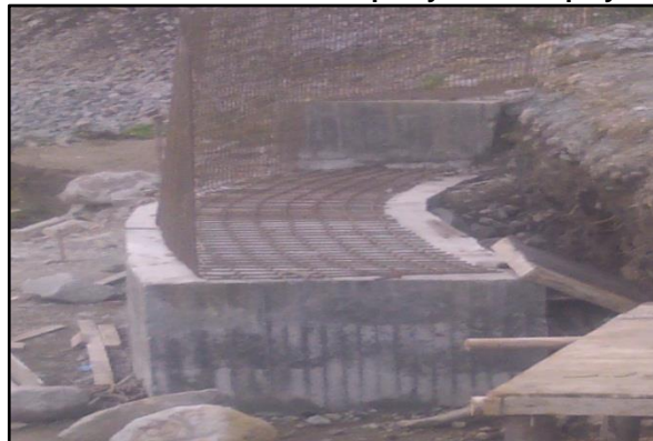
Imagen No.46. Cimentación concreto ciclópeo y acero zarpa y vástago k34+330
