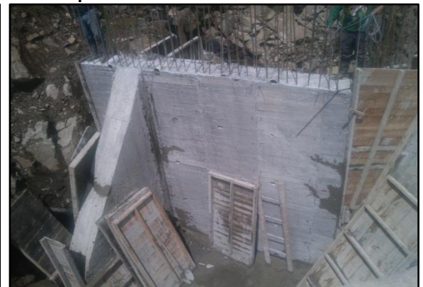
Imágenes No.40. Terminación de la primera sección del muro y contrafuerte Box Coulver k34+190 Muro izquierdo y derecho respectivamente
