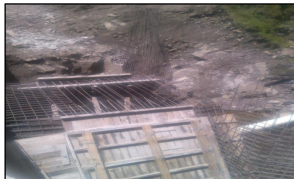
Imagen No.32. Formaleta de los muros laterales del Box coulver k34+190
