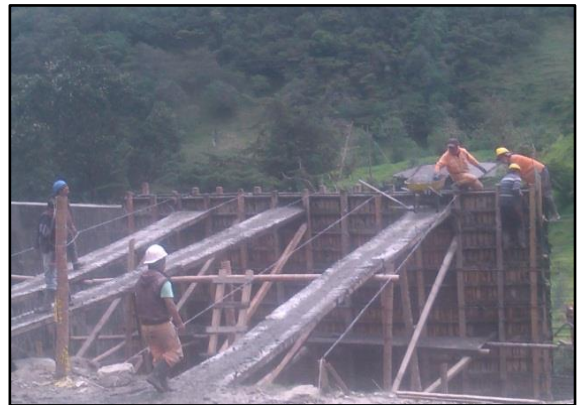
Imágenes No.60. Fundición del muro k28+880
