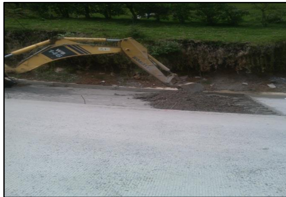
Imagen No.19. Escarificación de material de subbase
