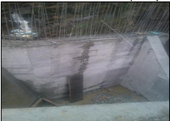
Imágenes No.40. Terminación de la primera sección del muro y contrafuerte Box Coulver k34+190 Muro izquierdo y derecho respectivamente
