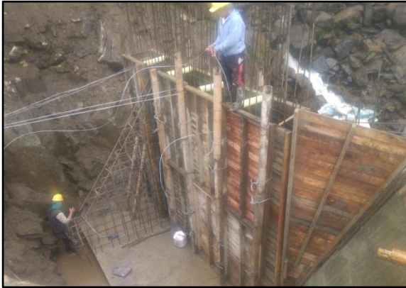
Imágenes No.39. Proceso de fundición muro de contención y contrafuerte Box coulver k34+190
