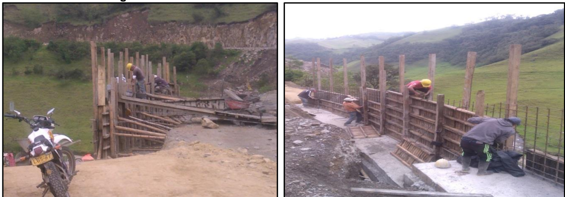
Imágenes No.47. Colocación de formaleta en 3 secciones k34+330
