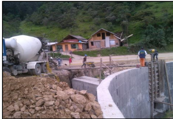
Imagen No.63. Fundición tramo final del muro k28+880
