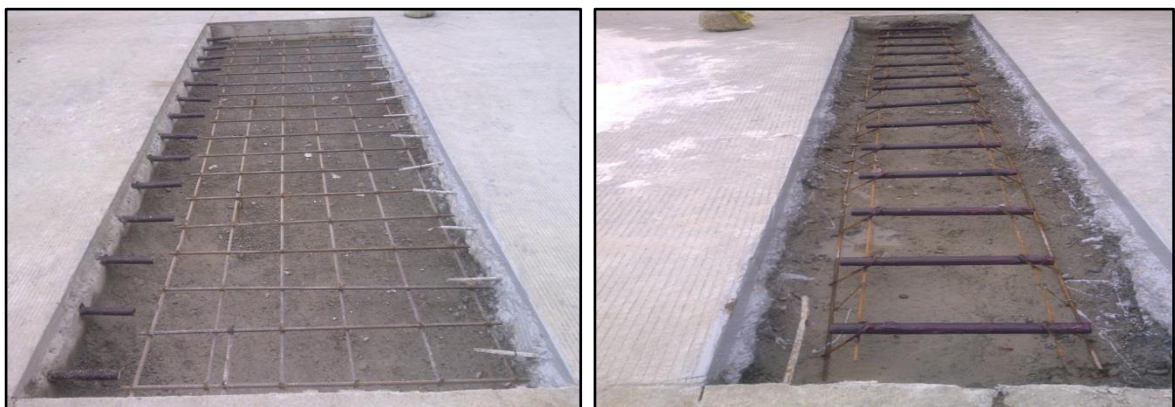
Imágenes No.20. Colocación de parrillas y canastillas respectivamente
