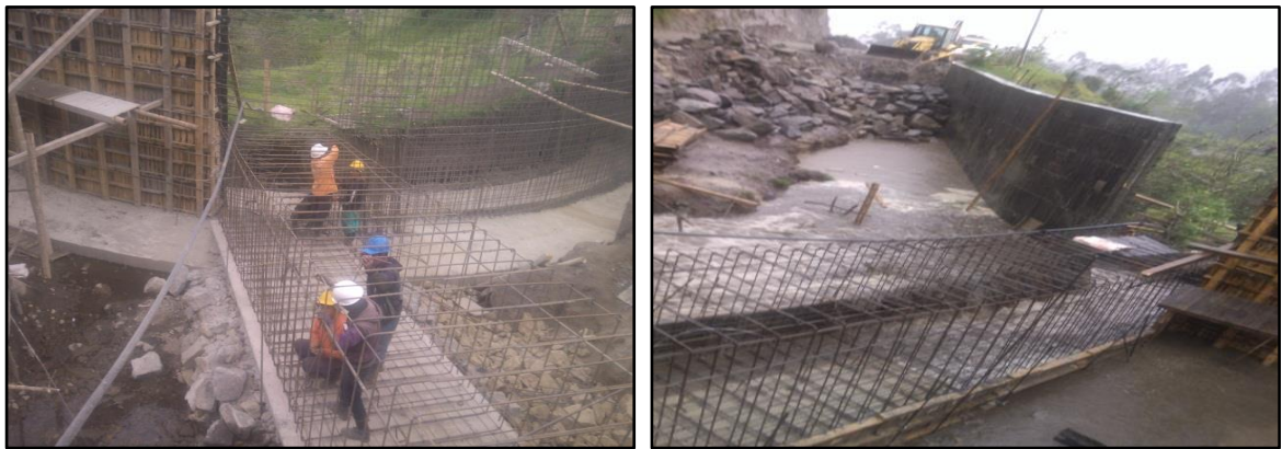
Imágenes No.61. Disposición de acero del box coulver y fundición de la losa inferior k28+910
