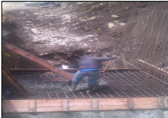
Imágenes No.41. Fundición losa superior Box Coulver k34+190
