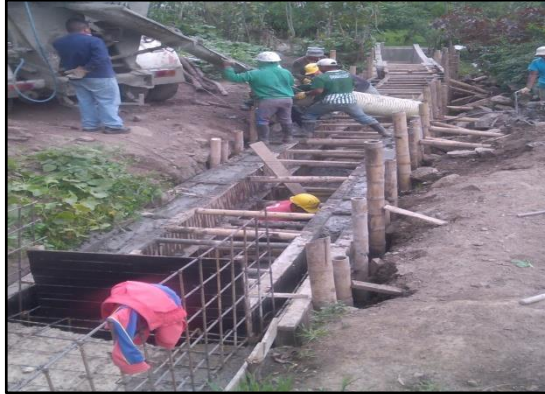
Imagen No.71. Proceso constructivo disipador hidráulico
