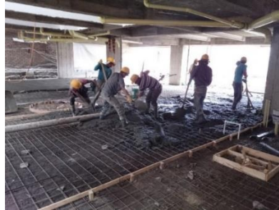
Figura No. 30 Fundición losa parqueadero T-A
