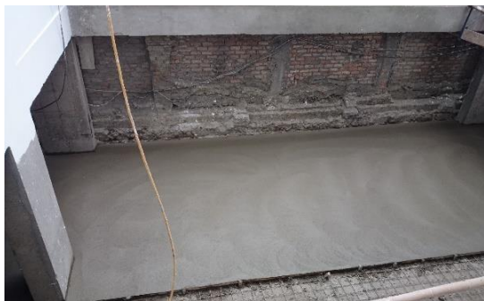
Figura No. 33 Losa parqueadero T-A pulida con fratasadora
