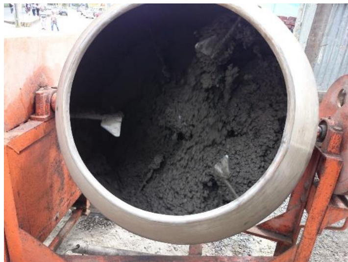
Figura No. 22 Trompo produciendo el concreto de la obra
