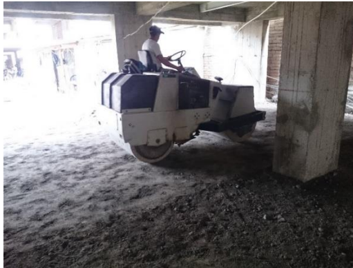
Figura No. 28 Compactación de sub base con rodillo
