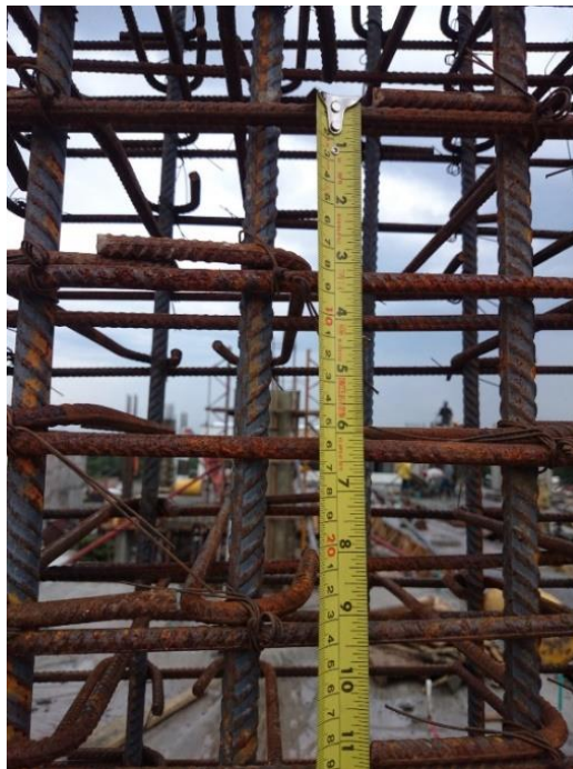
Figura No. 17 Chequeo cantidades de acero y distribución
