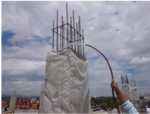
Figura No. 23 Curado columnas T-B
