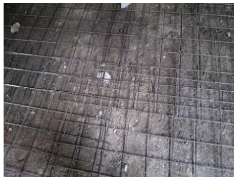
Figura No. 29 Malla electro soldada colocada con panelas
