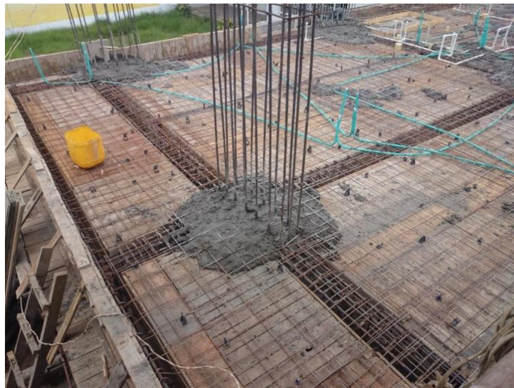
Figura No. 12 Fundición de concreto de nudos 28 Mpa
