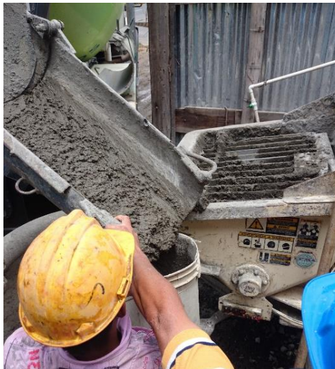
Figura No. 38 Toma de muestras de concreto para la realización de cilindros y ensayos de asentamiento 4
