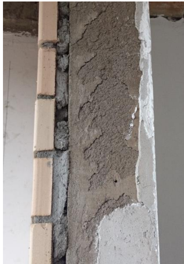
Figura No. 54 Fachaleta sobre muro de mamposteria
