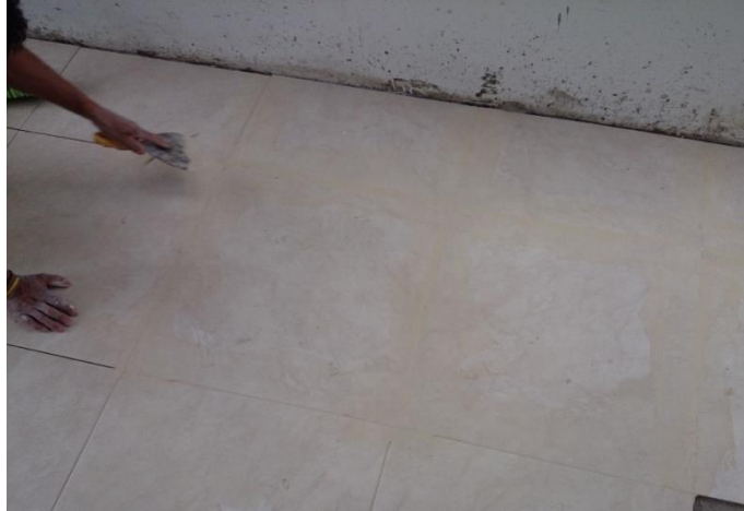
Figura No. 64 Emboquillado de ceramica
