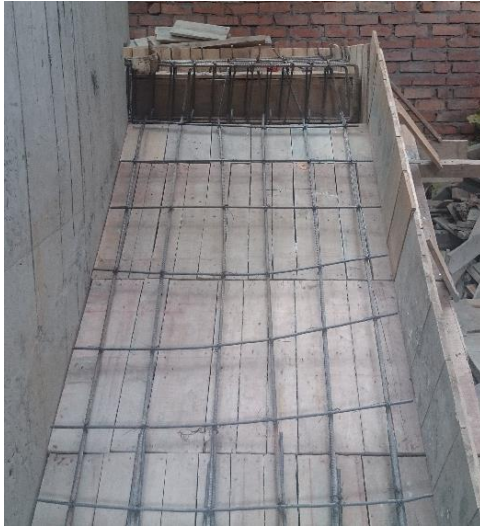
Figura No. 36 Colocación formaleta y acero en escaleras piso 1 al piso 2 T-B
