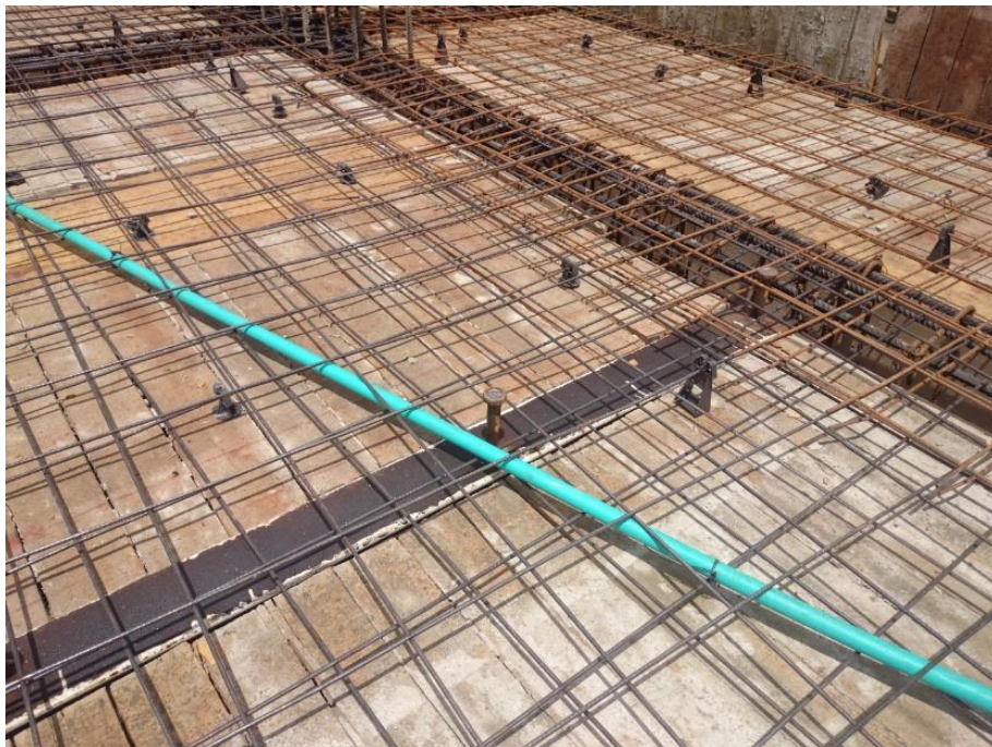
Figura No. 7 Silletas FORZA para garantizar recubrimiento
