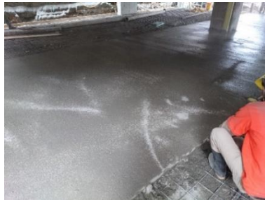
Figura No. 31 Colocación del endurecedor de pisos en losa parqueadero T-A
