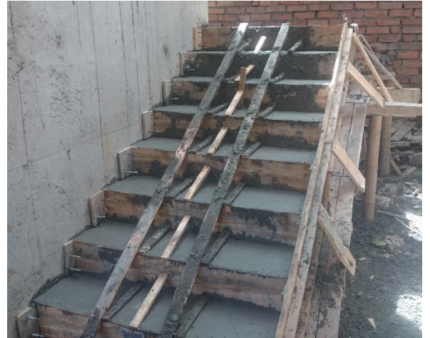
Figura No. 37 Escaleras 1-2 Fundidas T-B
