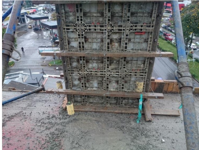
Figura No. 18 Plomada en las columnas
