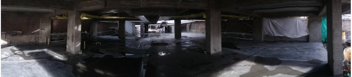
Figura No. 34 Vista panorámica losa parqueadero T-A
