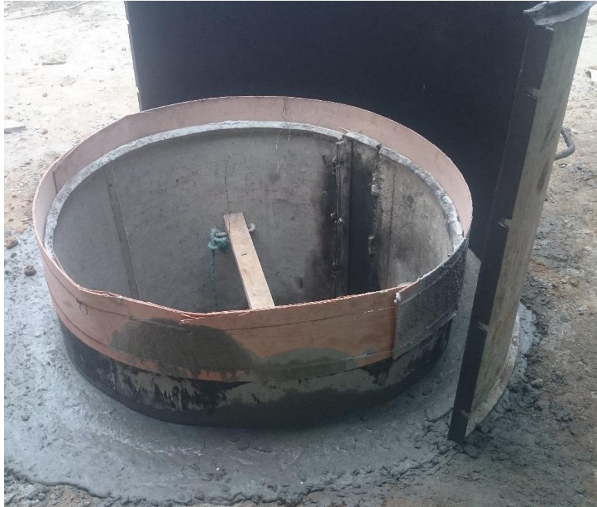
Figura No. 35 Fundición con formaleta metálica de las cámaras de inspección
