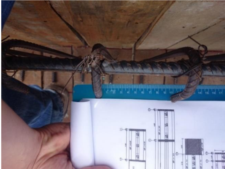
Figura No. 6 Chequeo de medidas acero estructural
