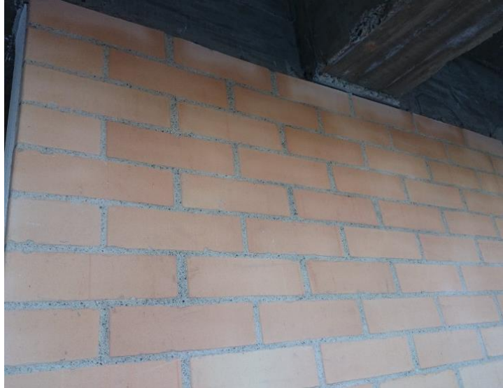
Figura No. 55 Fachaleta limpia y consistente
