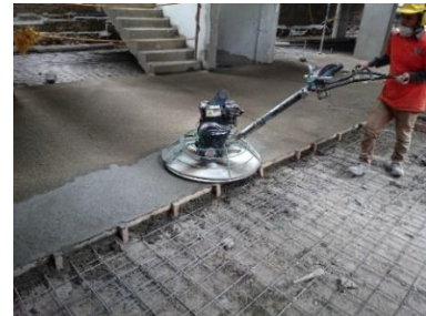
Figura No. 31 Colocación del endurecedor de pisos en losa parqueadero T-A
