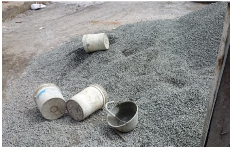
Figura No. 21 Triturado utilizado en obra
