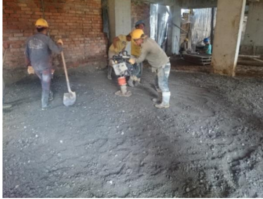
Figura No. 27 Compactación de sub base con saltarín
