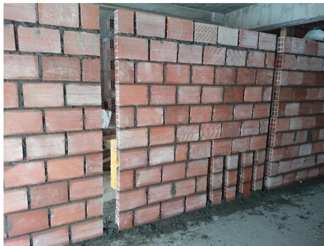
Figura No. 48 Muros construidos
