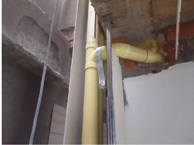
Figura No. 56 Tapado con laminas de superboard
