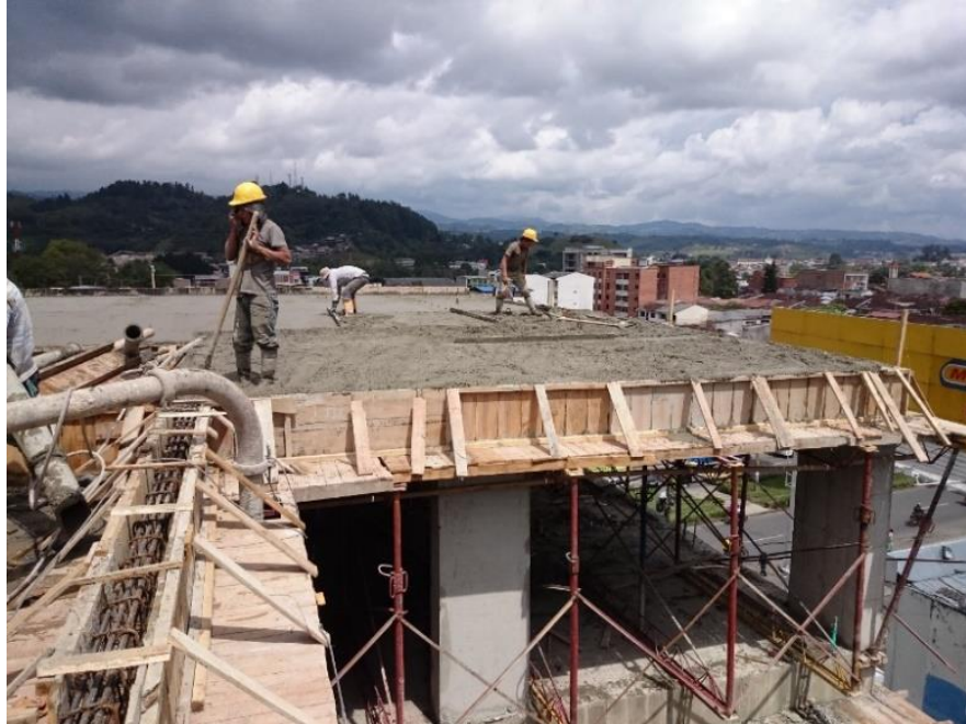
Figura No. 11 Acabado de la losa con llana
