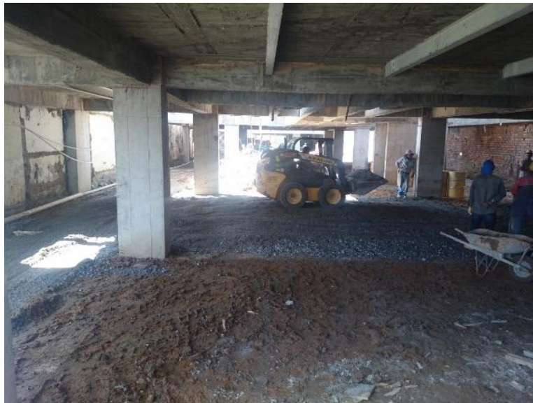
Figura No. 26 Mini cargador acarreando material de sub base
