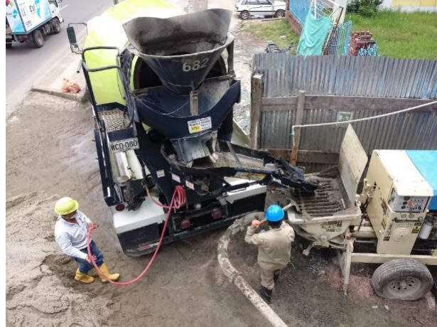
Figura No. 4 Llegada de mixer y colocación de concreto en la bomba
