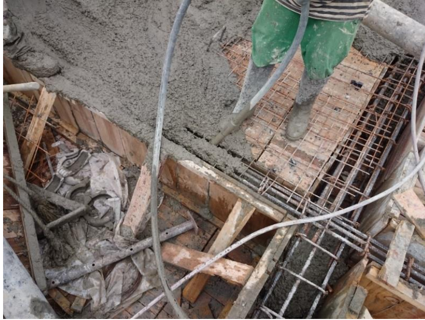
Figura No. 10 Vibrado del concreto
