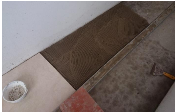
Figura No. 62 Colocacion fichas ceramica
