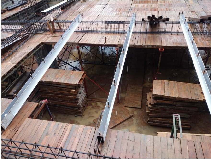
Figura No. 8 Colocación vigas IPE-200
