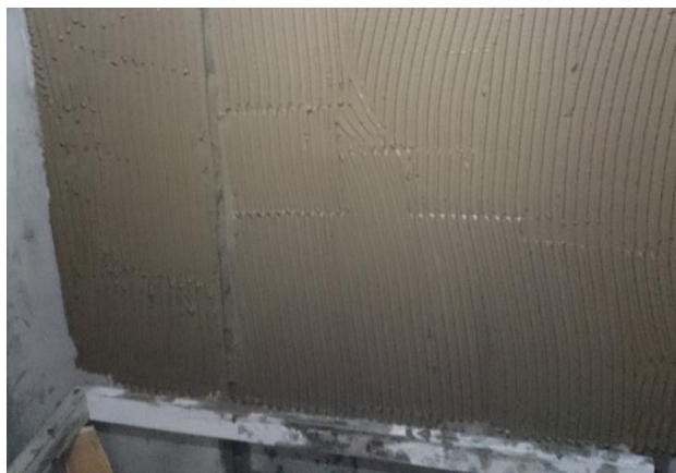
Figura No. 63 Pegaenchape sobre repello con llana dentada
