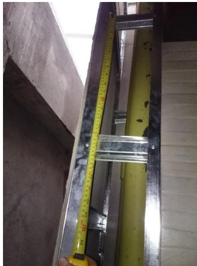
Figura No. 57 Medicion de estructura
