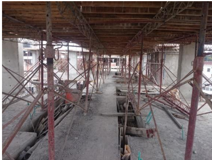
Figura No. 5 Formaleta para fundición de losa
