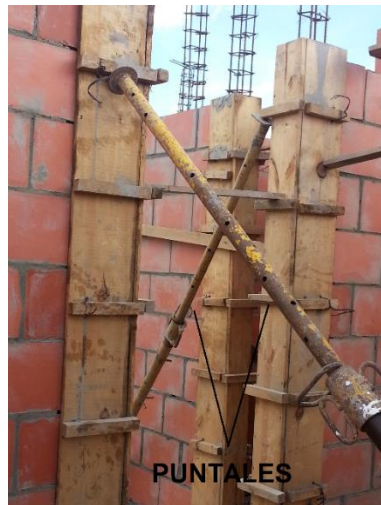
Figura No. 53 Apuntalamiento
