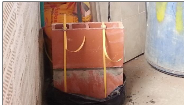
Figura No. 51 Murete
