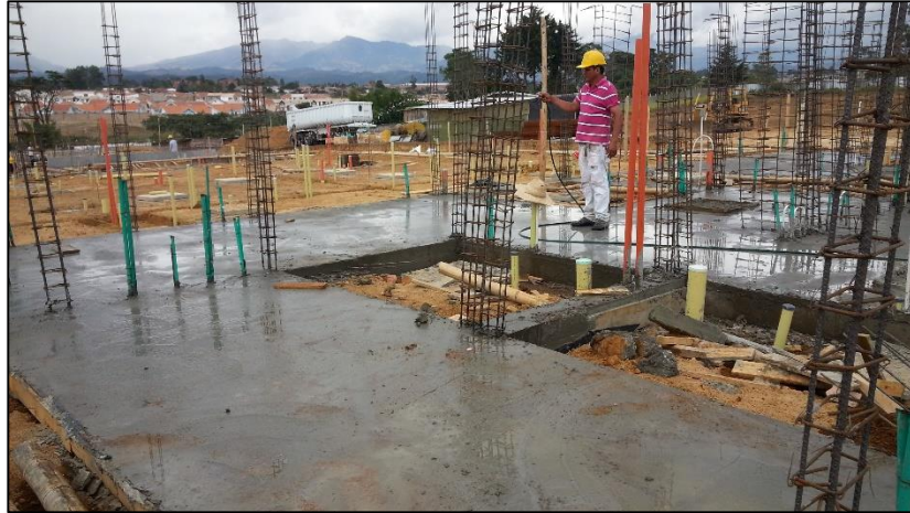
Figura No. 40 Curado de concreto con agua.
