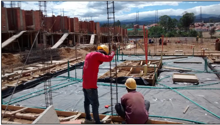
Figura No.26 Localización del acero estructural.
