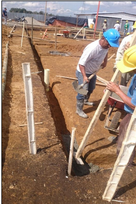
Figura No.22 Construcción solados en concreto.
