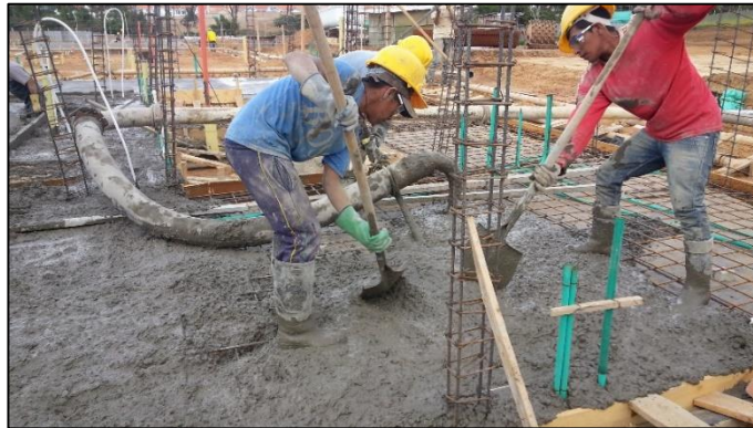
Figura No. 37 Colocación del concreto
