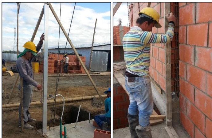
Figura No. 45 Localización de niveles mampostería
