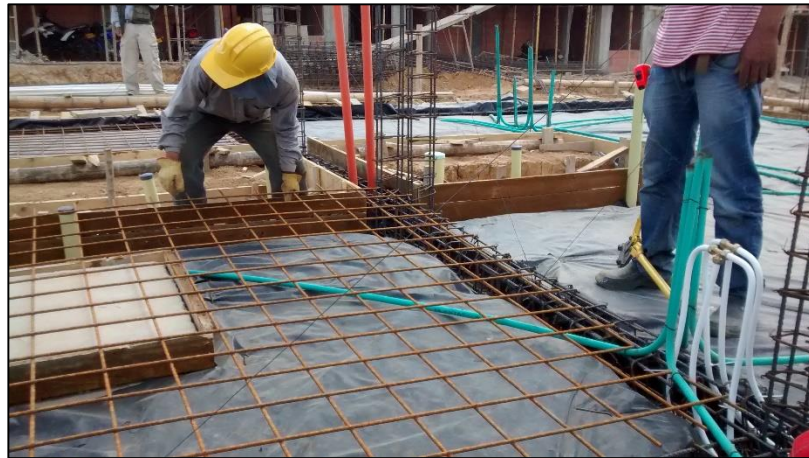
Figura No. 23 Instalación de la malla electrosoldada.
