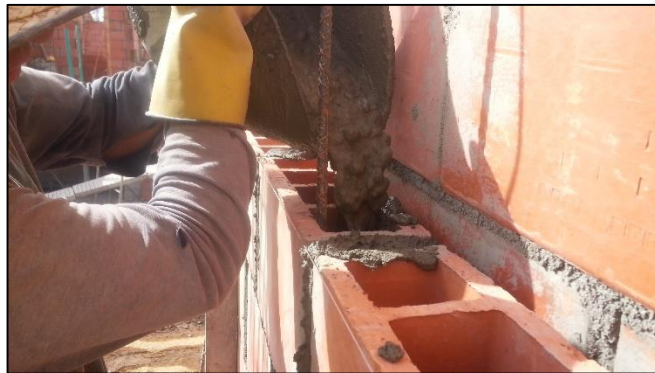
Figura No. 48 Construcción de dovelas
