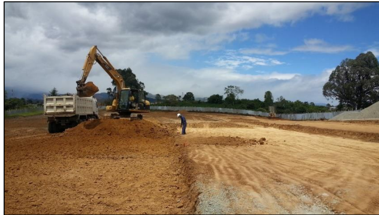
Figura No.9 Descapote y limpieza del terreno.
