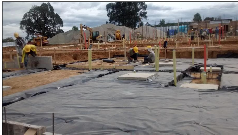
Figura No.21 Ubicación del plástico negro polisecc.
