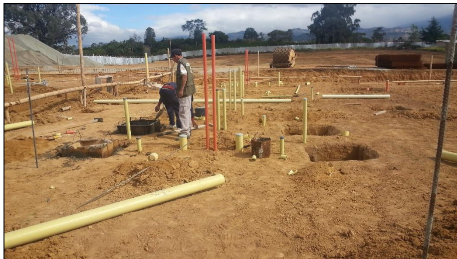
Figura No.15 Excavación de desagües y cajas de inspección.
