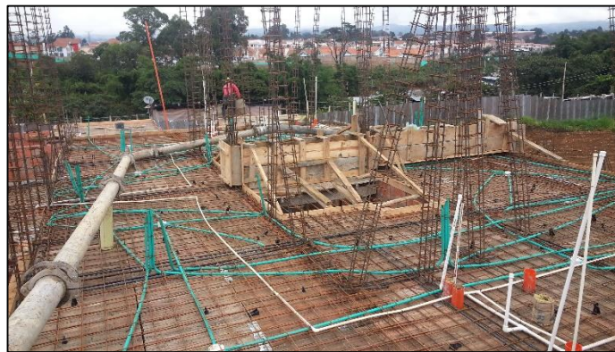
Figura No. 56 Colocación de acero de losa de entrepiso y de estructura
