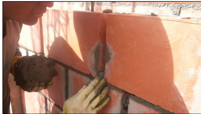
Figura No. 47 Pega de mampostería.
