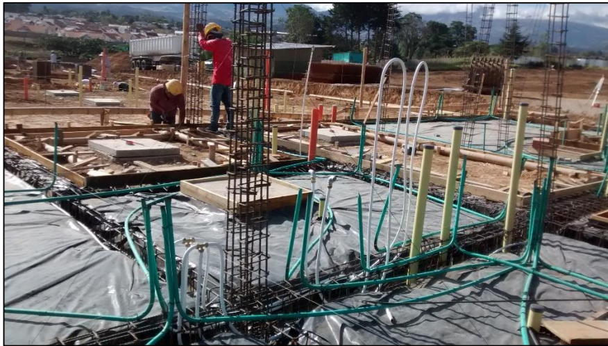
Figura No.27 Localización del acero estructural.
