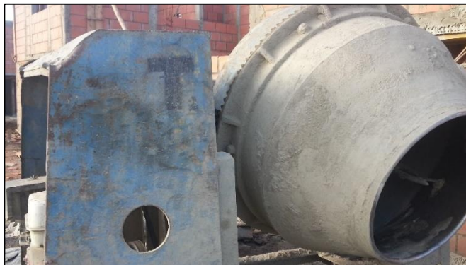
Figura No.31 Mezcladora con una capacidad de 6 pies 3 .
