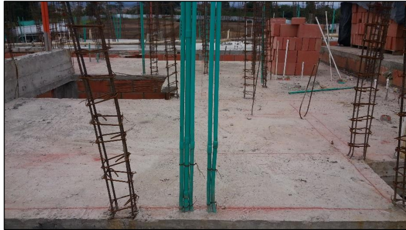
Figura No. 44 Localización y replanteo de la mampostería
