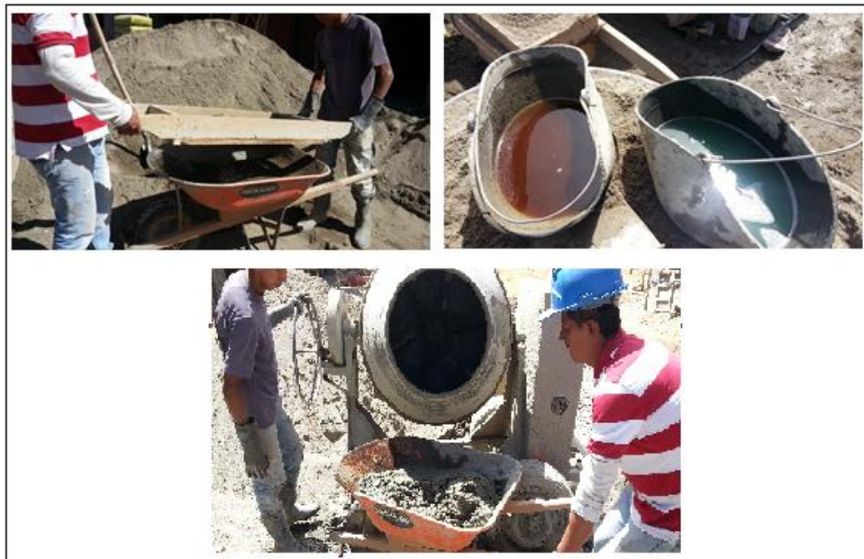
Figura No.46 Preparación del mortero de pega.
