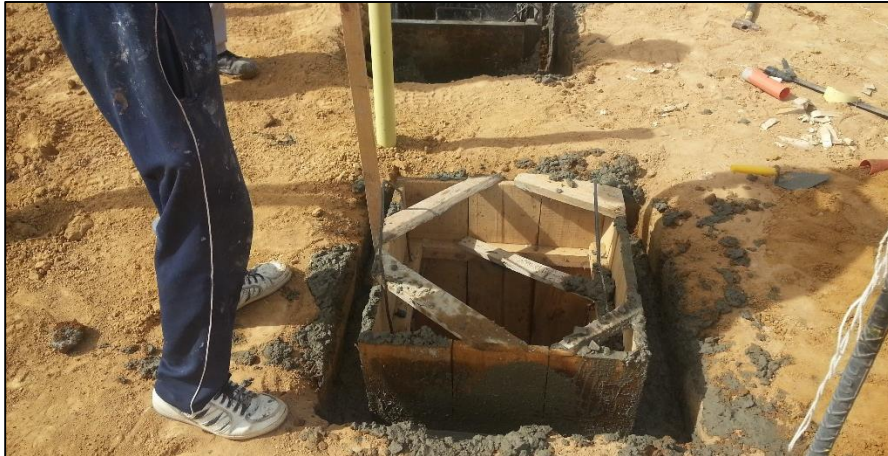
Figura No.16 Fundición de cajas de inspección.
