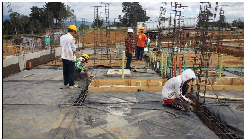
Figura No.24 Acero de refuerzo estructural.
