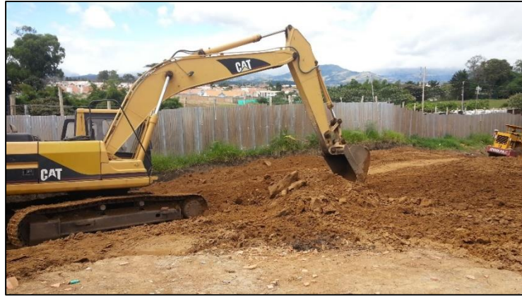
Figura No.8 Descapote y limpieza del terreno.
