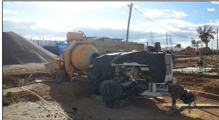
Figura No.30 Mezcladora Semco con una capacidad de 18 pies 3 y bomba de concreto.
