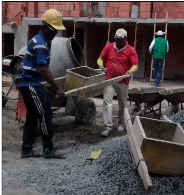
Figura No. 36 Preparación concreto en mezcladora de 1 bulto de cemento.
