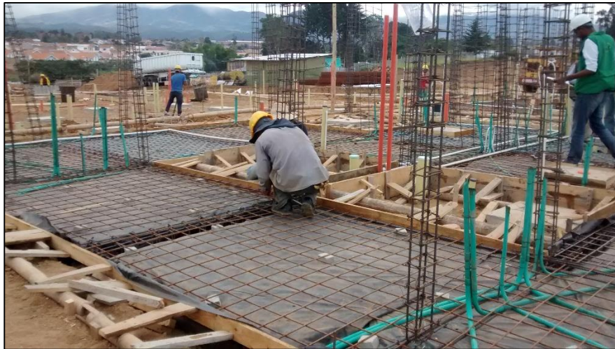
Figura No. 28 Localización del acero de estructural.
