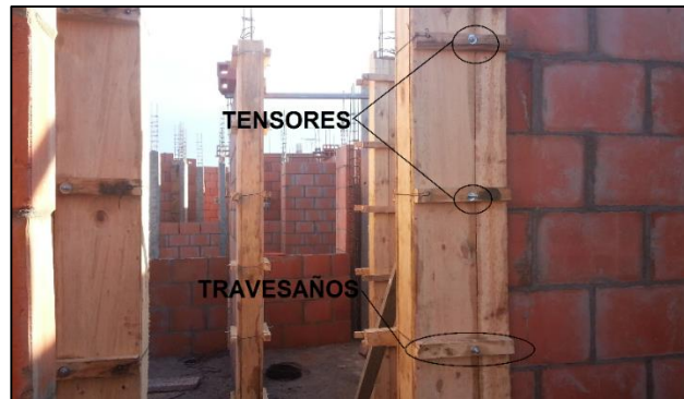
Figura No. 52 Formaleta de columnetas
