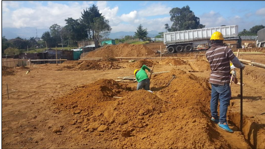
Figura No.14 Excavación de desagües y cajas de inspección
