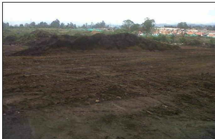
Figura No.7 Remoción de la capa vegetal.
