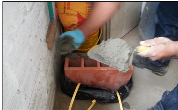
Figura No. 50 Elaboración murete
