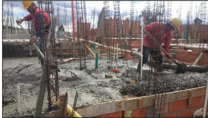
Figura No. 57 Fundición de la losa de entepiso
