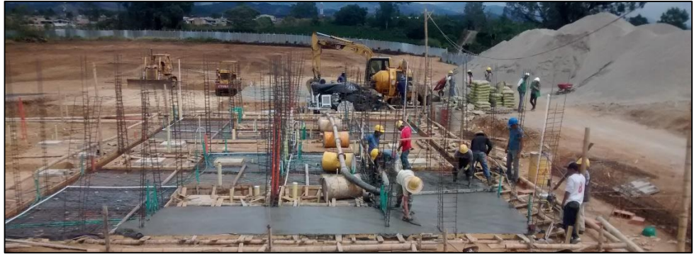
Figura No. 39 Fundición placas de cimentación.
