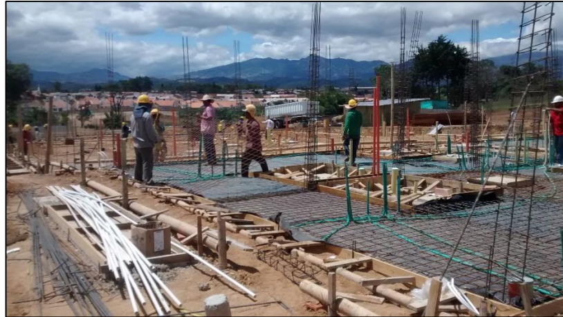
Figura No. 25 Colocación del acero de cimentación
