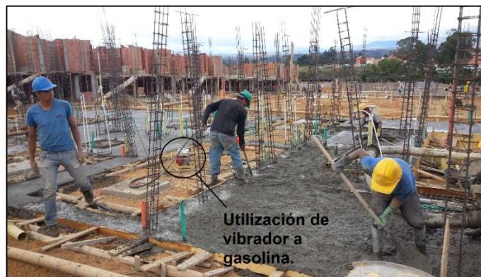
Figura No. 38 Uso adecuado de vibrador.
