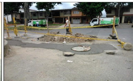
Fig. 17 Construcción de cámaras
