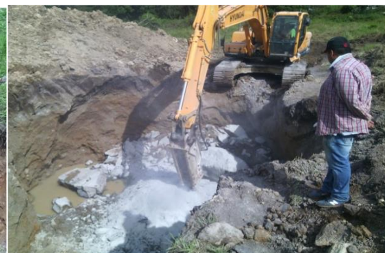
Fig. 47 Demolición de roca
