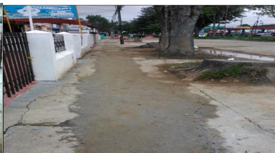
Fig. 29 Terminación de obra
