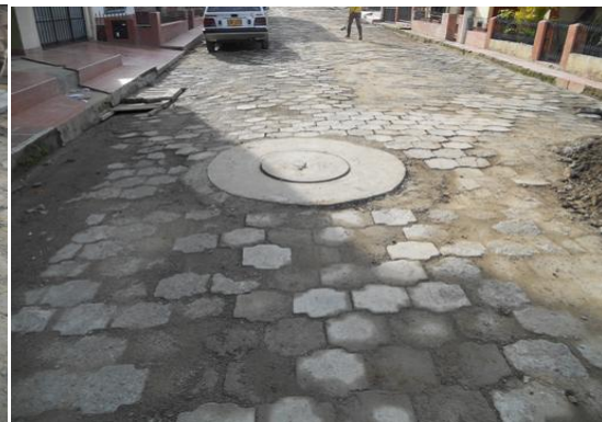
Fig. 49 Terminación de obra
