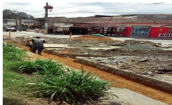
Fig. 36 Compactación de base
