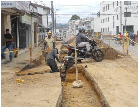
Fig. 54 Compactación de material
