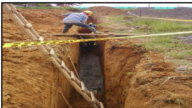
Fig. 32 Colocación de base granular
