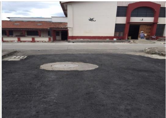
Fig. 51 Compactación de carpeta
