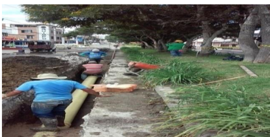
Fig. 33 Instalación de tuberías
