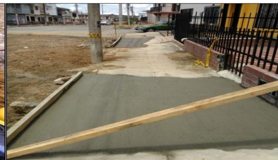
Fig. 11 Adecuación de andenes
