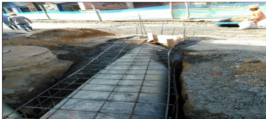
Fig. 21 Cimentación para tubería de alcantarillado
