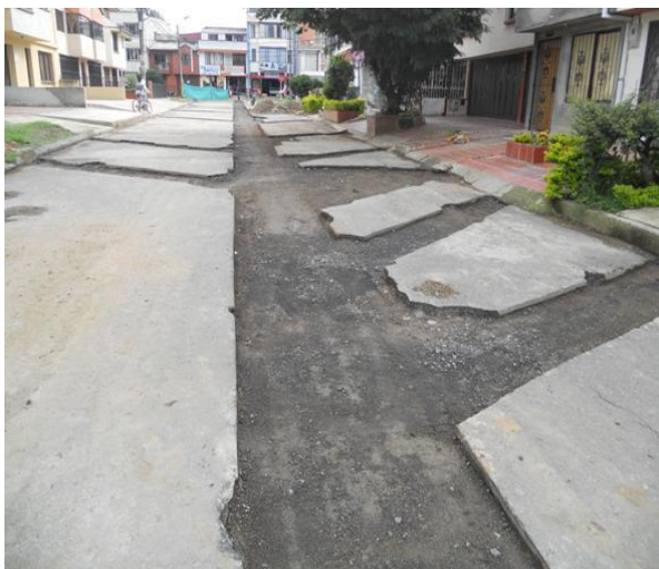
Fig. 58 Compactación de Sub-base
