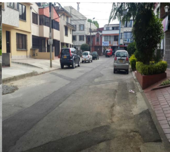
Fig. 59 Compactación de carpeta
