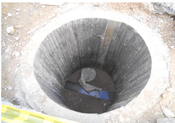
Fig. 56 Construcción de cámara
