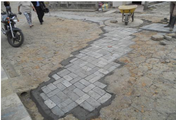
Fig. 48 Construcción de la vía
