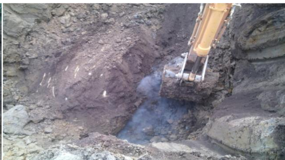
Fig. 43 Retiro del material
