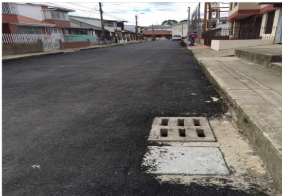
Fig. 50 Riego y compactación de carpeta
