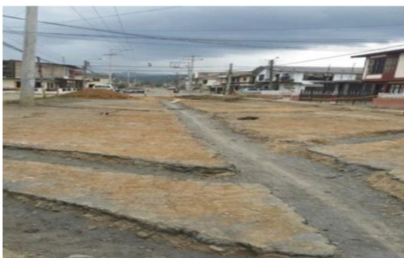
Fig. 6 Colocación de sub-base
