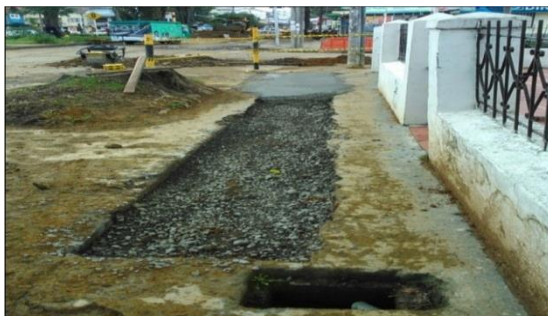
Fig. 28 Colocación de base granular
