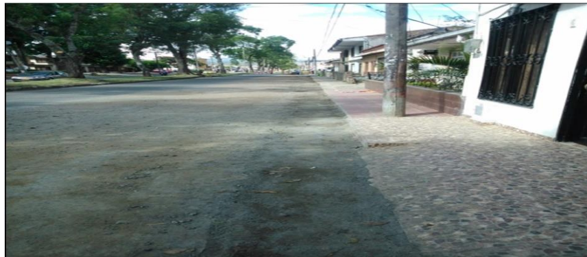
Fig. 18 Compactación de la Sub-base
