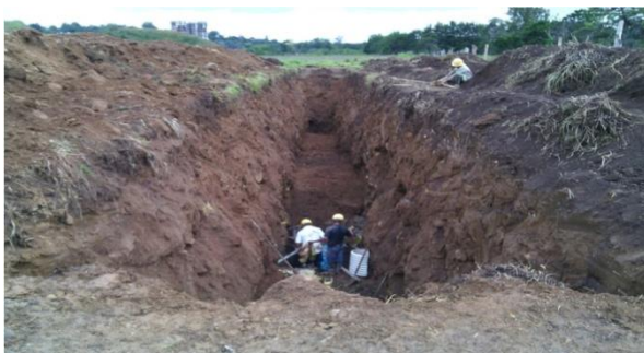
Fig. 42 Excavación manual
