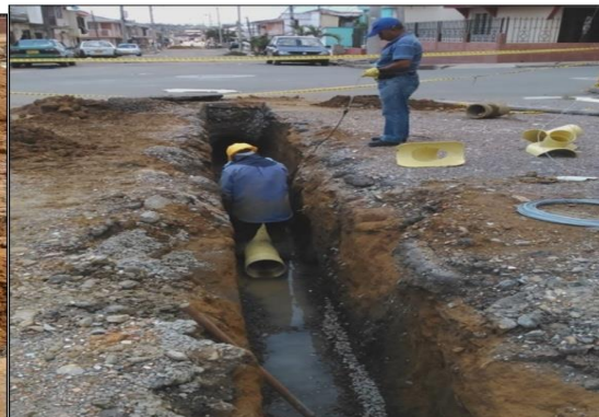
Fig. 13 Instalación de la tubería
