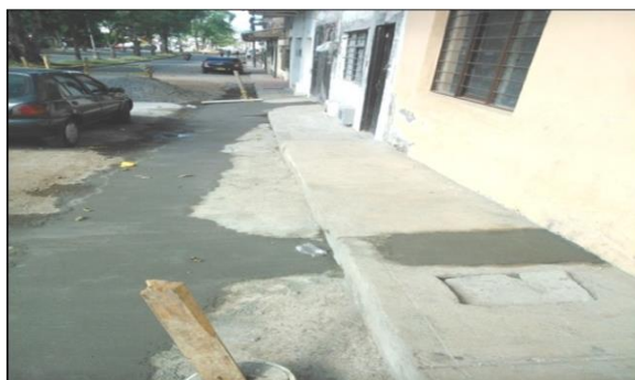
Fig. 16 Construcción de cajas domiciliarias
