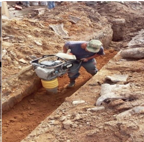
Fig. 38 Proceso de relleno
