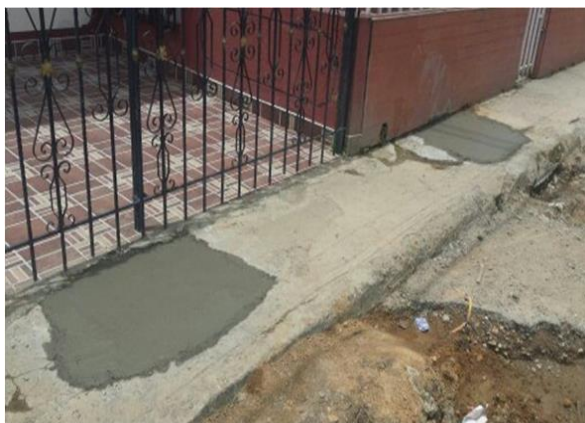
Fig. 8 Reposición de Andenes
