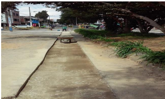
Fig. 35 Proceso de relleno
