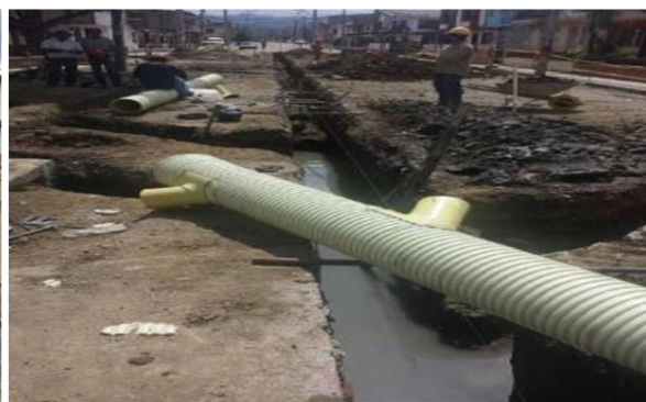
Fig. 7 Instalación de tubería y silla yee
