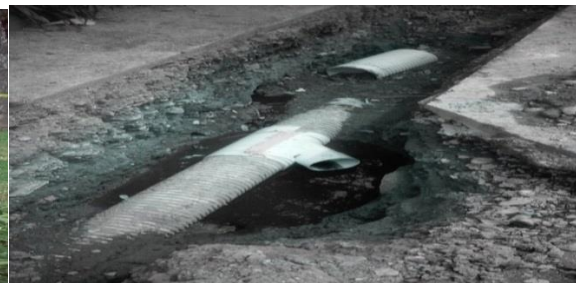
Fig. 34 Instalación de sillas
