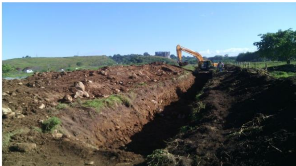
Fig. 40 Excavación con maquinaria
