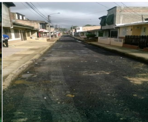
Fig. 61 Riego y compactación de carpeta
