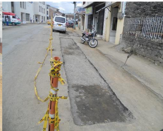
Fig. 55 Suministro de sub-base
