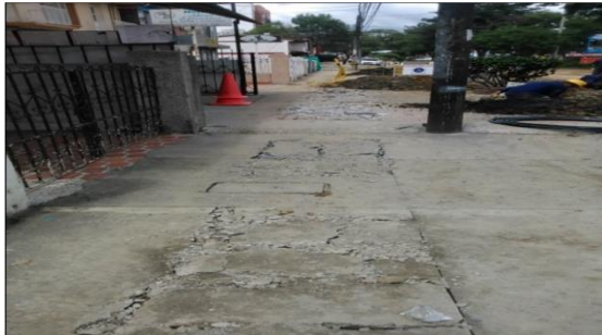
Fig. 26 Corte de concreto
