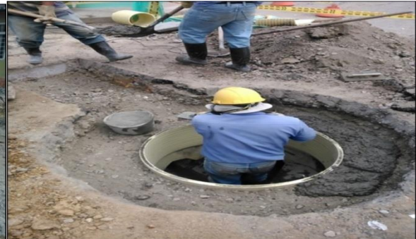
Fig. 23 Construcción de cámaras
