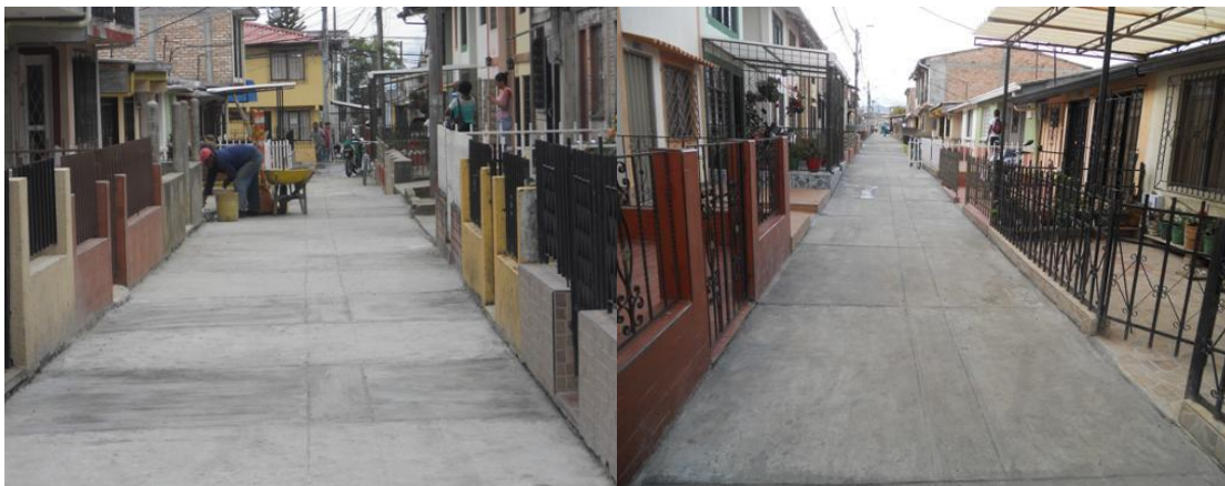
Fig. 52 Terminación de parcheo
