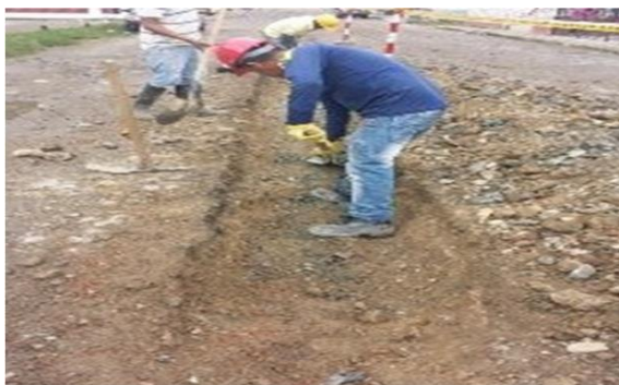
Fig. 2 Excavación en conglomerado
