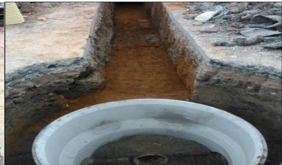
Fig. 25 Construcción de cámaras
