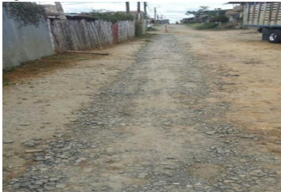
Fig. 4 Tramo terminado de sub-base
