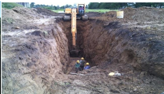
Fig. 41 Excavaciones con maquinaria
