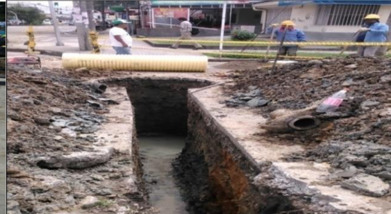
Fig. 27 Instalación de tubería
