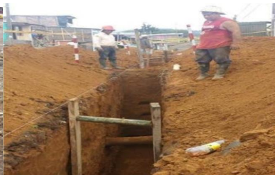
Fig. 3 Excavación y entibado
