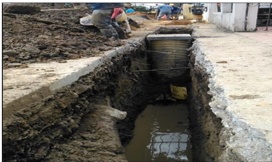
Fig. 24 Excavación y retiro de tubería
