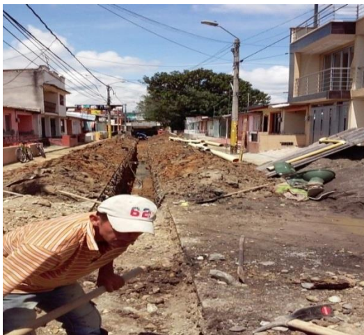
Fig. 37 Proceso de excavación
