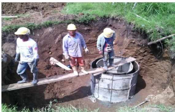
Fig. 46 Construcción de recámaras
