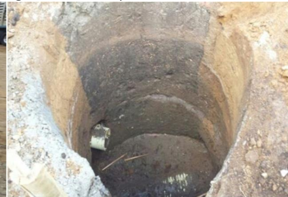
Fig. 5 Excavación para cámaras
