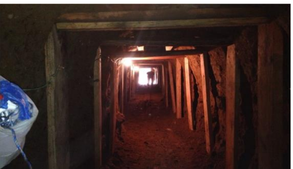
Fig. 45 Entibado del túnel
