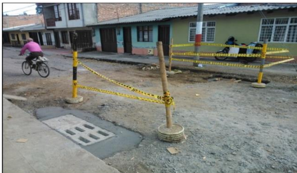
Fig. 22 Construcción de sumidero
