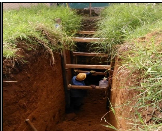
Fig. 31 Entibado y apuntalado
