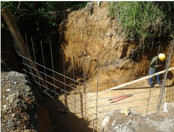
*Fig. 28. Continúan las labores de los cabezales de alcantarillas*
