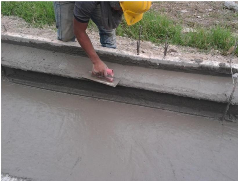
*Fig. 48. Terminados de cunetas y entradas.*
