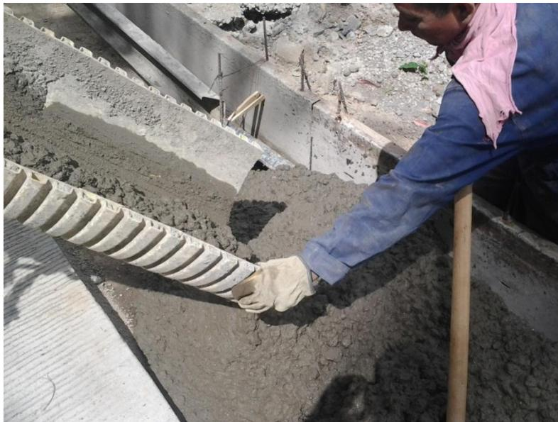
*Fig. 43. Fundición de losas y cunetas de concreto.*
