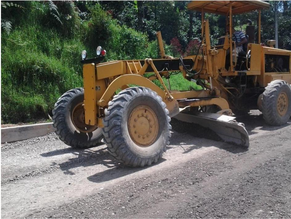
*Fig. 29. Se realiza nivelación del terreno con un operador calificado*
