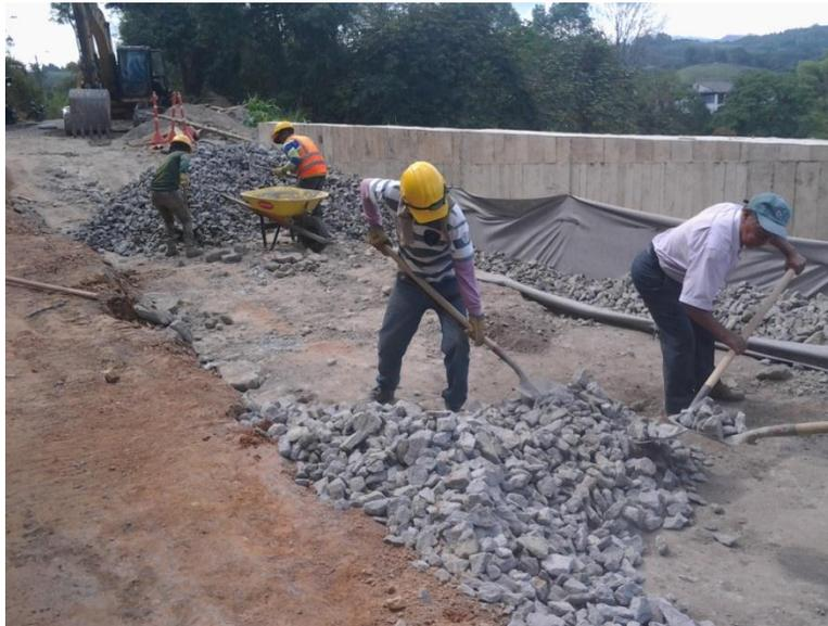
*Fig.42. se realiza el segundo muro de contención.*
