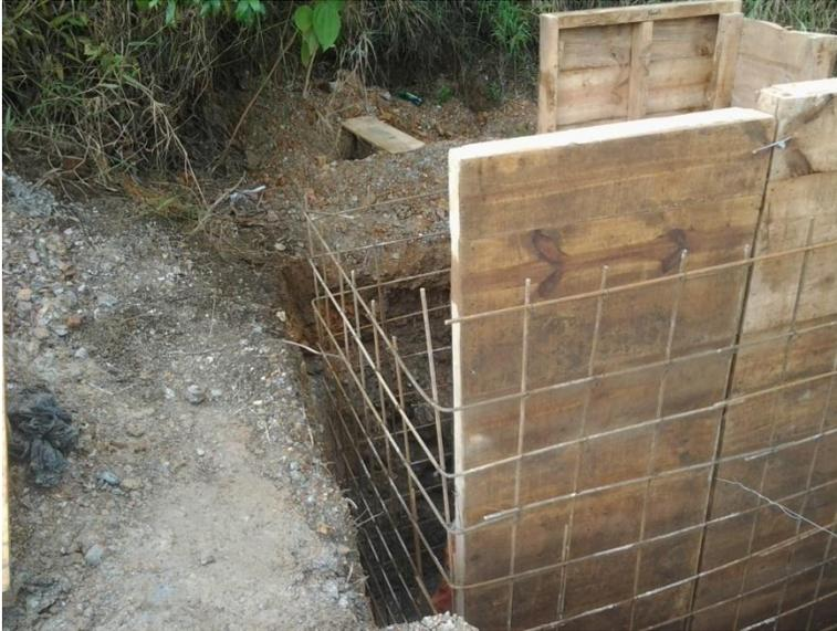
*Fig. 17. Se continúa con el encofrado de cabezales.*
