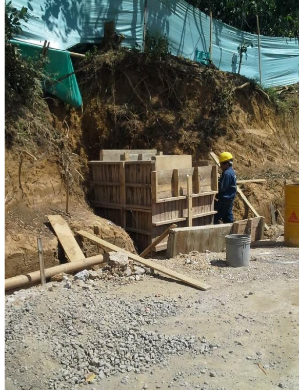
Figura 56. Formaleta de caja de inspección.
