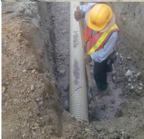
Figura 64. Suministro de tubería de 10in.
