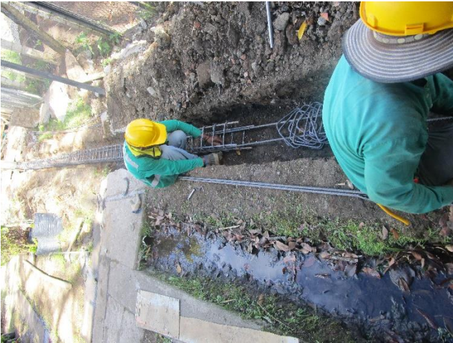
Figura 29. Aceros para viga de cimentación.
