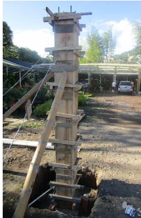
Figura 30. Formaleta para columna.
