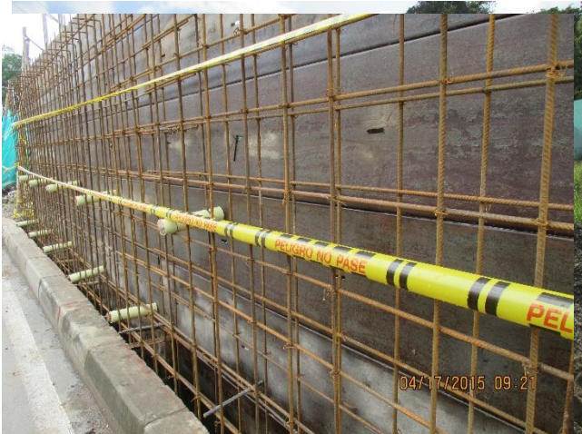
Figura 08. Fundición de zarpa con concreto premezclado transportado en mixer.
