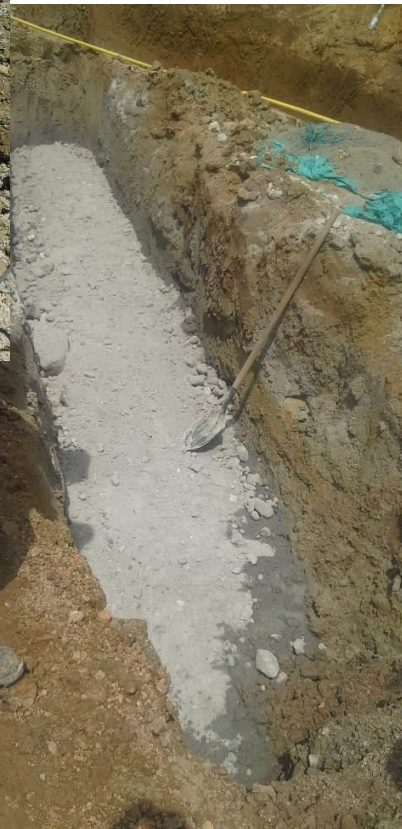
Figura 65. Compactación de material para relleno de excavación.
