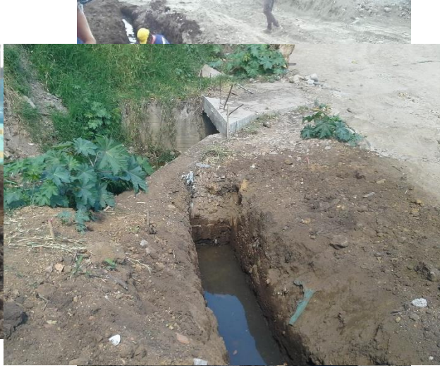
Figura 26. El agua que evacua el filtro y se lleva hasta un boxculvert existente en K0+217
