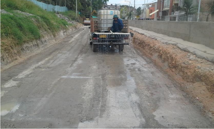
Figura 49. Extendido de material de mejoramiento.
