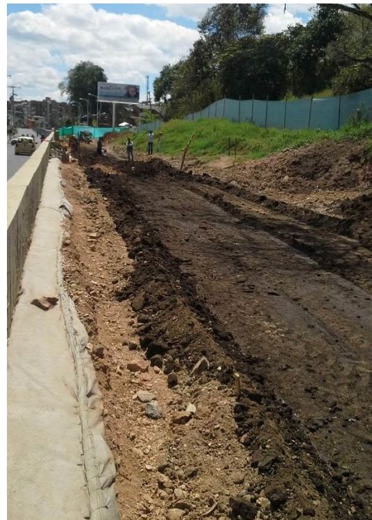
Figura 48. Tramo de prueba entre K0+551 hasta K0+503.
