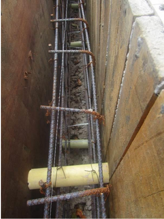
Figura 10. Segmentos de tubos, utilizados para lagrimales.
