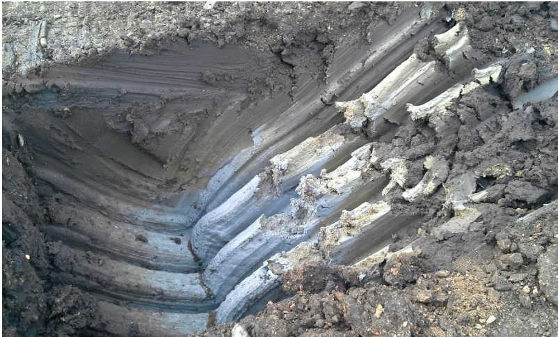
Figura 46. Apique con material arcilloso color gris y humedad alta.
