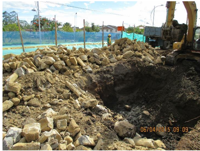
Figura 21. Disposición de material de mejoramiento para contener talud a lado
