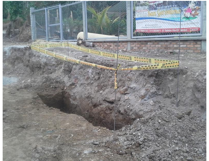
Figura 68. Excavación para sumidero K0+395.
