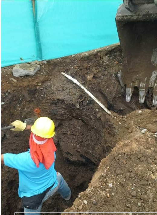
Figura 28. Excavación del canal para Figura 27. Excavación en predio 01.
