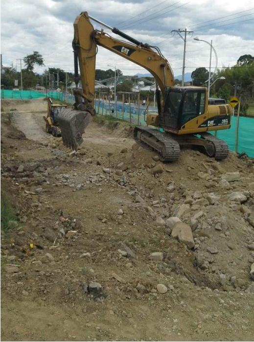
Figura 20. Extendida de material de mejoramiento
