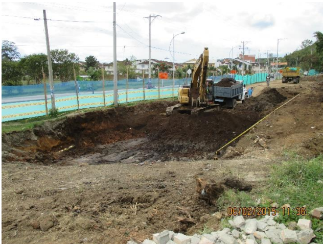
Figura 18. Excavación para llegar a nivel de subrasante.
