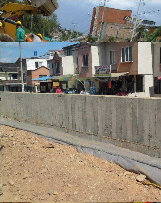
Figura 12. Relleno de filtro utilizando la retroexcavadora de llantas.
