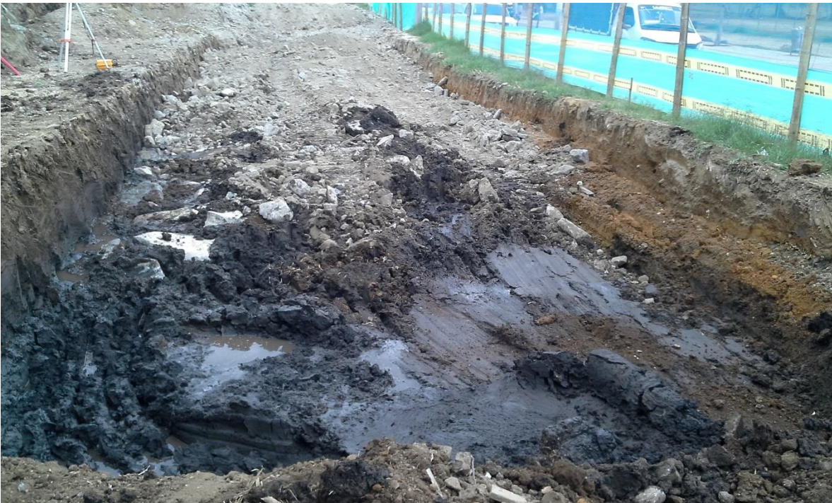
Figura 22. Suelo con alto contenido de materia orgánica y humedad, encontrado durante la excavación para la calzada.
