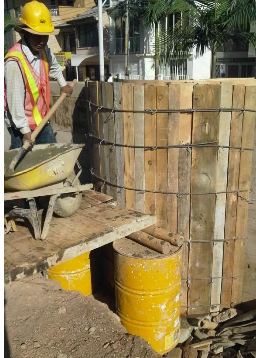
Figura 33. Fundición de empate de muro.
