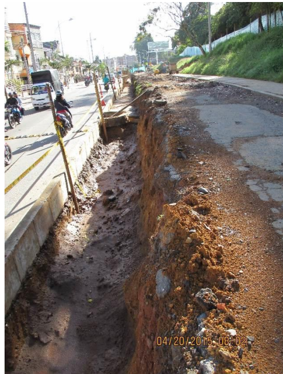
Figura 05. Excavación para zarpa.
