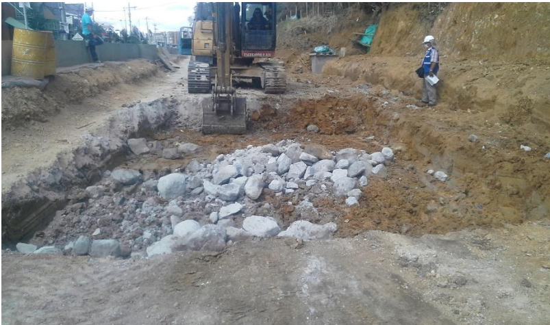
Figura 61. Material de mejoramiento para reemplazo en fallos.
