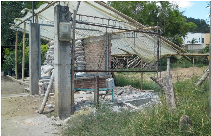
Figura 31. Demolición de estructuras de cerramiento.
