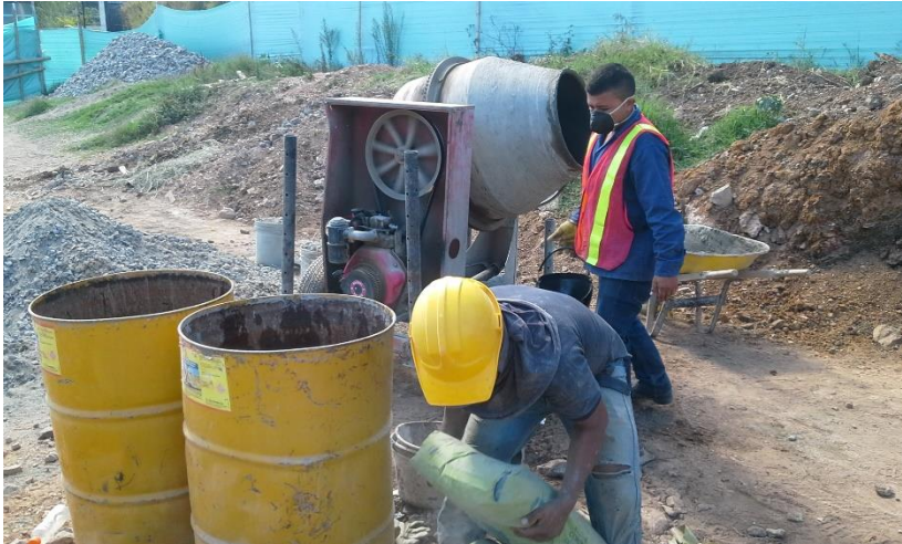
Figura 35. Elaboración de la mezcla de concreto.
