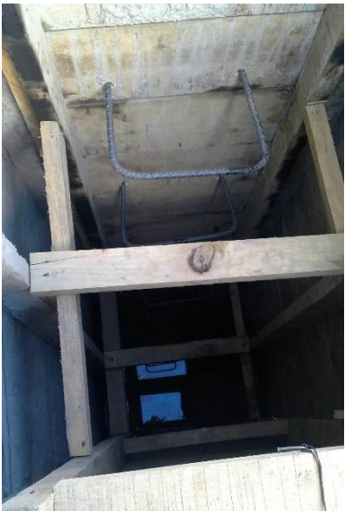
Figura 57. Vista al interior de la formaleta de caja de inspección.
