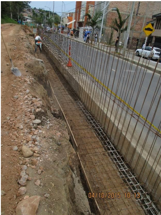
Figura 04. Aceros de muro en la base.
