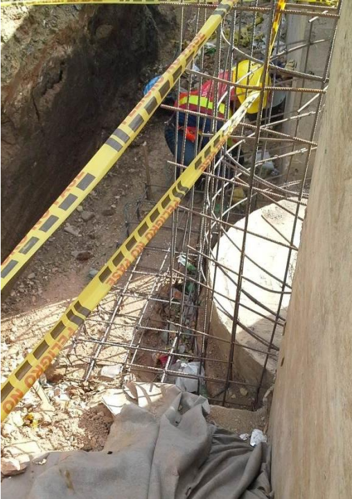
Figura 32. Aceros para empate de muro.
