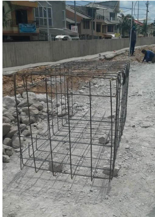
Figura 54. Estructura de acero para caja de inspección.
