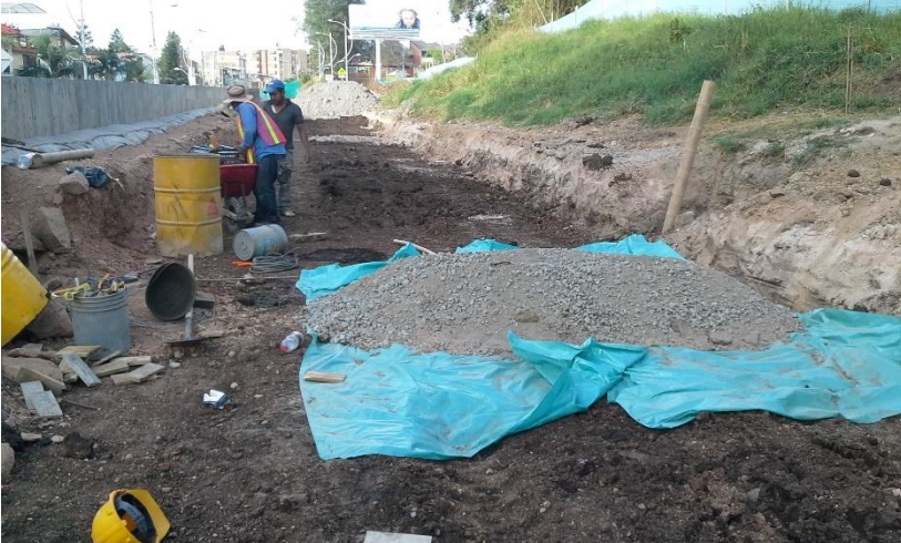
Figura 34. Arena y triturado para concreto.
