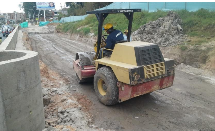
Figura 52. Compactación de la subrasante.
