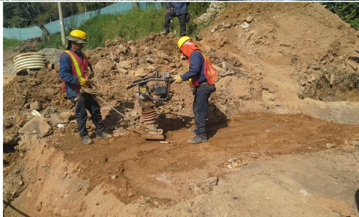
Figura 42. Relleno y compactación de excavación para tubería.
