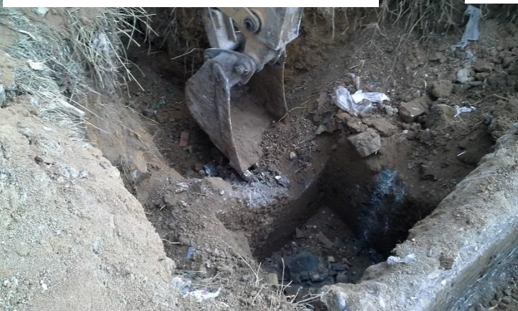
Figura 39. Excavación manual frente al muro cabezal.
