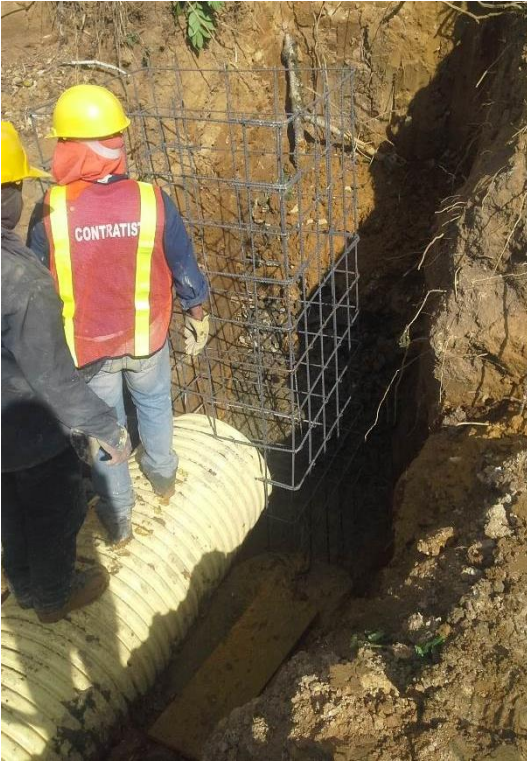
Figura 55. Estructura de acero para caja de inspección y tubería de 24".
