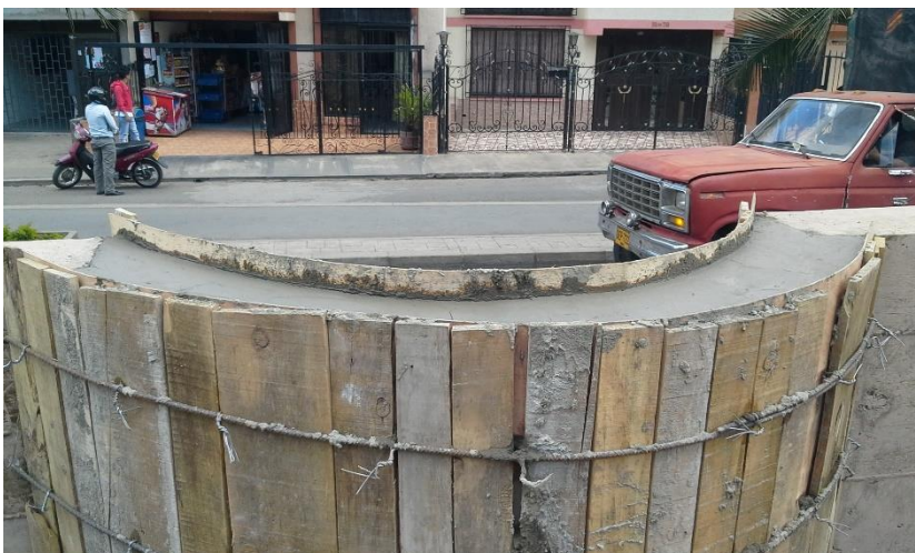
Figura 37. Muro fundido (parte superior).
