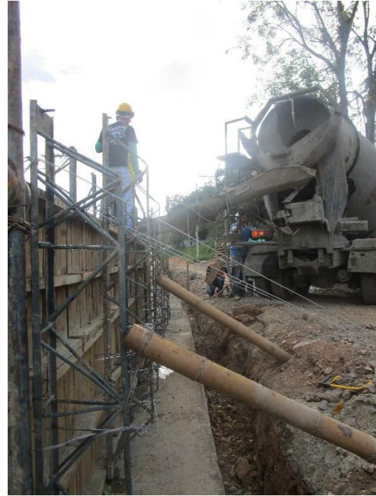
Figura 11. Fundición de último tramo de muro con concreto premezclado, en mixer.
