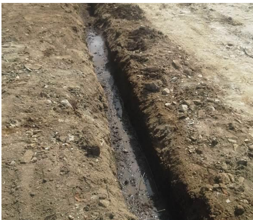
Figura 25. Filtro evacuando el agua represada.
