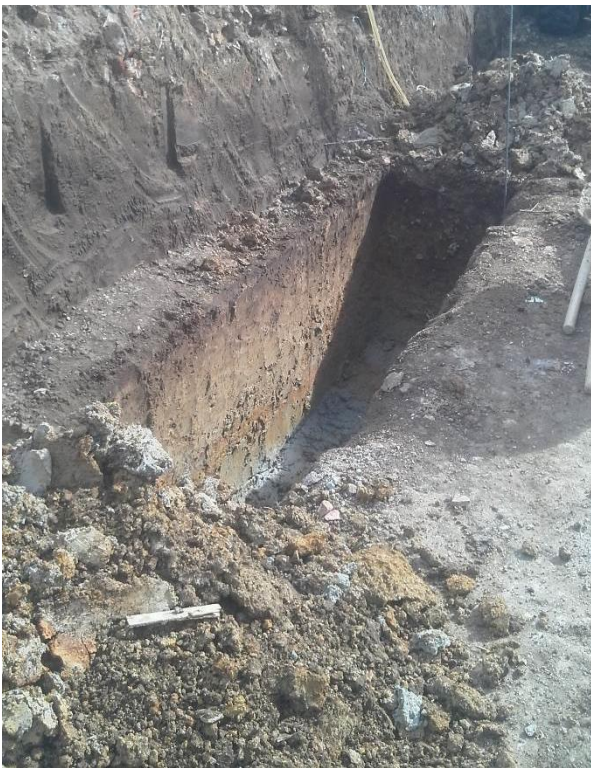
Figura 67. Excavación para sumidero K0+425.
