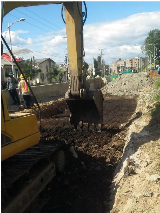
Figura 47. Excavación de la calzada con un ancho de 5m.
