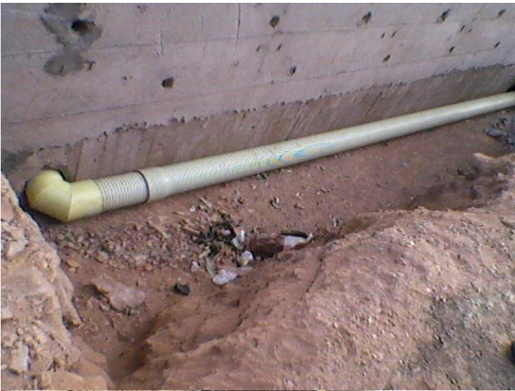
Figura 15. Instalación de tubería de 8 in para sumidero que se encuentra en la calzada de la Etapa I.
