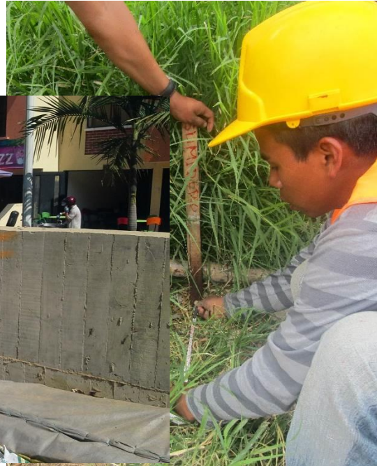
Figura 13. Ubicación de los sumideros con estacas.
