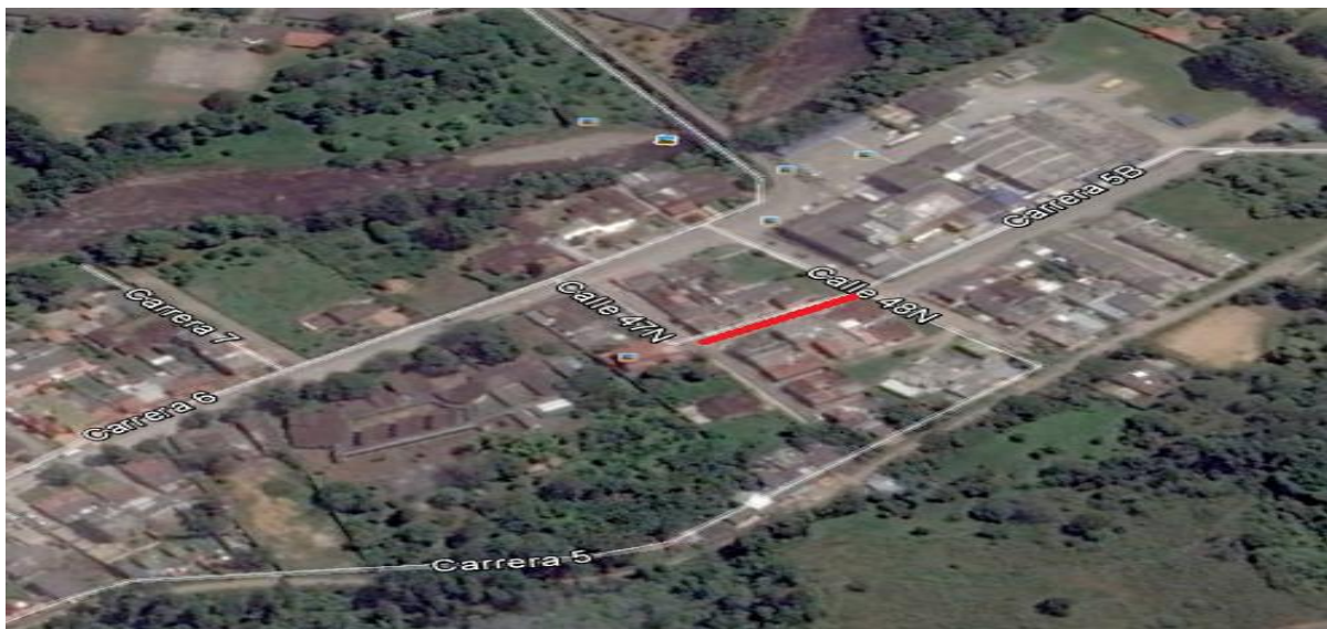
Fig. 4.10. Localización carrera 5b entre las calles 47n y 48n, sector lácteos. ( — )
