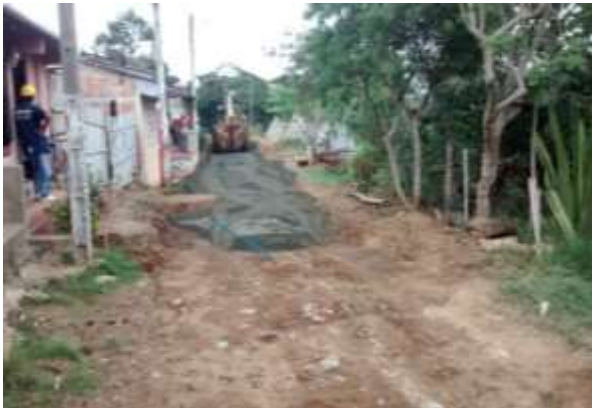
Imagen 5.20. Extendido de Sub Base Placa Huella. (Izquierda) Vía Placa Huella en Sub Base. (Derecha)
