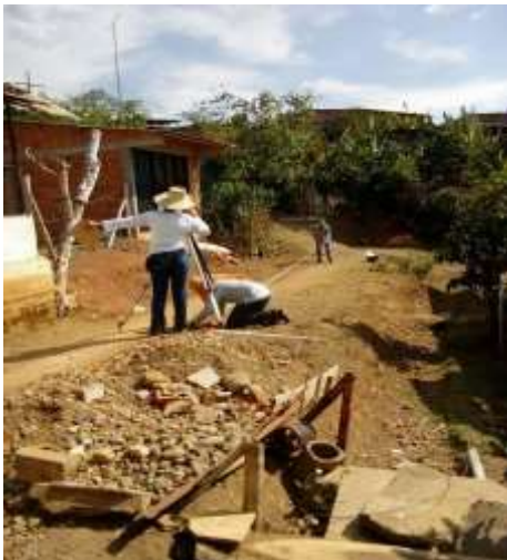
Imagen 5.19. Toma de Topografía Placa Huella. (Izquierda) Cajeo Para Placa Huella. (Derecha)
