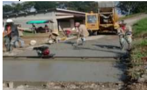
Imagen 5.40. Base Estabilizada San Carlos. (Izquierda). Vaciado De Concreto San Carlos. (Derecha)
