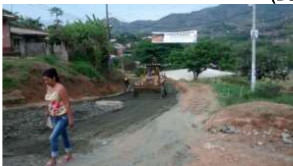
Imagen 5.29. Extendido de Sub Base. (Izquierda). Vía Veraneras en Base Granular. (Derecha)
