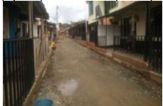
Imagen 5.15. Cajeo Para Alcantarillado (Izquierda). Vía en Sub Base (Derecha)
