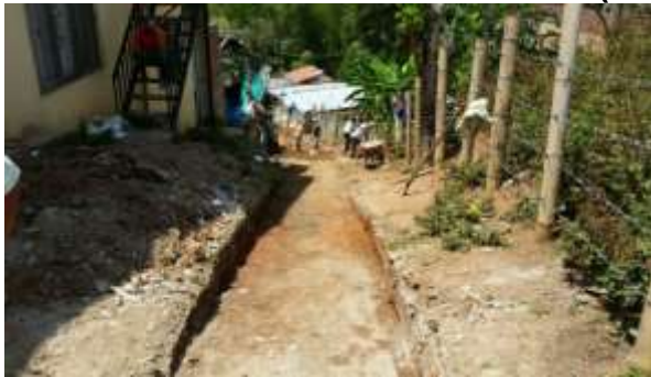
Imagen 5.13. Cajeo Manual Andén (Izquierda). Construcción primer tramo Andén (Derecha).
