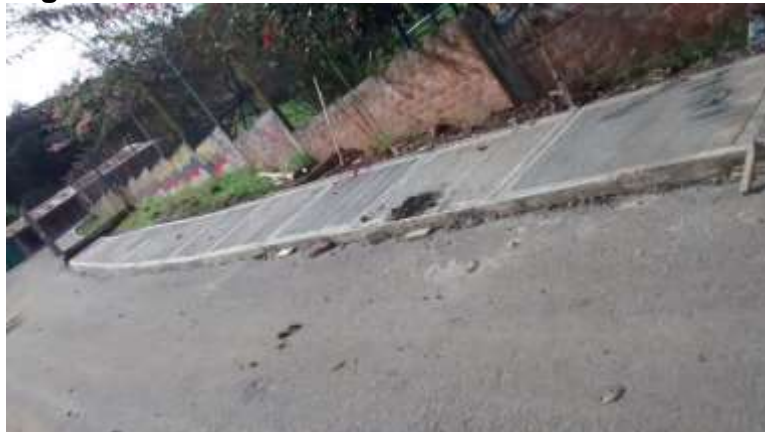
Imagen 5.52. Andén Tramo Santa Teresita Terminado
