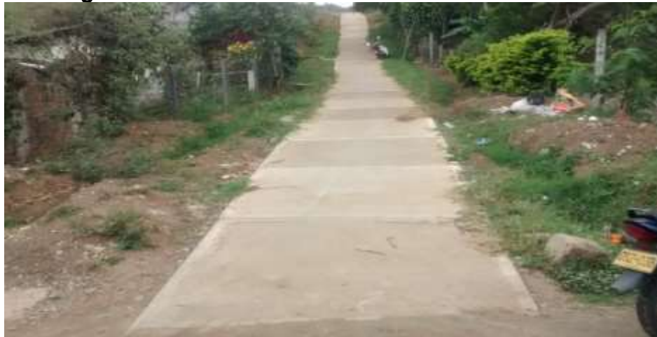
Imagen 5.60. Andén Veraneras – Los Pinos Terminado
