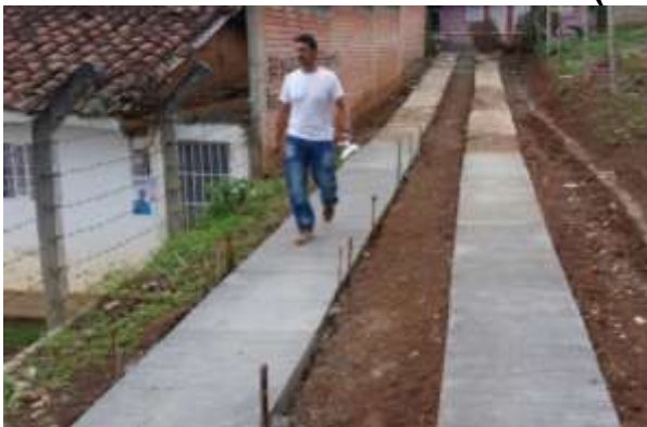
Imagen 5.14. Inicio Construcción Placa Huella (Izquierda). Placa Huella Terminada (Derecha).
