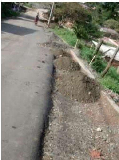
Imagen 5.51. Tramo Cancha Veraneras Antes
