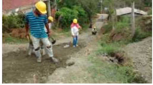
Imagen 5.58. Cajeo Andén Veraneras – Los Pinos. (Izquierda). Extendido De Sub Base Andén. (Derecha)
