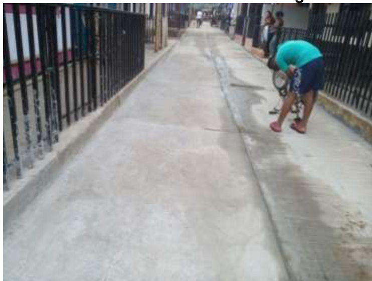
Imagen 5.18. Vía Urbanización Veraneras Autogestión Terminada
