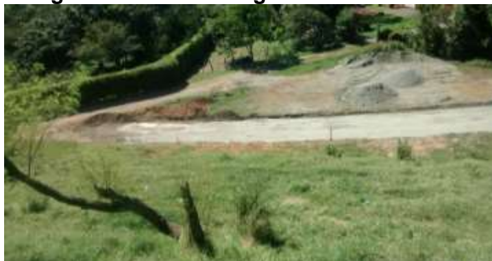
Imagen 5.27. Vía B/ Vergara en Base Granular
