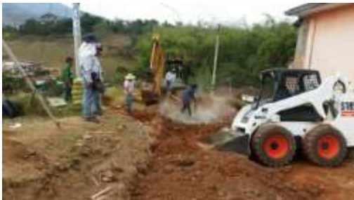
Imagen 5.44. Estabilización Con Cemento. (Izquierda). Compactación Base Estabilizada. (Derecha)
