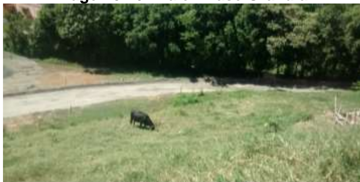
Imagen 5.26. Vía en Base Granular
