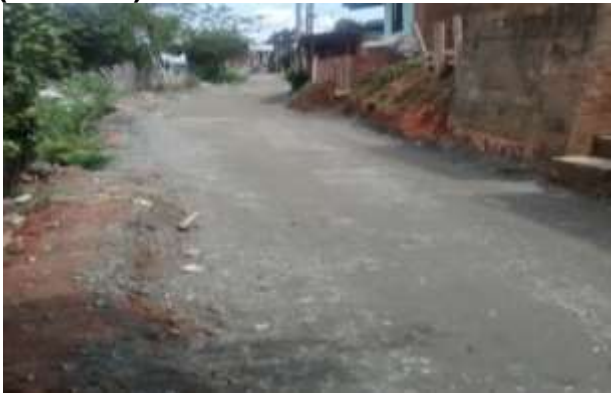
Imagen 5.20. Extendido de Sub Base Placa Huella. (Izquierda) Vía Placa Huella en Sub Base. (Derecha)
