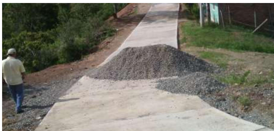
Imagen 5.8. Vía terminada por Autogestión Barrio San Carlos.
