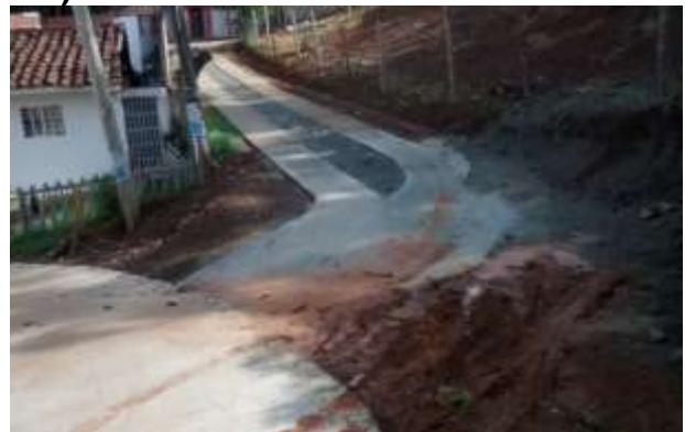
Imagen 5.14. Inicio Construcción Placa Huella (Izquierda). Placa Huella Terminada (Derecha).
