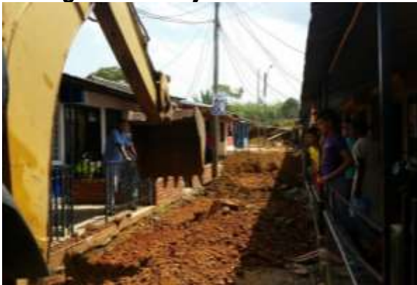
Imagen 5.15. Cajeo Para Alcantarillado (Izquierda). Vía en Sub Base (Derecha)
