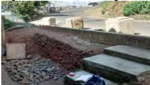
Imagen 5.61. Andén Barrio Vergara Antes
