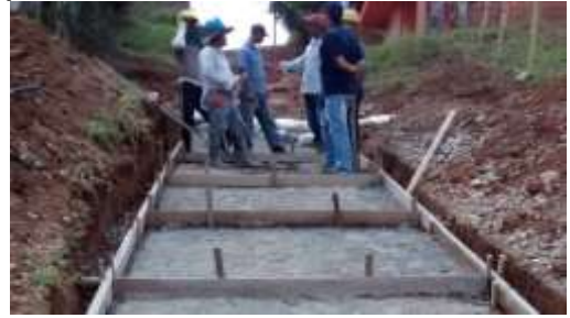
Imagen 5.47. Sector Sin Intervención. (Izquierda). Formaleta Anden Santa Teresita. (Derecha)
