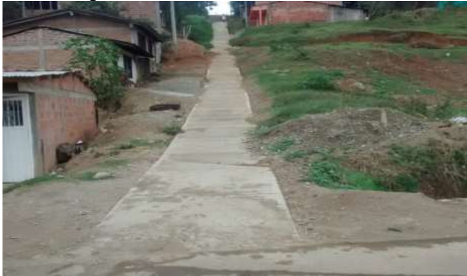
Imagen 5.49. Andén Santa Teresita Terminado
