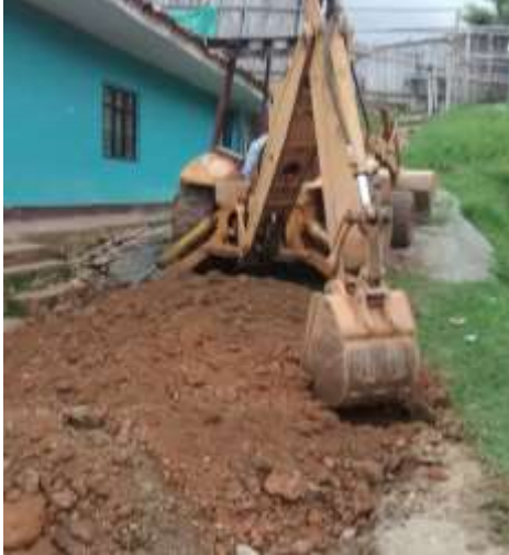
Imagen 5.23. Cajeo Calle 2. (Izquierda). Compactación Sub Base Calle 2. (Derecha)
