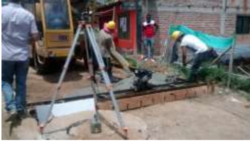
Imagen 5.45. Inicia Vaciado De Concreto. (Izquierda). Construcción Pavimento La Callaja. (Derecha)
