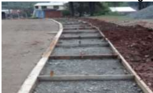
Imagen 5.33. Formaleta Anden Iglesia. (Izquierda). Vaciado De Concreto Anden Iglesia. (Derecha)
