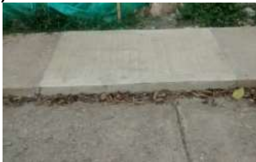
Imagen 5.34. Canal Causa De Accidente Peatonal. (Izquierda). Paño Reconstruido. (Derecha)
