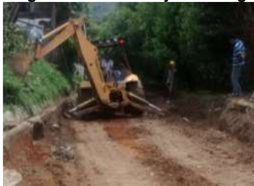
Imagen 5.25. Inicio Cajeo B/ Vergara. (Izquierda). Cajeo B/ Vergara. (Derecha)
