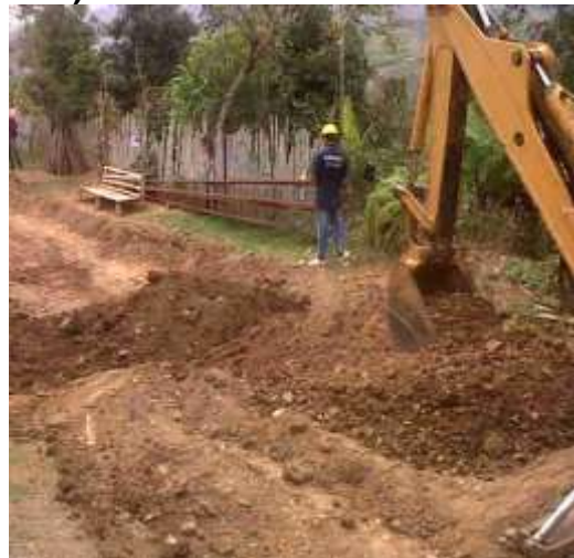
Imagen 5.19. Toma de Topografía Placa Huella. (Izquierda) Cajeo Para Placa Huella. (Derecha)
