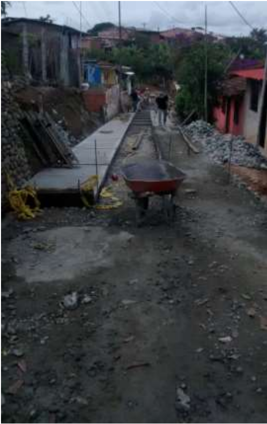
Imagen 5.21. Inicio Construcción Placa Huella
