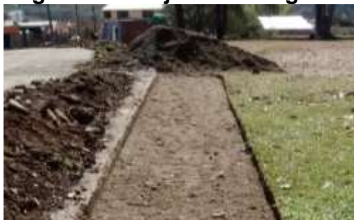
Imagen 5.32. Cajero Anden Iglesia. (Izquierda). Anden en Sub Base. (Derecha)
