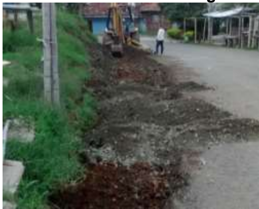
Imagen 5.62. Cajeo Andén Barrio Vergara. (Izquierda). Tramo De Ande Barrio Vergara Terminado. (Derecha)
