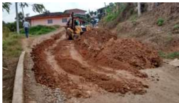
Imagen 5.28. Vía antes de intervención. (Izquierda). Inicio Cajeo Veraneras. (Derecha)
