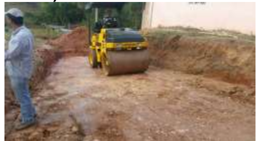
Imagen 5.44. Estabilización Con Cemento. (Izquierda). Compactación Base Estabilizada. (Derecha)
