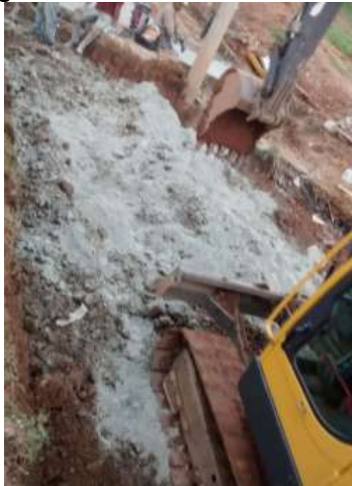
Imagen 5.56. Estabilización Con Cemento
