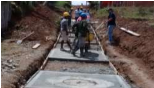
Imagen 5.48. Vaciado De Concreto Andén. (Izquierda). Tramo De Andén Terminado. (Derecha)
