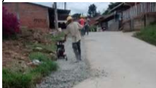
Imagen 5.50. Tramo Sin Intervención. (Izquierda). Compactación Sub Base. (Derecha)
