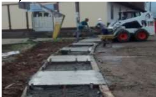
Imagen 5.33. Formaleta Anden Iglesia. (Izquierda). Vaciado De Concreto Anden Iglesia. (Derecha)
