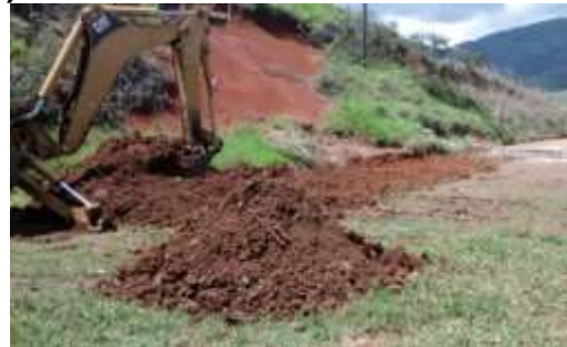
Imagen 5.39. Vía Sin Intervención. (Izquierda). Inicio Cajeo Vía San Carlos. (Derecha)
