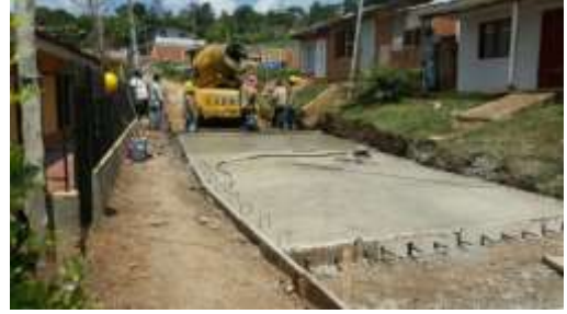
Imagen 5.45. Inicia Vaciado De Concreto. (Izquierda). Construcción Pavimento La Callaja. (Derecha)
