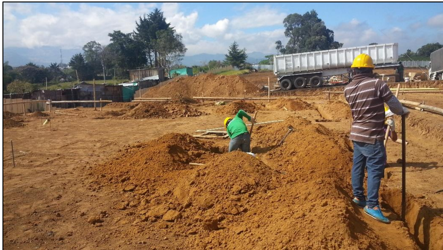
Figura No.12 Excavación de desagües y cajas de inspección
