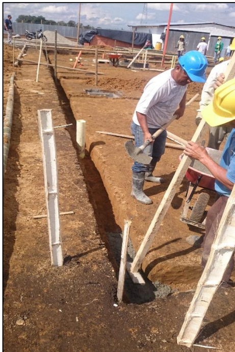
Figura No.18 Construcción solados en concreto.
