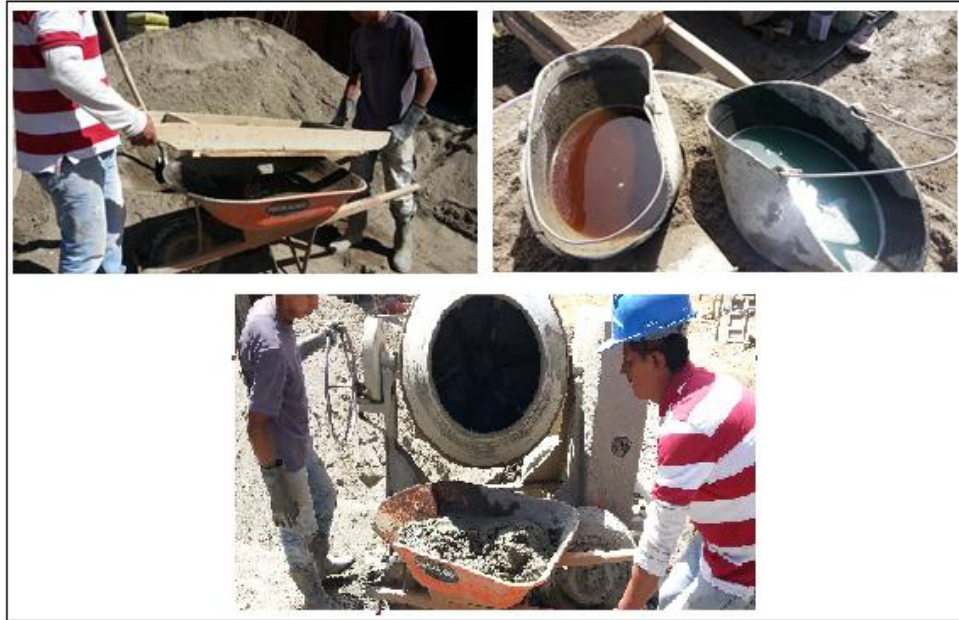
Figura No.35 Preparación del mortero de pega.
