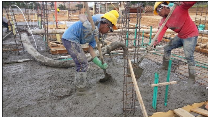
Figura No. 28 Colocación del concreto
