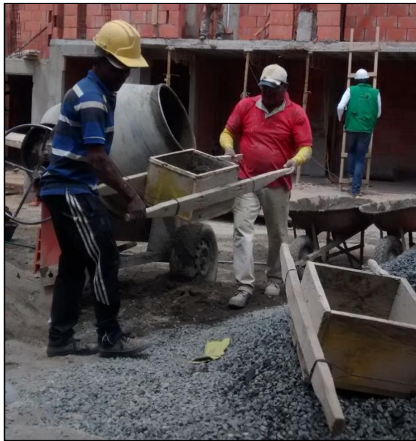
Figura No. 27 Preparación concreto en mezcladora de 1 bulto de cemento.
