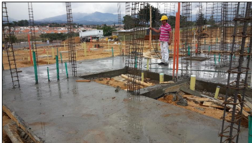
Figura No. 31 Curado de concreto con agua.
