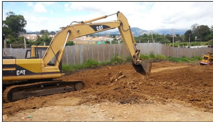
Figura No.6 Descapote y limpieza del terreno.
