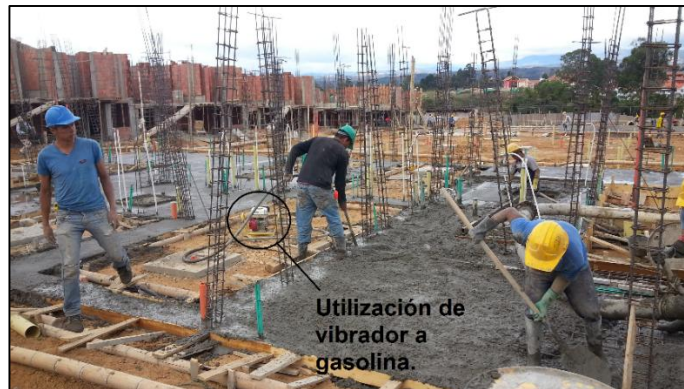
Figura No. 29 Uso adecuado de vibrador.
