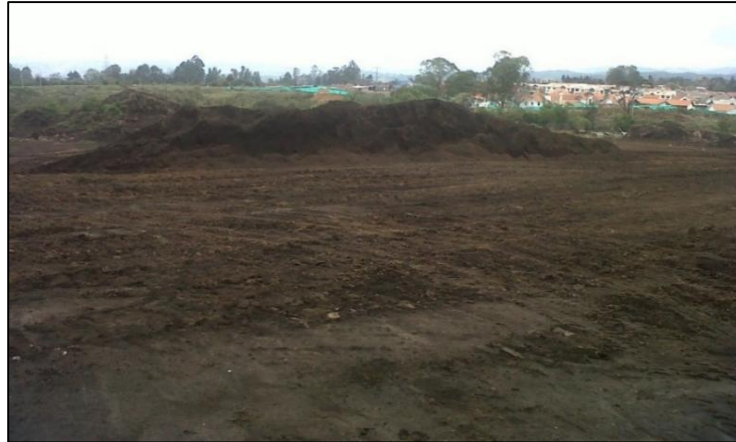
Figura No.5 Remoción de la capa vegetal.
