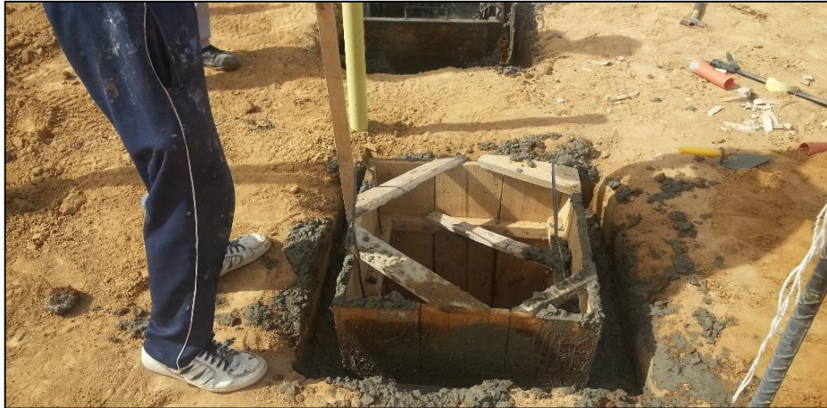
Figura No.14 Fundición de cajas de inspección.
