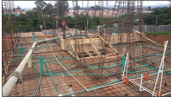
Figura No. 42 Colocación de acero de losa de entrepiso y de estructura
