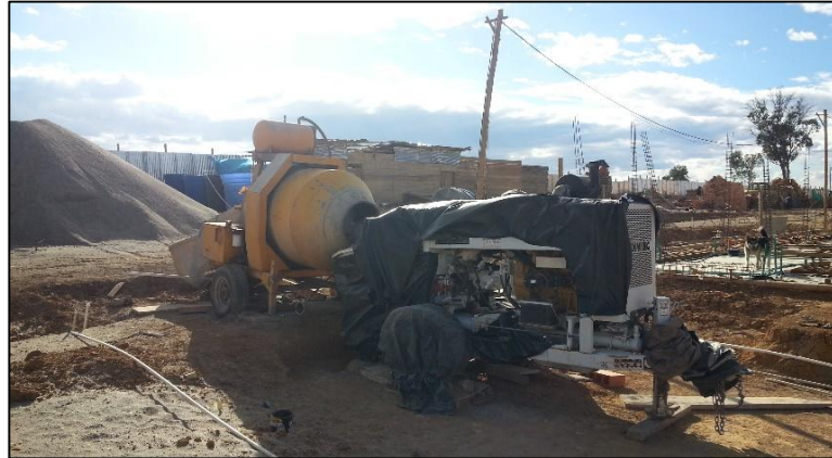
Figura No.25 Mezcladora Semco con una capacidad de 18 pies 3 y bomba de concreto.
