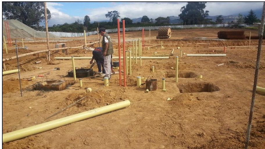
Figura No.13 Excavación de desagües y cajas de inspección.
