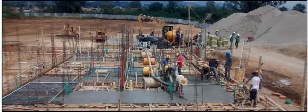
Figura No. 30 Fundición placas de cimentación.
