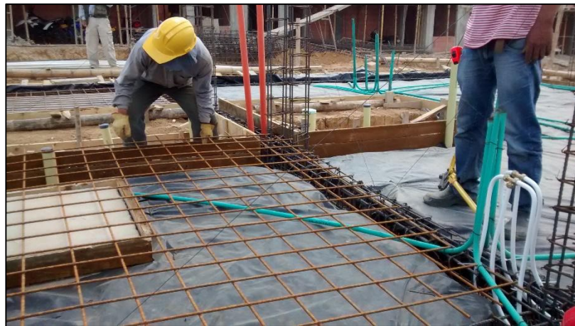
Figura No. 19 Instalación de la malla electrosoldada.
