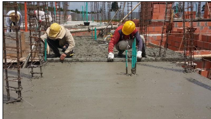
Figura No. 44 Losa de entrepiso
