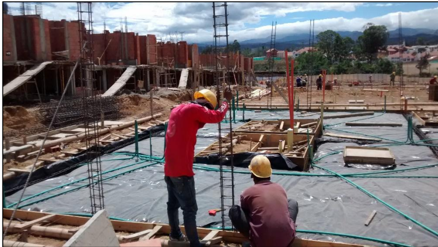
Figura No.22 Localización del acero estructural.
