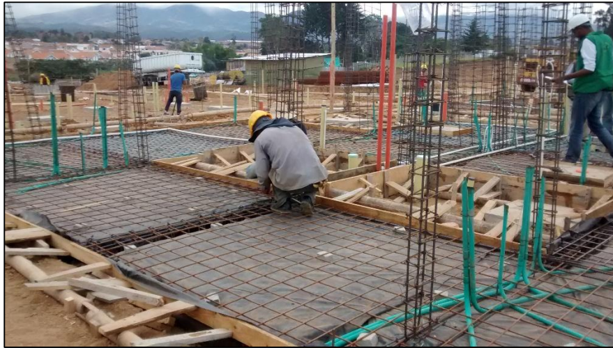
Figura No. 24 Localización del acero de estructural.
