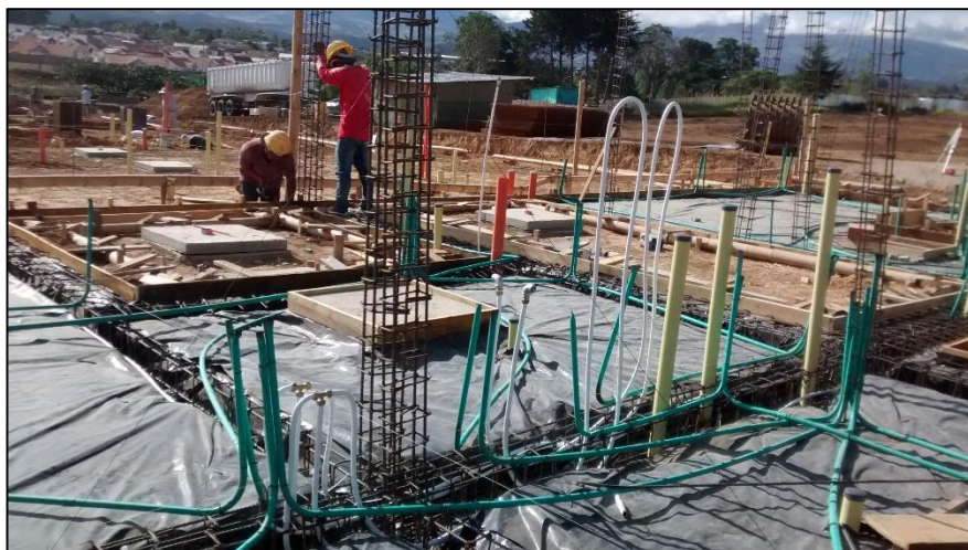
Figura No.23 Localización del acero estructural.
