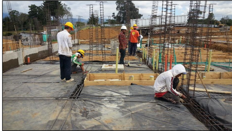
Figura No.20 Acero de refuerzo estructural.
