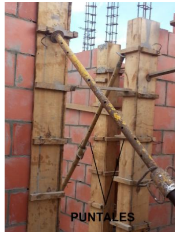
Figura No. 39 Apuntalamiento
