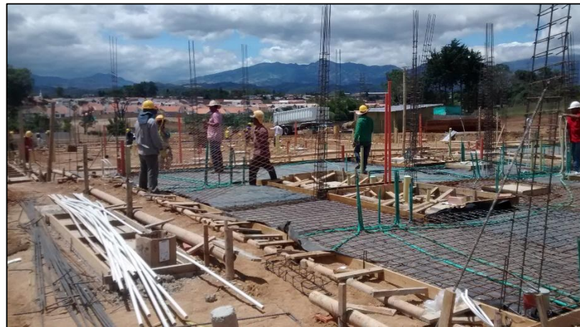
Figura No. 21 Colocación del acero de cimentación
