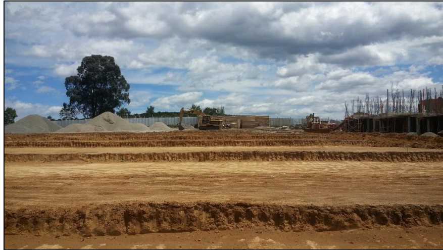
Figura No.10 Localización y replanteo del lote.
