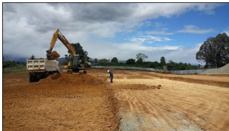
Figura No.7 Descapote y limpieza del terreno.
