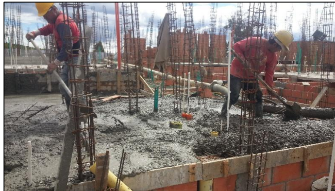
Figura No. 43 Fundición de la losa de entrepiso
