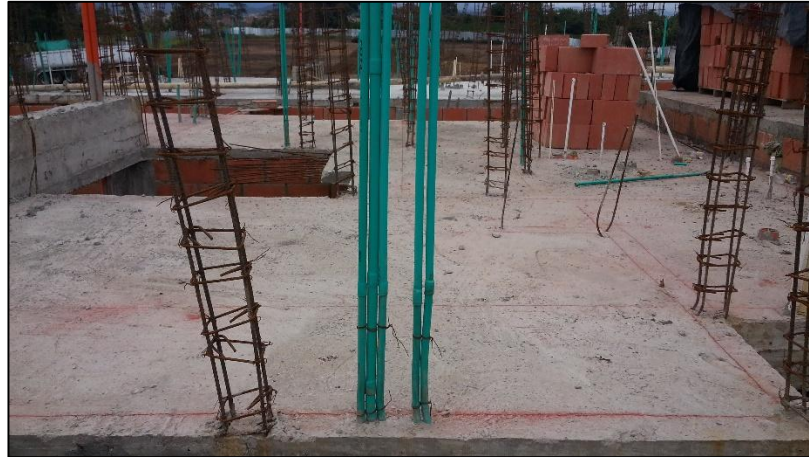
Figura No. 34 Localización y replanteo de la mampostería
