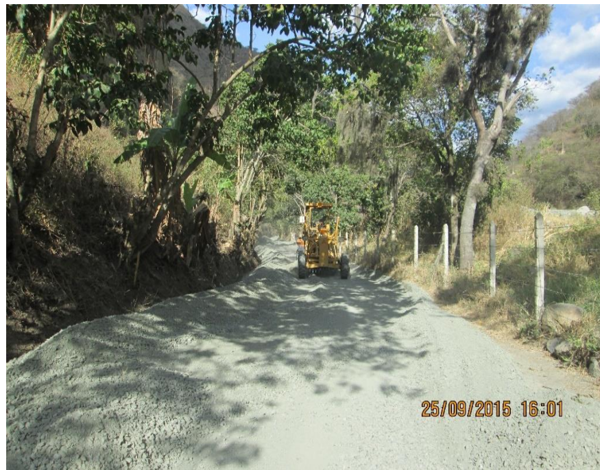
FIGURA 20. Extendida de base granular (BG-40). Fuente propia
