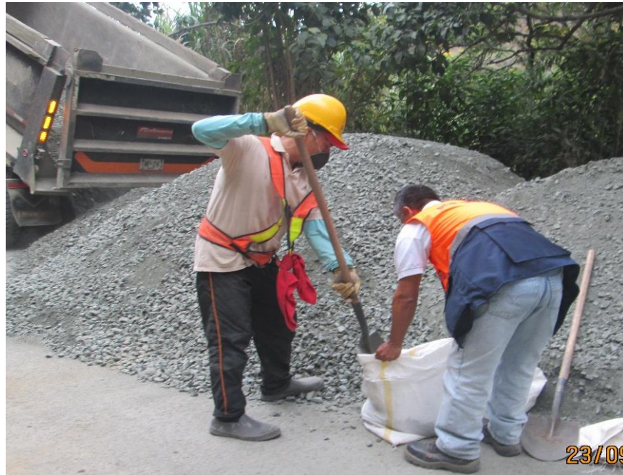
FIGURA 19. Toma de muestra de base por parte de interventoría. Fuente propia
