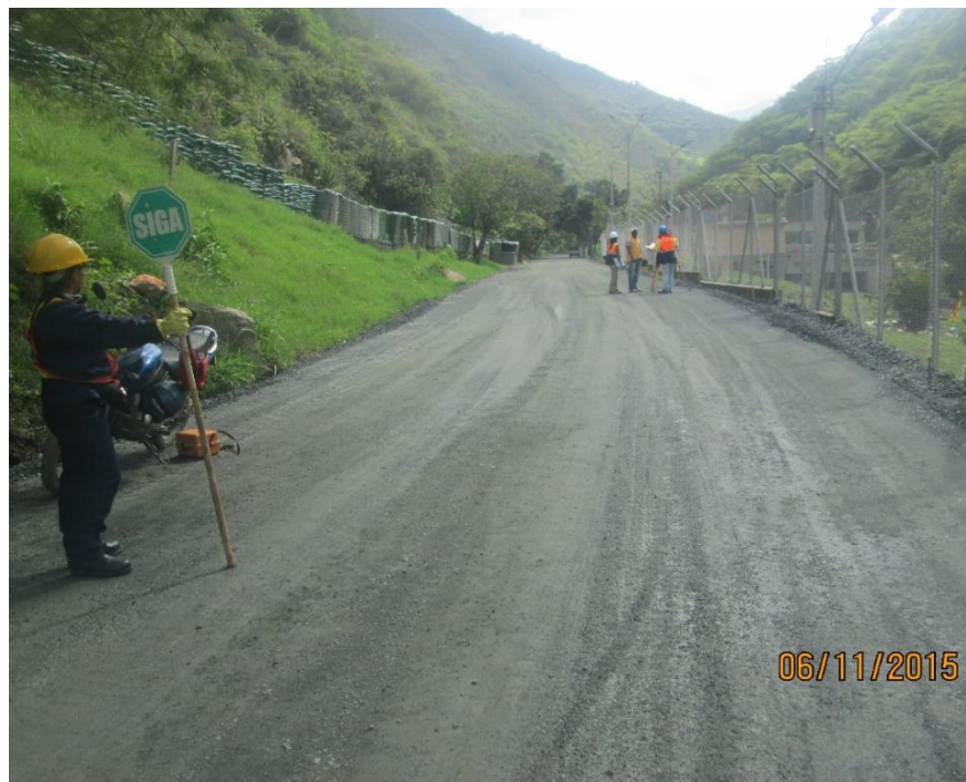
FIGURA 22. Compactación y cereo de base granular (BG-40). Fuente propia
