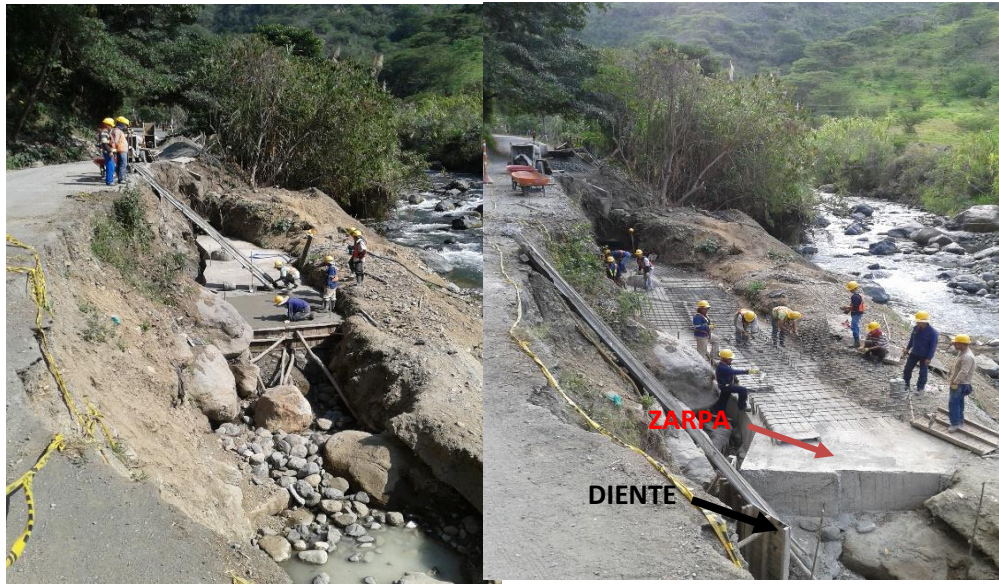
FIGURA 11. Concreto ciclópeo “diente” y zarpa. Fuente propia
