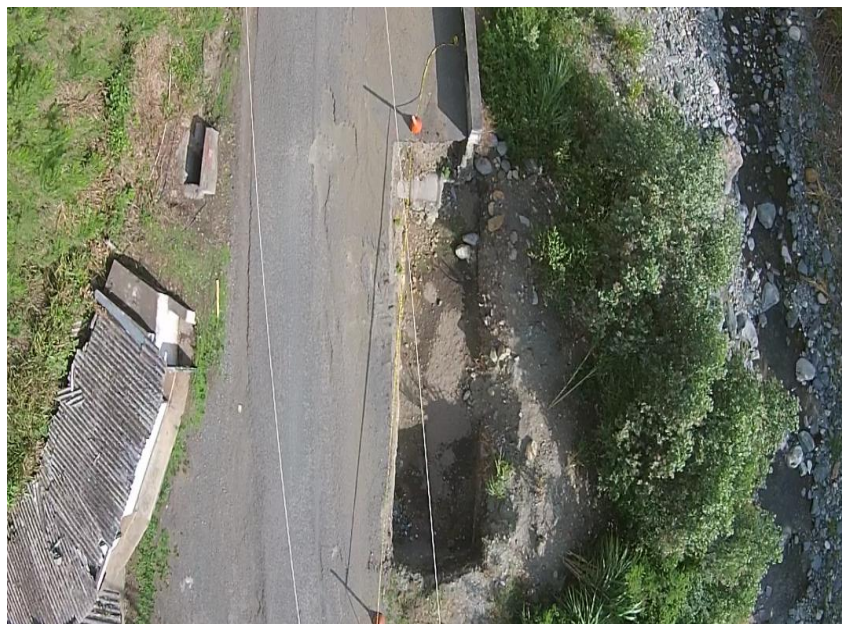
FIGURA 3. Foto en planta de excavación para muro K3+765-K3+775. Fuente DRON Universidad del Cauca.
