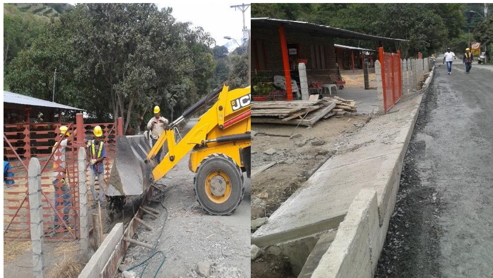
FIGURA 15. Fundición de entradas. Fuente propia.
