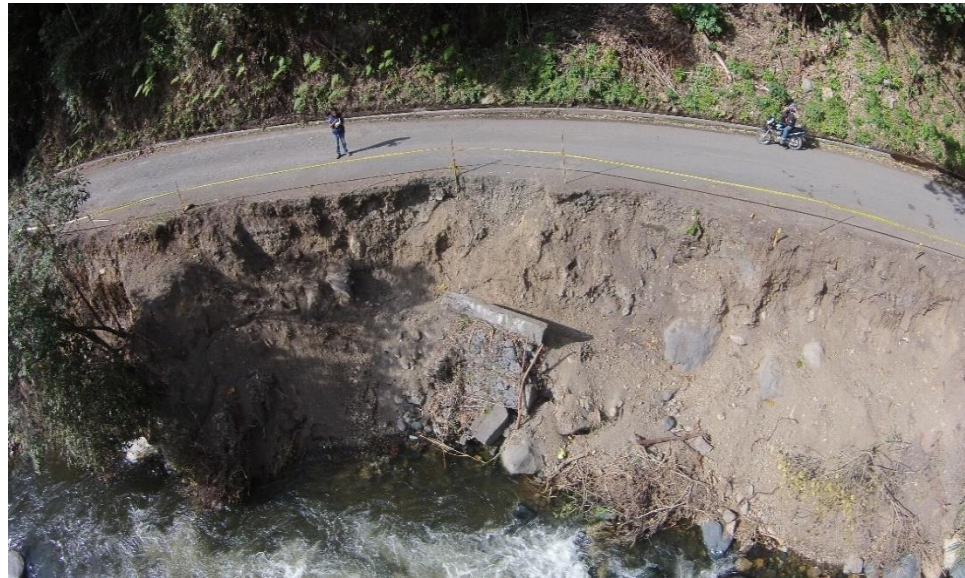
FIGURA 9. Foto en perfil donde va ubicado el muro tomada con DRON propiedad Universidad del Cauca.
