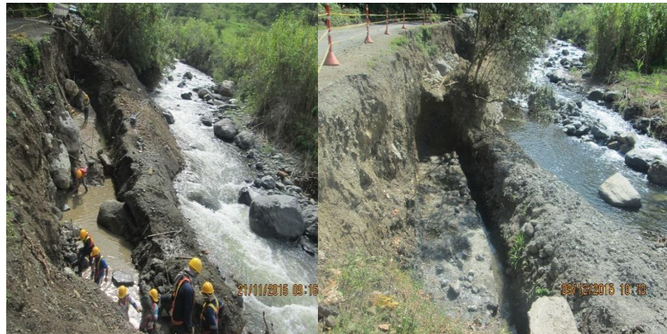
FIGURA 10. Excavación para muro K4+060 - K4+110. Fuente propia
