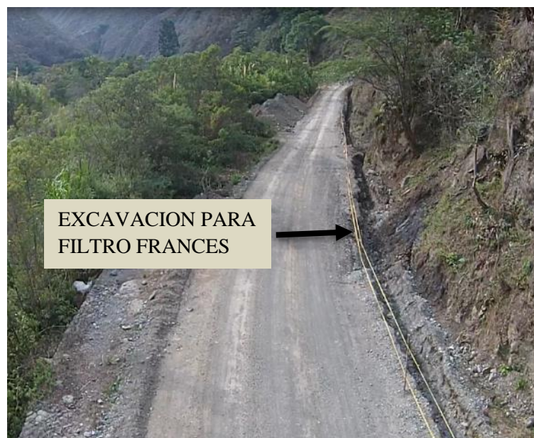
FIGURA 16. Excavación para filtro francés en k2+440 - k2+646.
