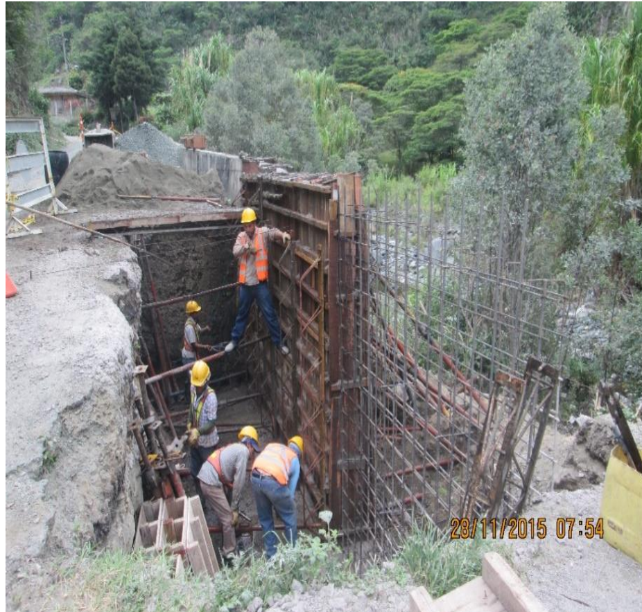
FIGURA 5. Trabajadores colocados formaleta para fundición de muro. Fuente propia.
