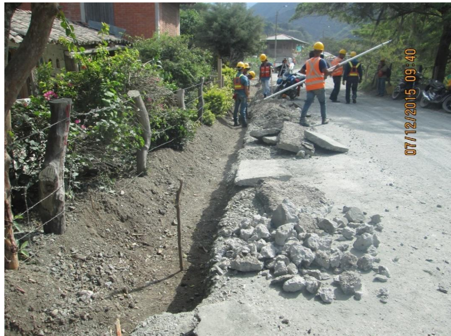
FIGURA 12. Cuneta existente demolida. Fuente propia
