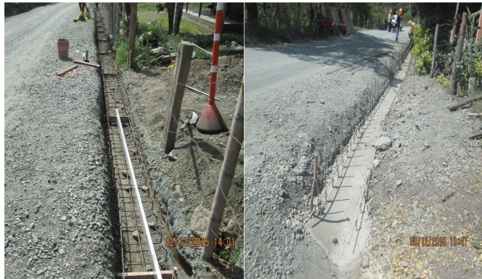
FIGURA 13. Acero de cuneta y fundición de cuneta. Fuente propia
