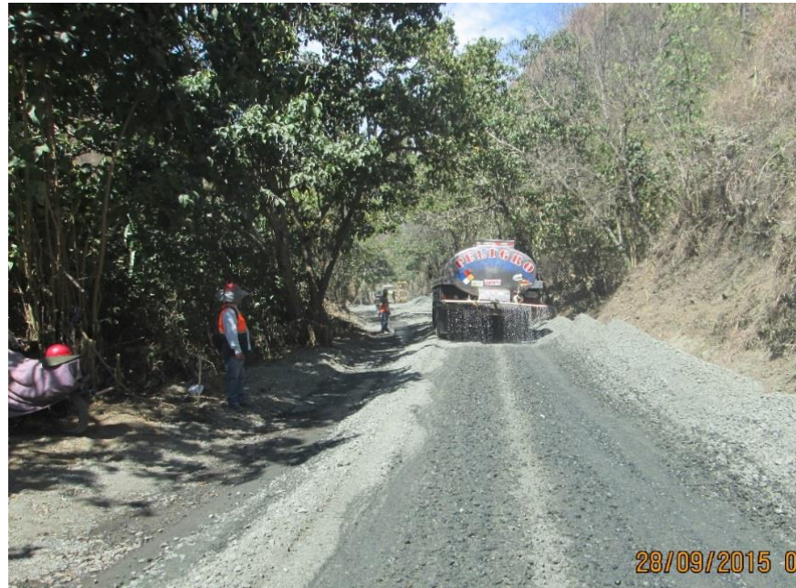
FIGURA 21. Humectación de base granular (BG-40). Fuente propia
