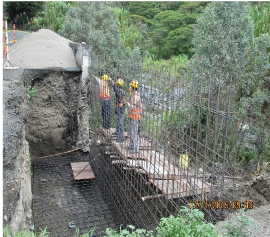
FIGURA 4. Acero de refuerzo de muro. Fuente propia.
