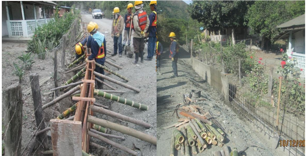
FIGURA 14. Formaleteo y desencofrado de pared lateral izquierda de cuneta. Fuente propia
