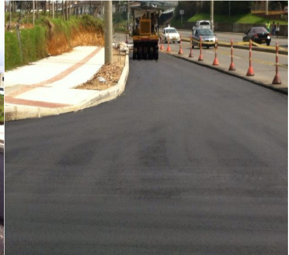
Figura 101. Sellado de la carpeta con compactador neumático
