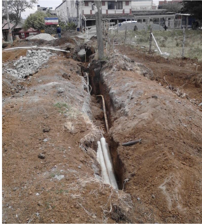
Figura 10. Reubicación de redes de telecomunicación.
