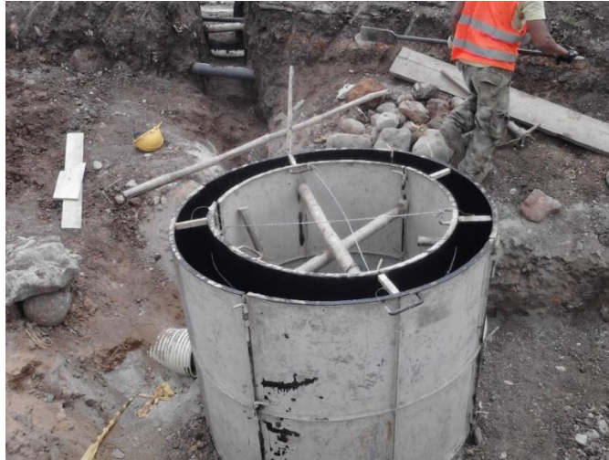
Figura 15. Encofrado completo de cámara de inspección.
