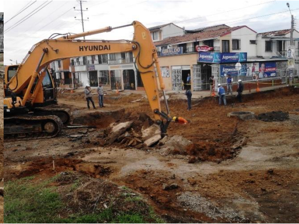
Figura 54. Excavación intercepción calle 53n con carrera 11
