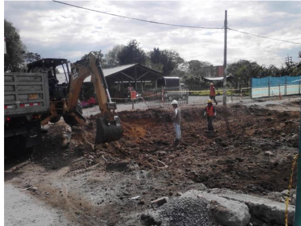
Figura 29. Sacando el fallo presentado sobre la calzada sur.
