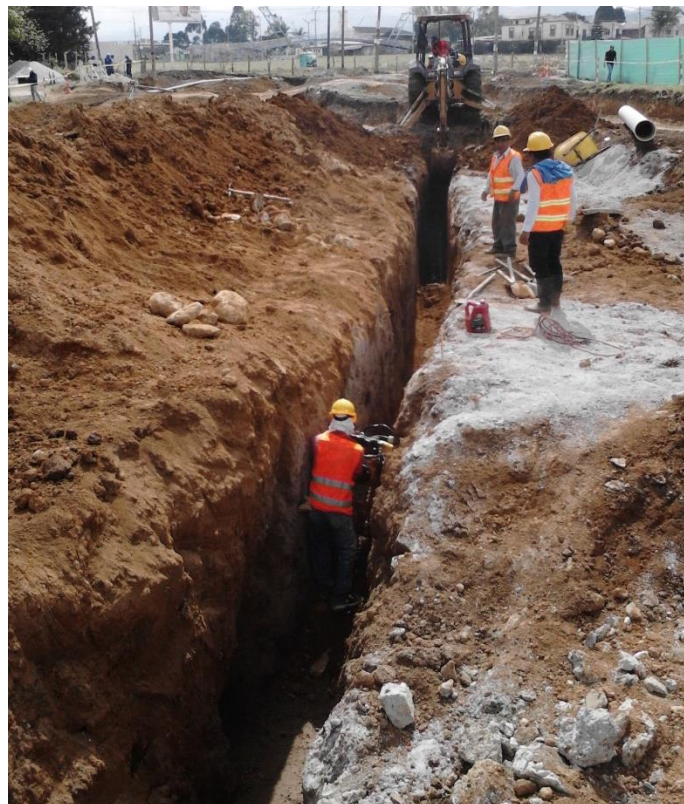
Figura 8. Relleno con el mismo material por capas y compactación.
