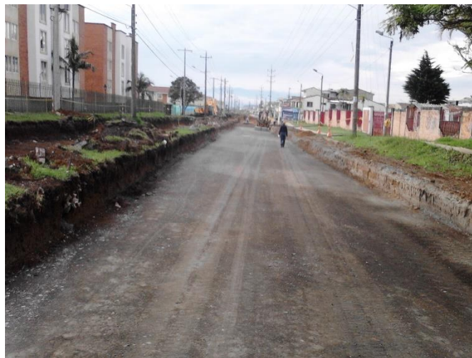
Figura 67. Conformada la sub base calzada norte.
