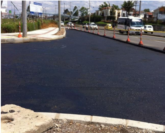
Figura 98. Imprimación transición calzada Norte
