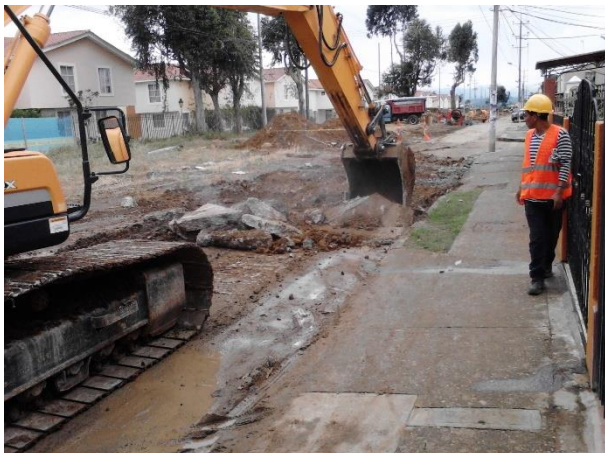
Figura 51. Cajeo calzada norte.
