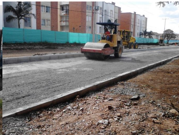
Figura 91. Compactación de la base
