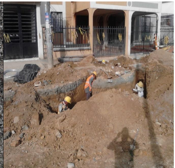
Figura 41. Tubería antigua de aguas sanitarias. Figura 42. Excavación tubería aguas sanitaria
