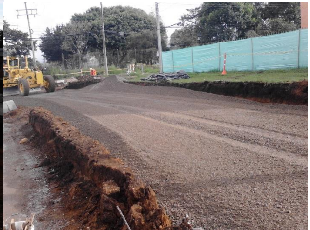
Figura 71. Extendido de la sub base
