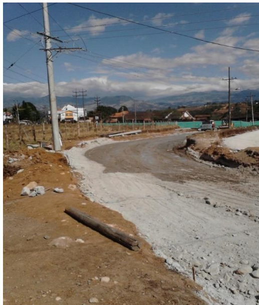
Figura 31. Poste PR0+095 trasladado y conformación del sitio en la calzada norte
