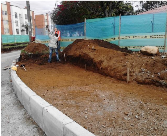
Figura 76. Excavación del andén.
