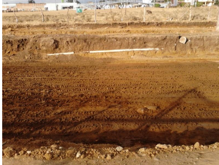
Figura 24. Humectación de la sub rasante.
