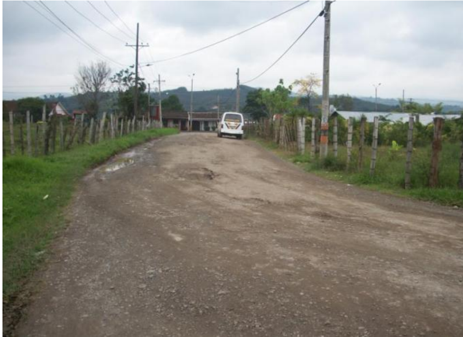
Figura 2 condiciones antes del corredor vial
