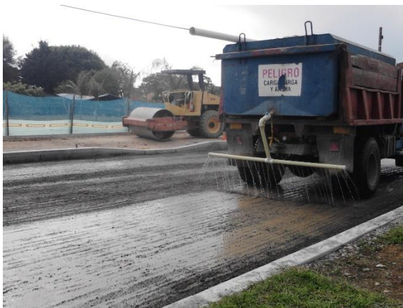
Figura 90. Humectación de la base
