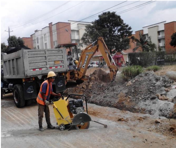
Figura 35. Cortando losa
