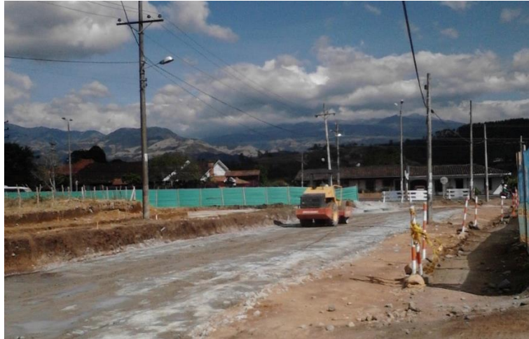
Figura 28. Compactación del mejoramiento PR0+010 calzada sur.
