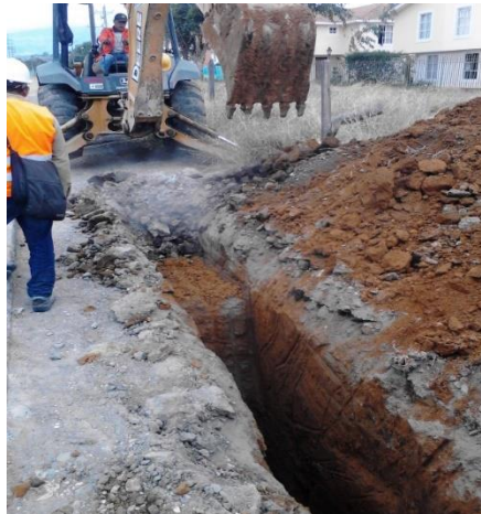
Figura 34. Excavación desde la carrera 11 hasta carrera 15
