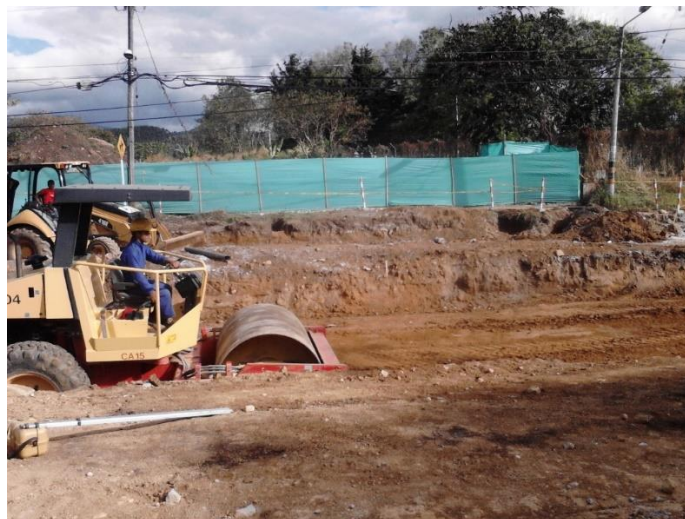
Figura 25. Compactación de la sub rasante calzada norte.
