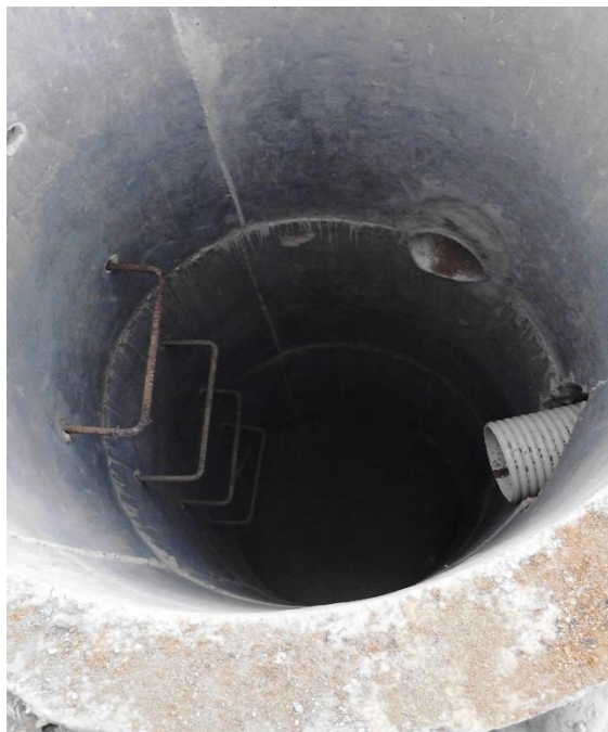
Figura 18. Interior de la cámara de inspección.
