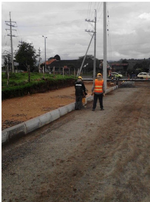
Figura 92. Compactación de los laterales de la calzada
