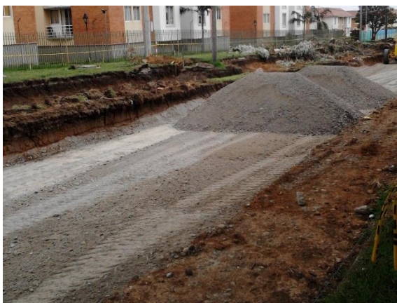
Figura 63. Sub base sobre la calzada
