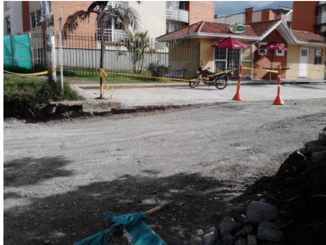
Figura 59. Sub base compactada en la intercepción.
