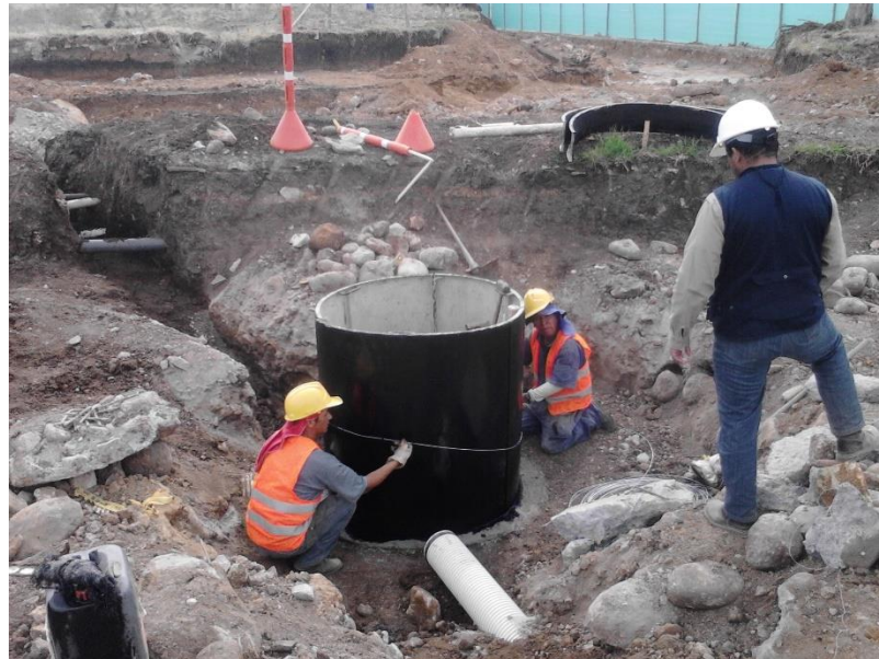
Figura 14. Encofrado de la cámara de inspección.
