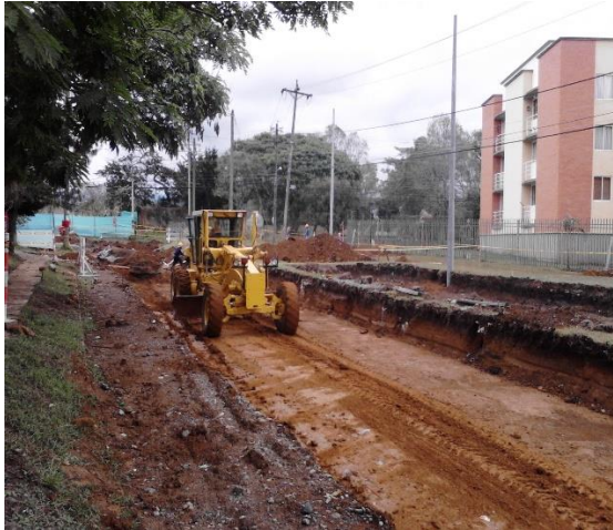
Figura 45. Perfilado sub rasante calzada norte
