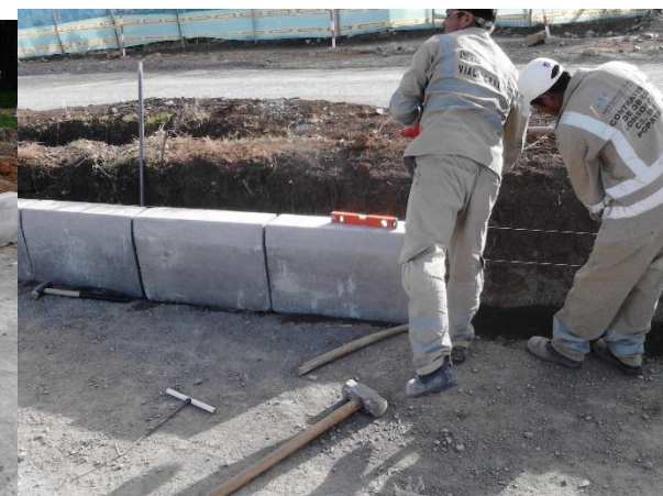
Figura 75. Colocaciones sardineles y chequeo de nivel
