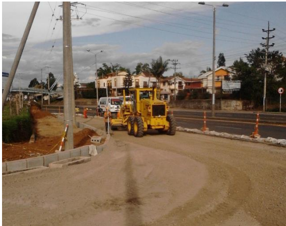
Figura 88. Nivelación de la base
