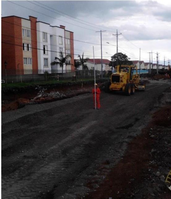
Figura 65. Nivelación de la sub base
