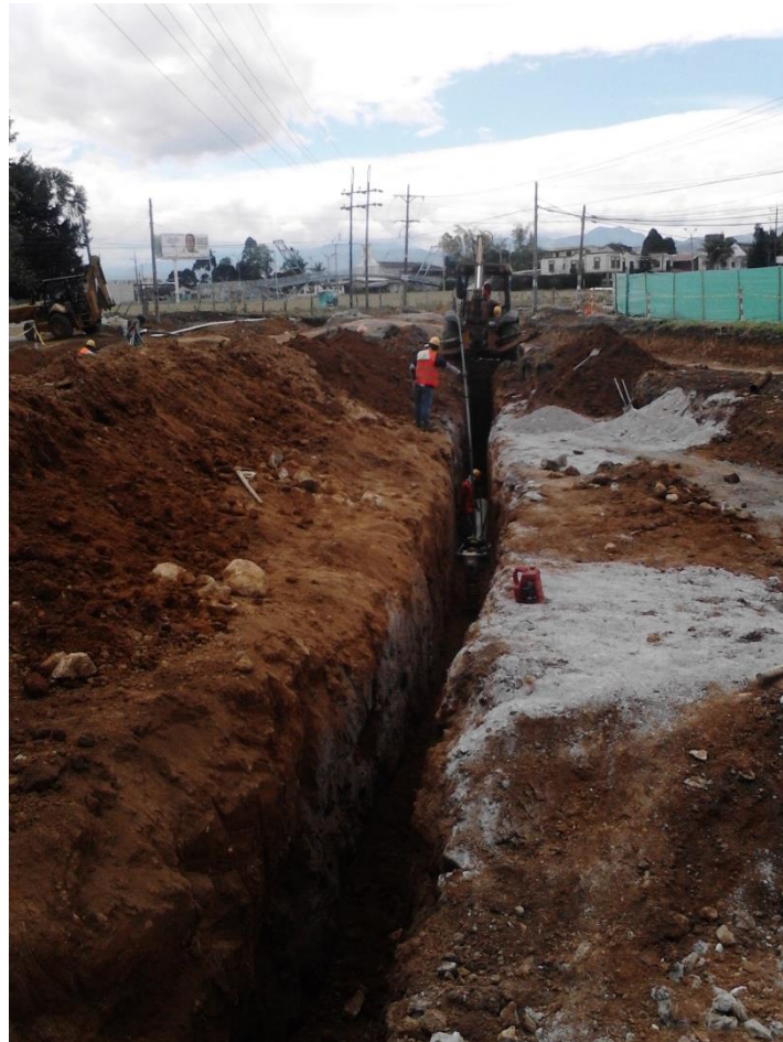
Figura 6. Nivel de la tubería de aguas sanitaria y excavación
