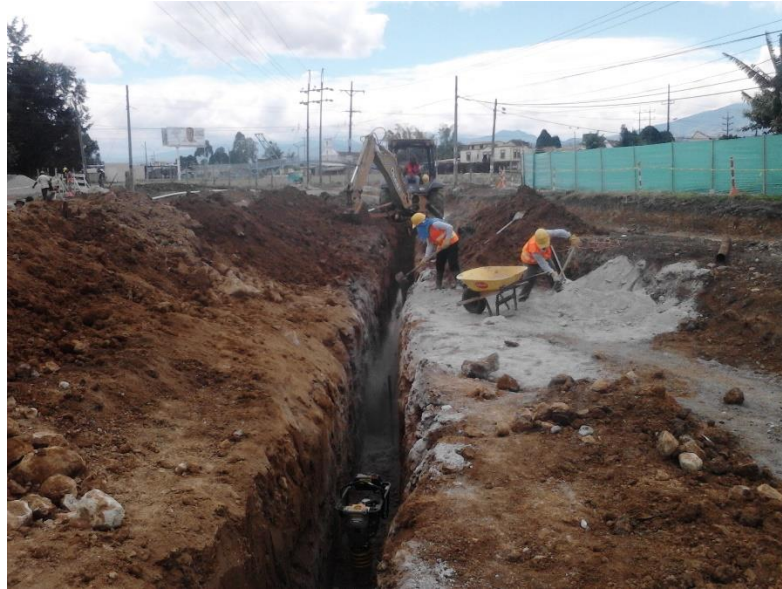
Figura 7. Relleno con arena de rio para la base de la tubería.
