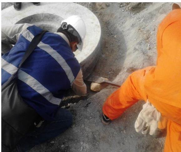
Figura 94. Nivelando el brocal.
