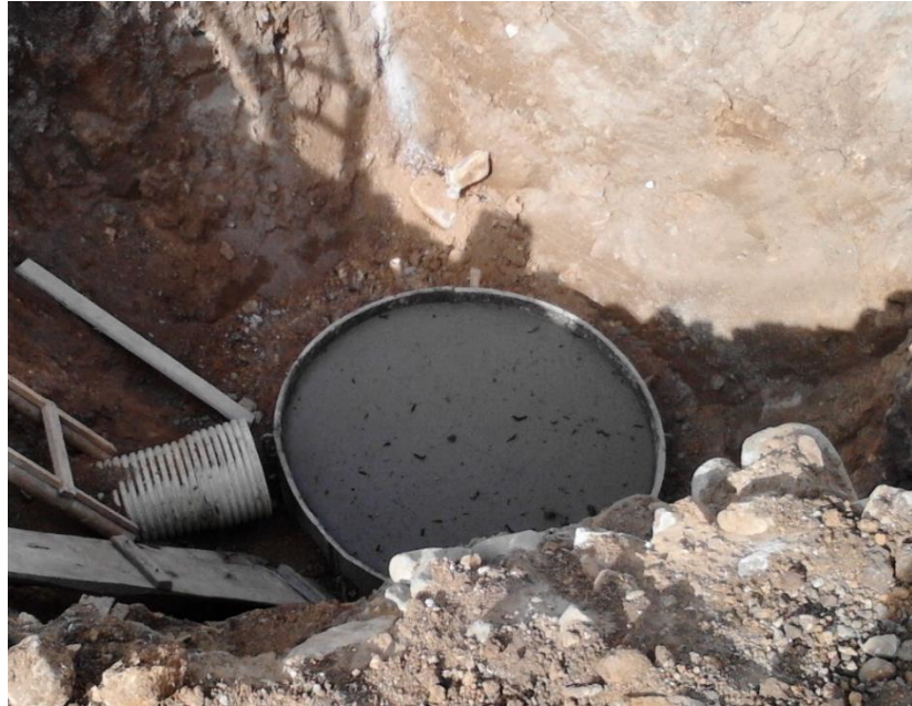
Figura 13. Base de la cámara de inspección.
