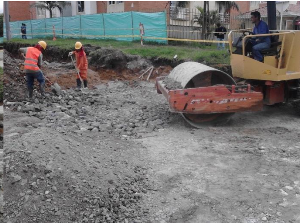
Figura 56. Compactación de piedraplen
