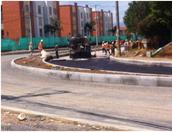
Figura 96. Imprimación de la base.
