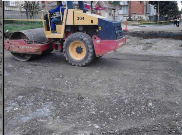
Figura 58. Compactación en la intercepción
