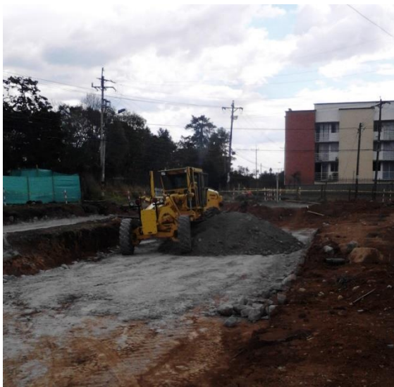
Figura 26. Extendido del mejoramiento sobre calzada norte PR0+100
