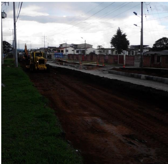
Figura 70. Perfilado sub rasante
