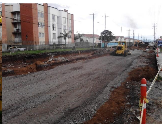
Figura 64. Extendido de la sub base
