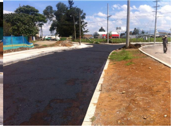
Figura 97. Imprimación sobre calzada norte.
