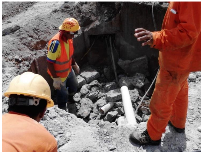
Figura 60. Cámara de Emtel demolida
