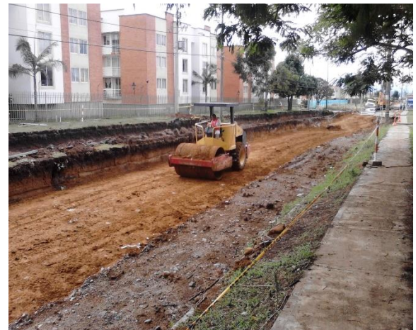
Figura 46. Compactación calzada norte
