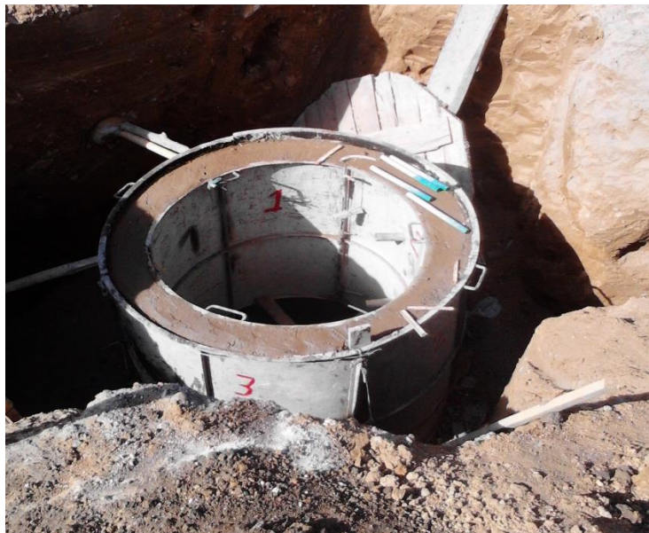
Figura 17. Curado del concreto en la cámara de inspección.
