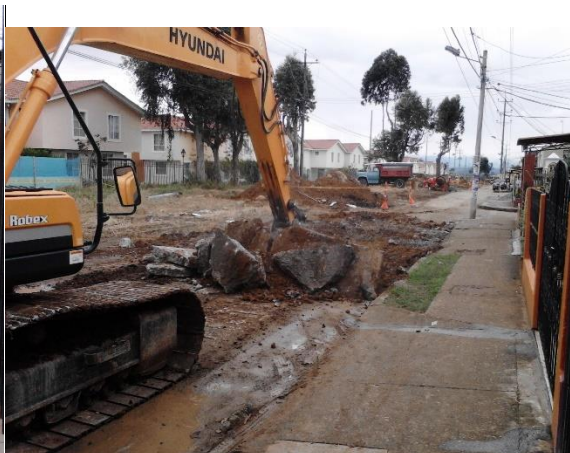
Figura 52. Cajeo calzada norte en donde esta la losa
