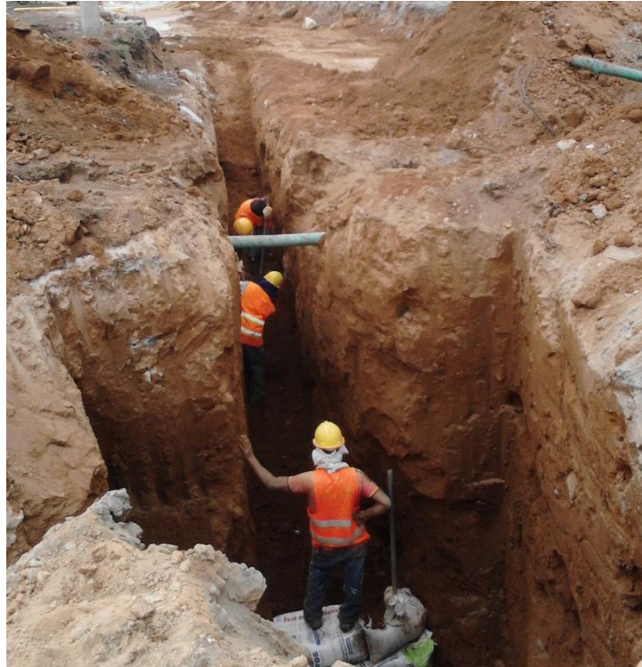
Figura 12. Excavación de la cámara de inspección colector aguas lluvias
