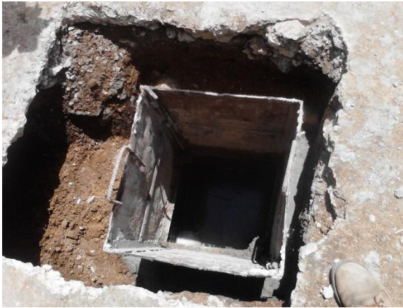
Figura 43. Encofrado caja domiciliaria
