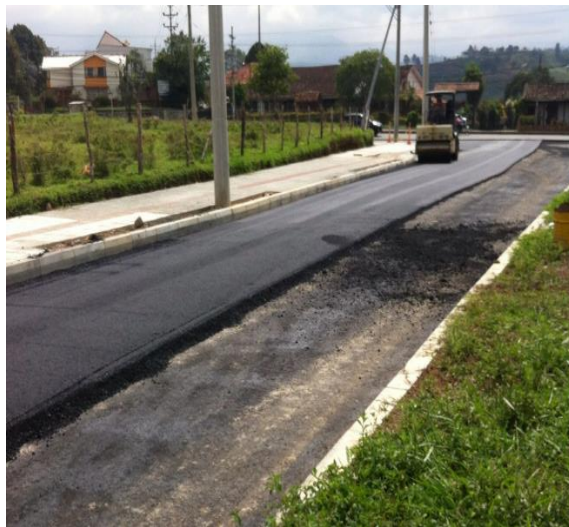
Figura 102. Sellado de la carpeta asfáltica calzada norte
