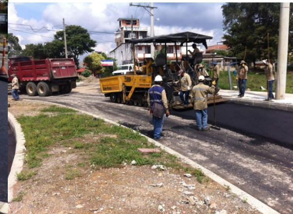
Figura 99. Finisher colocando primera capa.
