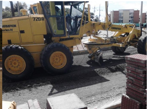
Figura 89. Perfilada de la base.
