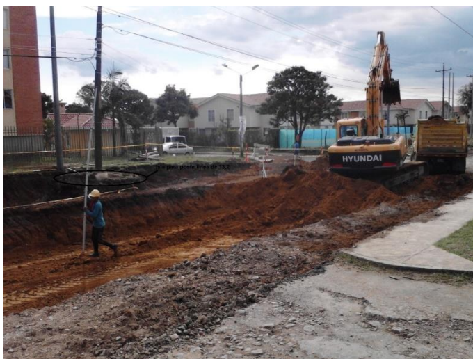
Figura 32. Excavación calzada norte.
