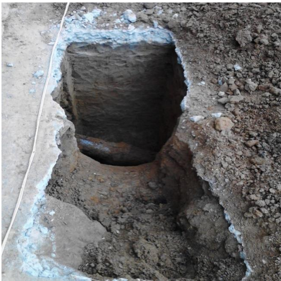
Figura 41. Tubería antigua de aguas sanitarias. Figura 42. Excavación tubería aguas sanitaria
