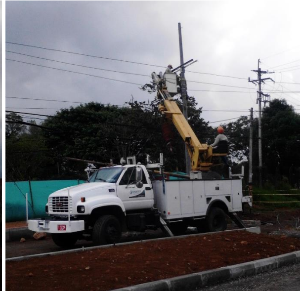
Figura 69. Trabajo sobre línea de 13,2
