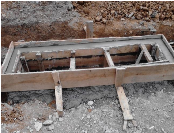
Figura 84. Curado del sumidero
