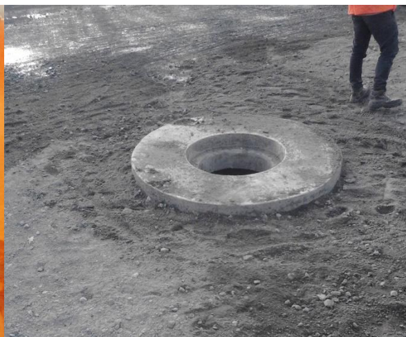
Figura 95. Brocal nivelado.
