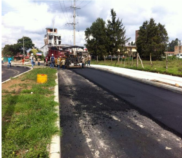
Figura 100. Extendido carpeta asfáltica calzada norte
