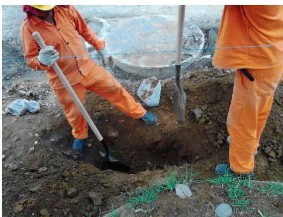
Figura 82. Excavación sumidero
