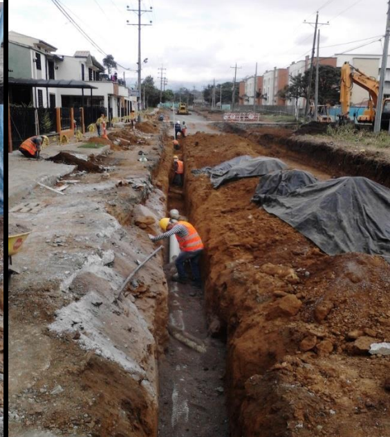
Figura 40. Nivelación de tubería.
