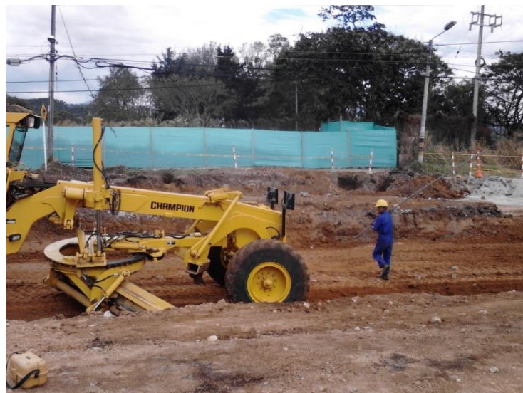
Figura 23. Nivelación de la sub rasante en la calzada norte.
