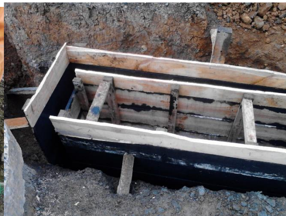
Figura 83. Encofrado sumidero.
