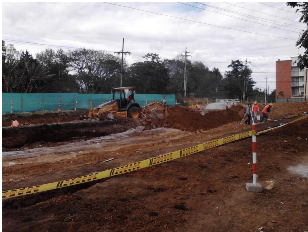
Figura 5. Excavación con retroexcavadora para tubería de aguas sanitarias.
