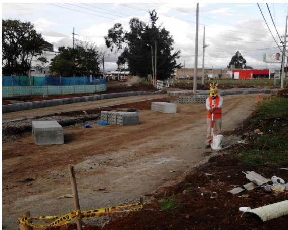
Figura 72. Puntos de replanteo para los sardineles
