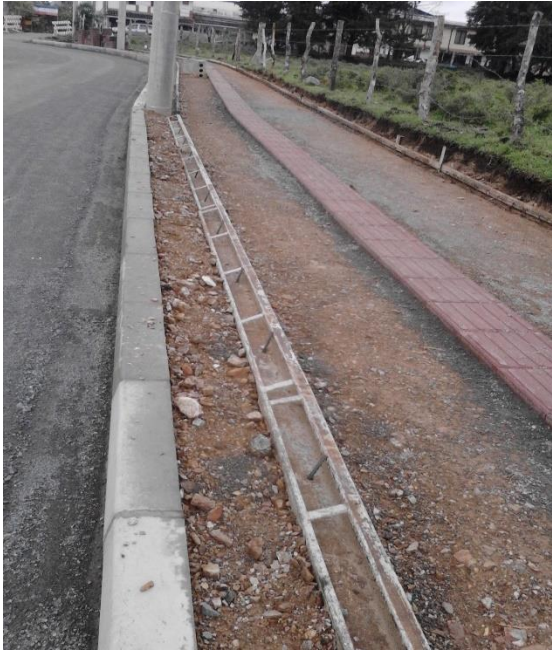
Figura 78. Viga de confinamiento y tableta Guía
