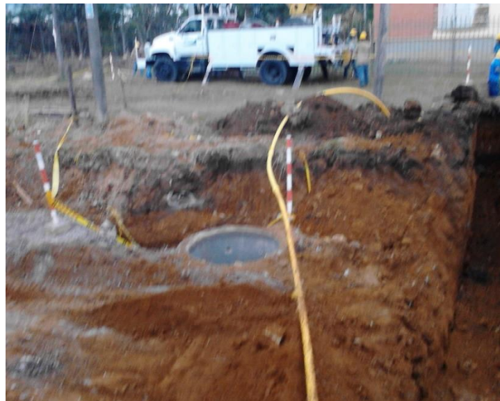
Figura 11. Reubicación de red de gas domiciliario.
