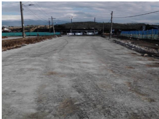
Figura 30. Calzada sur mejoramiento.
