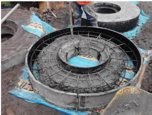
Figura 49. Vibrado del concreto en la Formaleta del brocal
