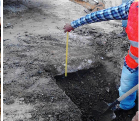
Figura 36. Espesor losa (17 cm)
