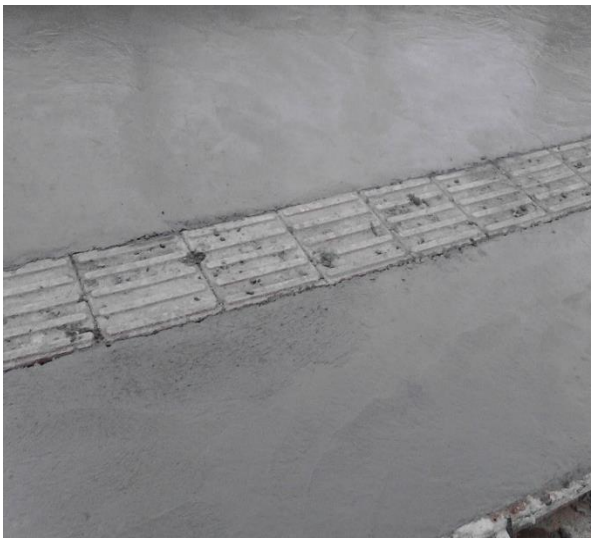
Figura 80. Fraguado de losa del andén
