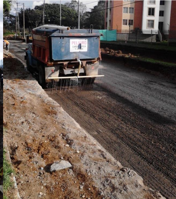
Figura 66. Humectación de la sub base
