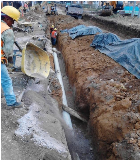
Figura 39. Relleno con arena de rio
