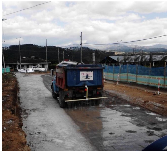
Figura 27. Humectación sobre calzada sur PR0+010
