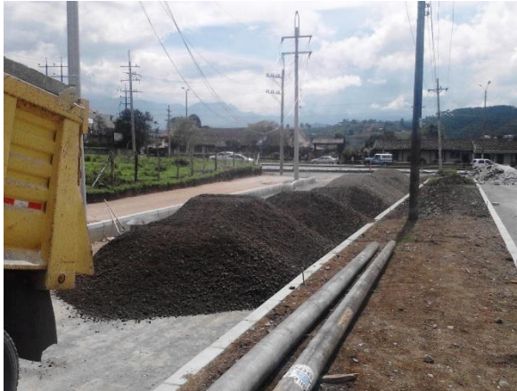
Figura 86. Descarga de base.
