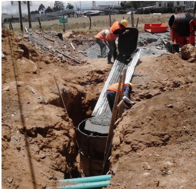
Figura 16. Incorporando el concreto al encofrado.
