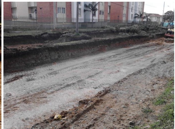
Figura 48. Mejoramiento en el fallo.
