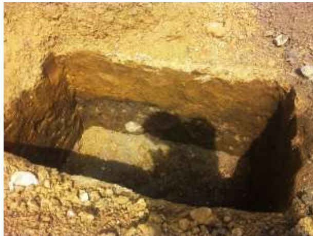
FIGURA No. 23 Relleno suelo cal – cimentación.
