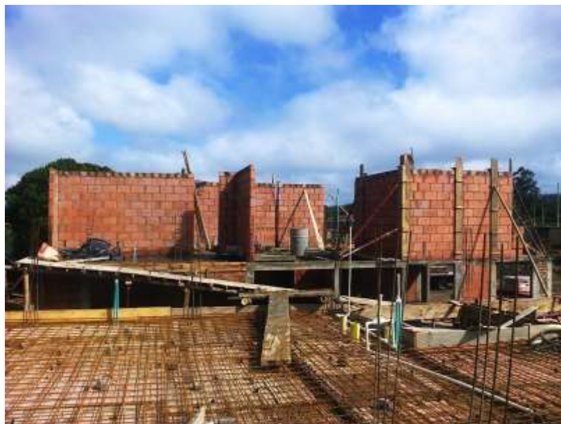
FIGURA No. 50 Mampostería confinada, segundo piso.
