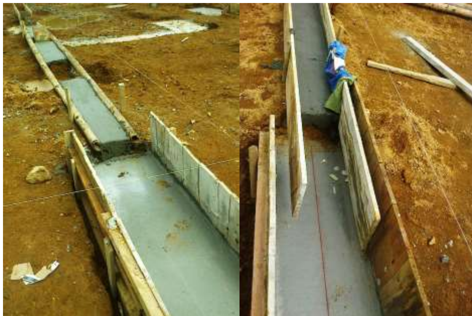
FIGURA No. 24 Fundición del solado – Zapatas y vigas de cimentación
