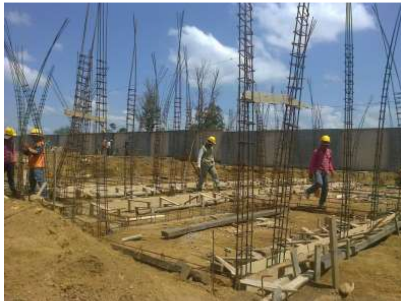
FIGURA No.42 Columnas primer piso.
