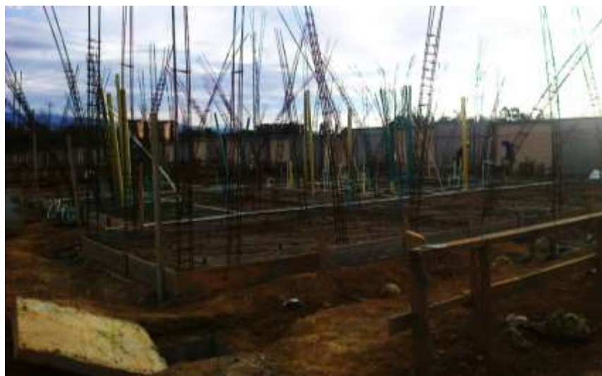
FIGURA No. 36 Colocación del plástico, instalación eléctrica, malla electrosoldada, hidráulica.
