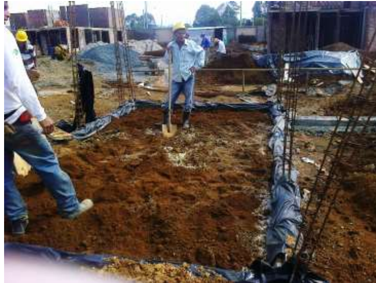
FIGURA No 34. Relleno – suelo cal
