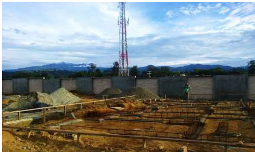
FIGURA No. 30 Armado del acero para vigas de cimentación y zapatas.
