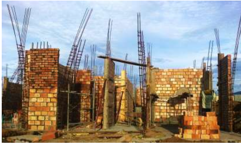
FIGURA No. 43 Mampostería primer piso.
