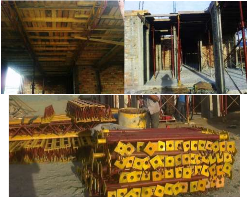
FIGURA No. 45 Encofrado losa de entrepiso
