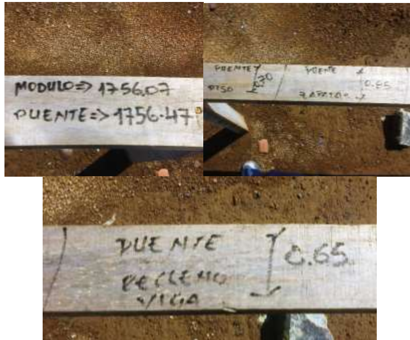
FIGURA No. 20 Cotas para excavación.
