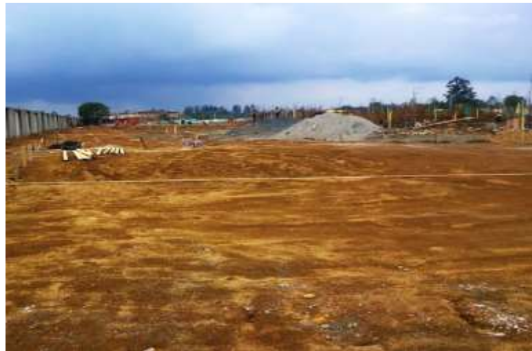
FIGURA No. 21 Nivelación del terreno.
