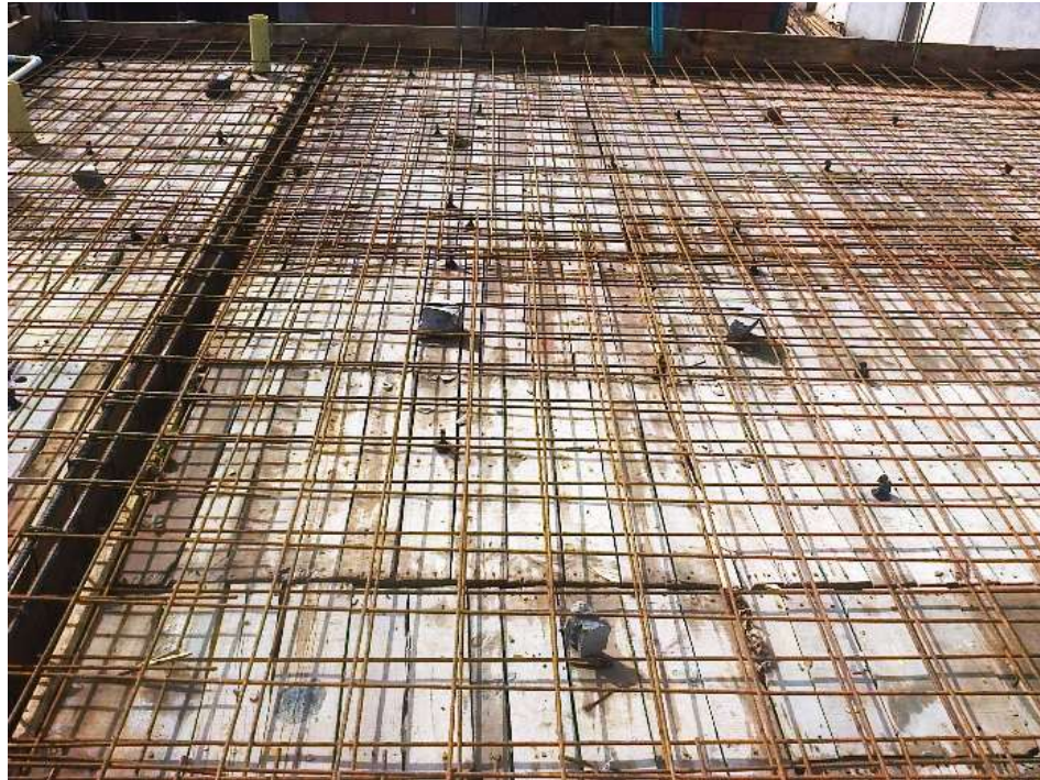
FIGURA No. 47 Separadores plásticos y en concreto.
