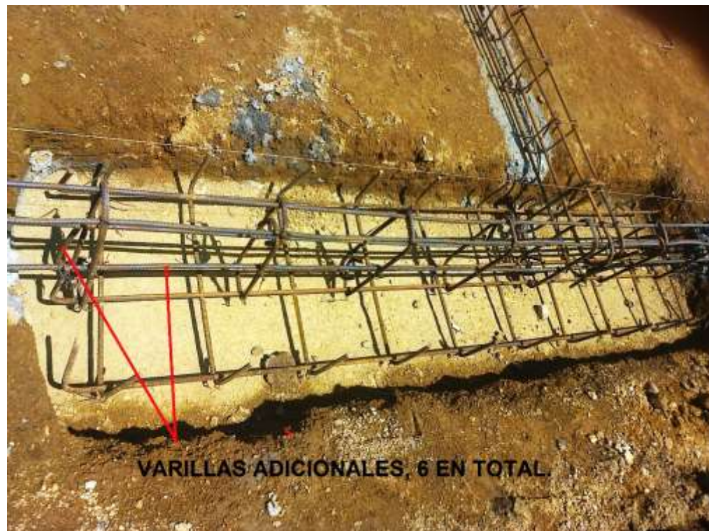
FIGURA No. 28 Colocación varillas inferiores de zapatas.
