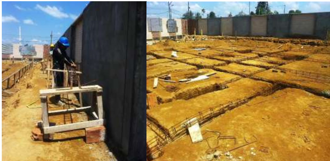
FIGURA No. 25 Armado y colocación de las vigas de cimentación.
