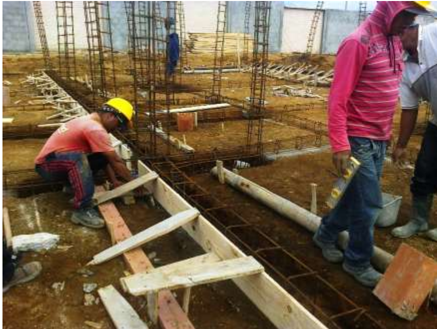
FIGURA No. 31 Encofrado - cimentación
