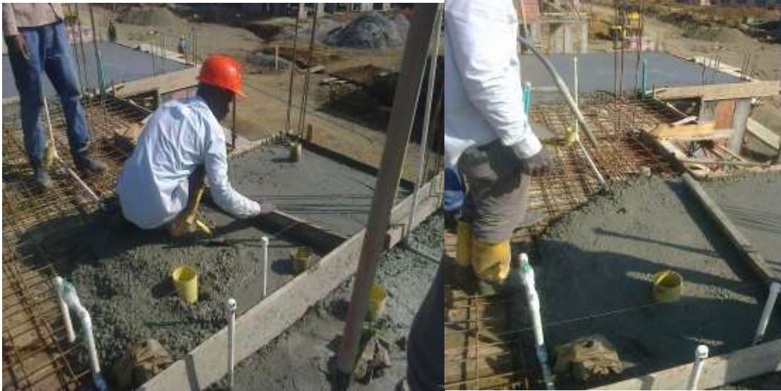
FIGURA No. 48 Fundición losa de entrepiso.
