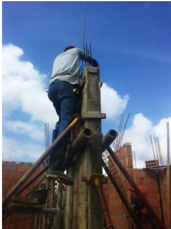
FIGURA No. 44 Fundición columnas primer piso.
