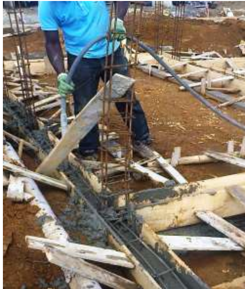
FIGURA No. 32 Fundición – cimentación
