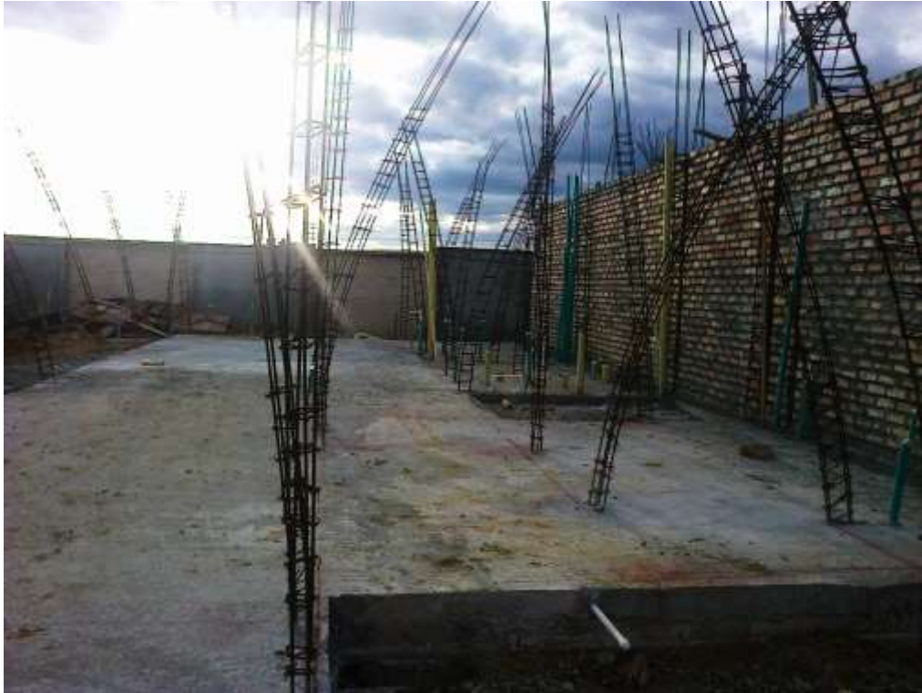
FIGURA No. 38 Losa de contrapiso.
