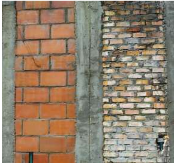
FIGURA No. 41 Muros en ladrillo farol y común.
