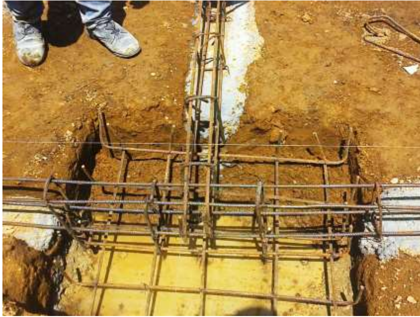
FIGURA No. 27 Amarre viga con zapata.
