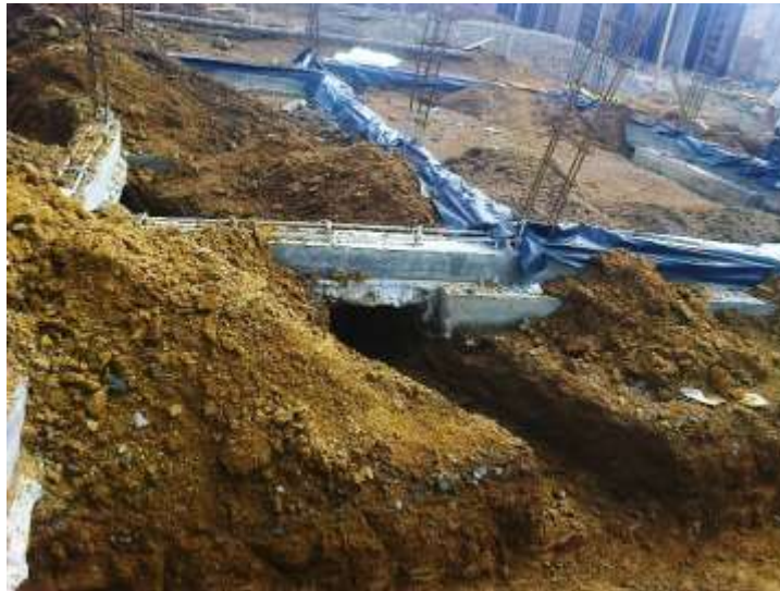
FIGURA No. 33 Excavación, Instalación sanitaria
