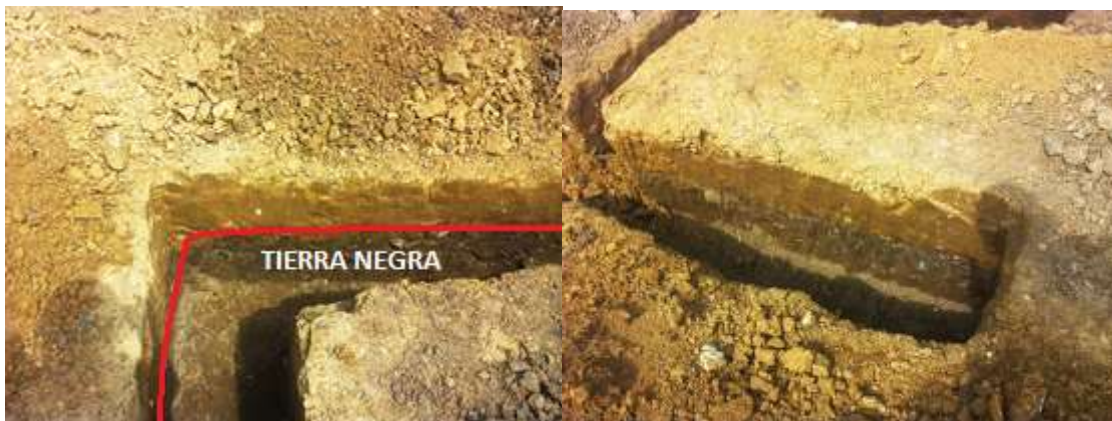
FIGURA No. 22 Excavación para cimentación.
