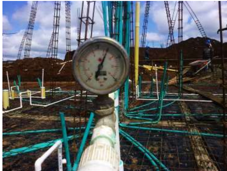
FIGURA No. 36 Colocación del plástico, instalación eléctrica, malla electrosoldada, hidráulica.
