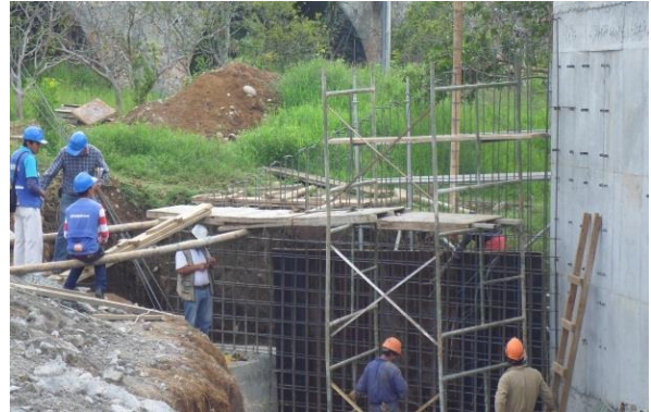
Instalación de acero de refuerzo cuerpo aleta estribo No.2
