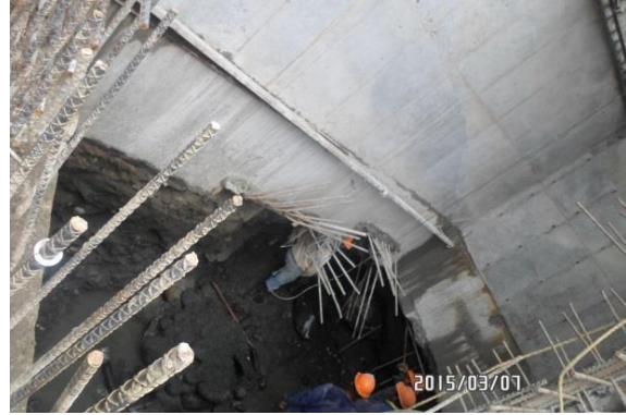
Excavación para quinto anillo
