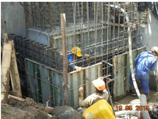
Instalación de formaleta metálica para terminación de pantalla y contrafuerte del segundo anillo del cajón derecho.
