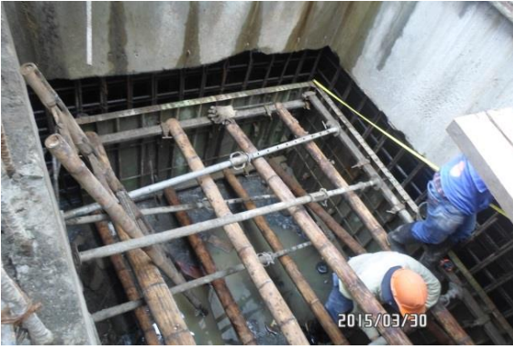
Instalación de formaleta metálica por secciones. Quinto anillo
