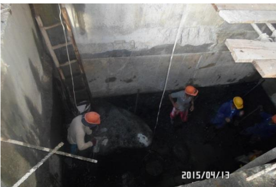
Excavación para sexto anillo
