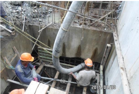
Fundición por secciones. Quinto anillo
