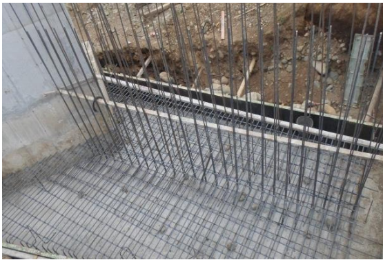
Amarre de acero de refuerzo aleta estribo No.2
