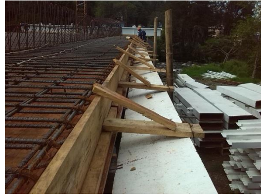
Instalación formaleta vertical de madera
