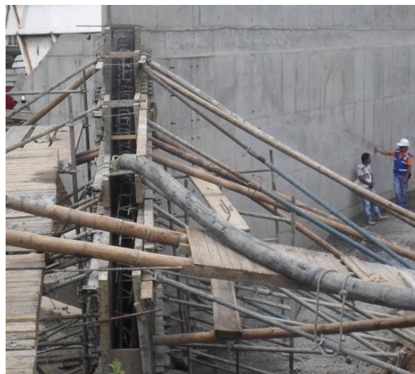
Figura 21. Fundición aleta derecha estribo No.2
