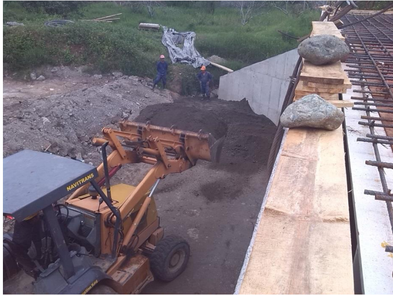
Figura 26. Colocación y extendido del material de una capa del terraplén
