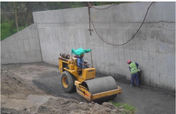
Colocación y compactación del material
