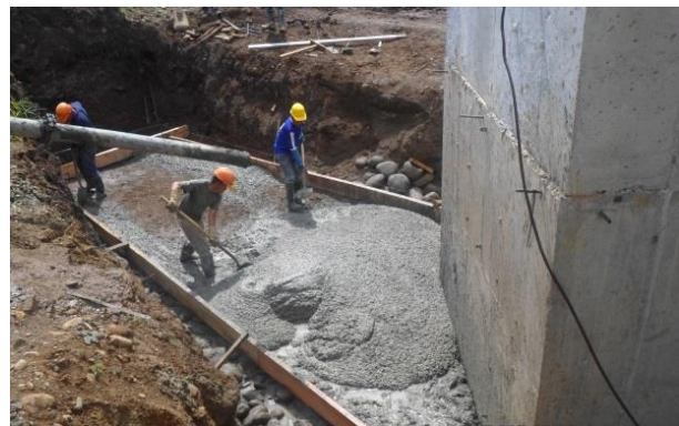
Fundición de solado de limpieza aleta estribo No.1
