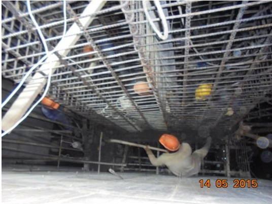
Fundición hasta una altura de 4,75 m del vástago
