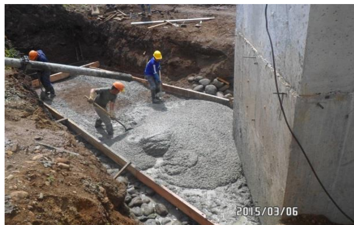
Figura 10. Fundición solado de limpieza de la aleta izquierda del estribo No.1
