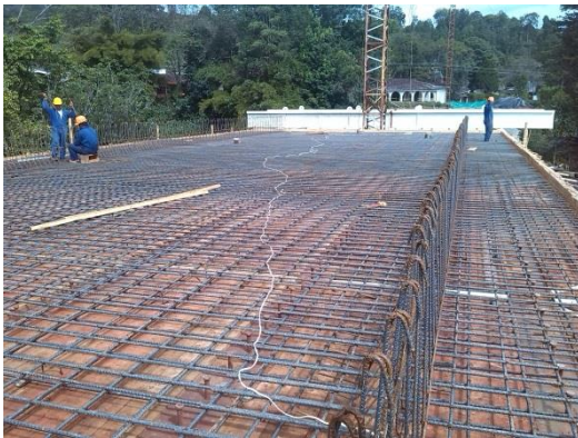
Instalación y amarre de acero de refuerzo del new jersey
