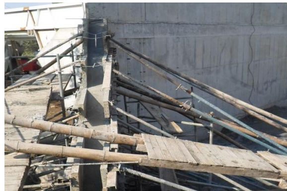
Fundición cuerpo aleta estribo No.2
