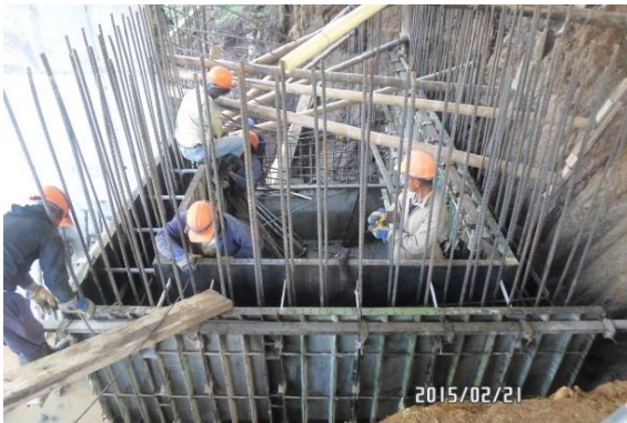
Segundo anillo cajón
