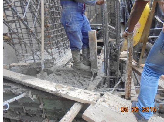
Fundición de terminación de pantalla y contrafuerte del segundo anillo del cajón derecho.
