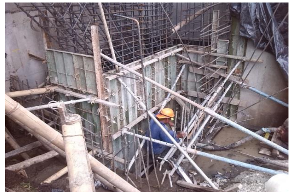
Instalación formaleta metálica hasta una altura de 4,75 m del vástago
