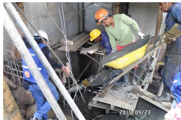
Fundición por secciones. Sexto anillo
