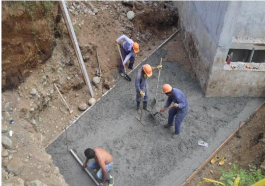
Fundición de solado de limpieza aleta estribo No.2
