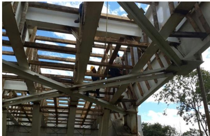
Figura 33. Instalación formaleta madera
