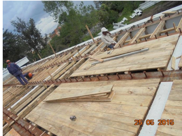
Figura 34. Instalación formaleta madera
