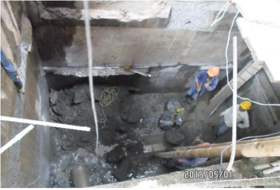
Excavación y nivelación para cimentación cajón derecho
