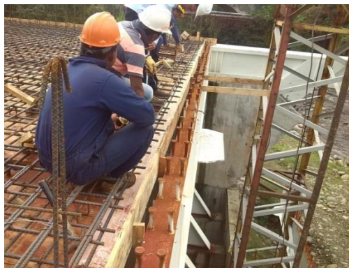
Figura 38. Instalación formaleta vertical de madera.
