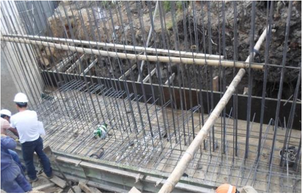
Amarre de acero de refuerzo aleta estribo No.1
