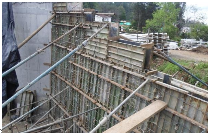
Figura 20. Instalación formaleta metálica aleta
