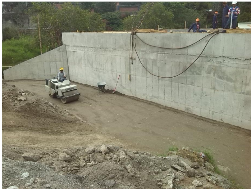
Figura 27. Compactación de una capa del terraplén.
