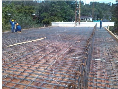
Figura 37. Instalación y amarre de acero de refuerzo losa y new jersey.
