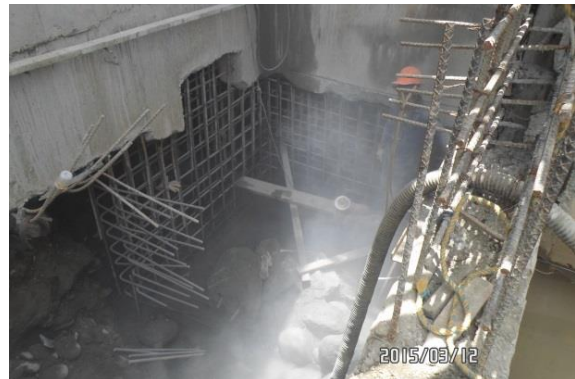
Instalación y amarre de acero por secciones. Quinto anillo
