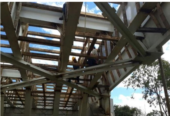
Instalación formaleta de madera
