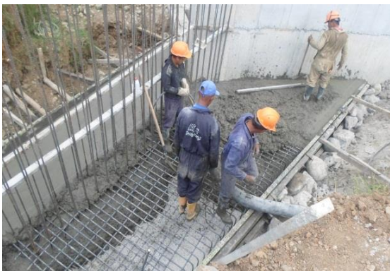
Fundición zarpa aleta estribo No.2
