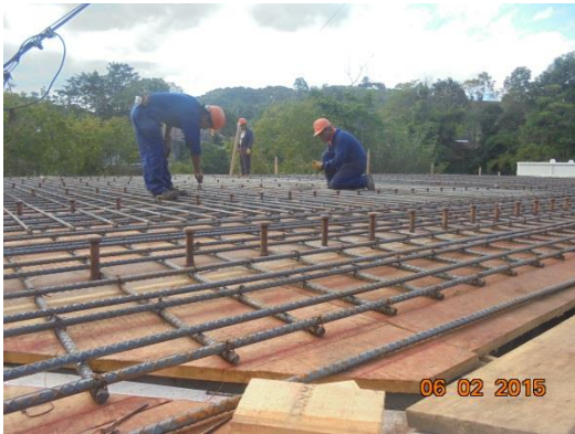
Instalación y amarre de acero de refuerzo de la losa
