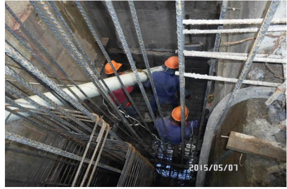
Fundición cimentación cajón derecho
