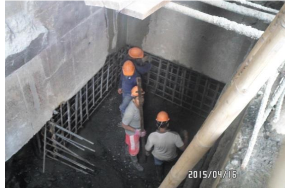
Instalación y amarre de acero por secciones. Sexto anillo
