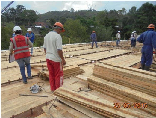
Instalación de formaleta de madera
