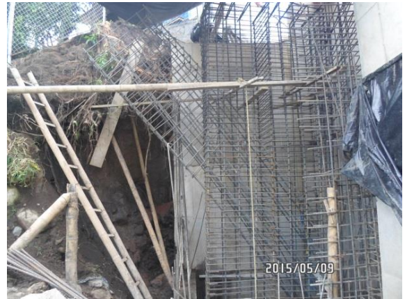
Instalación y amarre acero de refuerzo vástago cajón derecho
