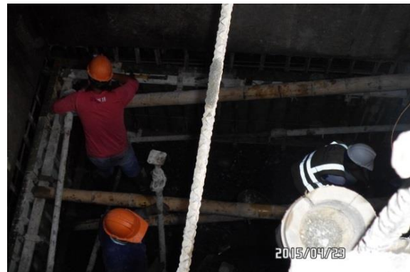
Instalación de formaleta metálica por secciones. Sexto anillo
