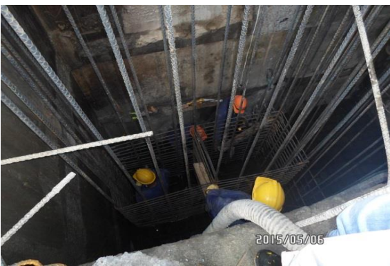
Instalación y amarre de acero de refuerzo para cimentación cajón derecho
