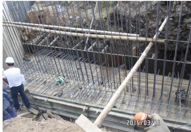
Figura 12. Amarre de acero de refuerzo aleta izquierda estribo No.1
