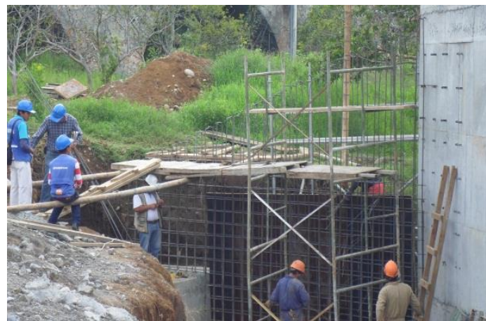
Figura 13. Amarre de acero de refuerzo aleta derecha estribo No.2
