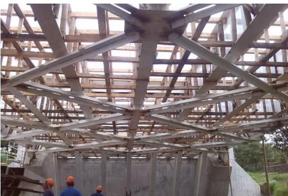
Instalación formaleta de madera
