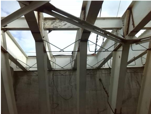
Instalación de andamios para formaleta de madera
