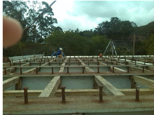
Control topográfico de los niveles de la formaleta
