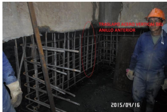
Figura 22. Detalle acero vertical con traslapeo de anillo anterior
