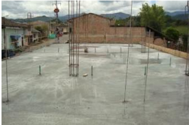
Figura No. 28 Losa aligerada con casetón de guadua fundida en su totalidad (Vista Norte- Sur)
