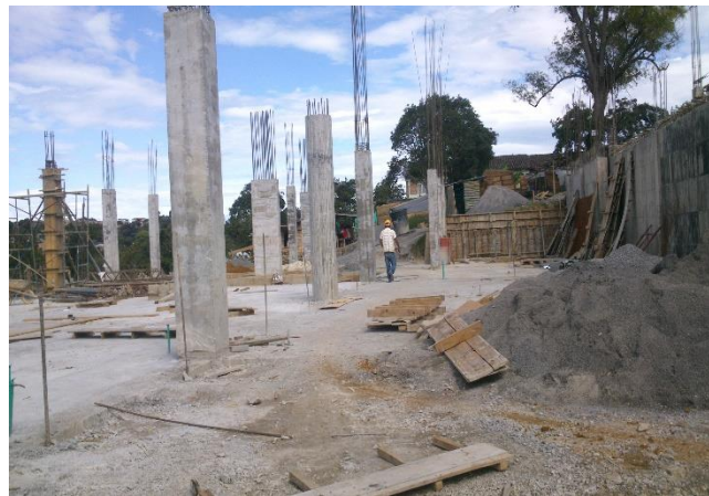
Figura No. 22 Sector 2 suspendido por falta de material cementante.
