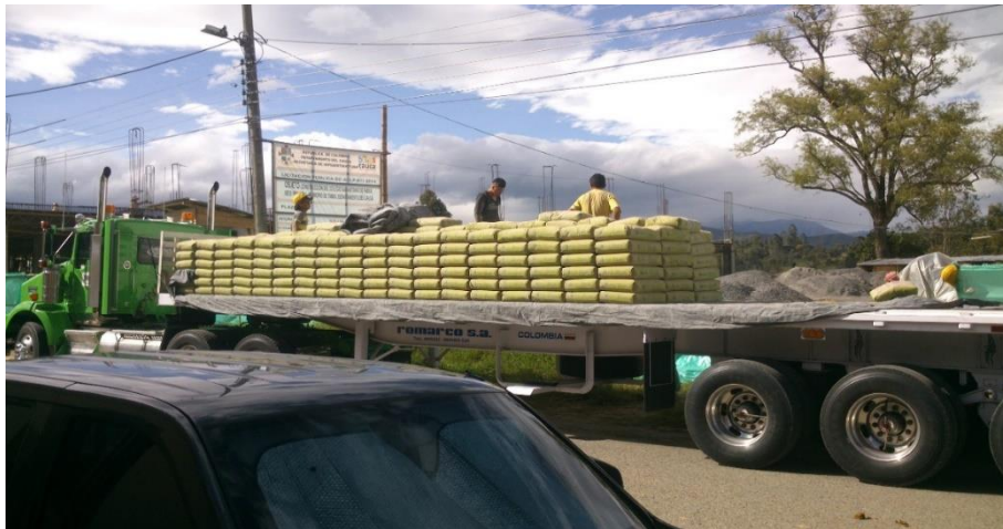
Figura No. 24 Tracto-camión con sacos de cemento para continuar la construcción de la obra.
