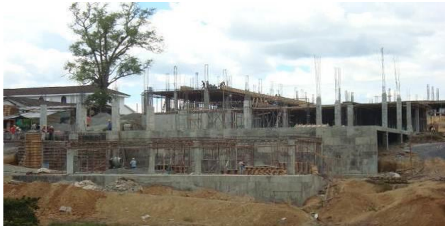
Figura No. 27 Vista general del proyecto durante la Segunda Inspección
