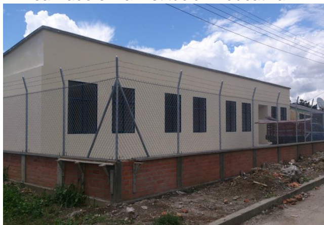
Figura No. 16 Enmallado perimetral realizado en la Institución Educativa.
