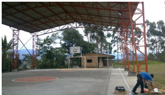
Figura No. 10 Vista general del polideportivo vereda Cinco Días con su cubierta instalada.
