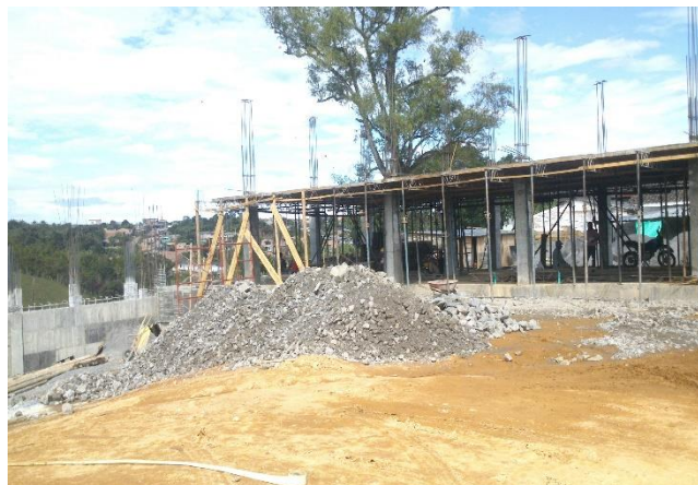
Figura No. 23 Estructura dispuesta para la construcción de losa de entrepiso.
