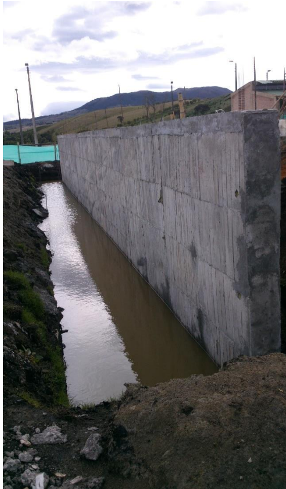
Figura No. 5 Empozamiento de agua sobre muro de contención.
