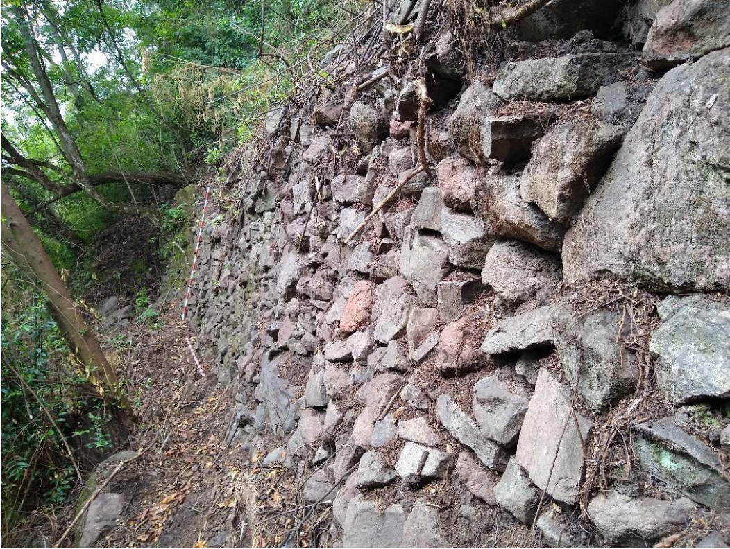
Muro en piedra para terraza con altura de 2 m. Fuente: Propia
