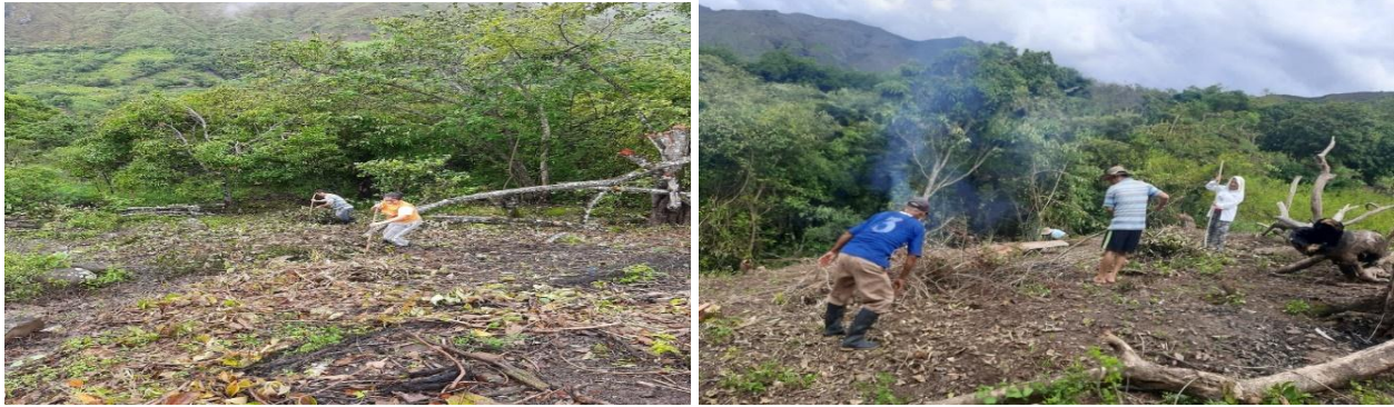
Fotografía 9. Limpieza del terreno para la implementación de Huerta escolar
