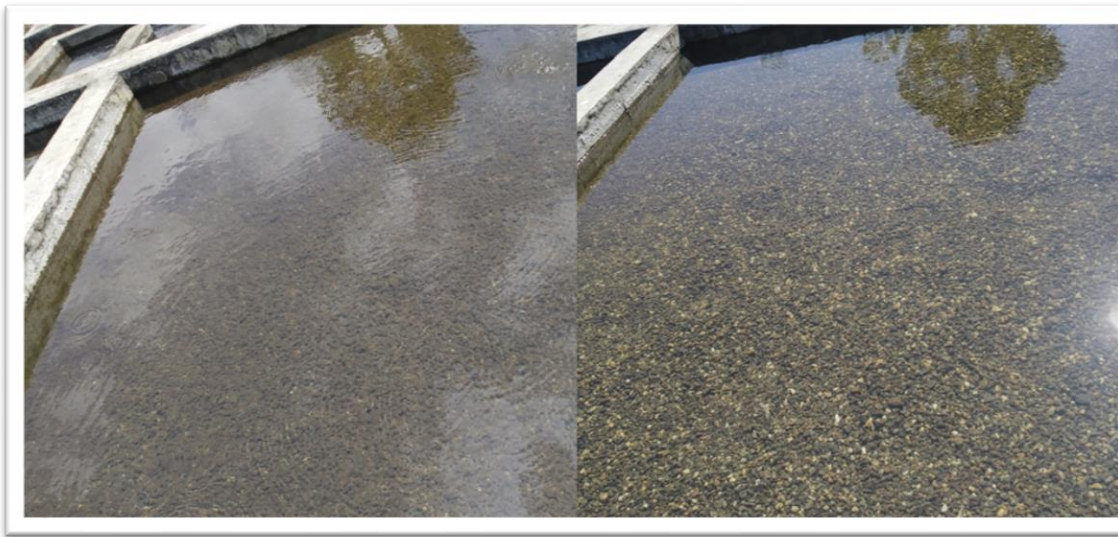
Figura 9. Filtro en grava con y sin presencia de lodo en la superficie.
