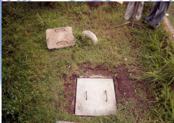
Fotografía 4. Vista tapa Tanque séptico.
