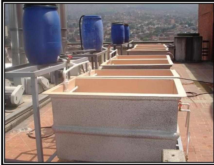
Imagen Nro. 4 Montaje Final de los humedales artificiales
